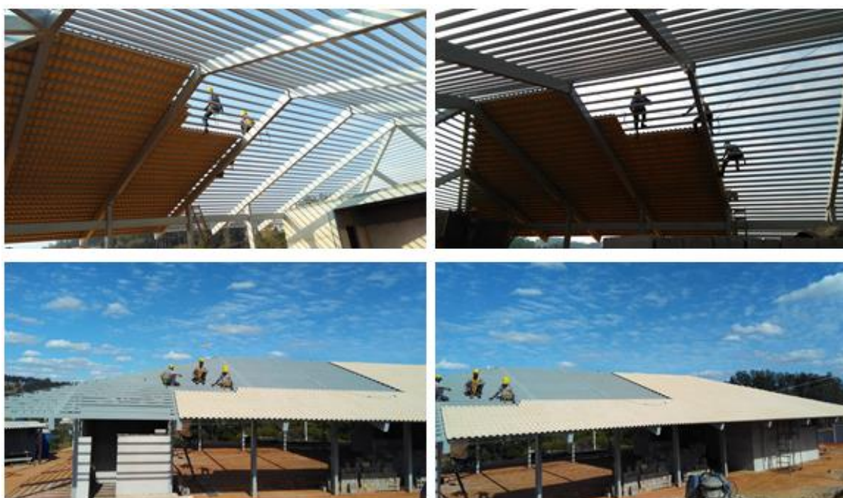
Figura 2: Imagem dos trabalhadores executando a cobertura.
