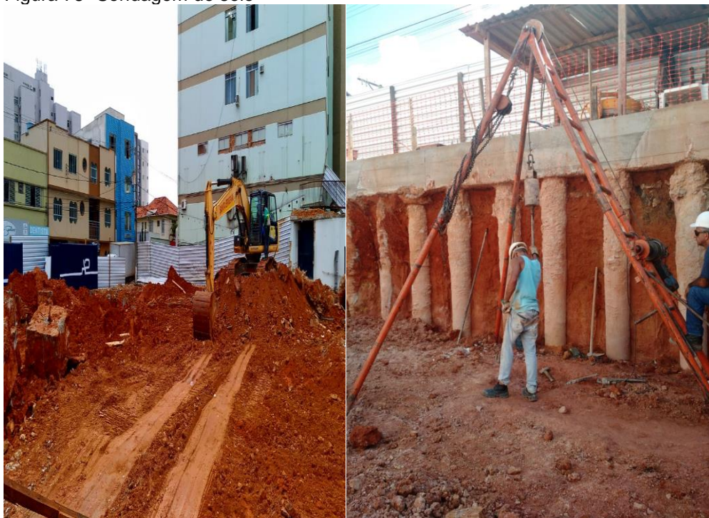
Figura 78- Sondagem do solo
