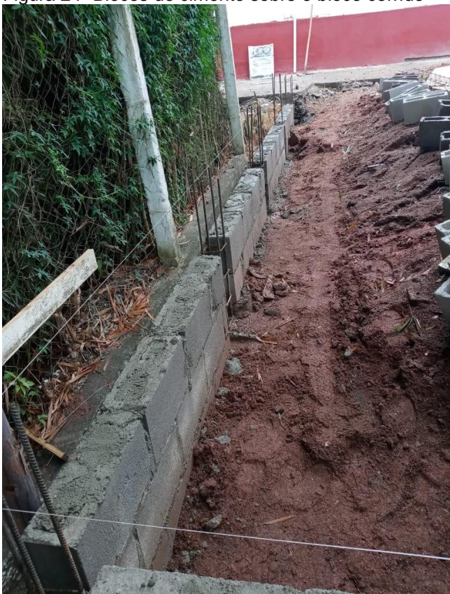
Figura 24- Blocos de cimento sobre o bloco corrido
