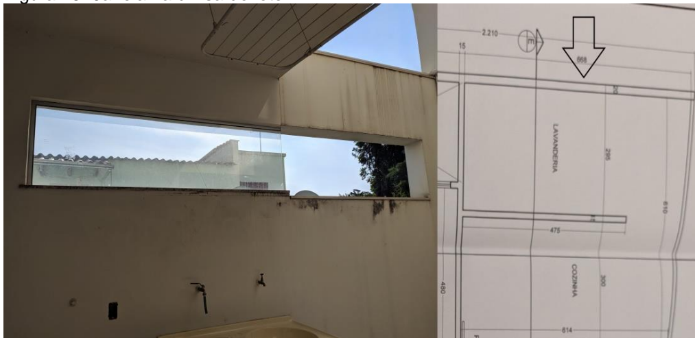
Figura 16- Janela na divisa do lote
