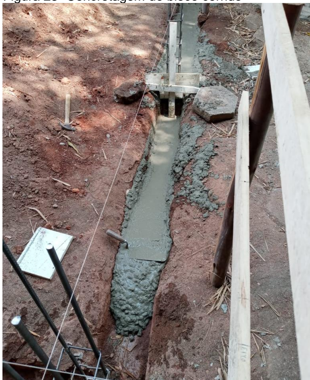
Figura 23- Concretagem do bloco corrido
