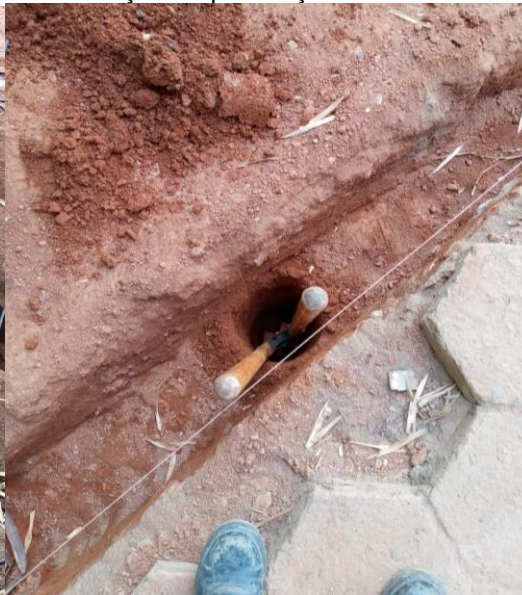
21- Execução da perfuração da broca
