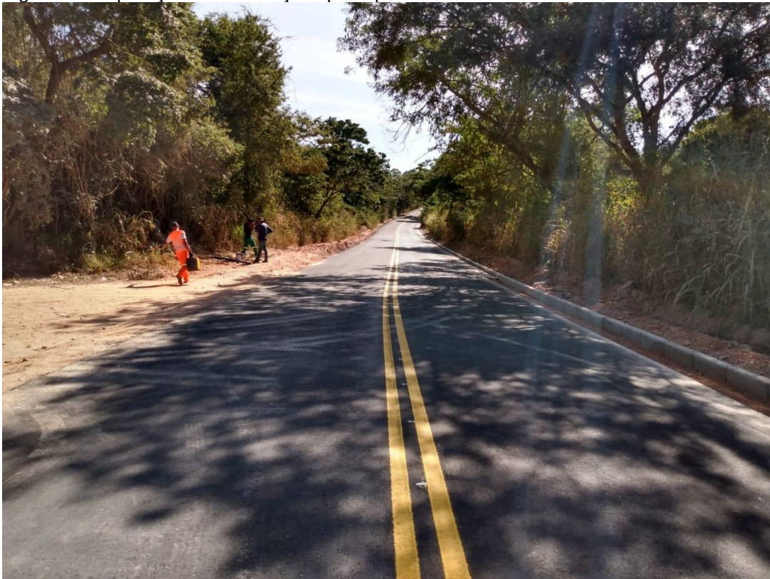
Figura 55 – Aplicação da sinalização tipo dupla contínua
