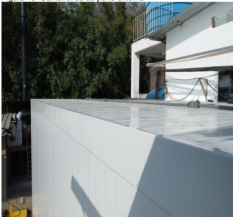
Figura 40- Cantoneiras da parte externa
