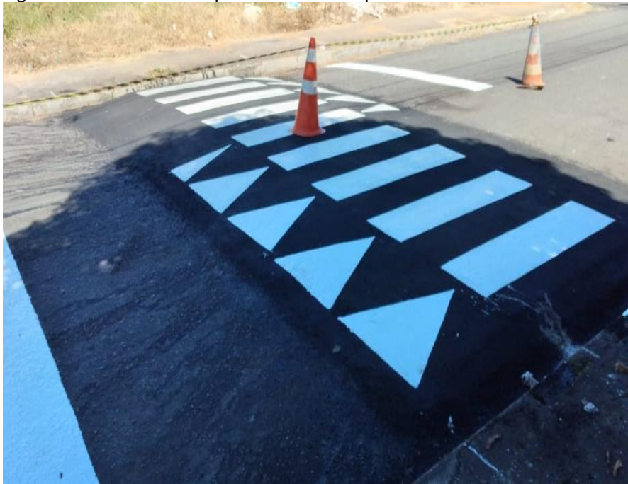
Figura 59- Faixa elevada para travessia de pedestres
