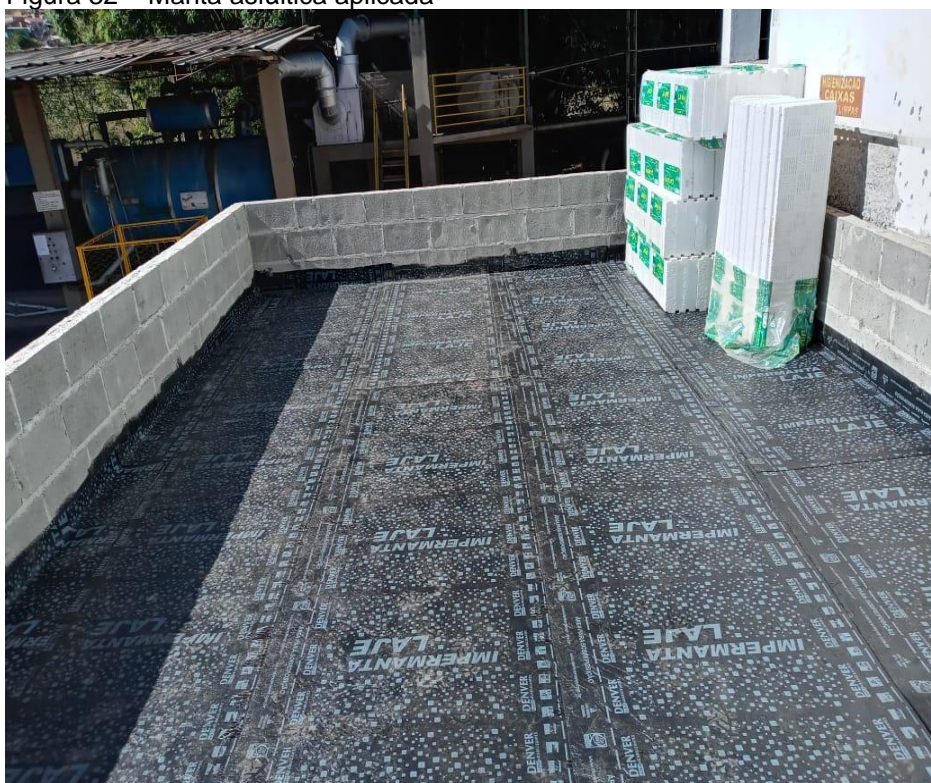
Figura 32 – Manta asfáltica aplicada
