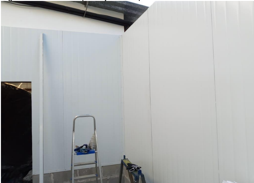
Figura 38- Painéis esquadrejados e apurados
