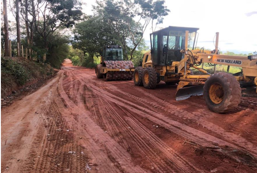
Figura 46- Serviço de compactação da base
