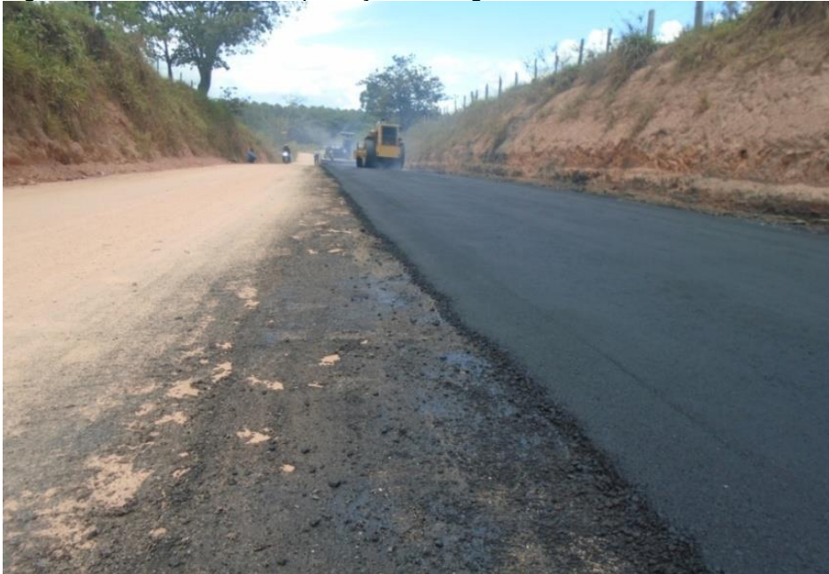
Figura 54- Processo de compactação ao longo da via
