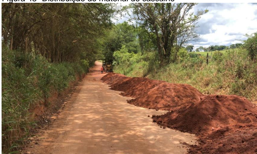
Figura 43- Distribuição do material de cascalho
