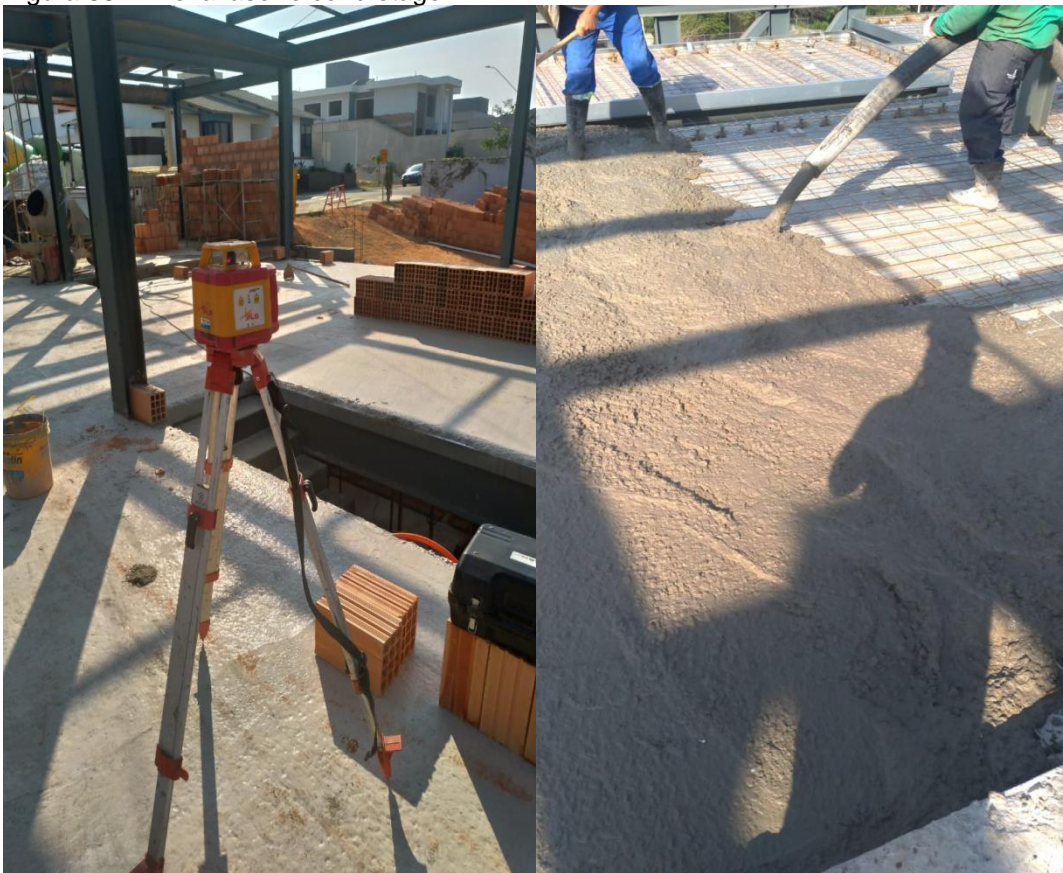
Figura 86- Nível a laser e concretagem
