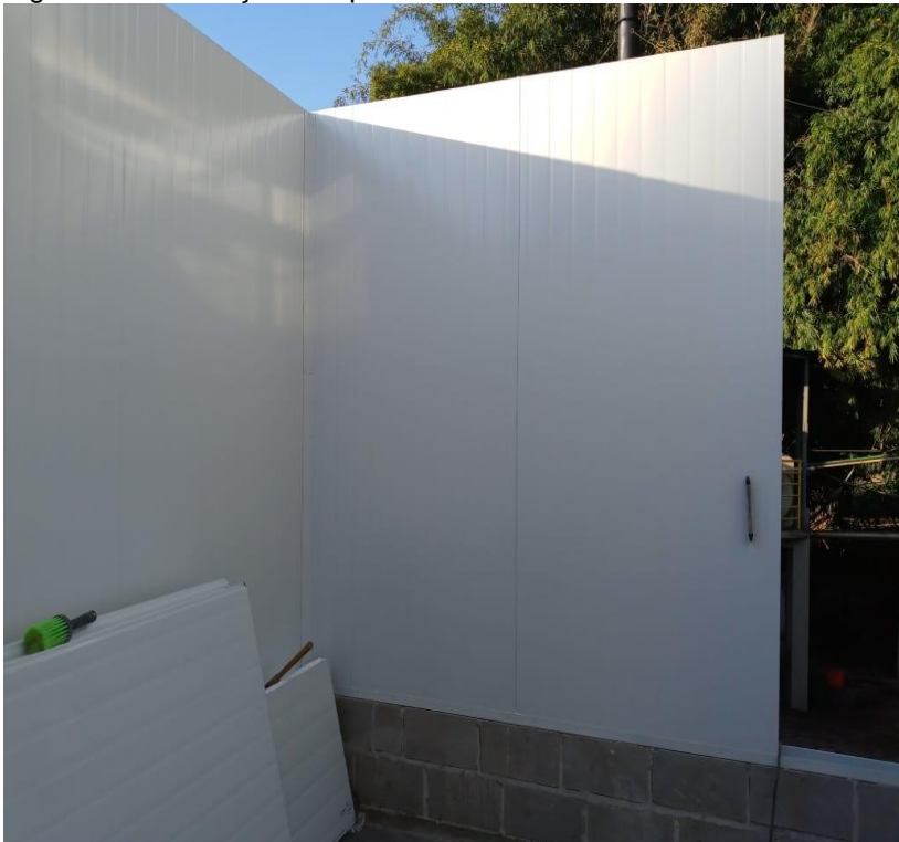
Figura 37- Colocação dos painéis
