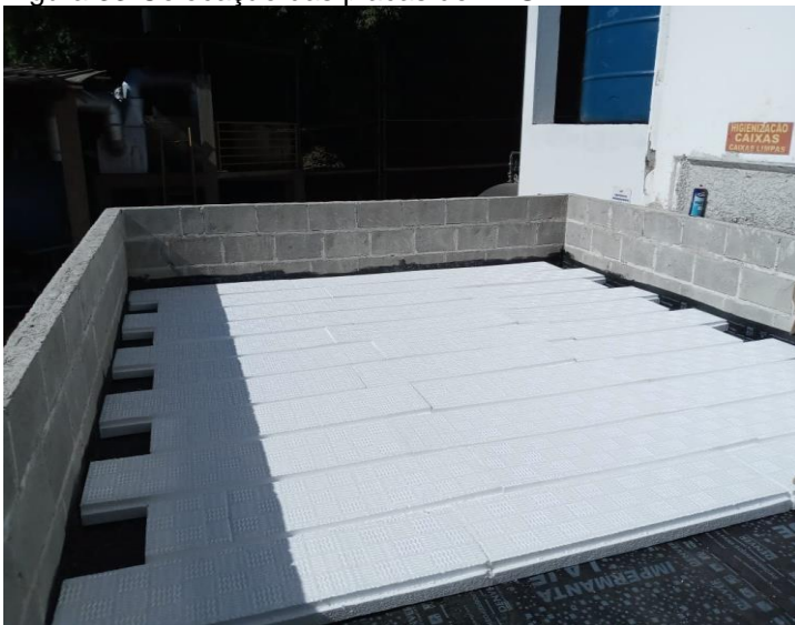
Figura 33-Colocação das placas de EPS
