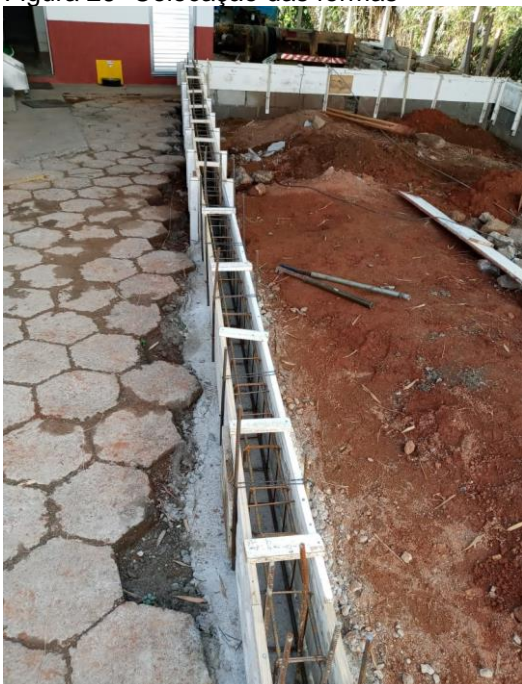
Figura 26- Colocação das formas
