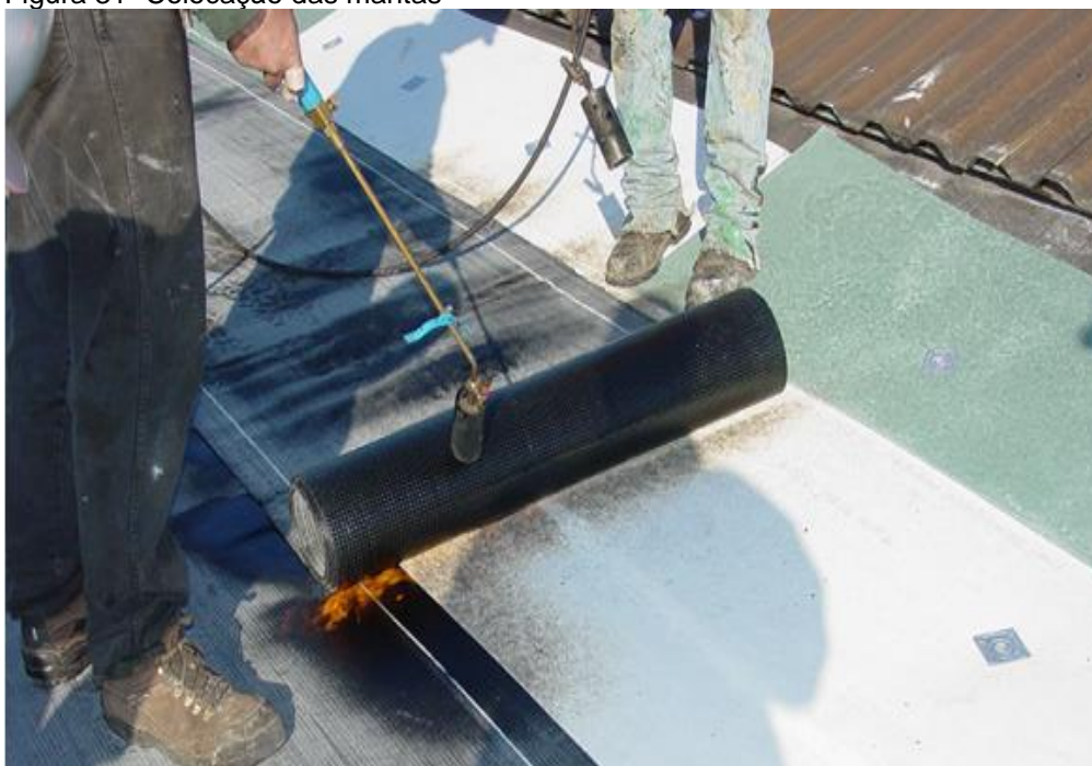
Figura 31- Colocação das mantas
