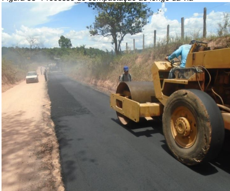
Figura 53- Processo de compactação ao longo da via
