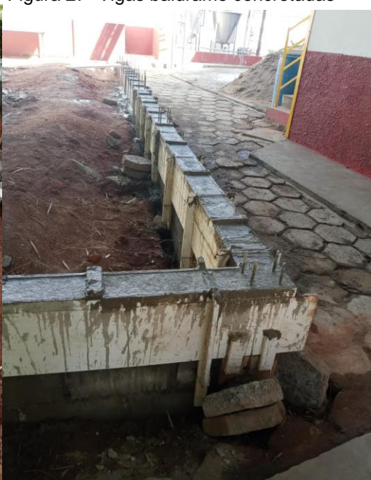
Figura 27- Vigas baldrame concretadas
