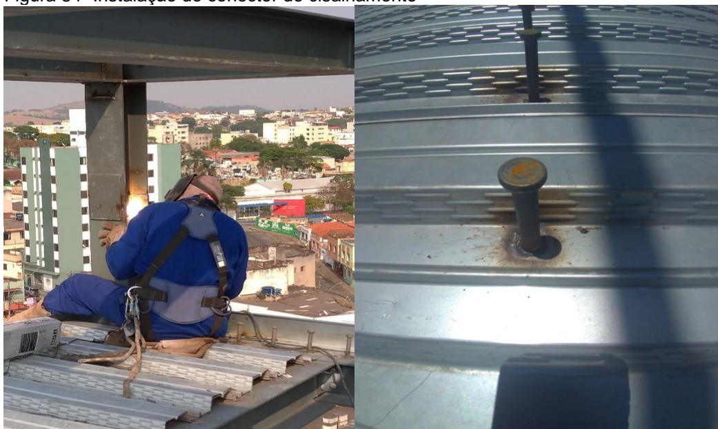
Figura 84- Instalação do conector de cisalhamento
