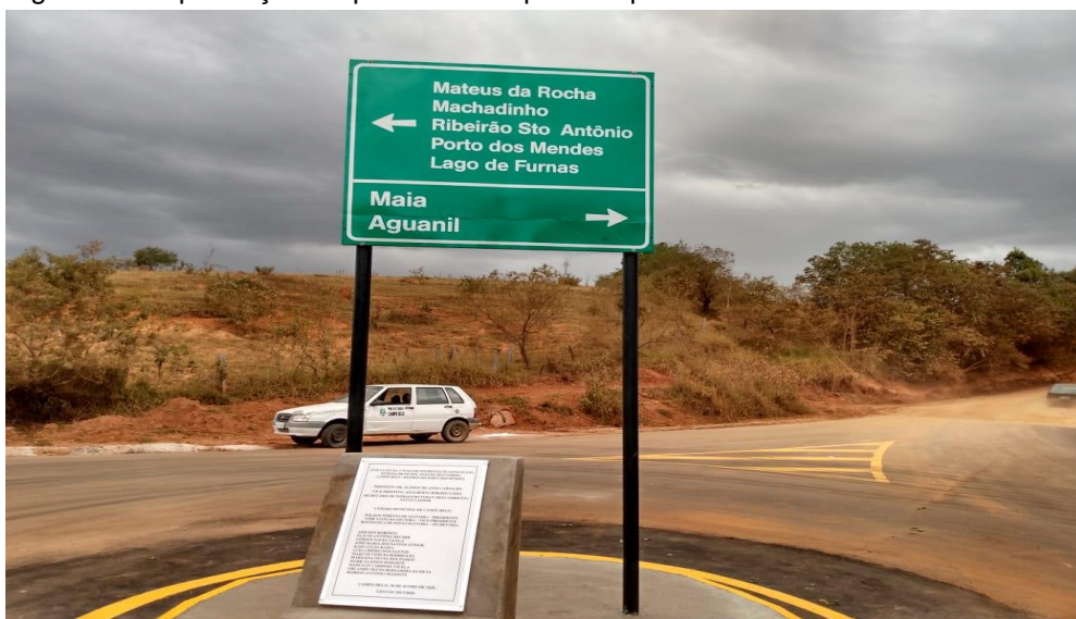
Figura 58- Implantação de placa com suporte duplo
