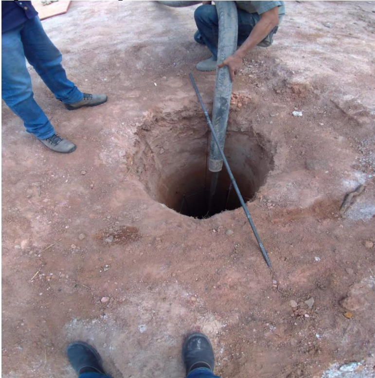
Figura 88- Concretagem tubulão
