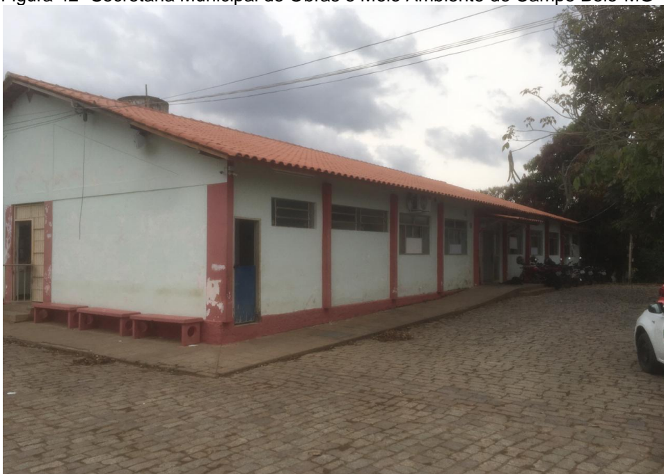
Figura 42- Secretaria Municipal de Obras e Meio Ambiente de Campo Belo-MG
