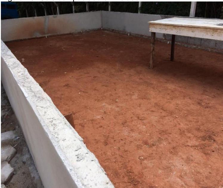
Figura 29- Solo compactado e nivelado
