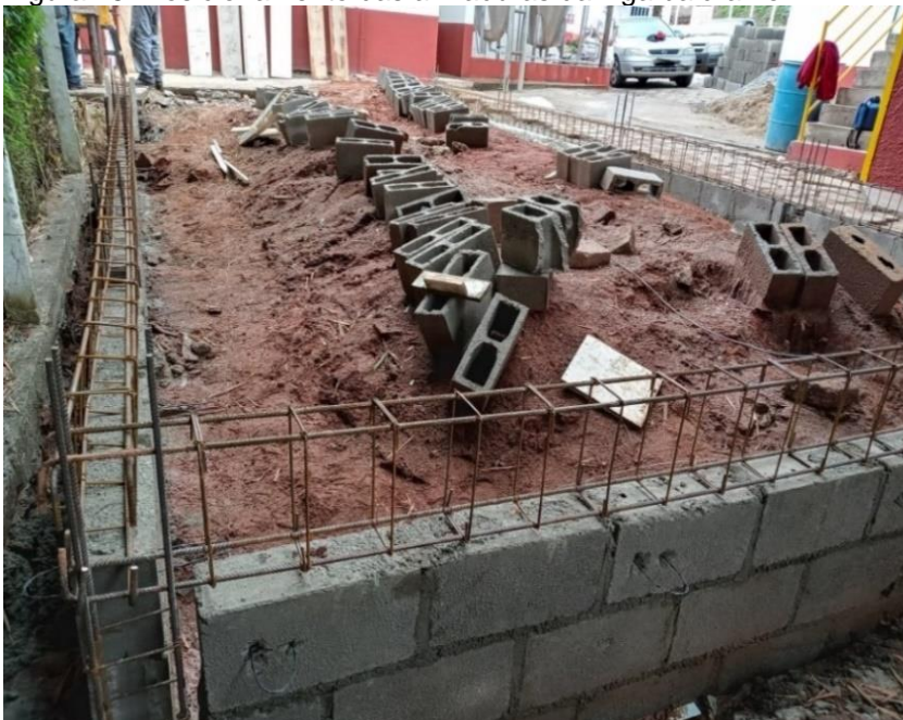
Figura 25- Posicionamento das armaduras da viga baldrame
