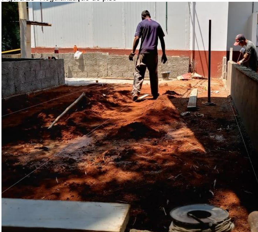
Figura 28- Regularização do piso
