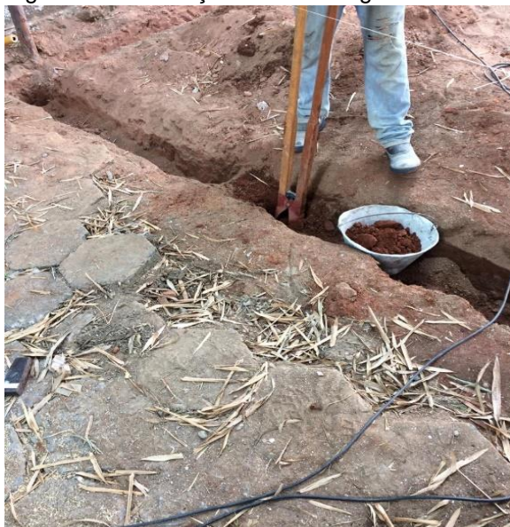
Figura 20- Perfuração da broca Figura
