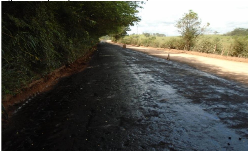
Figura 49- Imprimação sobre a área a ser pavimentada
