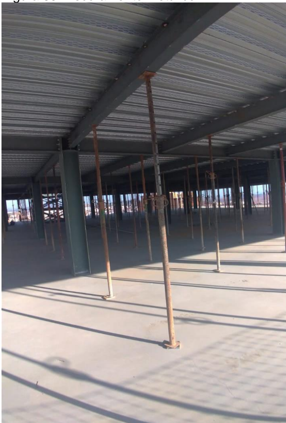
Figura 85- Escoramento metálico
