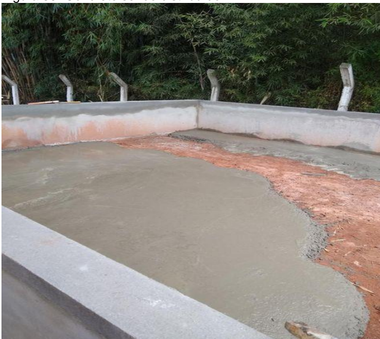
Figura 30- Concreto sendo distribuído
