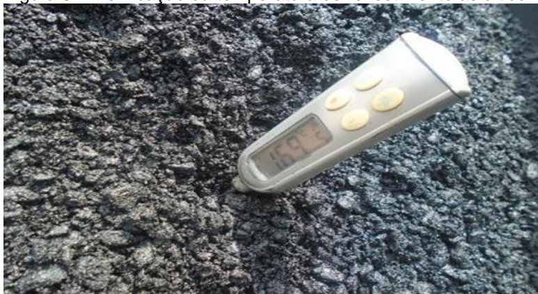
Figura 52- Verificação da temperatura do revestimento asfáltico
