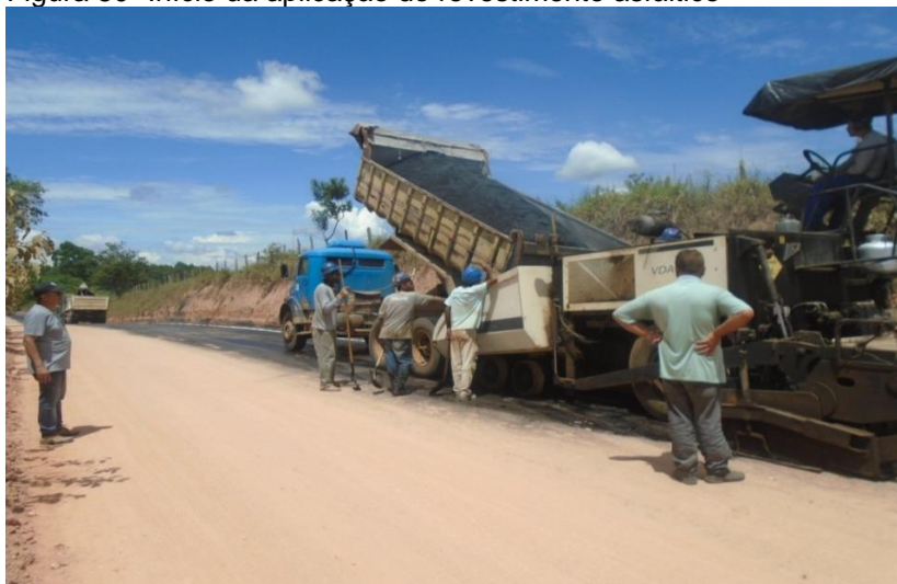
Figura 50- Início da aplicação do revestimento asfáltico
