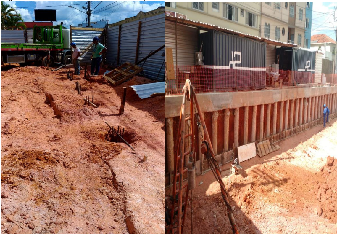
Figura 79- Cortina de estacas de contenção
