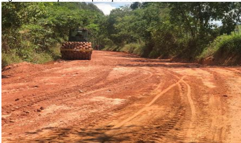
Figura 45- Serviço de compactação da base
