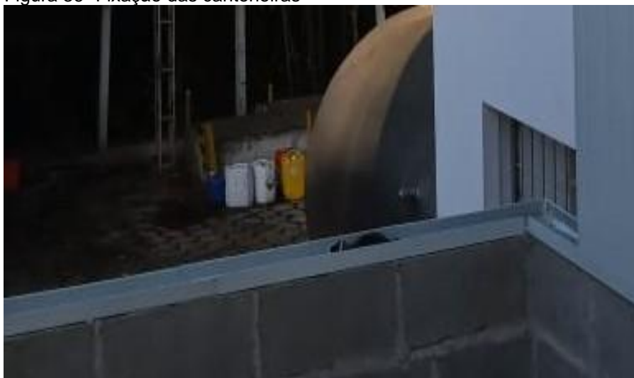
Figura 36- Fixação das cantoneiras
