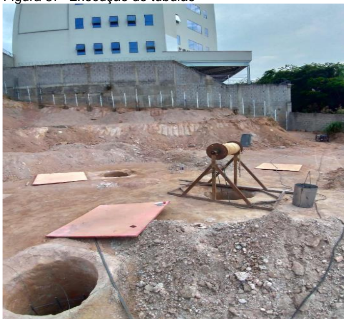
Figura 87- Execução do tubulão
