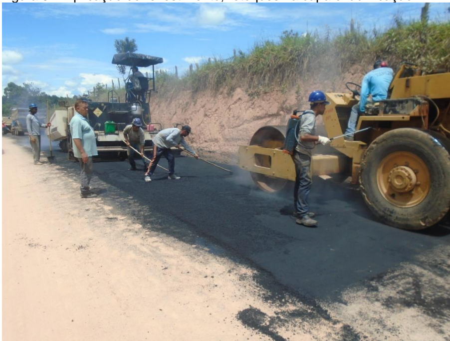
Figura 51- Aplicação do revestimento, retoques na capa e lubrificação
