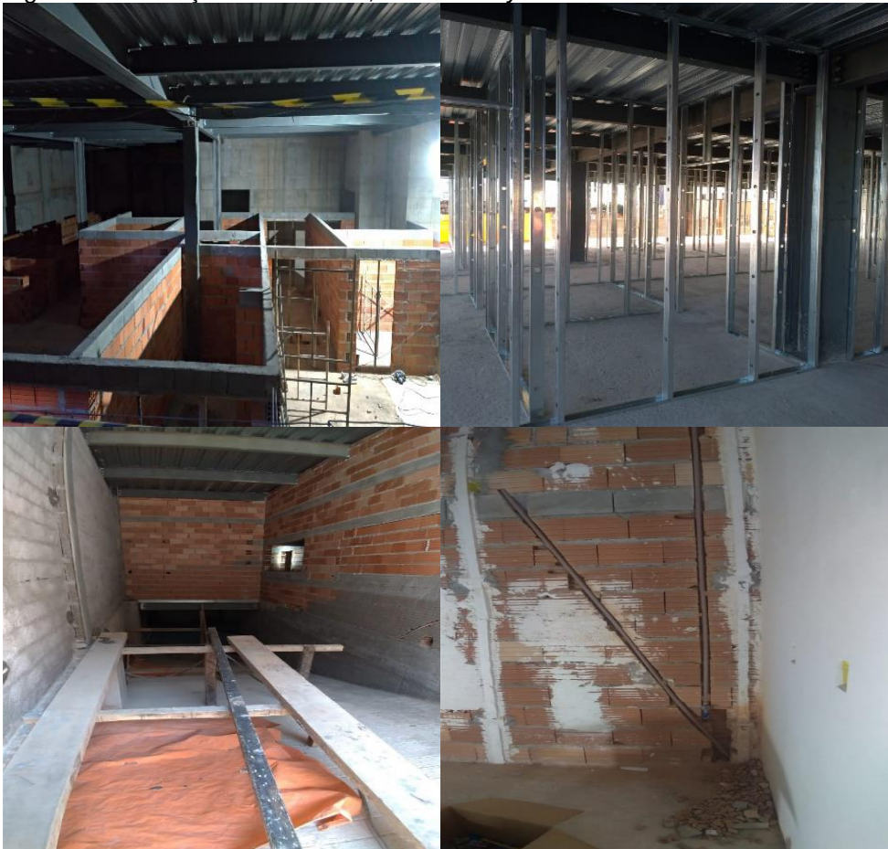
Figura 81- Execução da alvenaria, estrutura drywall e reboco
