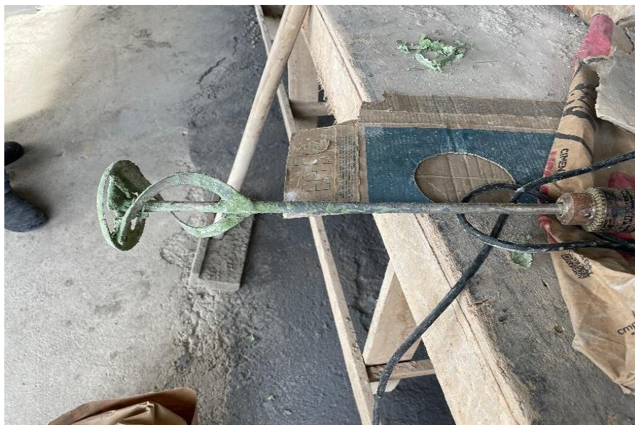
Figura 43 - Misturador utilizado no material impermeabilizante.
