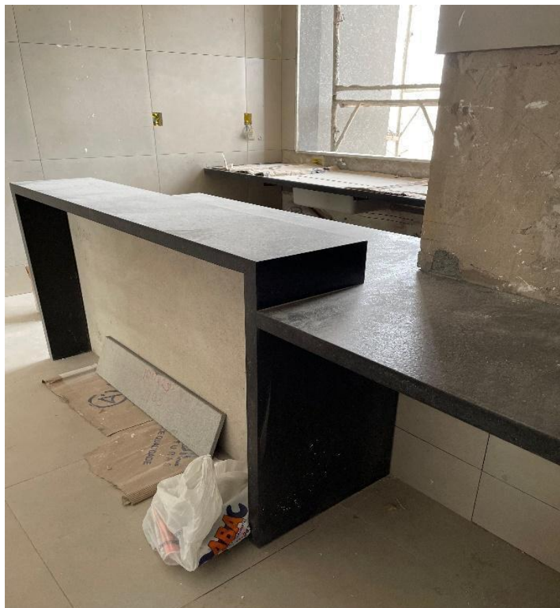
Figura 56 - Instalação de bancadas em harmonia com demais revestimentos.
