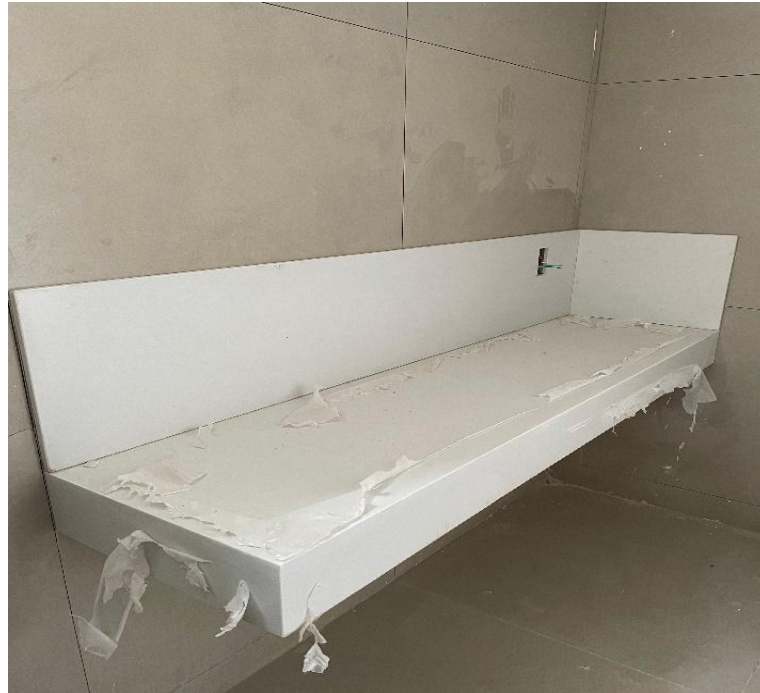
Figura 59 - Rodobanca assentada com ganho estético.
