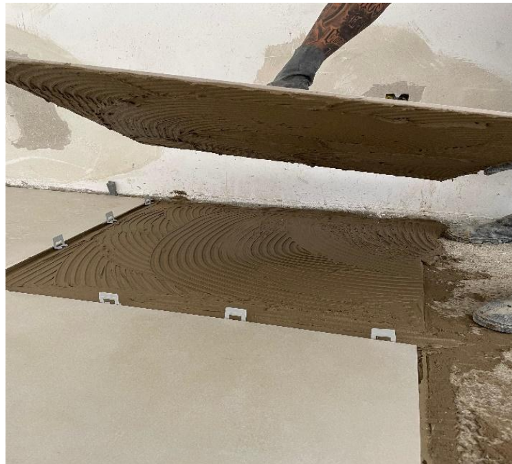
Figura 51 - Aplicação de dupla camada de argamassa colante.
