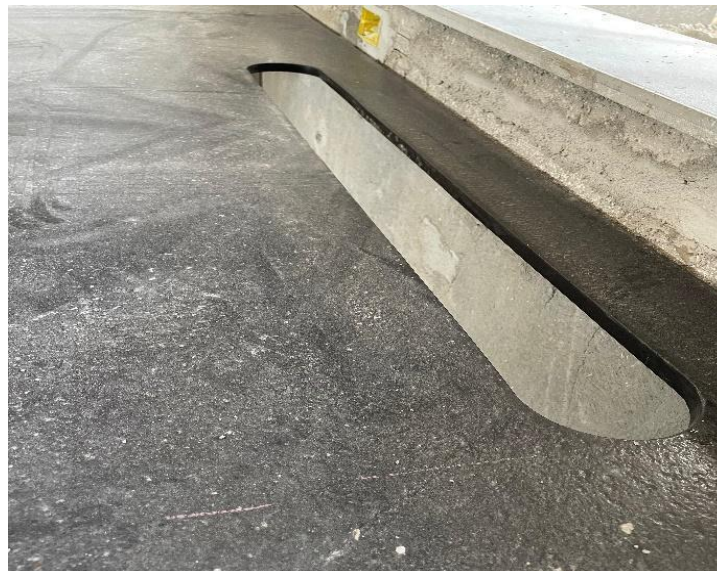
Figura 57 - Corte na bancada para adequação de projeto.
