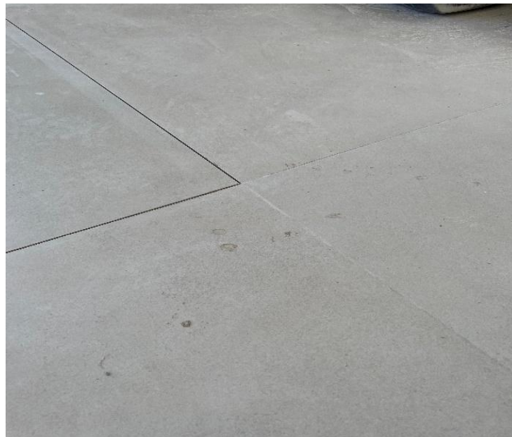
Figura 54 - Diferença de revestimentos com e sem rejunte.
