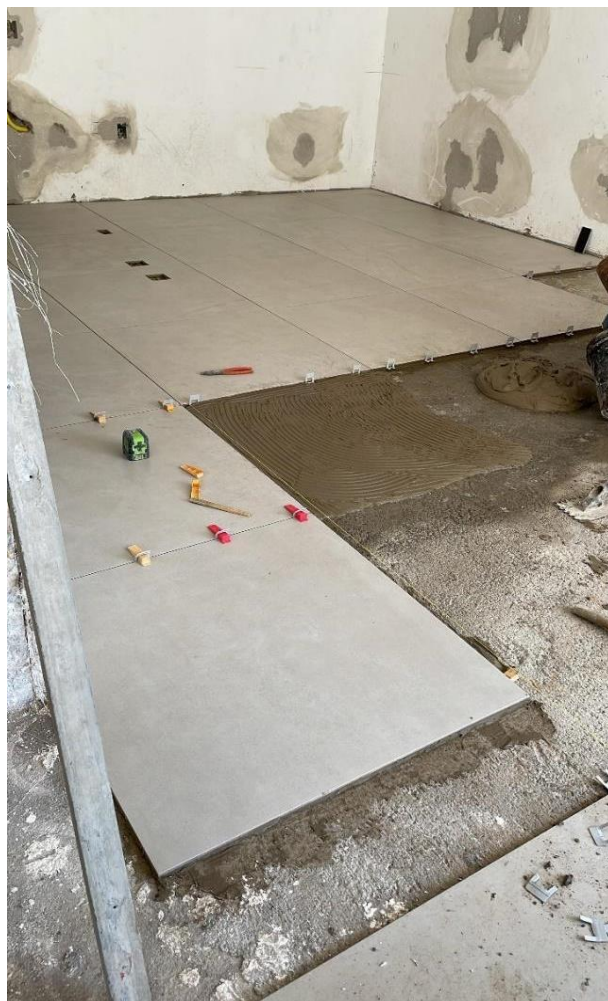
Figura 50 - Paginação e assentamento com auxílio de linha de pedreiro.
