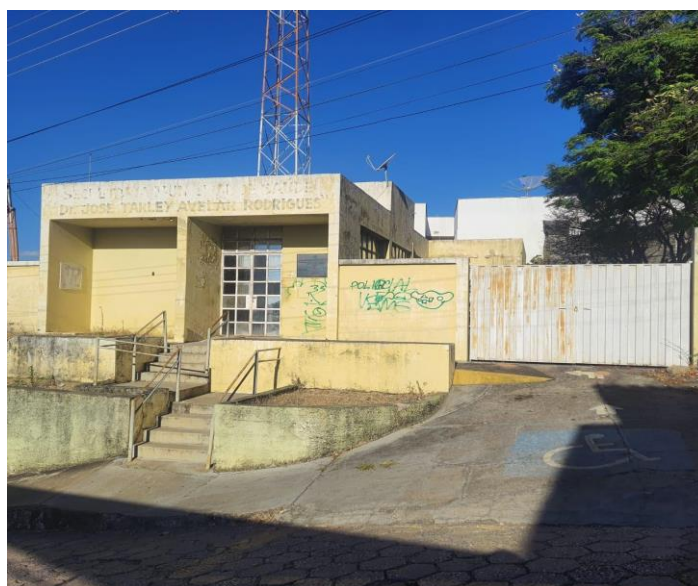
Figura 2 - Fachada antes da reforma e ampliação.
