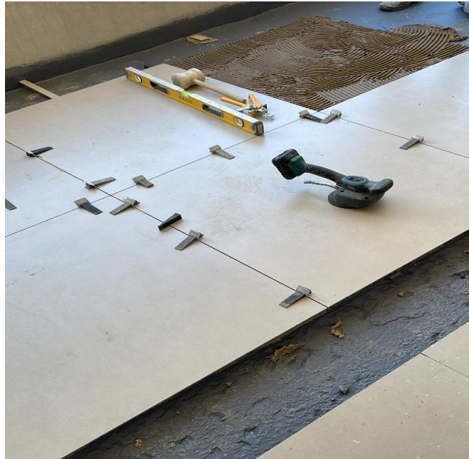
Figura 52 - Utilização de espaçadores e cunhas.
