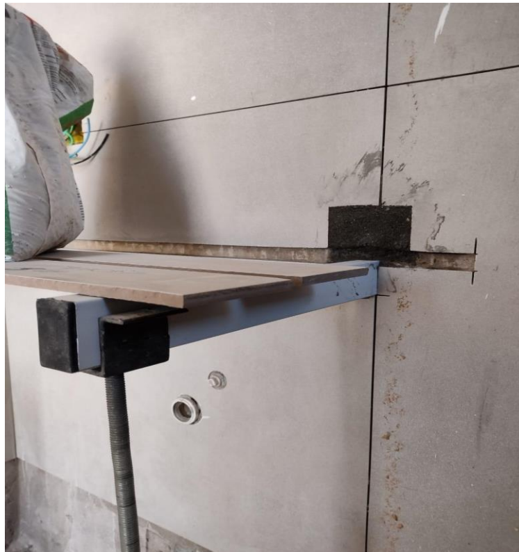
Figura 55 - Fixação de chumbadores.
