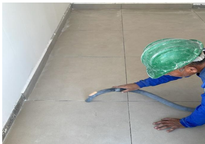
Figura 53 - Limpeza de juntas para execução de rejuntamento.
