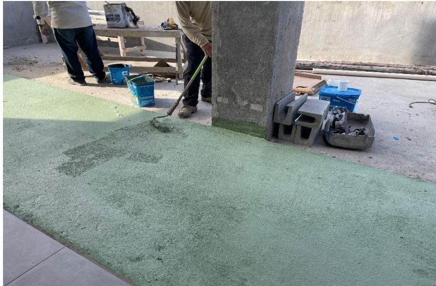
Figura 47 - Aplicação do impermeabilizante PROOF MULTI.
