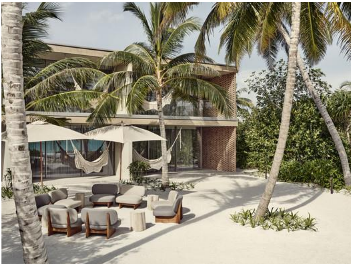
Imagem 37: Fachada da Village
