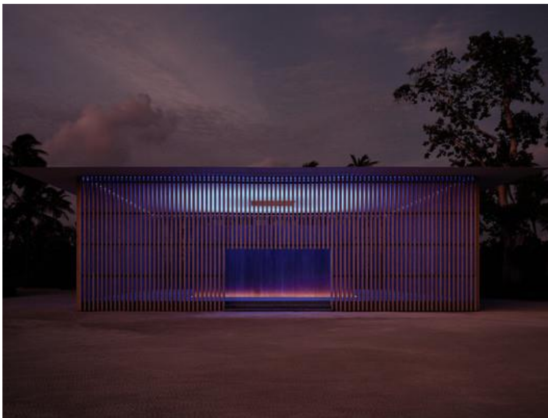
Imagem 38: Fachada da Galeria de Arte
