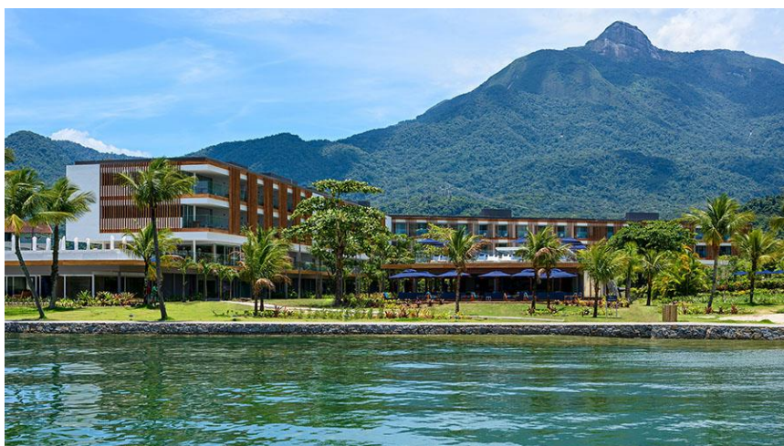
Imagem 31: Hotel Fasano Angra dos Reis visto do mar
