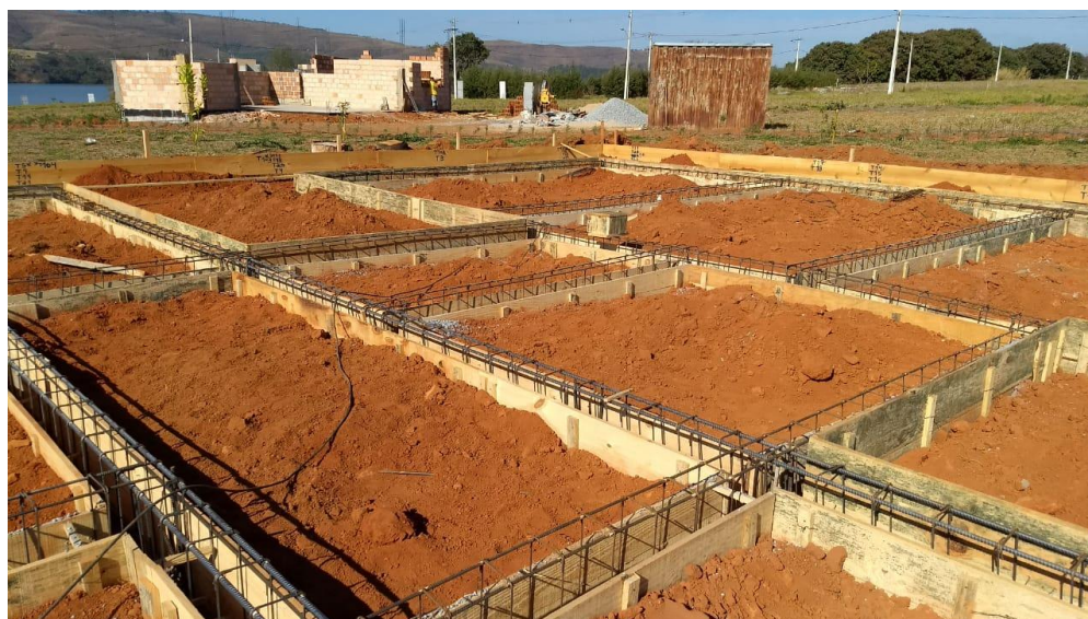
Figura 66: Armaduras e formas
