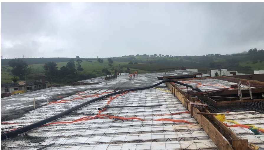
Figura 24: Concretagem da laje
