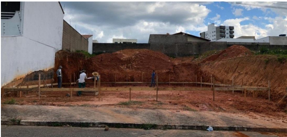
Figura 33: Gabarito da fundação
