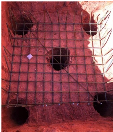
Figura 37: Armadura principal da sapata isolada
