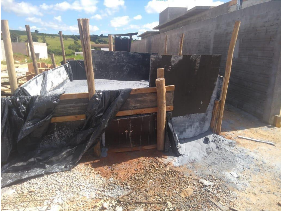
Figura 27: Baia com argamassa
