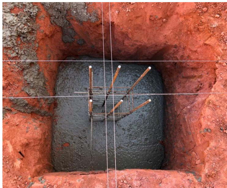
Figura 41: Sapata isolada concretada
