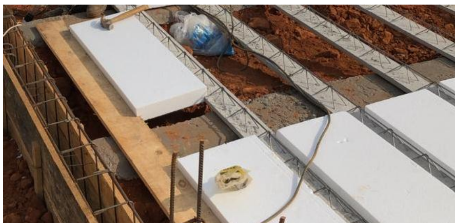
Figura 67: Faixa de terra com lastro de concreto para escora
