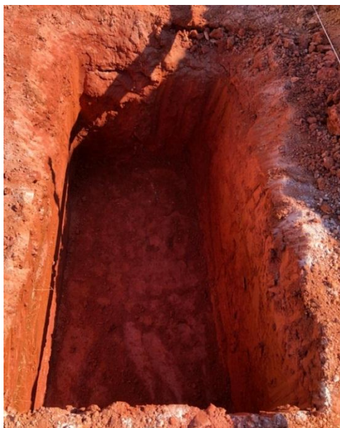
Figura 35: Sapata associada escavada.
