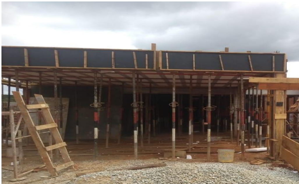
Figura 22: Escoramento das lajes
