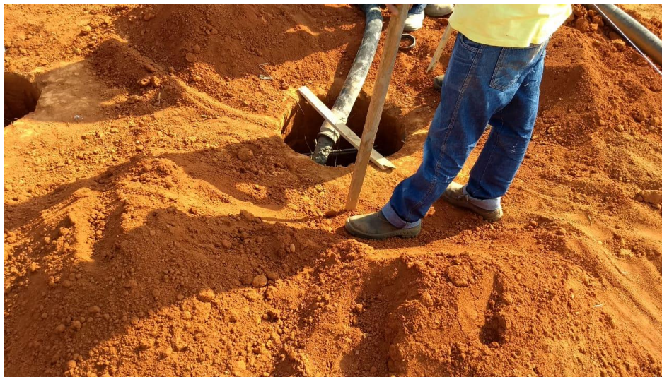
Figura 61: Concretagem do Tubulão
