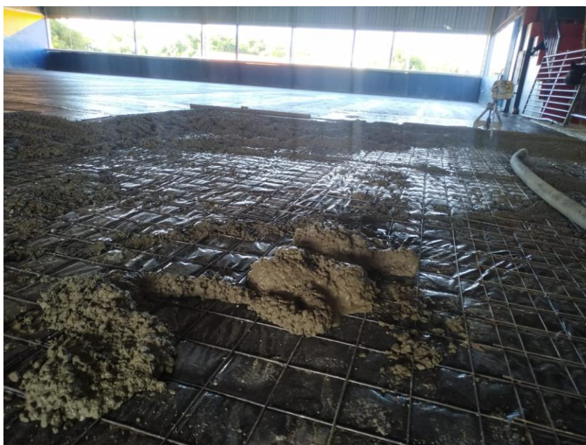
Figura 80: Lançamento do concreto
