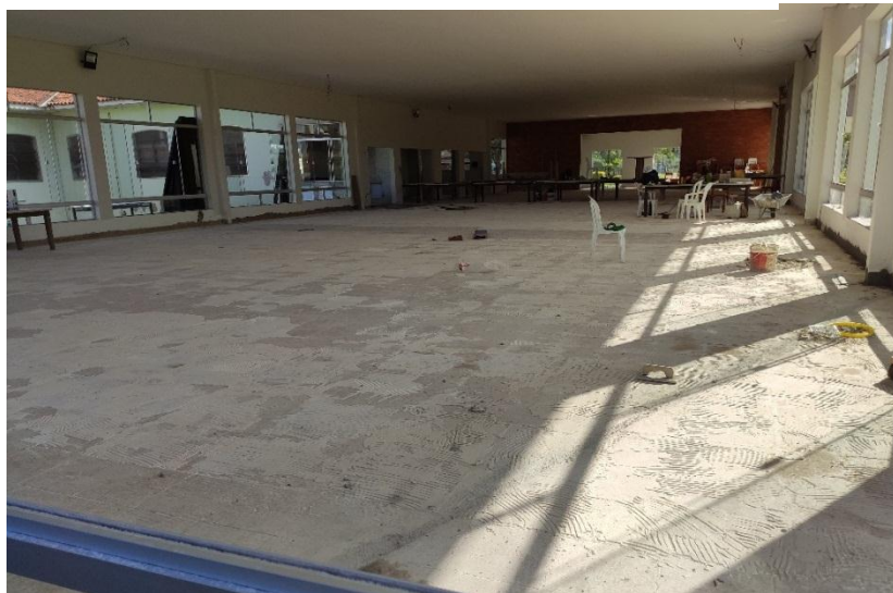
Figura 83: Local da obra
