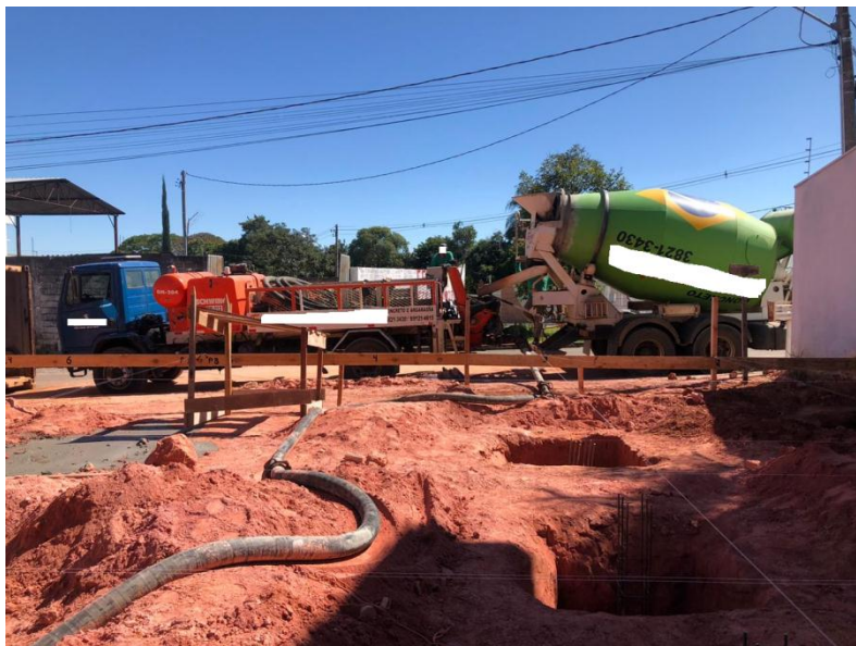
Figura 39: Caminhão-betoneira e bomba da concreteira
