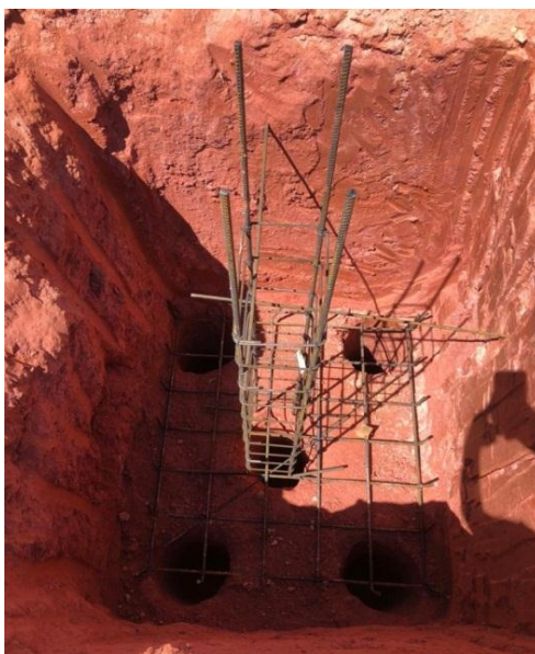
Figura 38: Barras longitudinais do pilar
