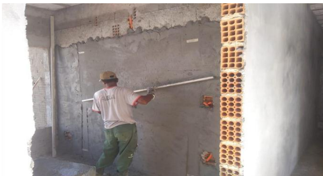
Figura 26: Sarrafeando emboço
