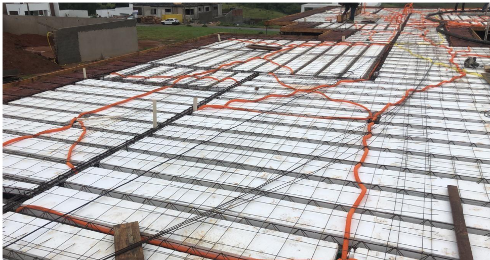
Figura 21: Passagem das armaduras e dos condutores
