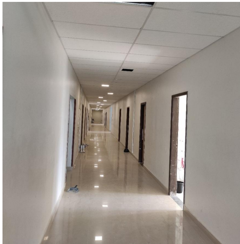
Figura 94: Colocação da iluminação
