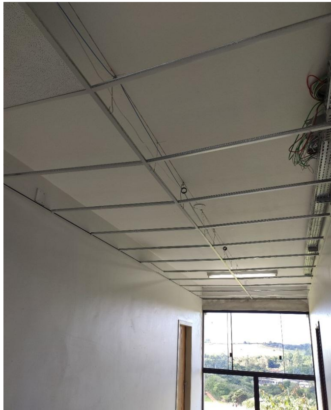
Figura 92: Estrutura de perfis metálicos
