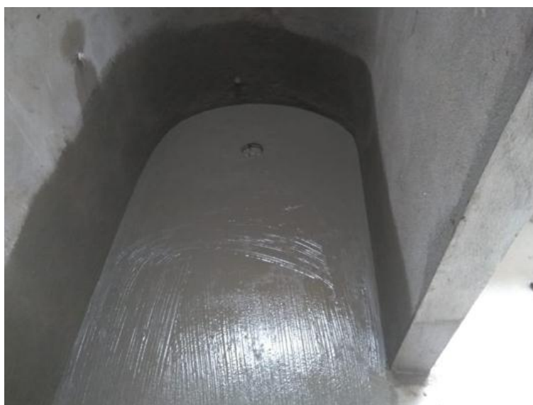
Figura 16: Aplicação do impermeabilizante
