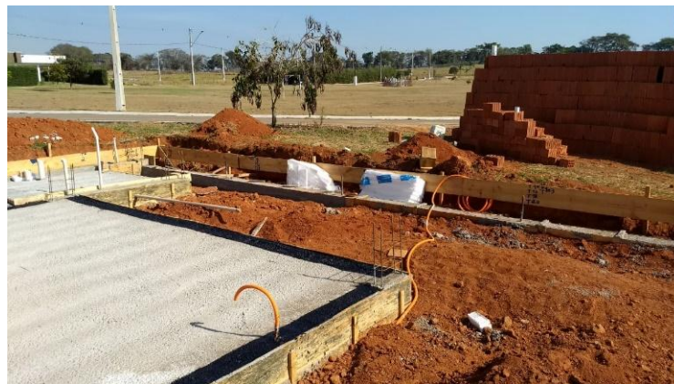
Figura 69: Impermeabilização das vigas baldrame
