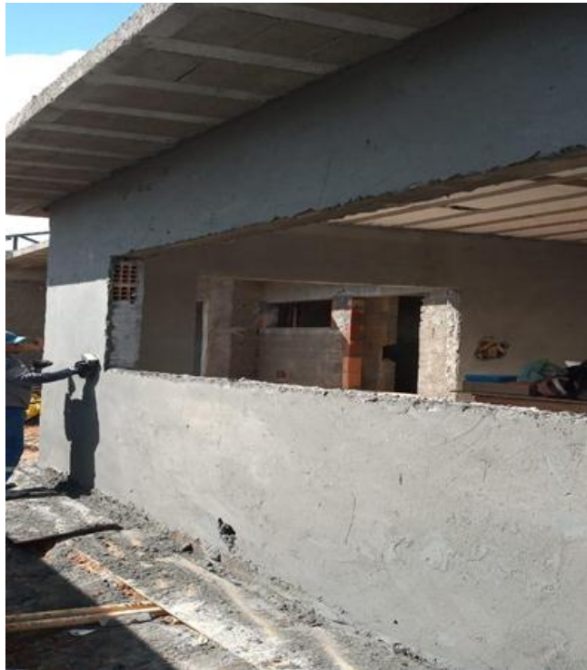
Figura 30: Acabamento da argamassa
