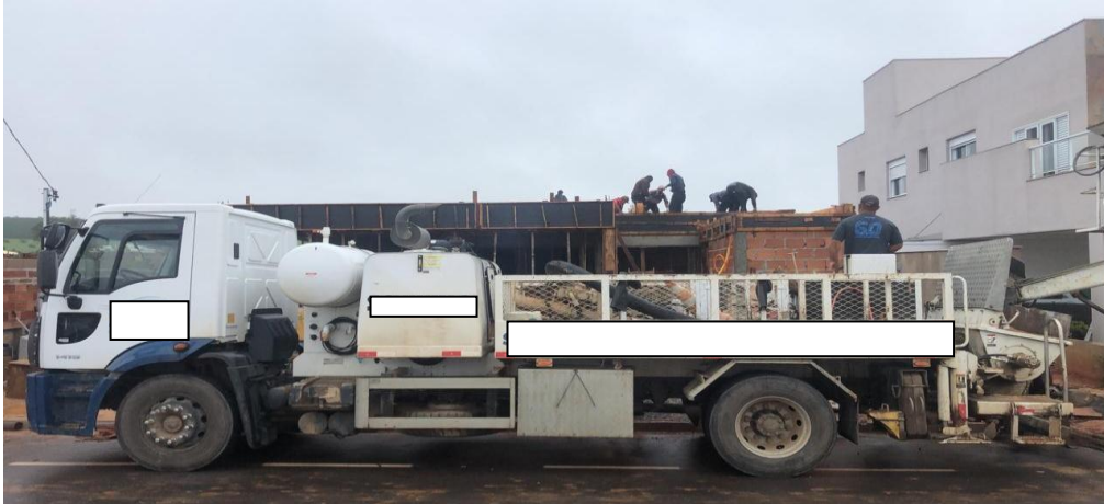
Figura 23: Caminhão de bombeamento
