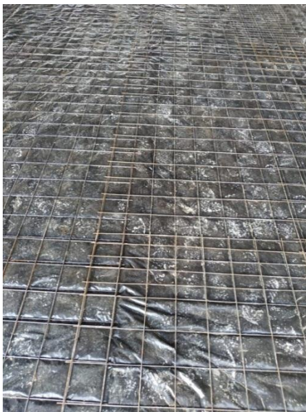
Figura 79: Colocação da malha de aço e da lona
