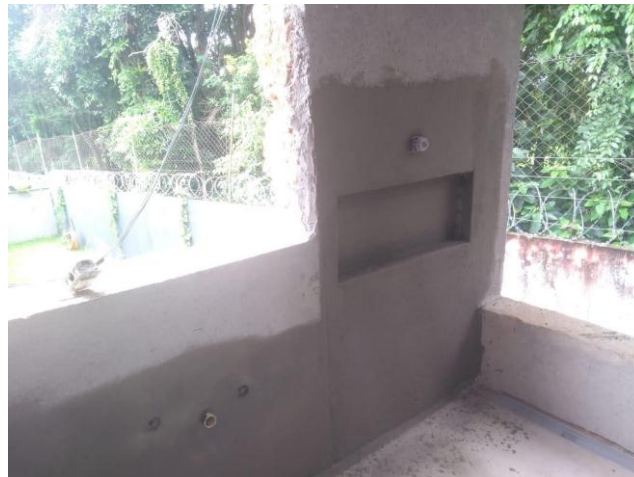
Figura 17: Aplicação de impermeabilizante na parte hidráulica, nichos e rodapés
