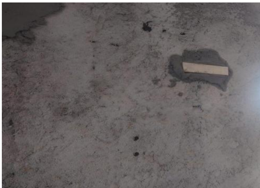
Figura 29: Talisca para nivelamento de massa
