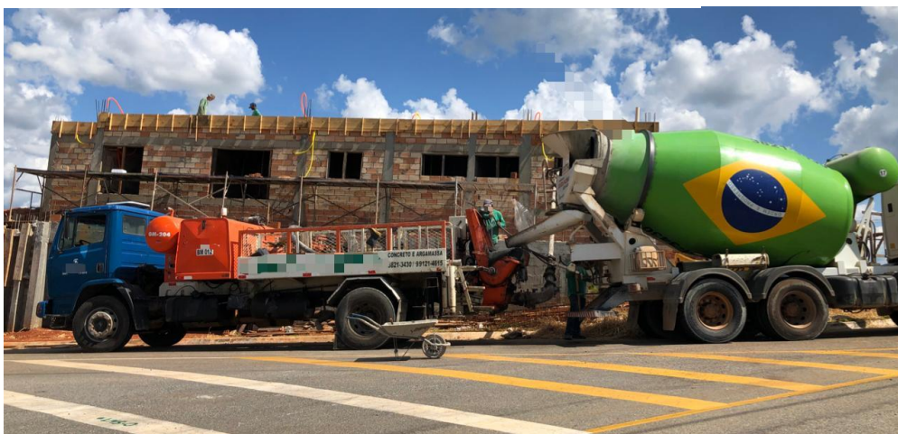
Figura 43: Caminhão-betoneira e bomba da concreteira
