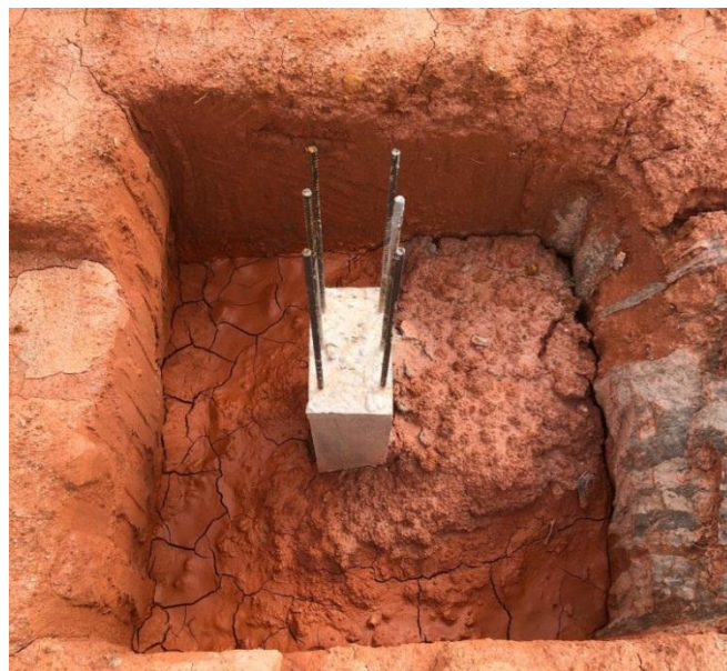
Figura 42: Sapata isolada finalizada
