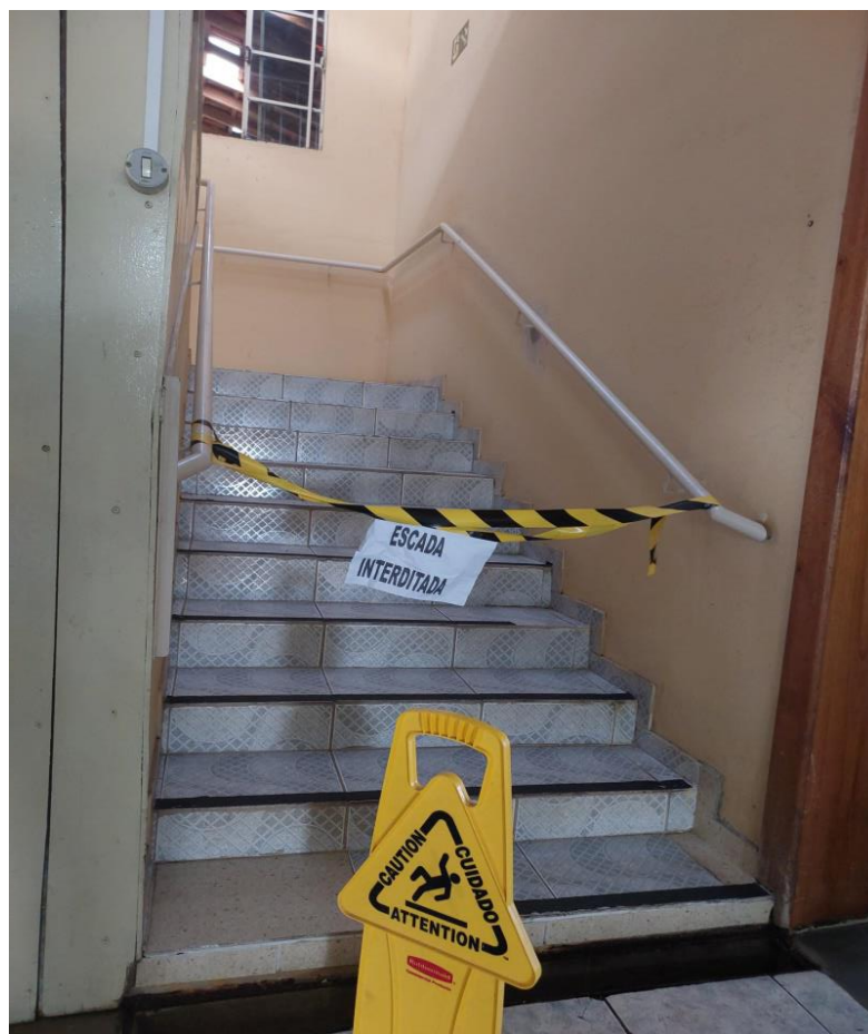
Figura 28 – Escada da Casa do Vovô
