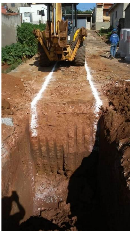
Figura 10 - Abertura de valas
