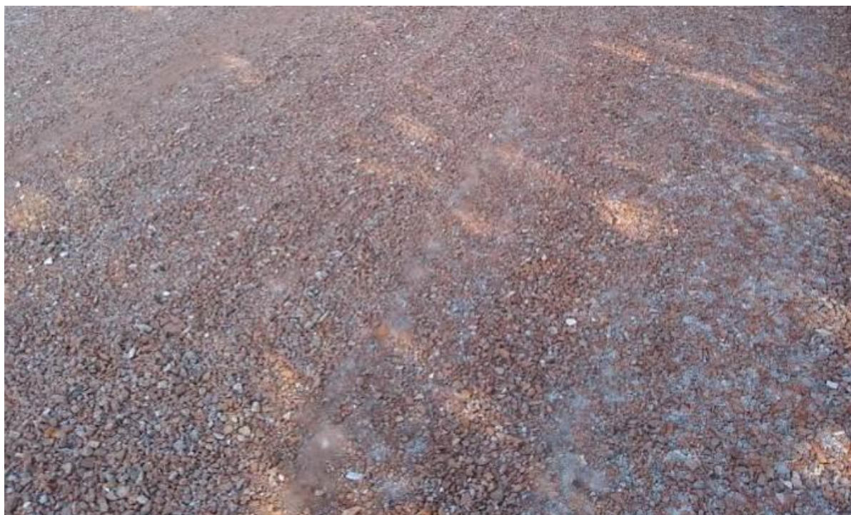
Figura 17 - Preparo da Base
