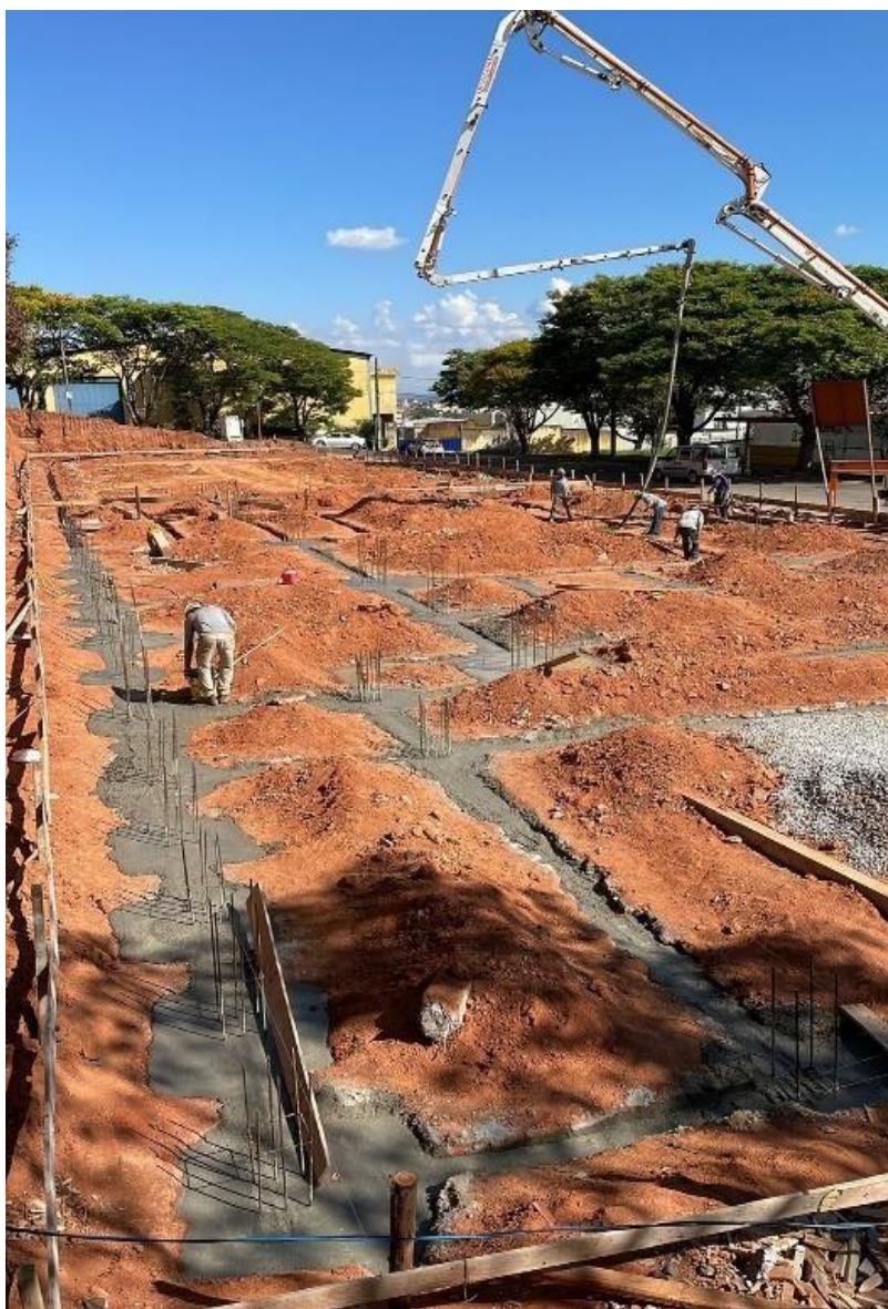
Figura 57 - Concretagem das vigas baldrame
