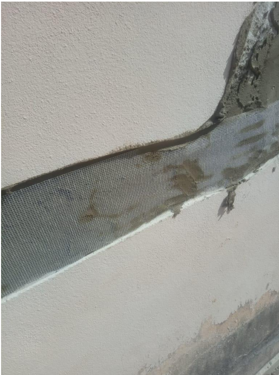
Figura 28 - Aplicação da argamassa com a tela de poliéster- Parede 1
