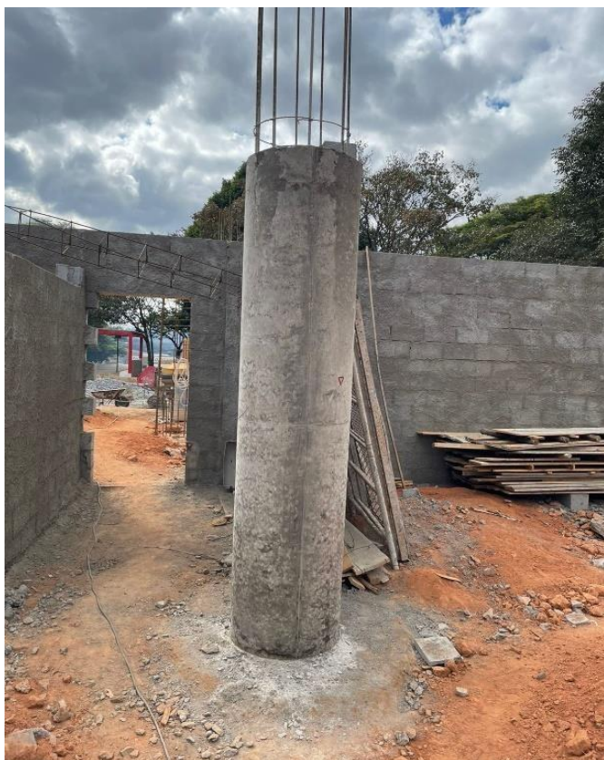
Figura 60 - Pilar concretado
