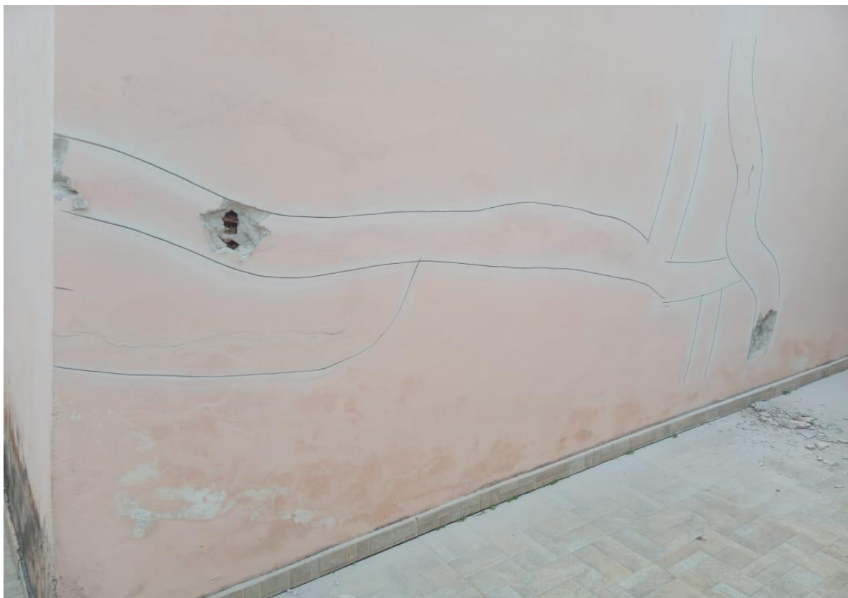
Figura 27 - Parede com cortes
