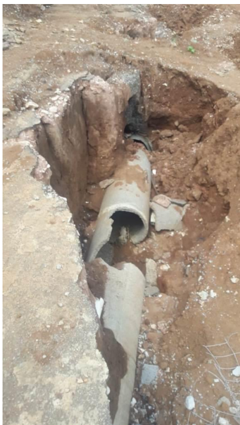
Figura 9 - Remoção do Sistema de Galerias
