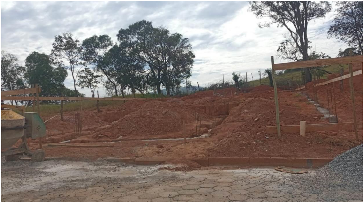
Figura 37 - Lote com obra iniciada
