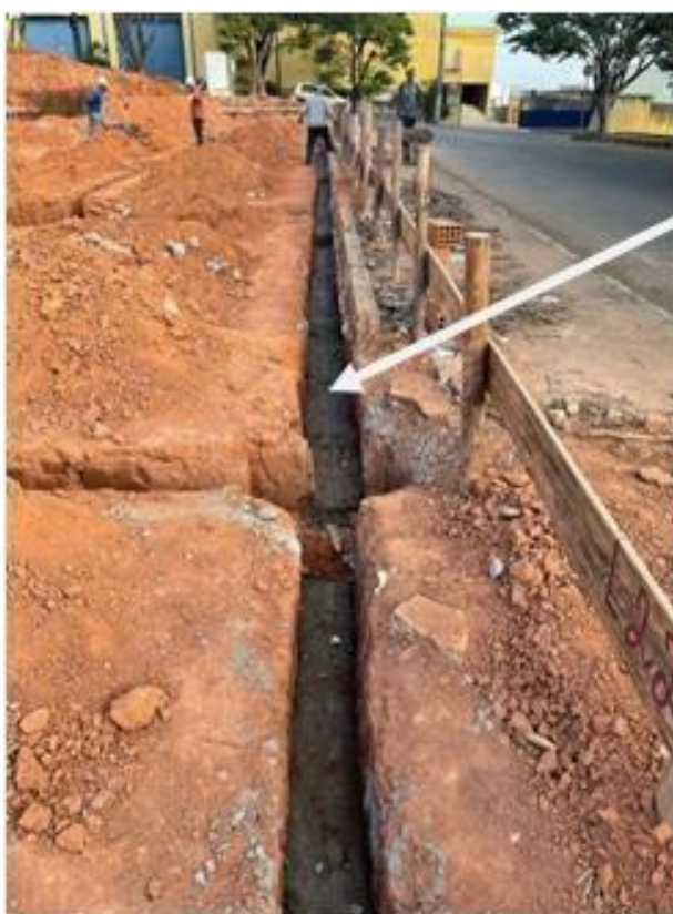
Figura 55 - Valas abertas com lastro de concreto
