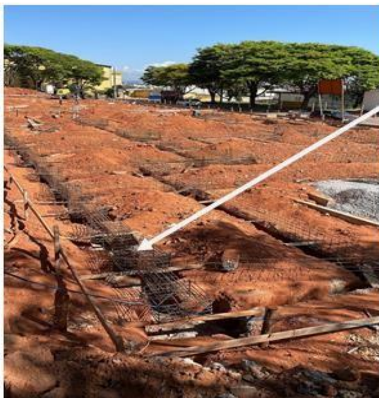
Figura 56 - Armação posicionada
