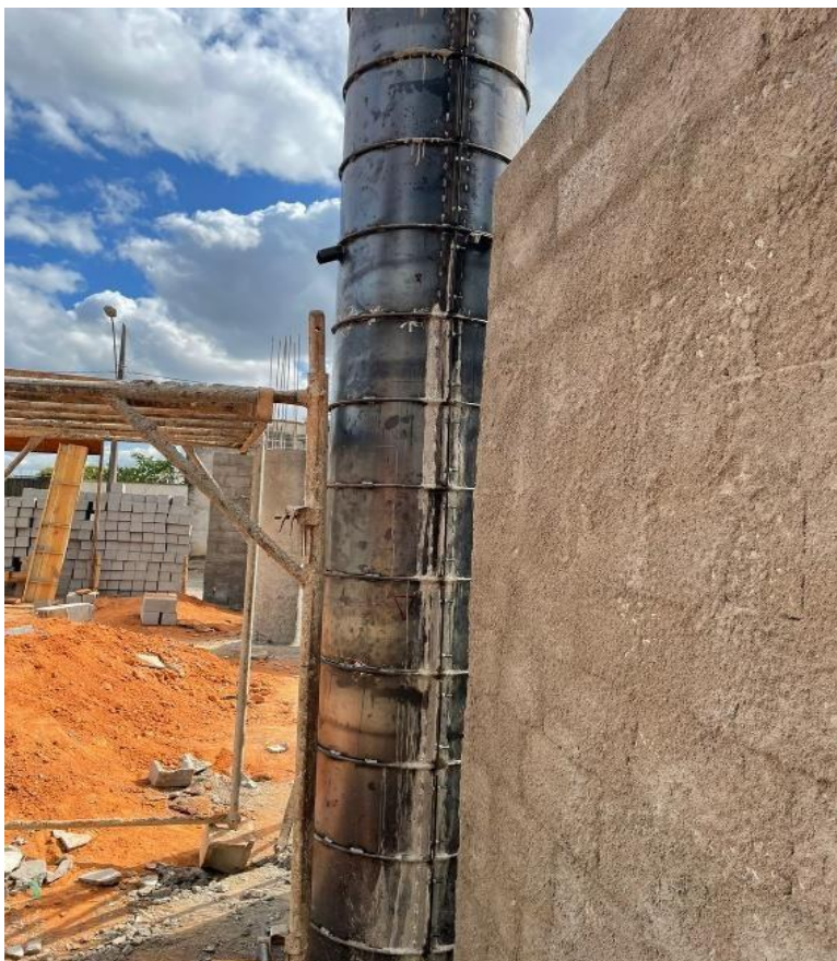
Figura 59 - Formas dos pilares
