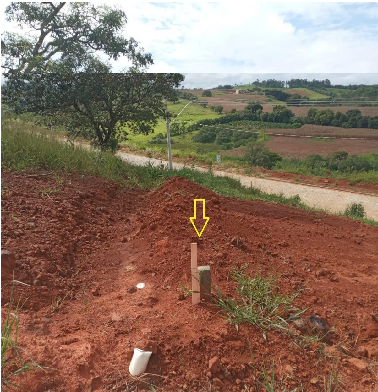
Figura 41 Estaca de Madeira e Piquete de Concreto
