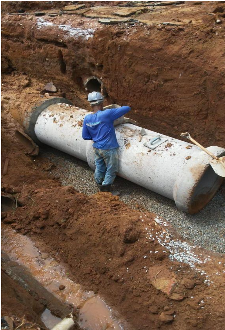
Figura 12 - Assentamento dos tubos de concreto
