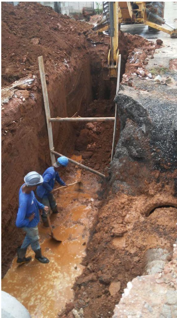
Figura 11 - Abertura de valas com escoramentos
