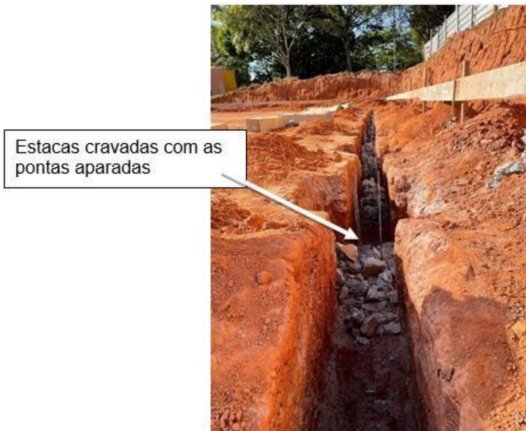
Figura 51 - Estacas cravadas
