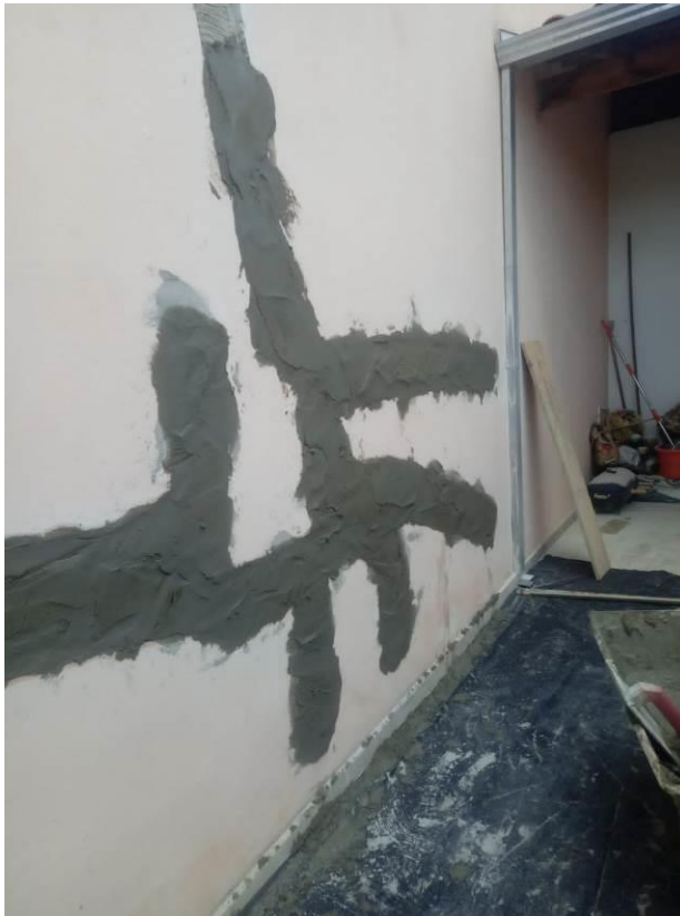
Figura 30 - Aplicação da segunda camada de argamassa
