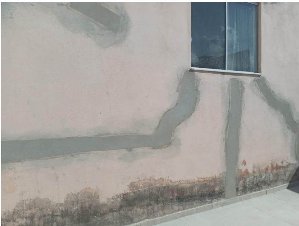
Figura 31 - Parede rebocada- Parede 1
