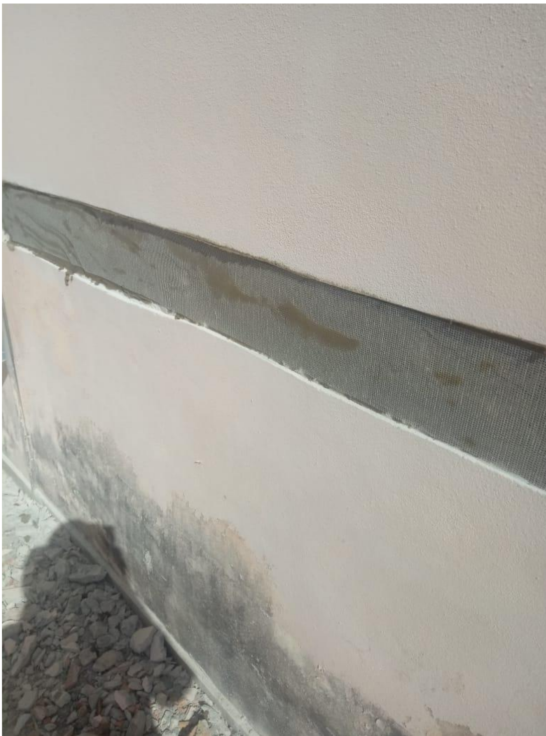
Figura 29 - Aplicação da argamassa com a tela de poliéster- Parede 2
