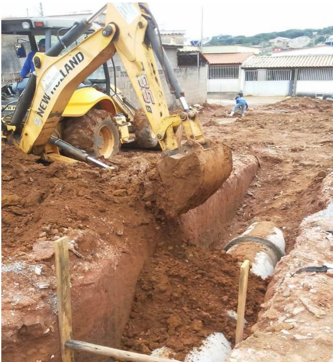
Figura 14 - Reaterro de valas
