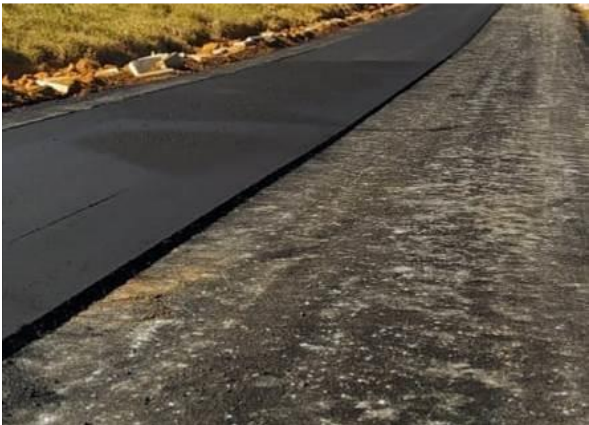
Figura 18 - Execução da Pavimentação
