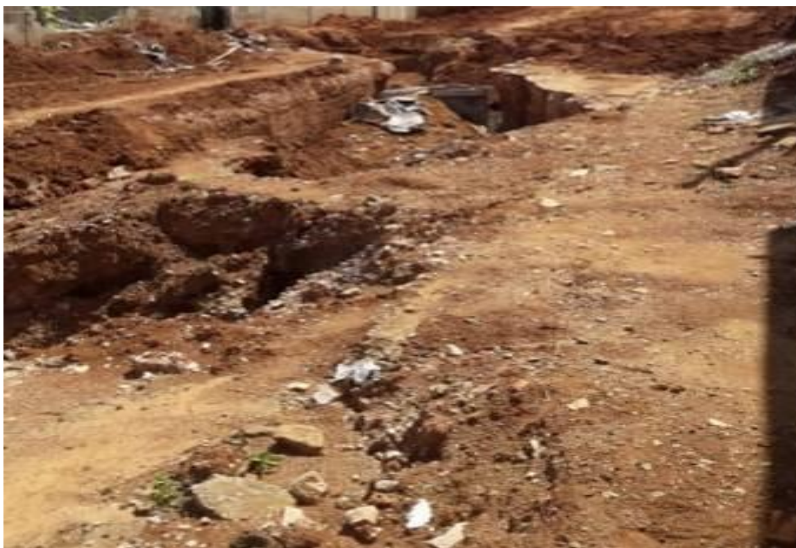
Figura 8 - Movimentação de Terra
