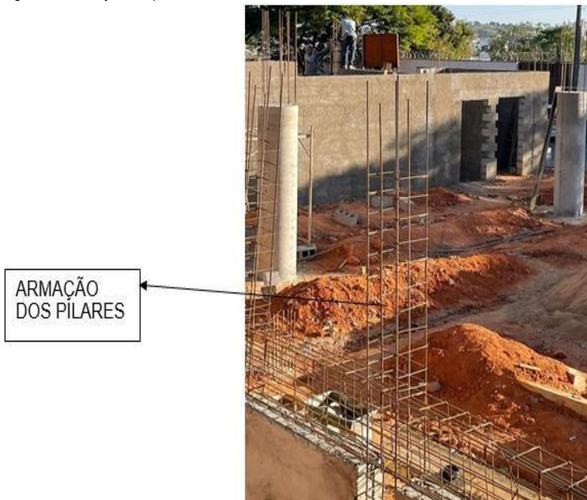
Figura 58 - Armação dos pilares
