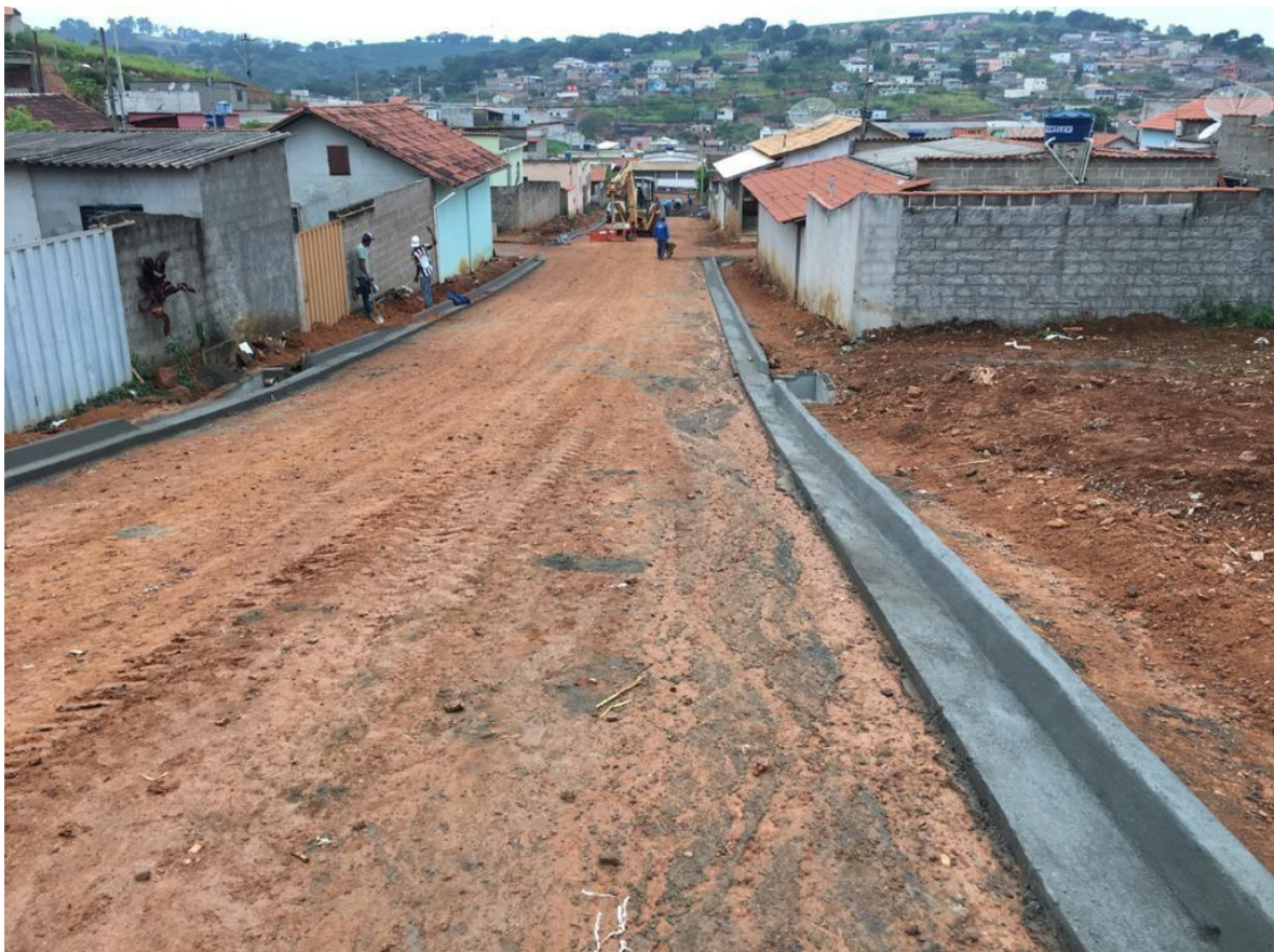
Figura 16 - Regularização do solo
