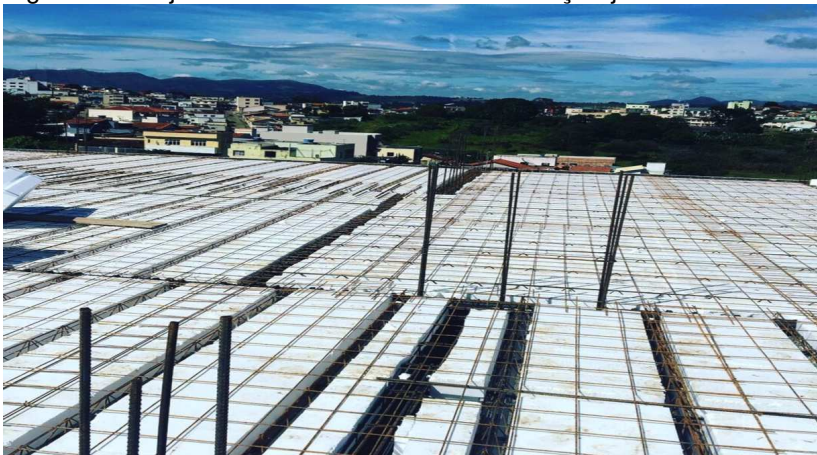
Figura 55 - Laje montada com a malha de retração já colocada
