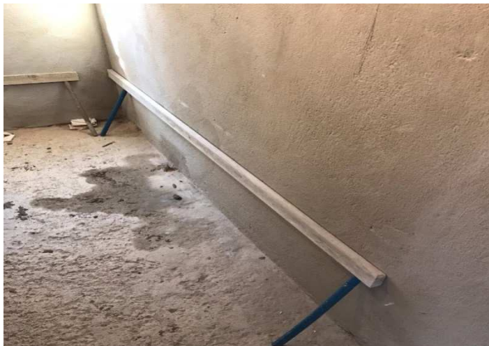
Figura 44 - Régua Niveladora para início da primeira fiada
