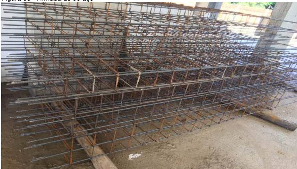
Figura 58 - Armaduras de aço
