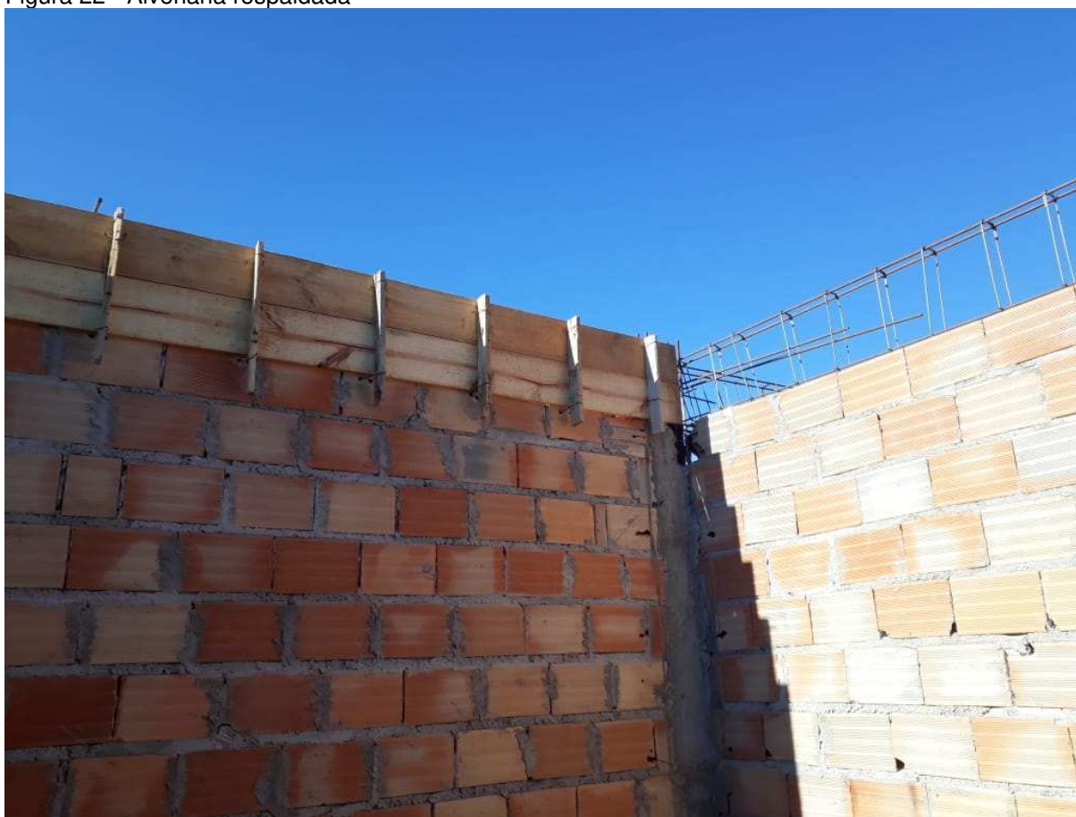
Figura 22 - Alvenaria respaldada
