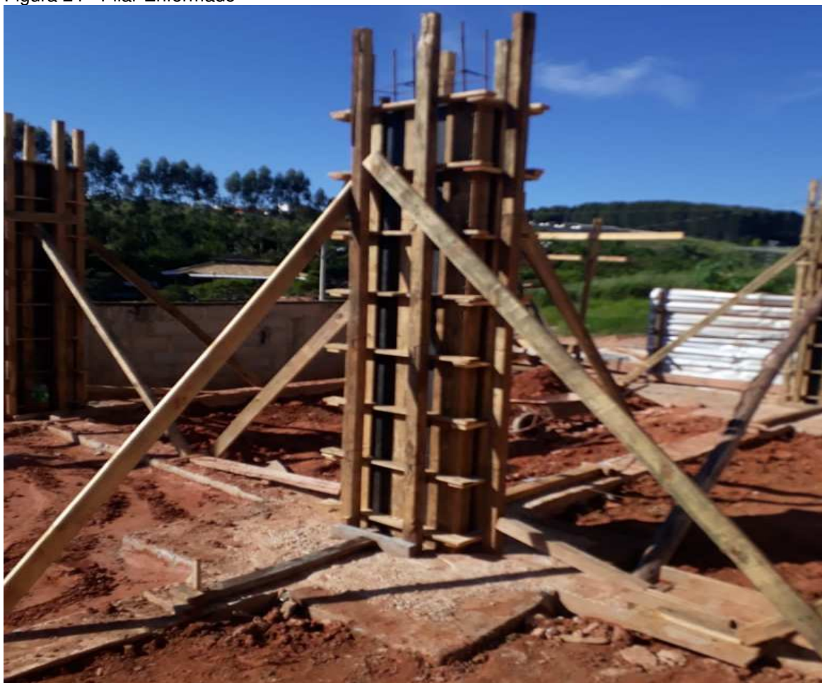
Figura 24 - Pilar Enformado
