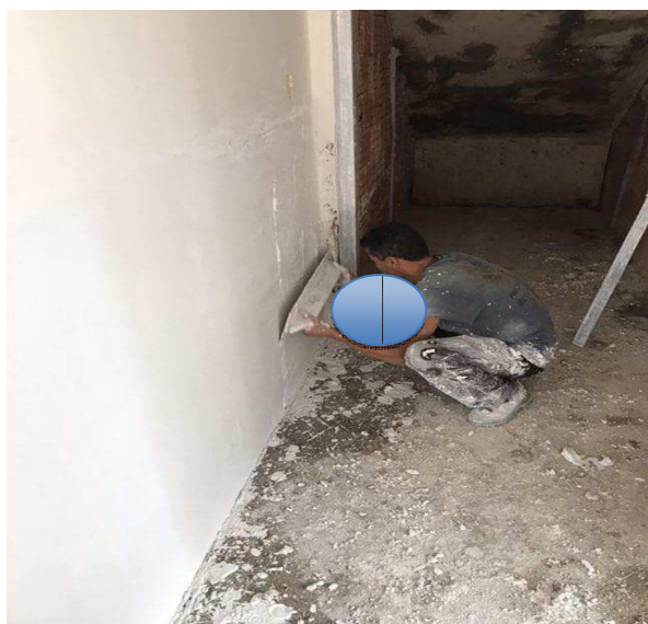
Figura 40 - Aplicação do gesso liso com desempenadeira
