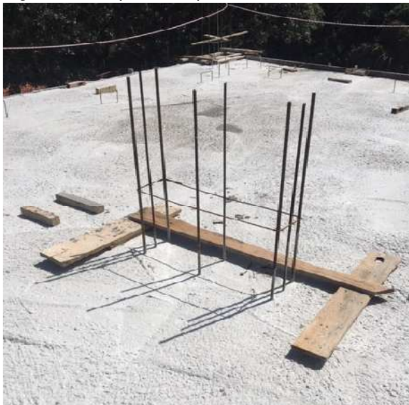
Figura 60 - Espera dos pilares
