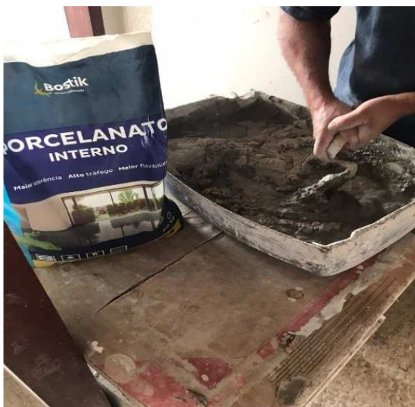
Figura 43- Preparo de Argamassa Pré fabricada
