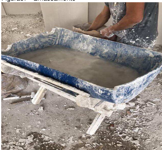
Figura37 - Emassamento
