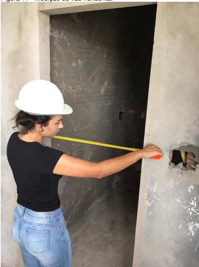
Figura 11 - Medição de vão horizontal
