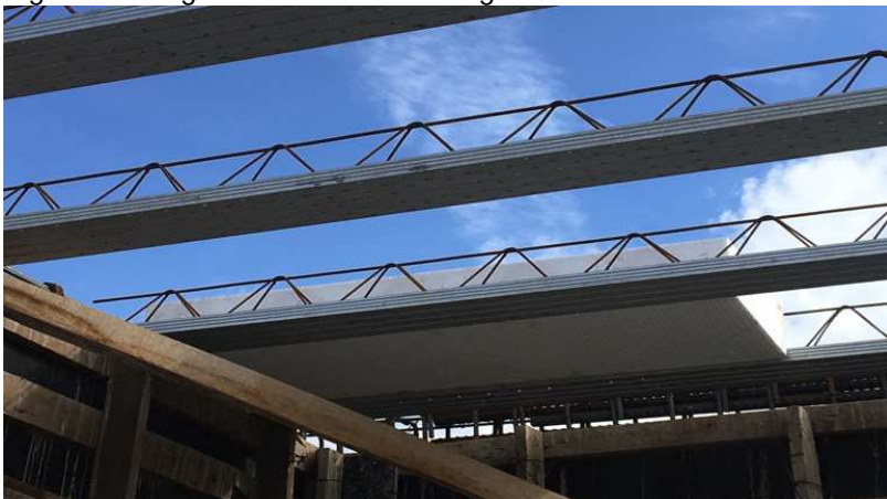
Figura 53 - Vigotas encaixadas as vigas
