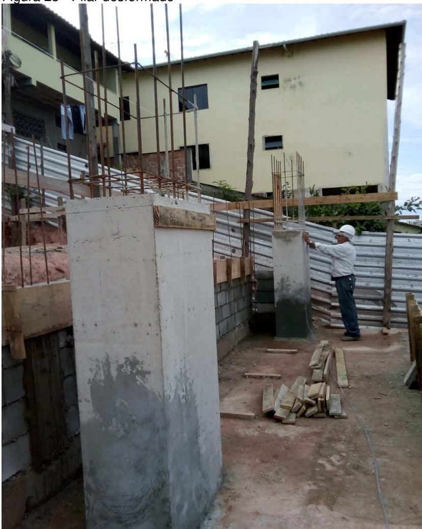
Figura 25 - Pilar desformado
