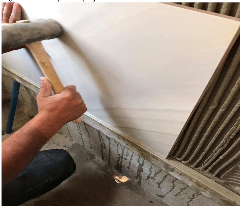
Figura 49- Fixação da peça com auxílio do martelo de borracha
