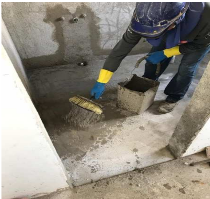
Figura 34 - Cura úmida
