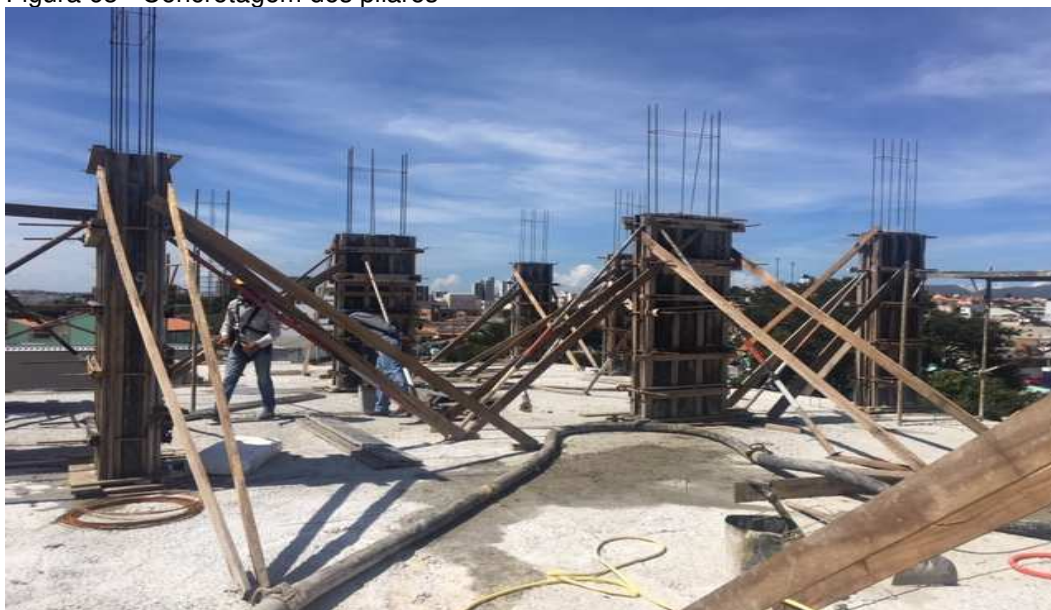
Figura 63 - Concretagem dos pilares
