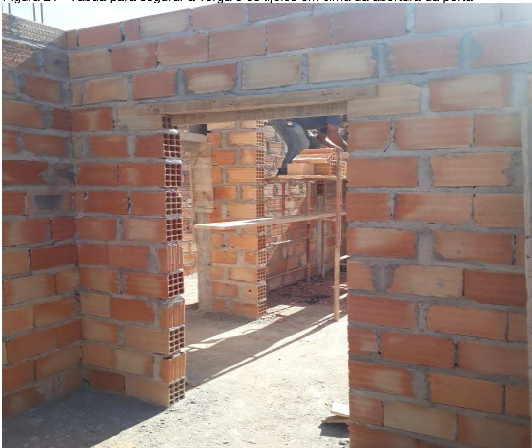
Figura 21 –Tábua para segurar a verga e os tijolos em cima da abertura da porta
