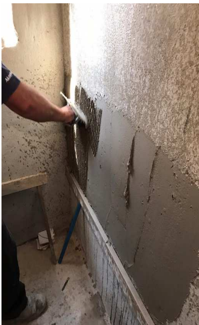
Figura 47 - Aplicação de argamassa na superfície
