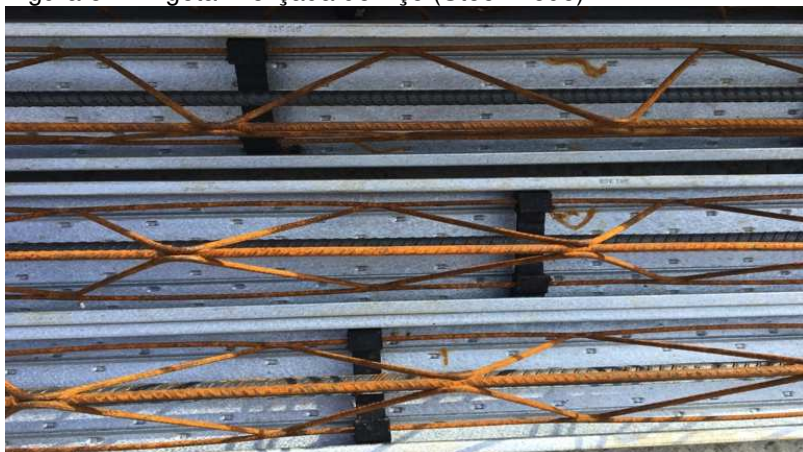
Figura 52 - Vigota Treliçada de Aço (Steel Mode)
