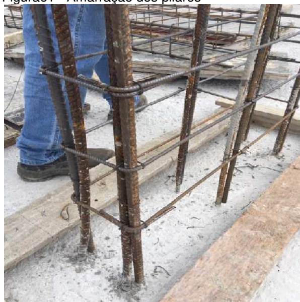
Figura61 - Amarração dos pilares
