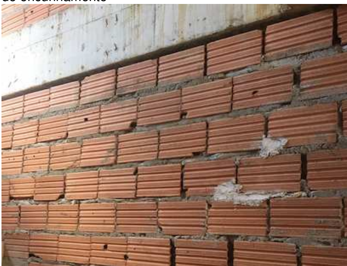
Figura 71 - Alvenaria aguardando conclusão de todos os pavimentos para receber expansor nos vãos de encunhamento
