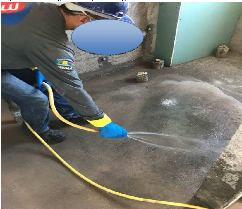
Figura 29 - Lavagem com jato de água
