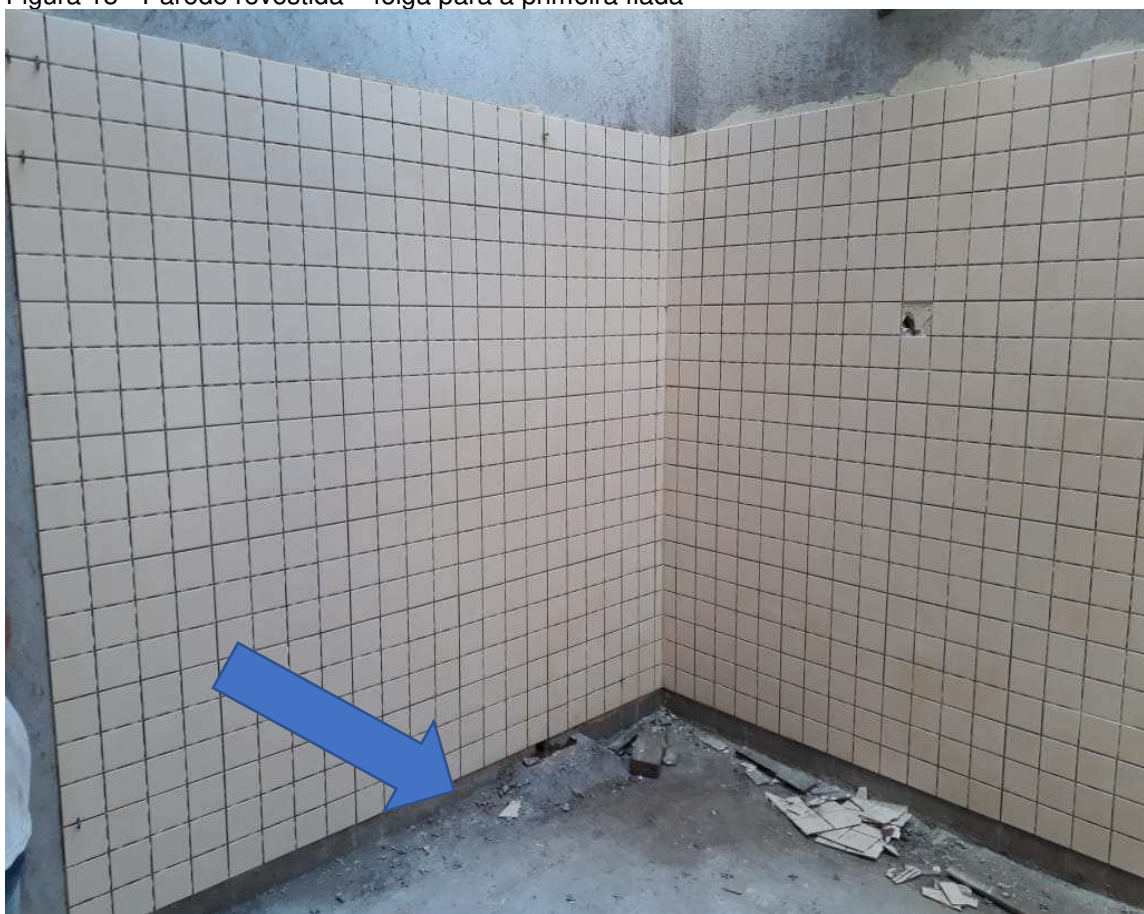
Figura 18 - Parede revestida – folga para a primeira fiada
