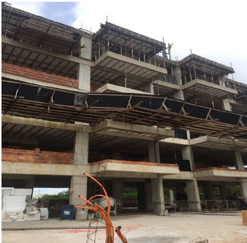
Figura 64 - Estrutura em Concreto Armado e Alvenaria Convencional
