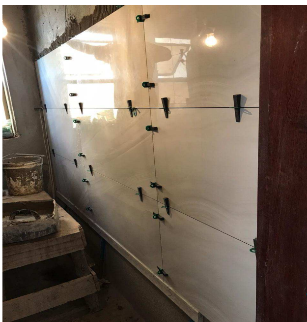
Figura 50 - Espaçadores e Niveladores
