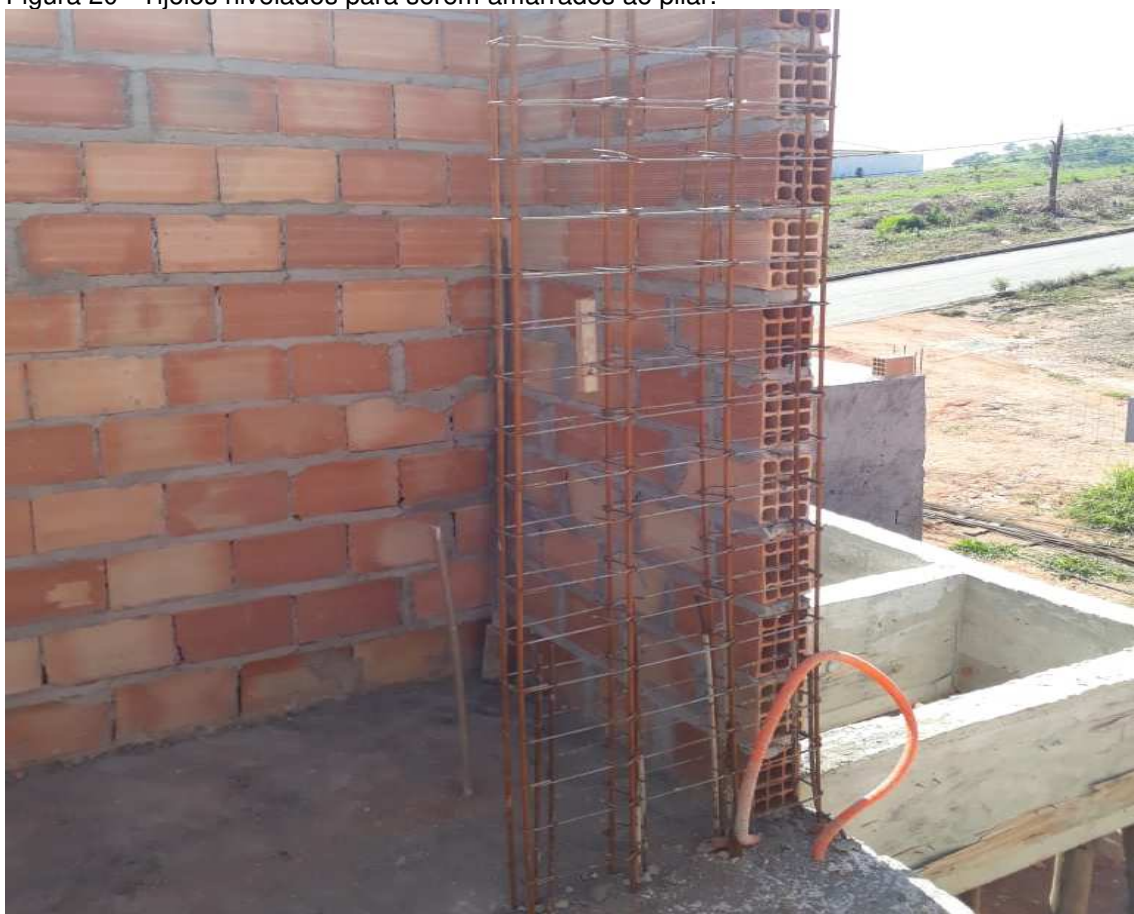
Figura 20 –Tijolos nivelados para serem amarrados ao pilar.
