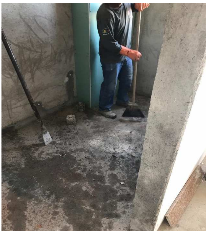
Figura 28 - Remoção de partículas com vassoura piaçava
