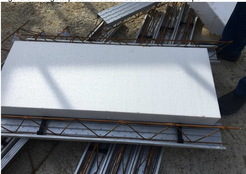
Figura 54 - Vigota preenchida em seus vãos com isopor
