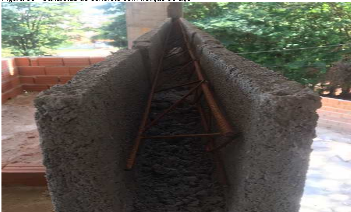
Figura 66 - Canaletas de concreto com treliças de aço
