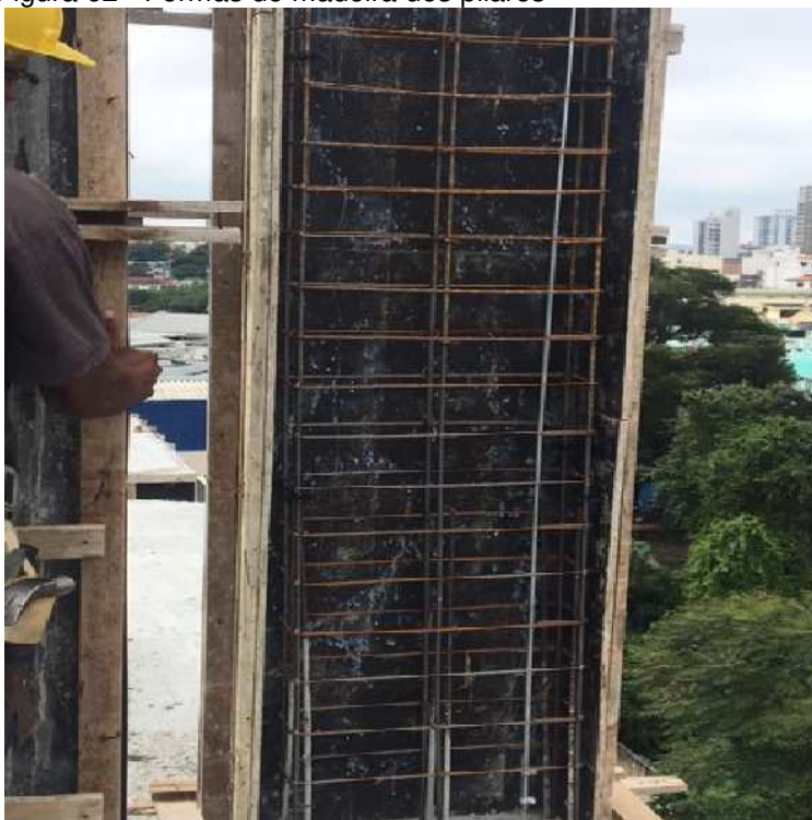
Figura 62 - Formas de madeira dos pilares
