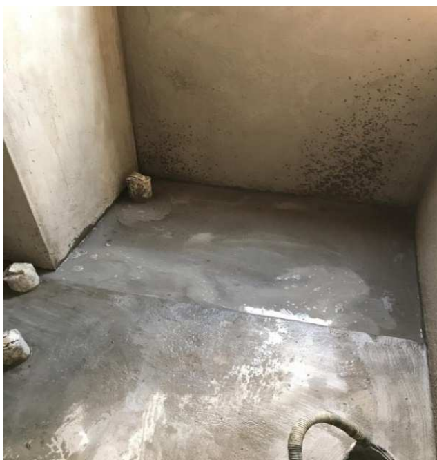
Figura 35 - Teste de estanqueidade
