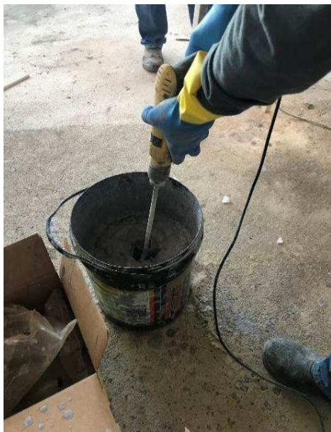
Figura 31 - Mistura homogênea
