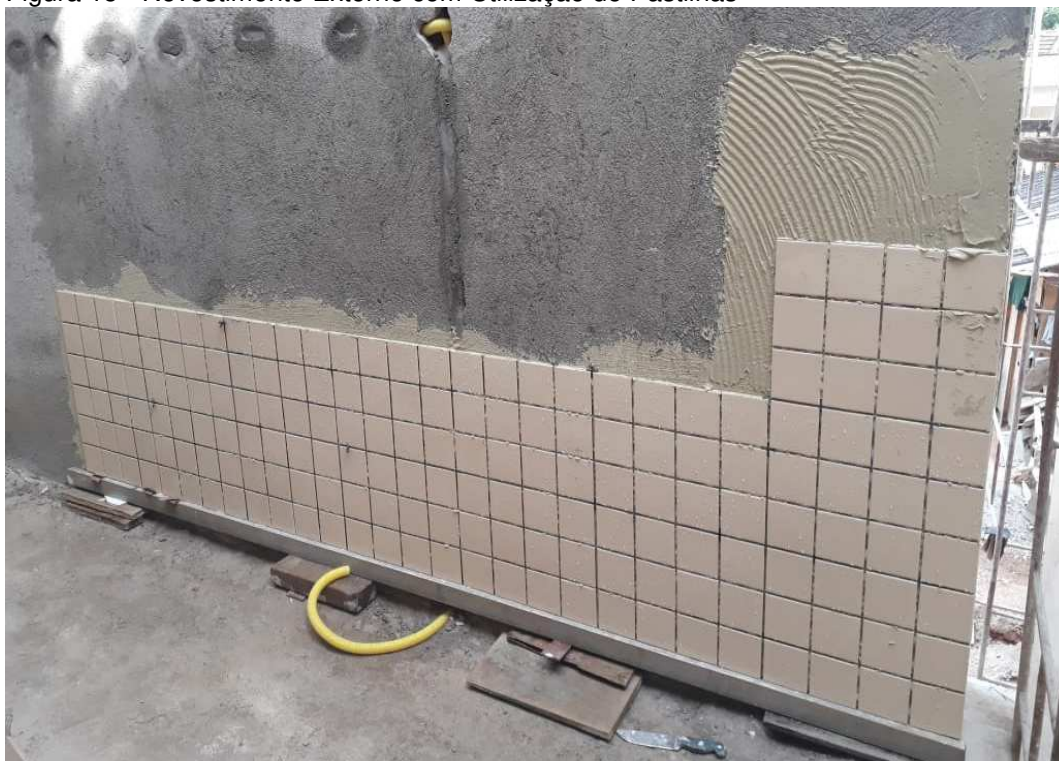
Figura 15 - Revestimento Externo com Utilização de Pastilhas
