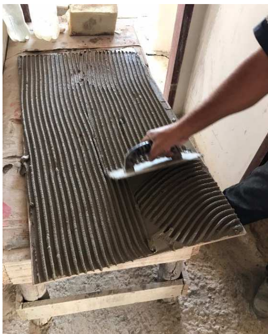
Figura 48 - Aplicação de argamassa na peça
