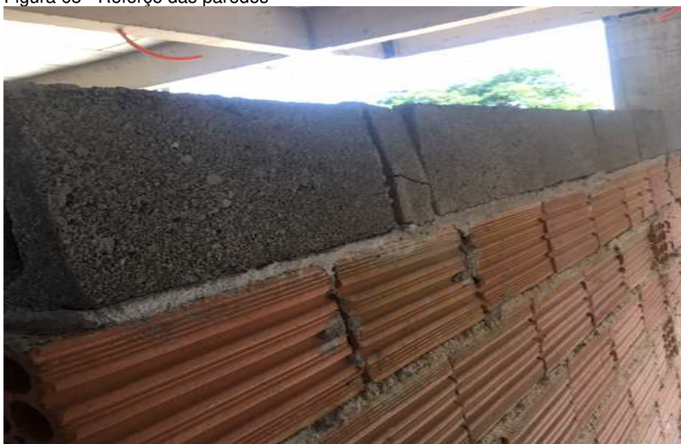
Figura 68 - Reforço das paredes
