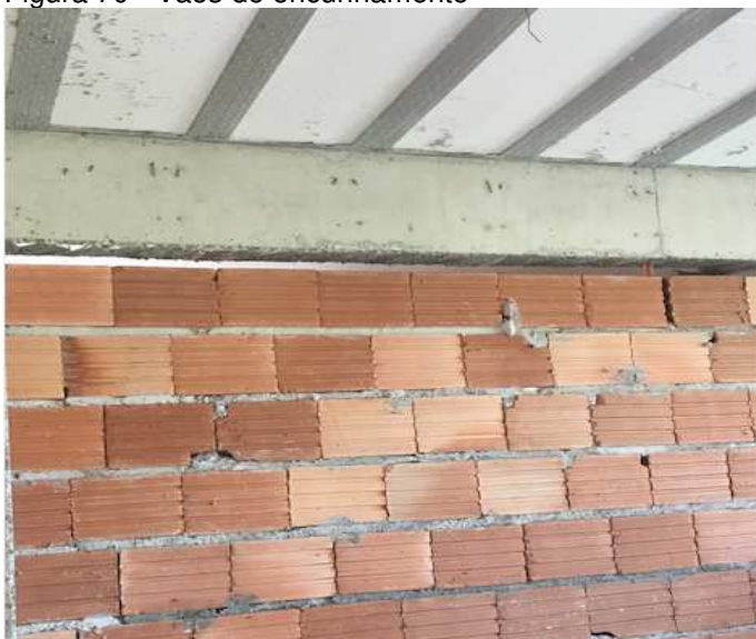
Figura 70 - Vãos de encunhamento
