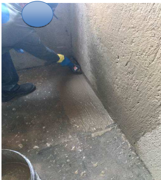
Figura 32 - Aplicação do Tecplus Top com auxílio de trincha
