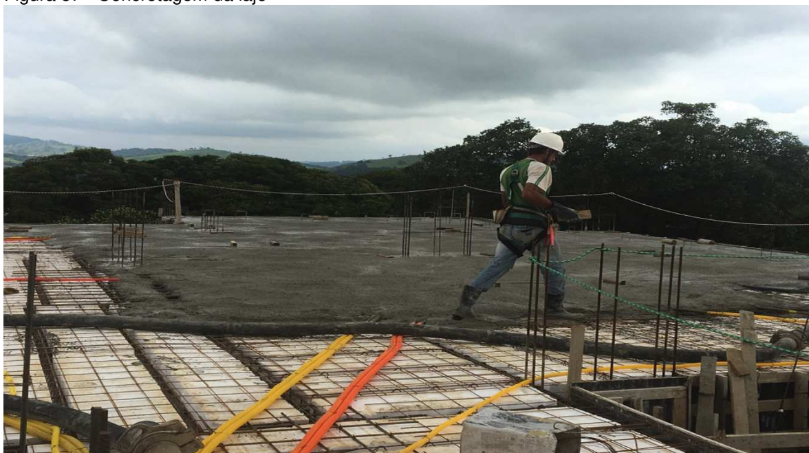
Figura 57 - Concretagem da laje
