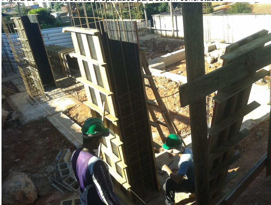
Figura 23 - Pilares sendo preparados para serem concretados
