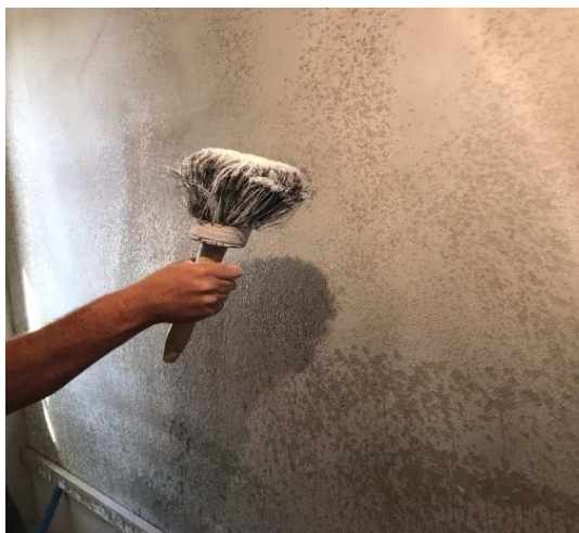
Figura 45 - Limpeza da superfície
