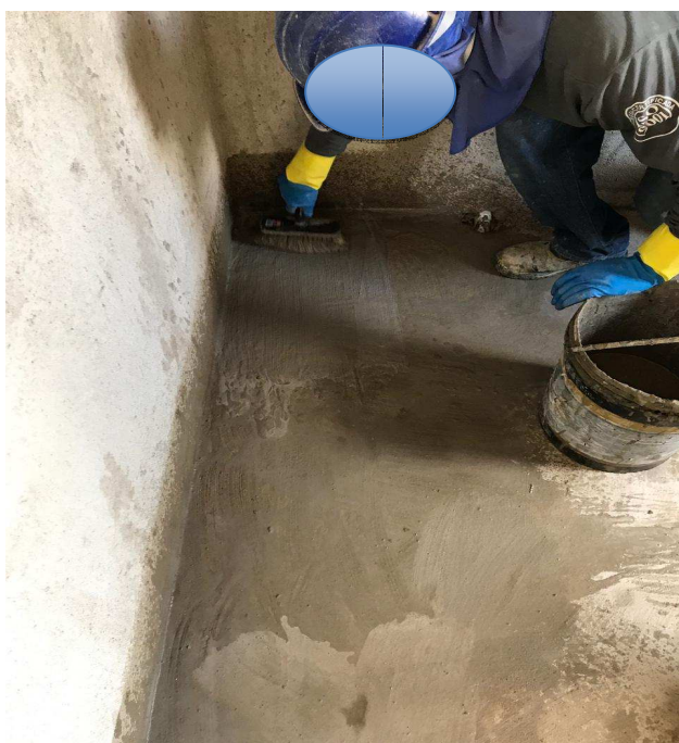
Figura 33 - Aplicação da segunda demão de Tecplus Top
