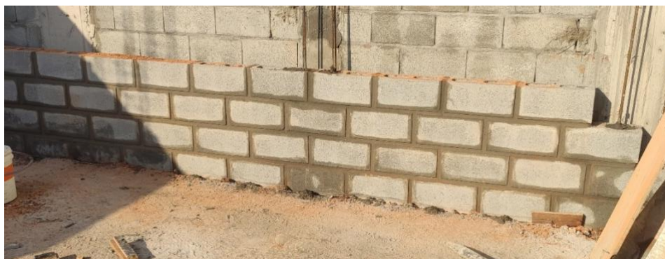
Figura 46 - Técnica de juntas amarradas
