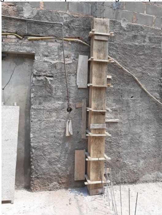
Figura 30 - Formas para concretagem dos pilares
