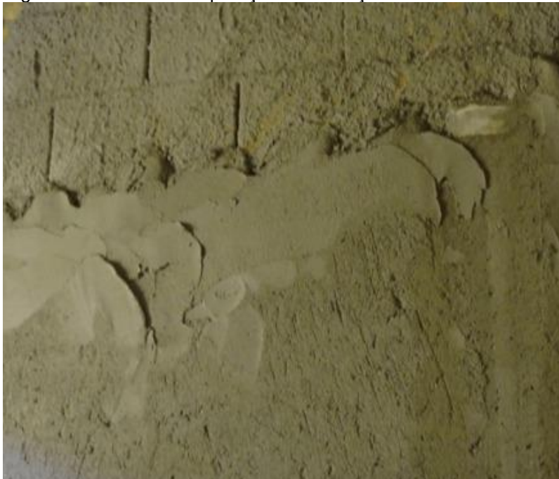
Figura 3 - Processo de aplicação do emboço em residência familiar
