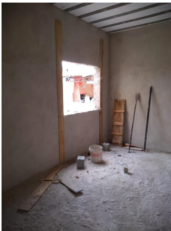
Figura 35 - Paredes rebocadas da suíte
