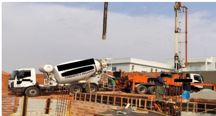
Figura 54 - Transporte e lançamento de concreto
