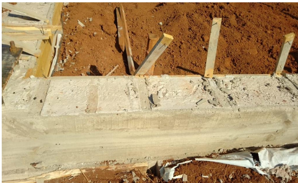
Figura 67 – Concreto sem as formas
