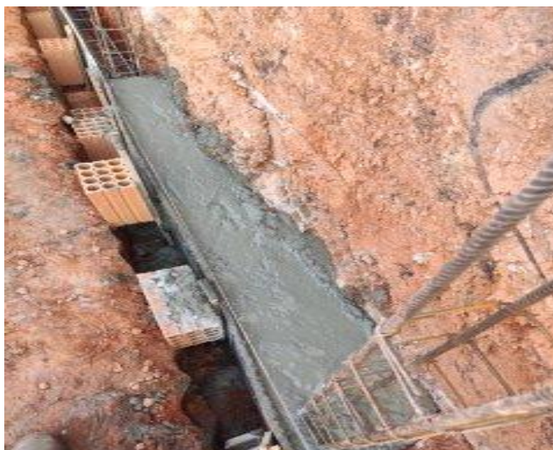
Figura 44 - Fundação do muro de arrimo concretada
