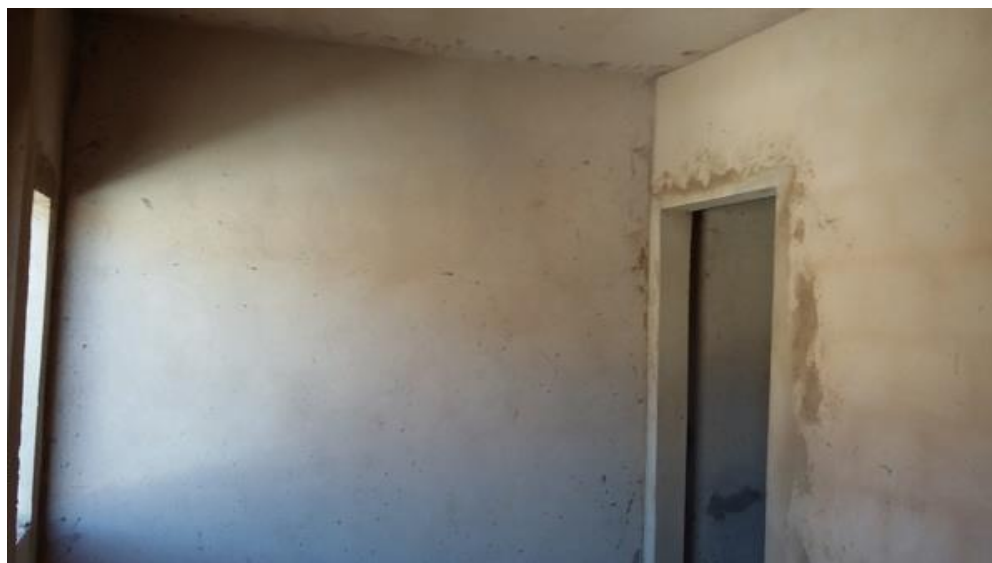
Figura 5 - Reboco finalizado em residência familiar
