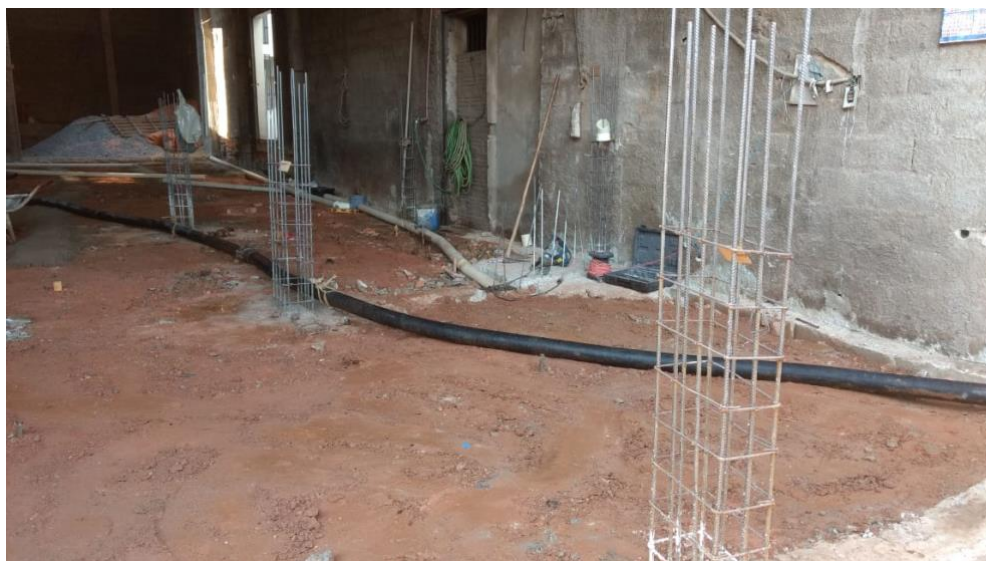
Figura 28 - Armação do pilar in loco 2
