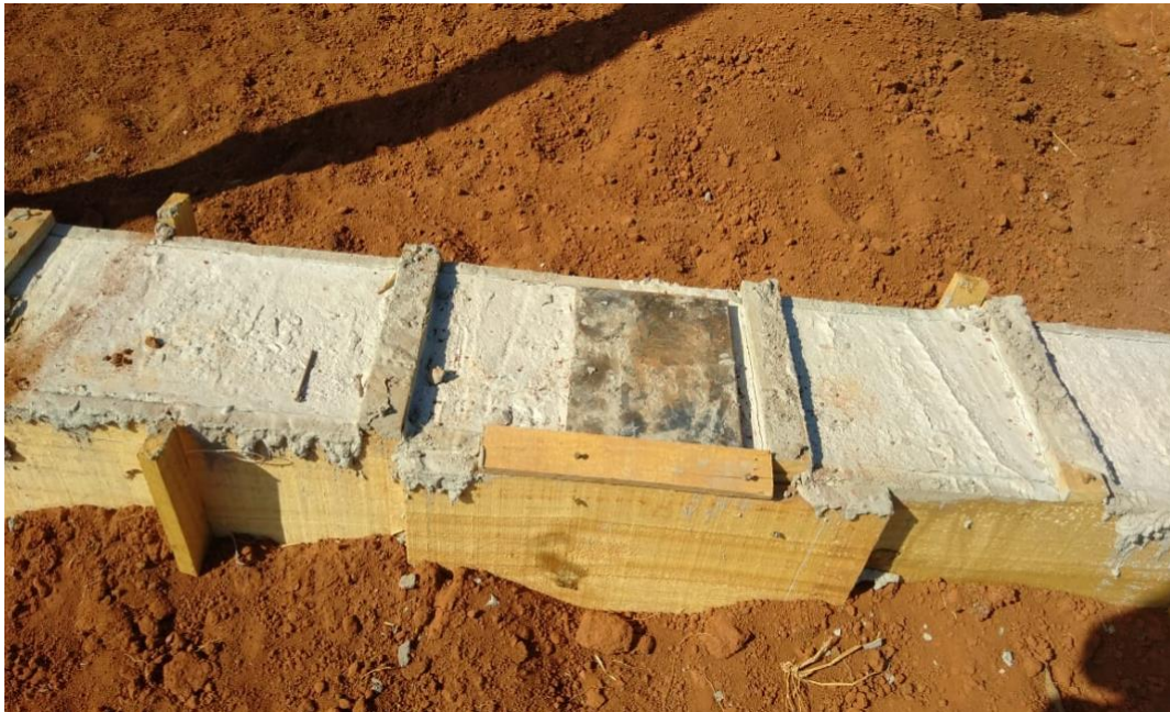
Figura 66 – Retirada das formas
