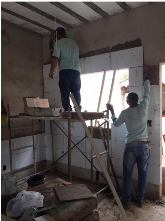
Figura 38 - Assentamento dos pisos porcelanatos nas paredes da cozinha
