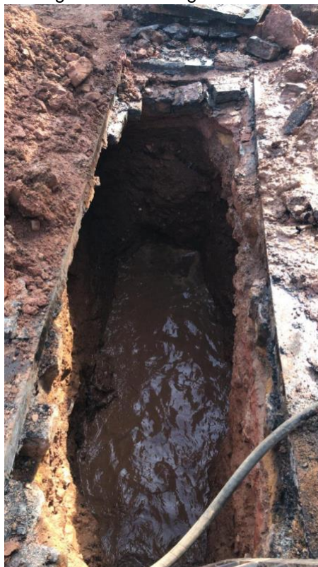
Figura 88 - Drenagem da vala
