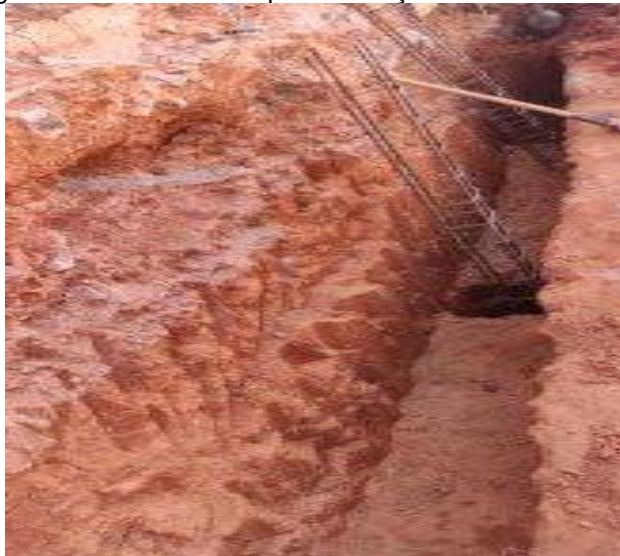
Figura 42 - Vala e cavas para fundação do muro de arrimo
