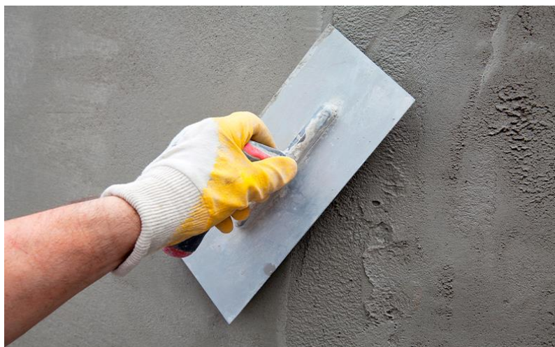
Figura 4 - Aplicação do reboco e materiais utilizados
