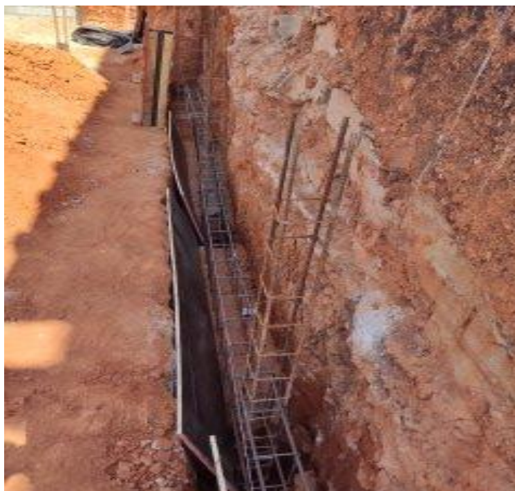
Figura 43 - Armaduras posicionadas
