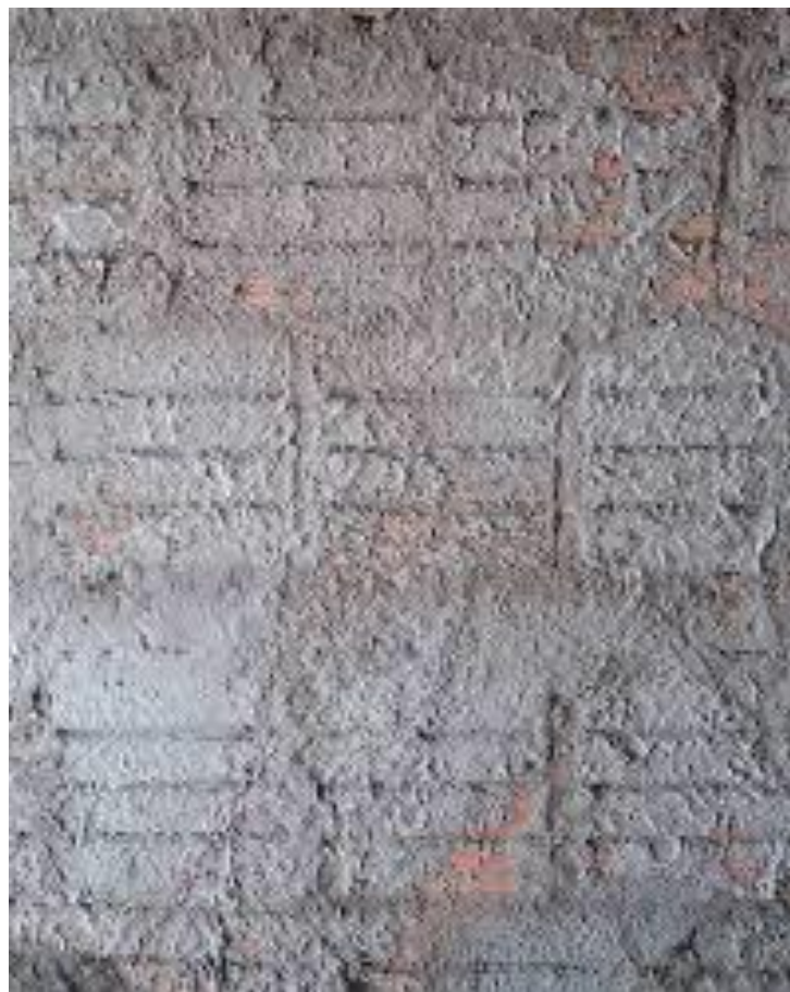
Figura 2 - Execução de chapisco em residência familiar
