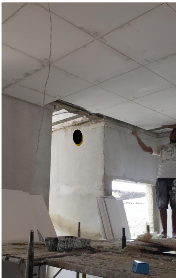
Figura 40 - Execução do rebaixamento de gesso
