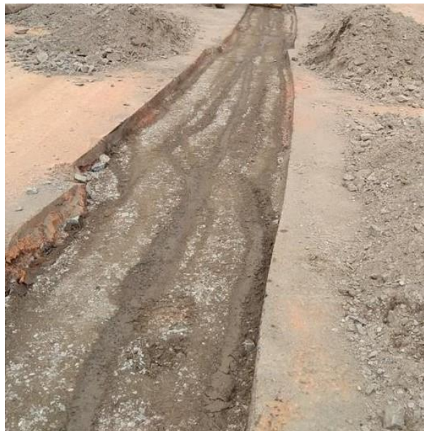
Figura 85 - Abertura do asfalto com o auxílio de serra clipper
