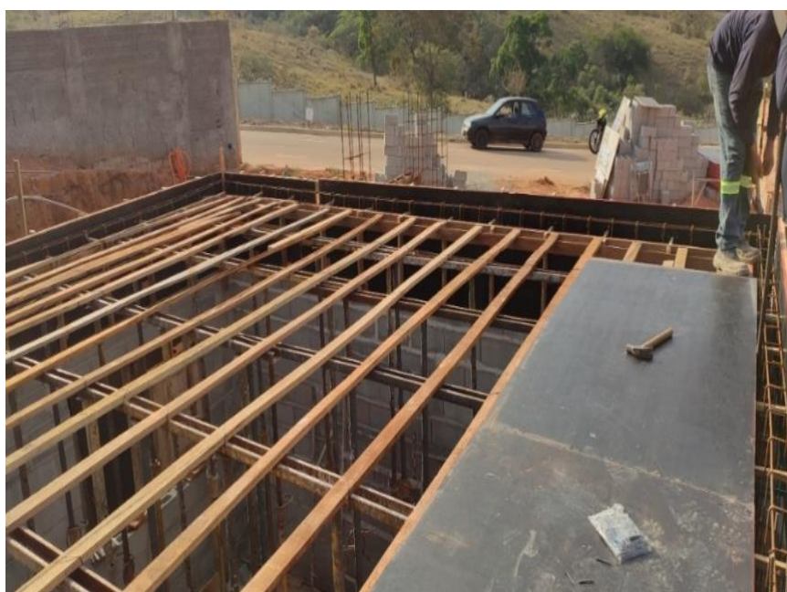
Figura 48 - Montagem da fôrma da laje maciça
