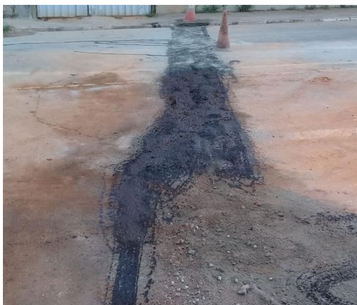
Figura 94 - Processo de emulsão asfáltica
