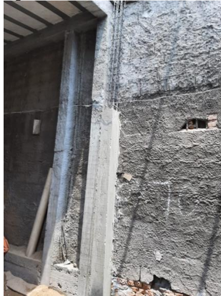
Figura 31 - Pilar de concreto armado
