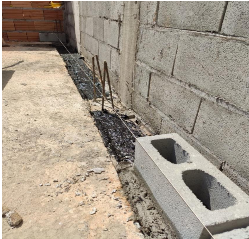
Figura 45 - Início da primeira fiada de blocos
