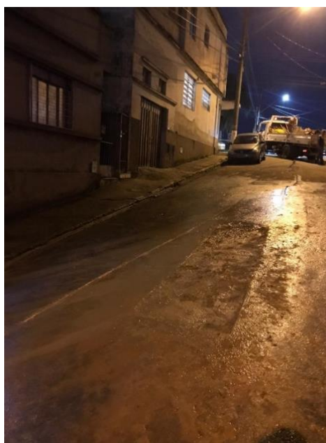
Figura 95 - Reconstituição do pavimento asfáltico
