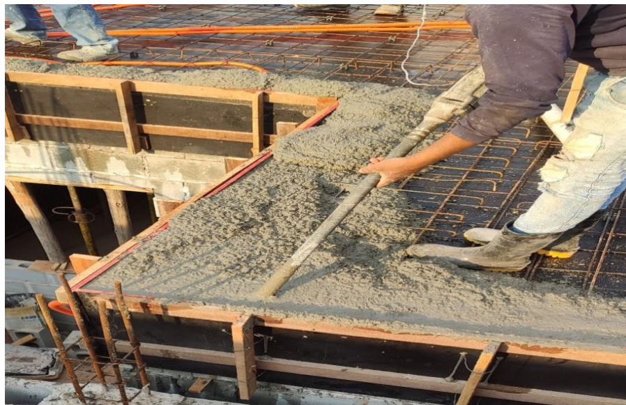
Figura 56 - Adensamento do concreto
