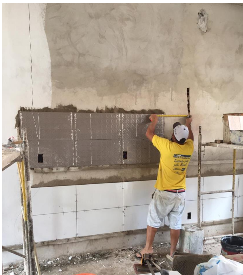
Figura 37 - Assentamento dos pisos porcelanatos nas paredes da cozinha
