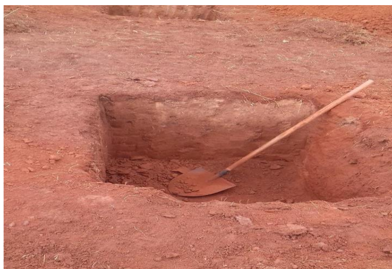
Figura 60 - Escavação das sapatas com pá e cavadeira
