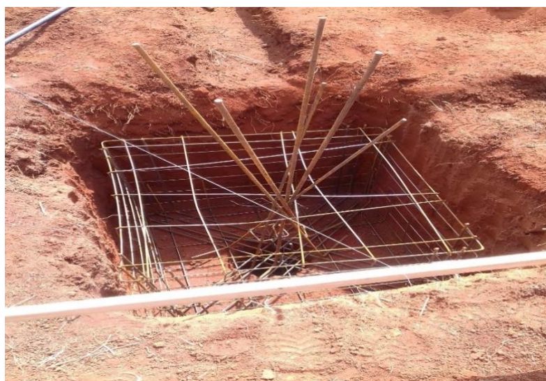
Figura 62 – Armadura na sapata
