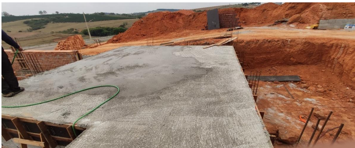
Figura 57 - Concretagem finalizada e início da cura úmida
