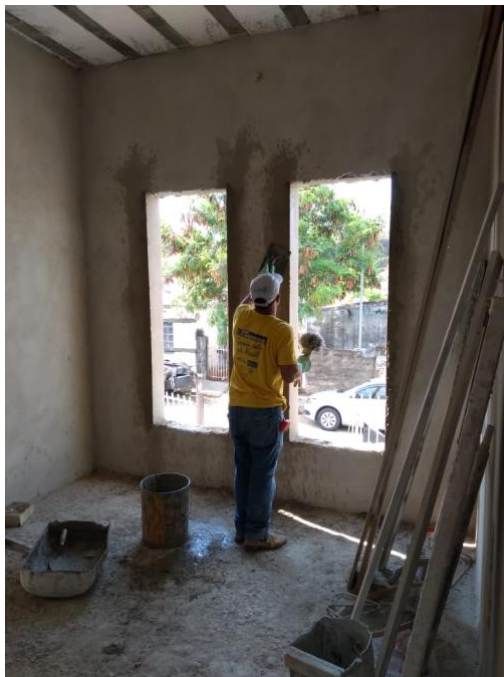
Figura 36 - Paredes rebocadas da sala
