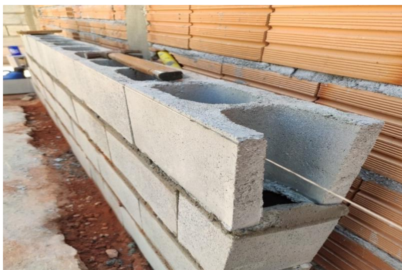
Figura 47 - Utilização da linha de pedreiro
