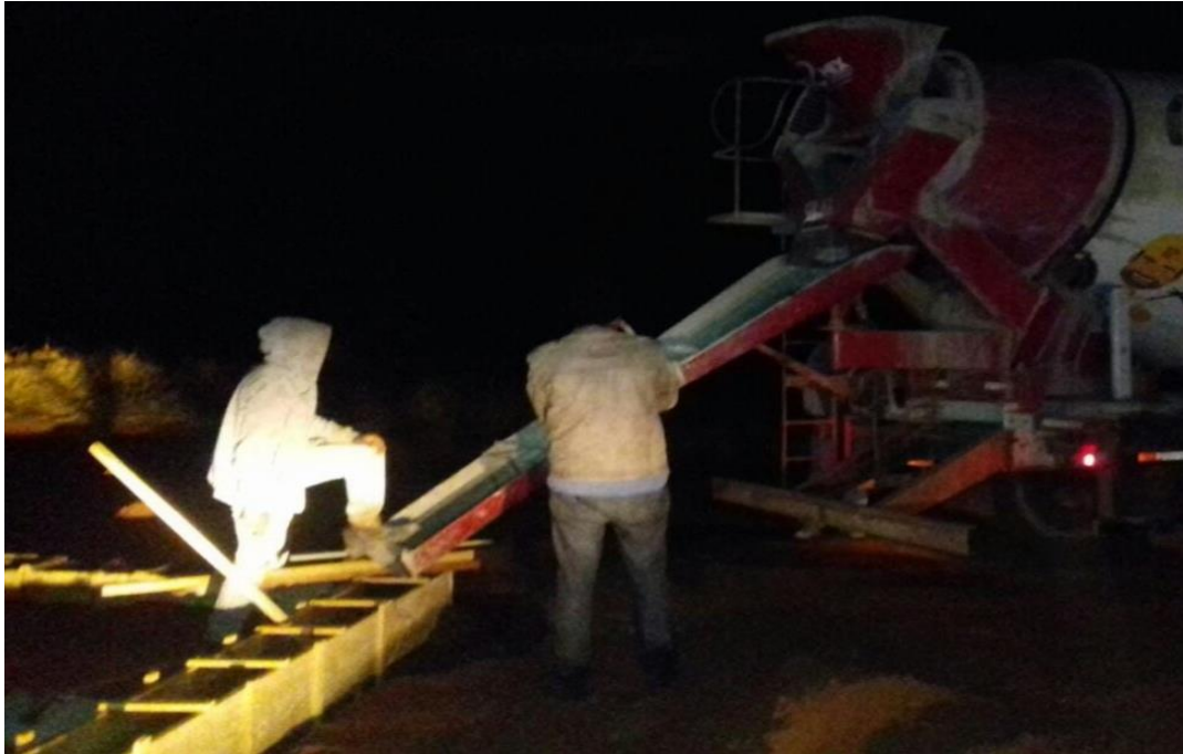
Figura 65 – Concretagem
