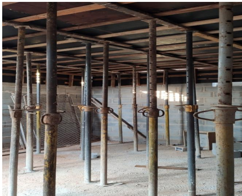
Figura 50 - Escoramento da laje finalizado
