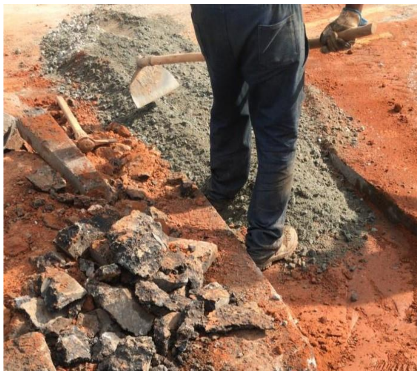
Figura 93 - Adição da camada de pó de brita e compactação
