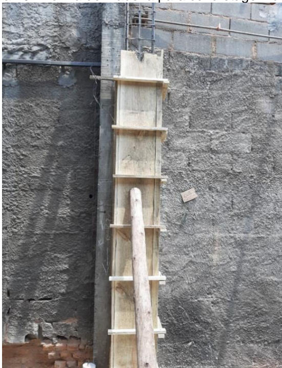
Figura 29 - Forma de madeira para concretagem do pilar
