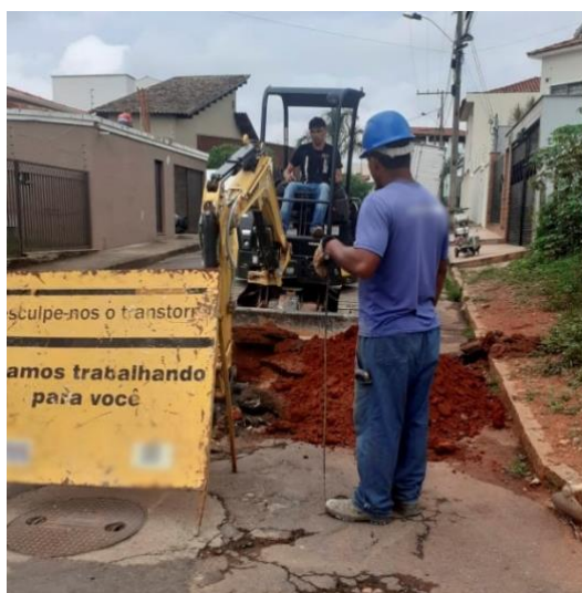
Figura 87 - Escavação do solo
