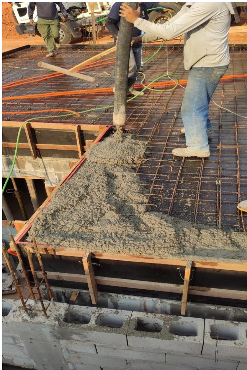
Figura 55 - Lançamento do concreto
