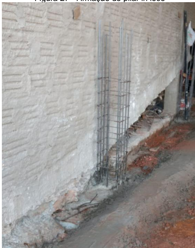
Figura 27 - Armação do pilar in loco
