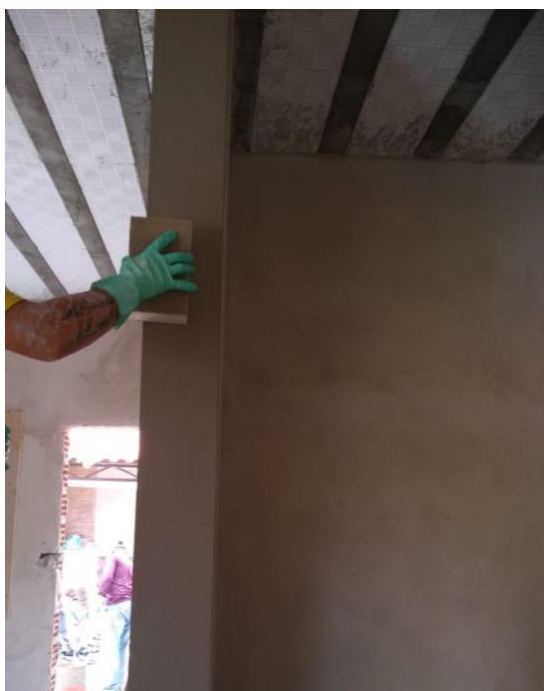
Figura 34 - Reboco Paredes
