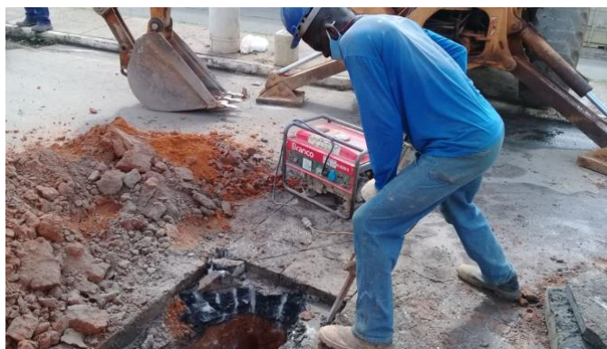
Figura 86 - Remoção da camada asfáltica
