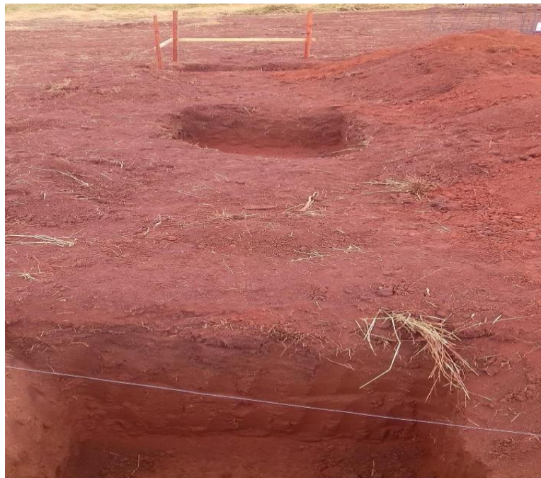
Figura 59 - Escavação das sapatas com retroescavadeira
