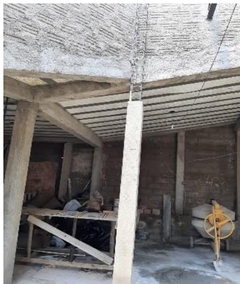
Figura 32 - Pilar concretado
