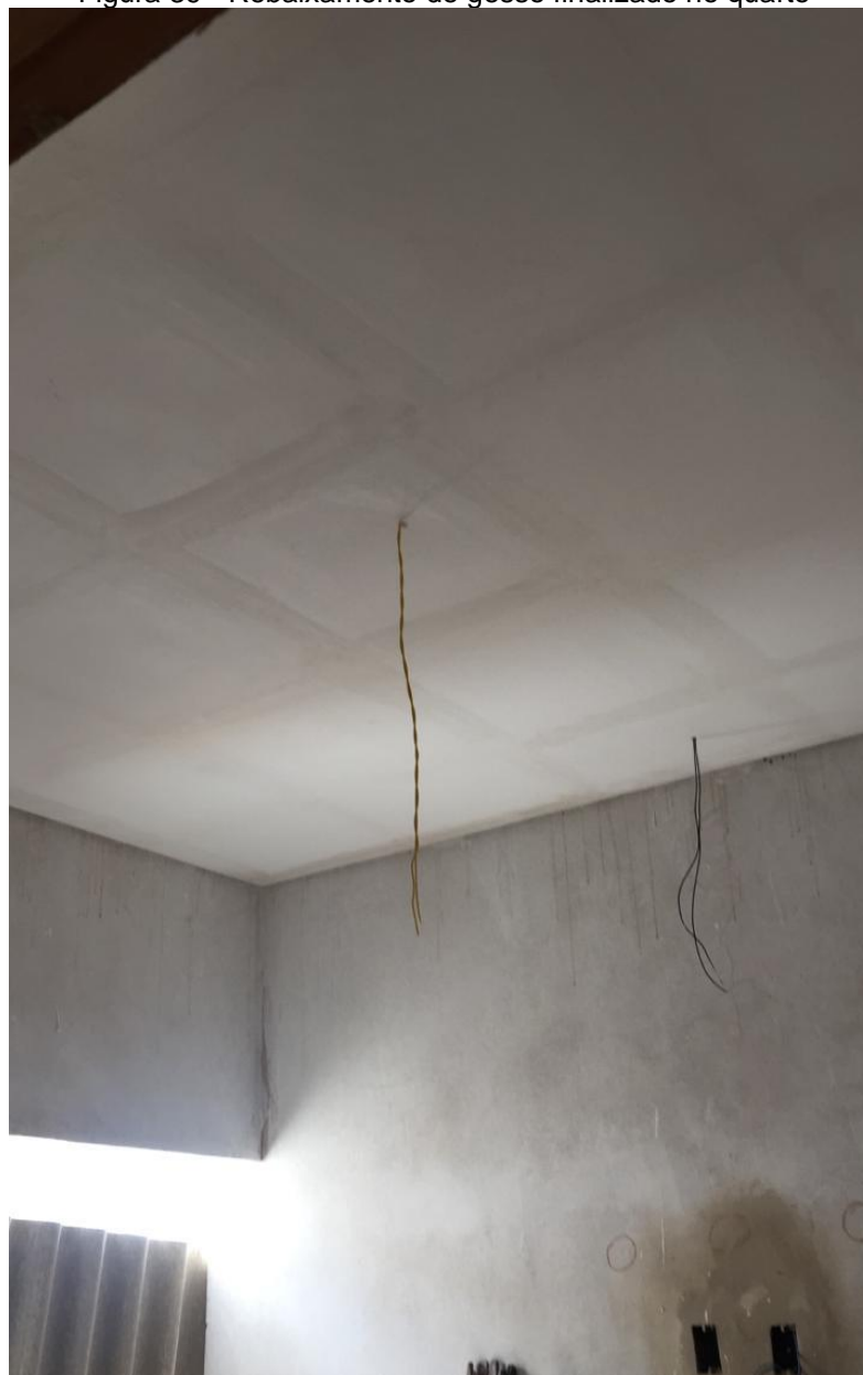
Figura 39 - Rebaixamento de gesso finalizado no quarto
