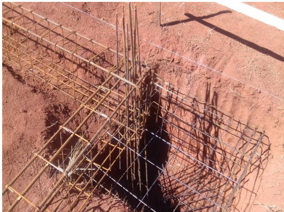
Figura 63 – Armadura na viga baldrame
