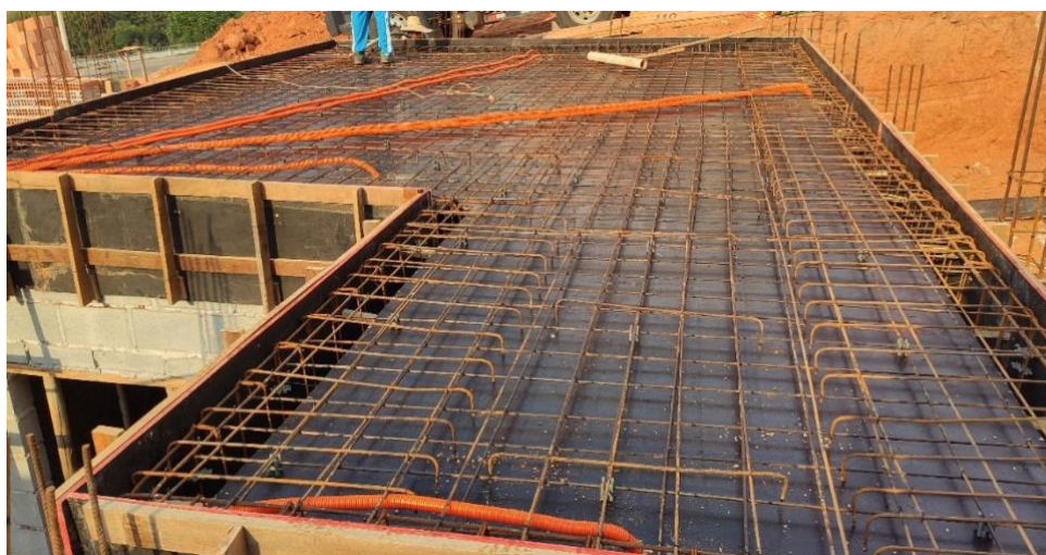
Figura 51 - Arranjo das armaduras
