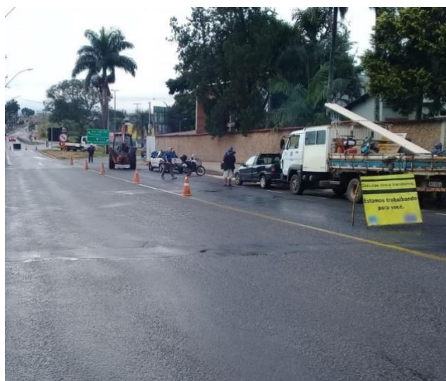
Figura 80 - Sinalização no sentido oposto da via
