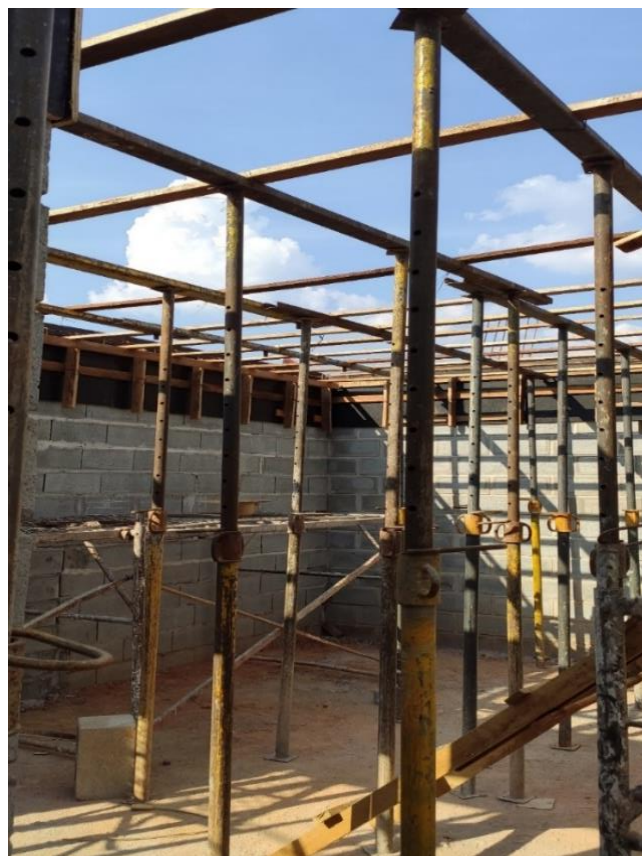
Figura 49 - Escoramento da laje
