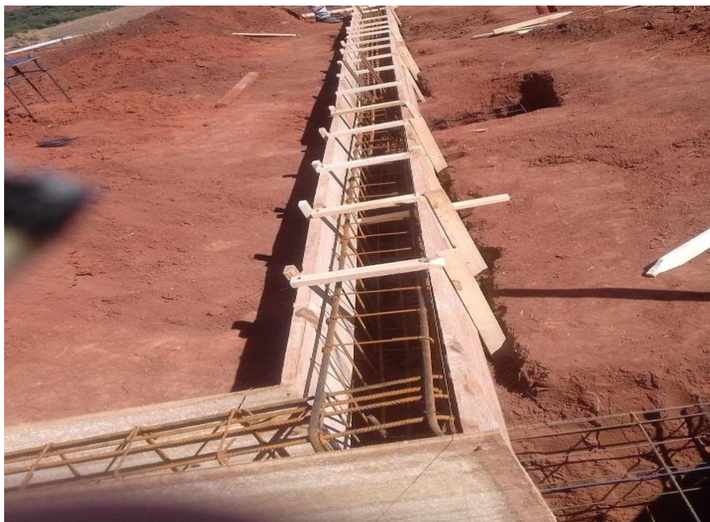
Figura 64 – Colocação das formas
