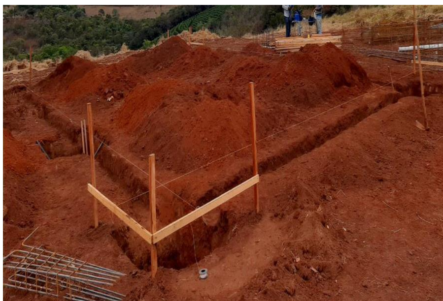
Figura 61 - Escavação do baldrame
