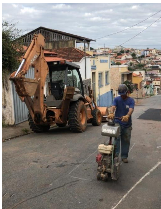
Figura 84 - Demarcação do local de abertura da vala
