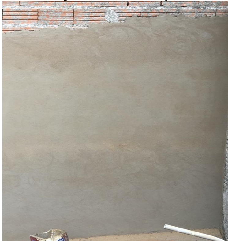
Figura 27 - Reboco em execução
