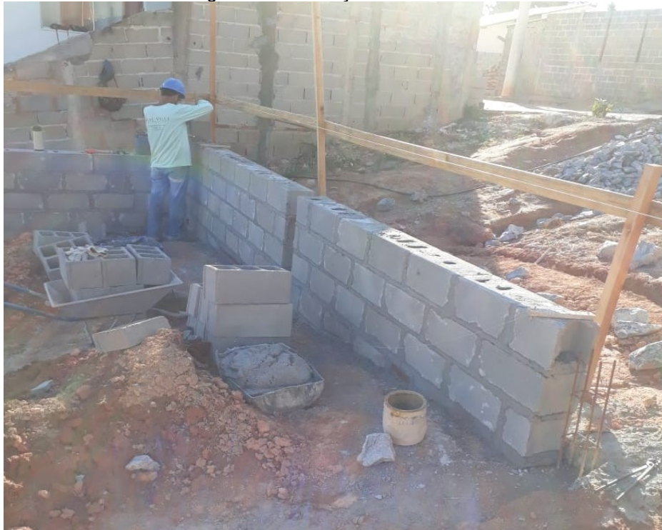
Figura 25 - Execução da alvenaria
