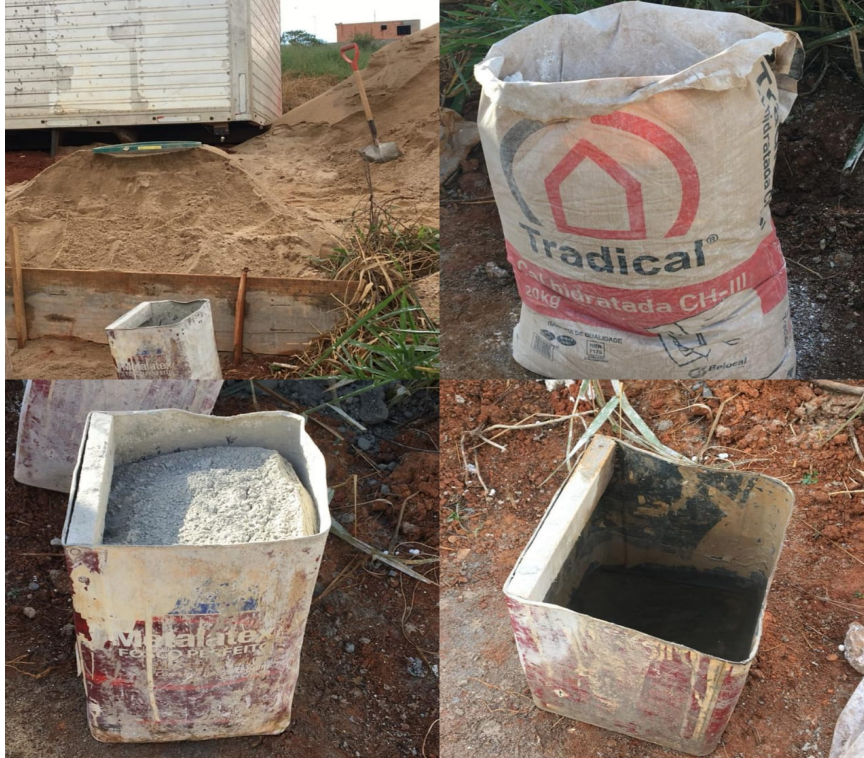
Figura 28 - Materiais utilizados para a argamassa de reboco e emboço
