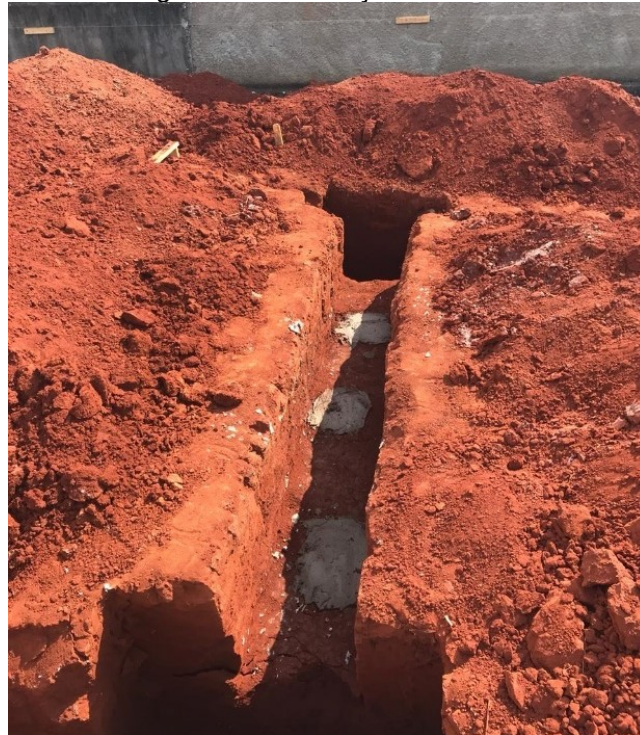
Figura 74 - Escavação das valas
