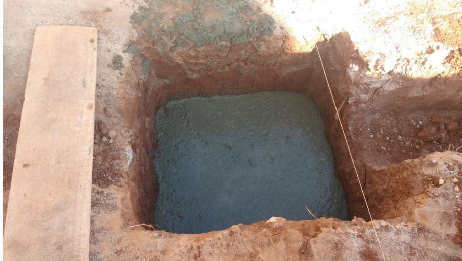
Figura 80 - Camada de concreto magro
