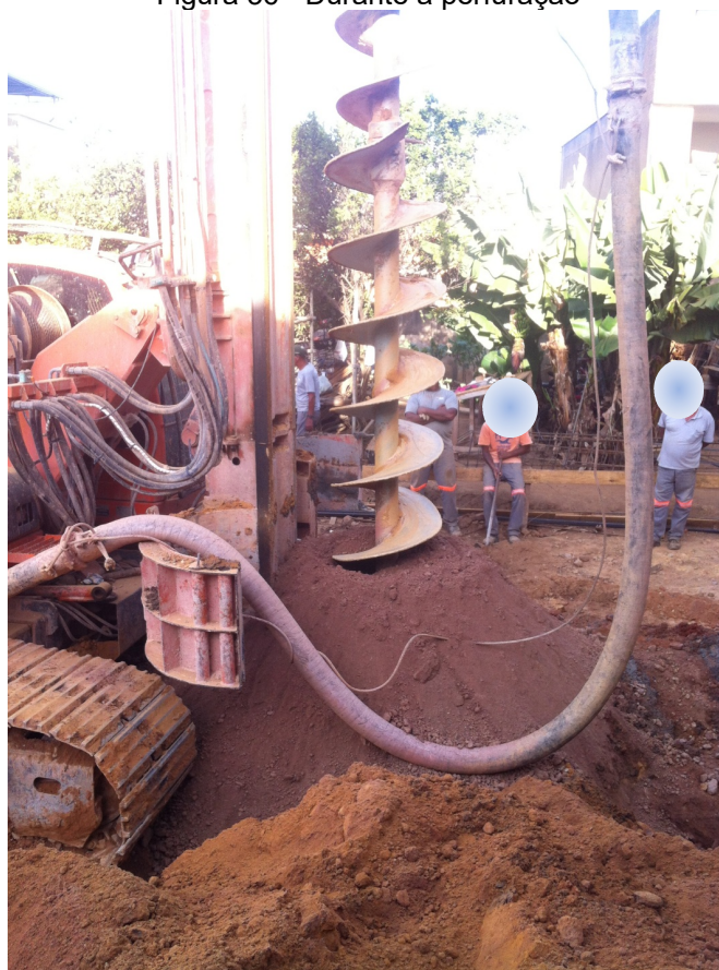
Figura 36 - Durante a perfuração
