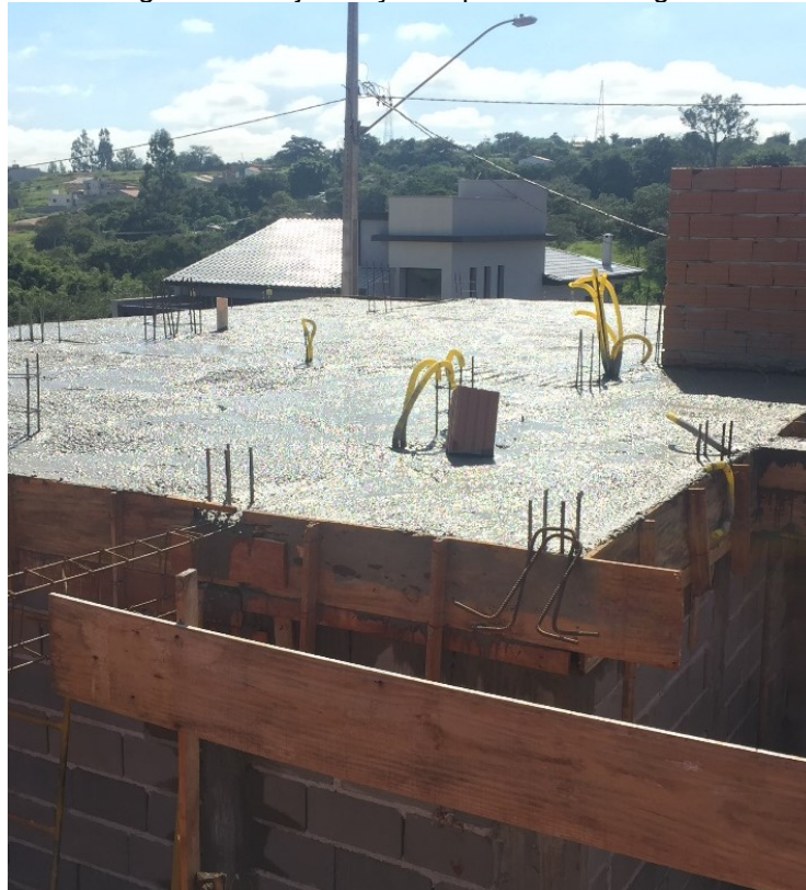
Figura 14 - Laje treliçada após a concretagem
