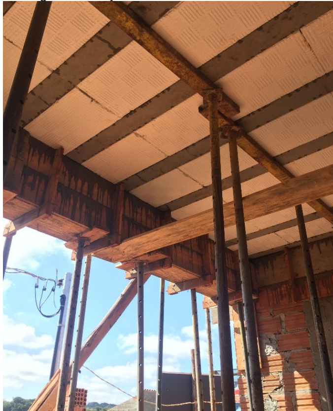
Figura 13 - Laje com os escoramentos metálicos
