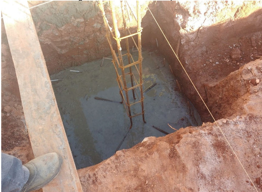
Figura 82 - Armaduras dos pilares
