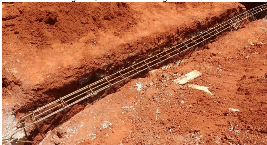
Figura 75 - Armações da viga baldrame
