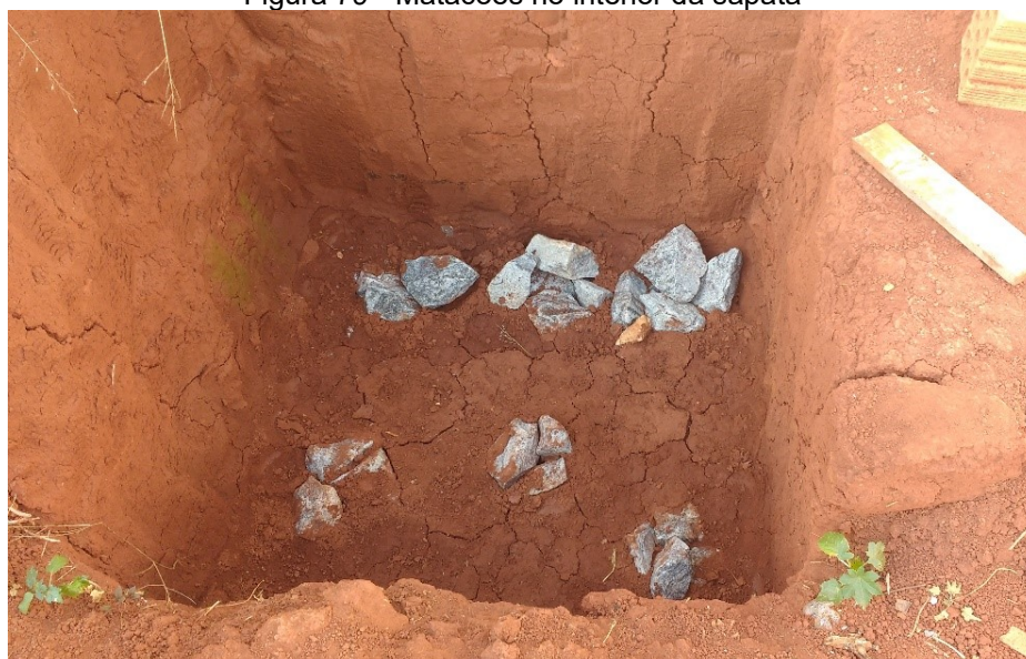
Figura 79 - Matacões no interior da sapata
