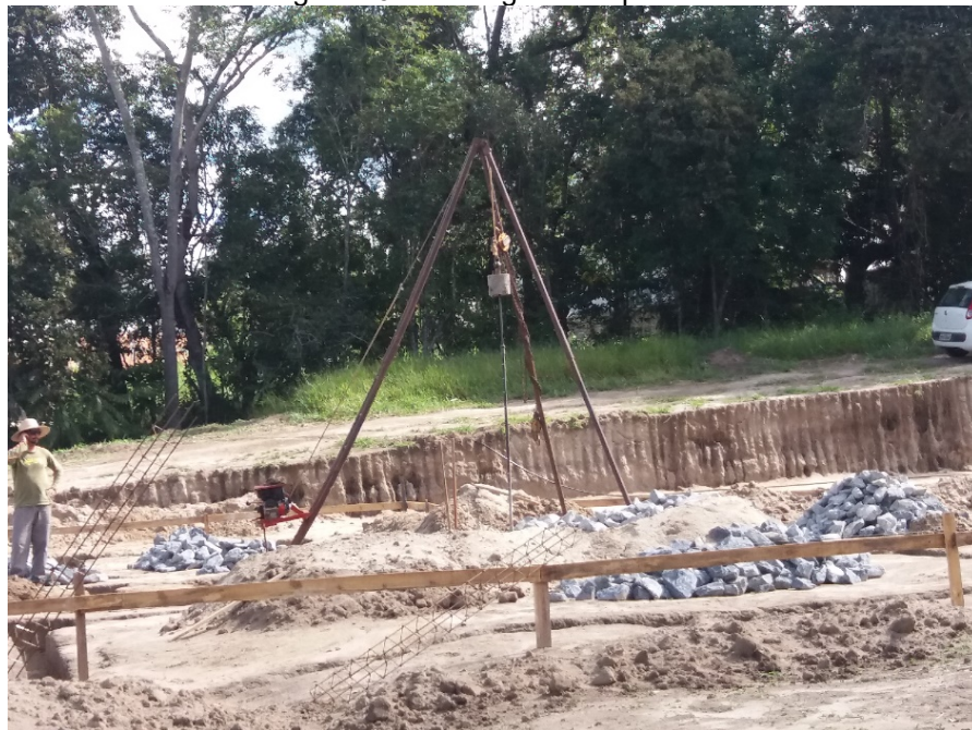
Figura 16 - Sondagem do tipo SPT
