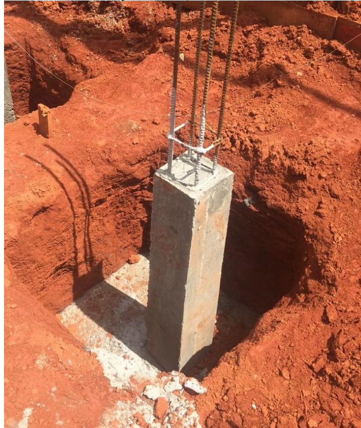
Figura 4 - Sapata isolada
