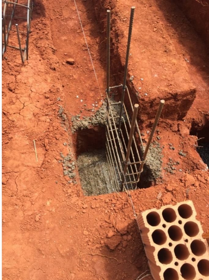
Figura 7 - Valas e a sapata com as esperas dos pilares
