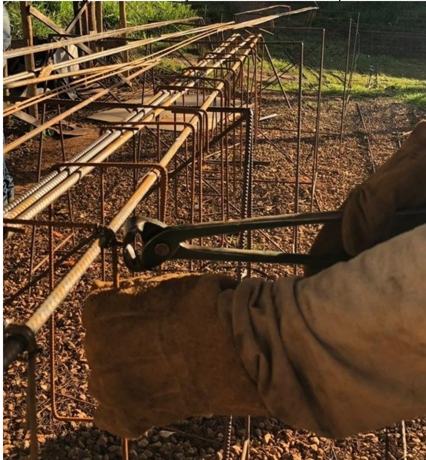
Figura 58 - Amarração com a ferramenta torquês
