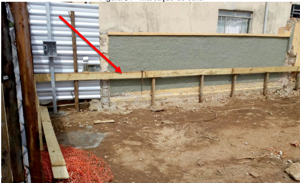
Figura 34 - Marcação de obra
