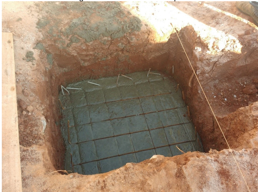
Figura 81 - Armaduras da sapata
