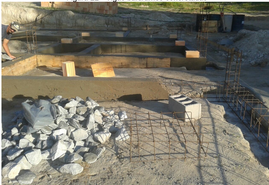
Figura 22 - Vigas baldrames concretadas
