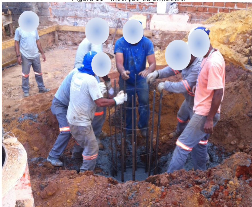
Figura 39 - Inserção da armadura
