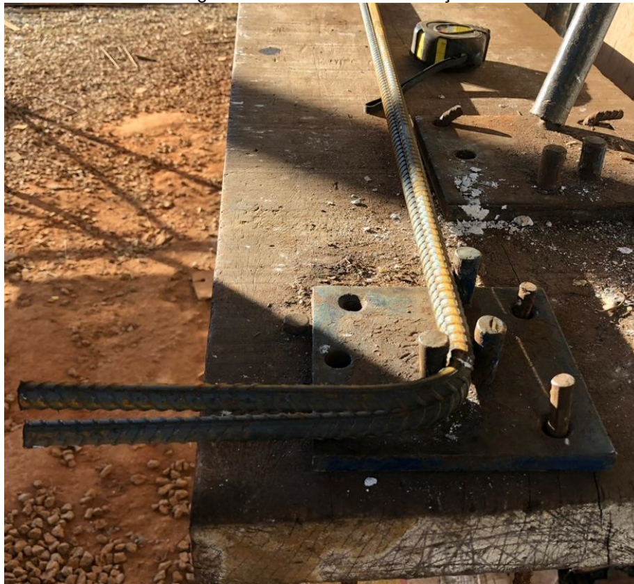
Figura 55 - Dobra da barra de aço
