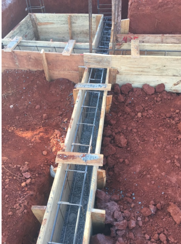
Figura 9 - Fôrmas com a camada de brita e as armaduras
