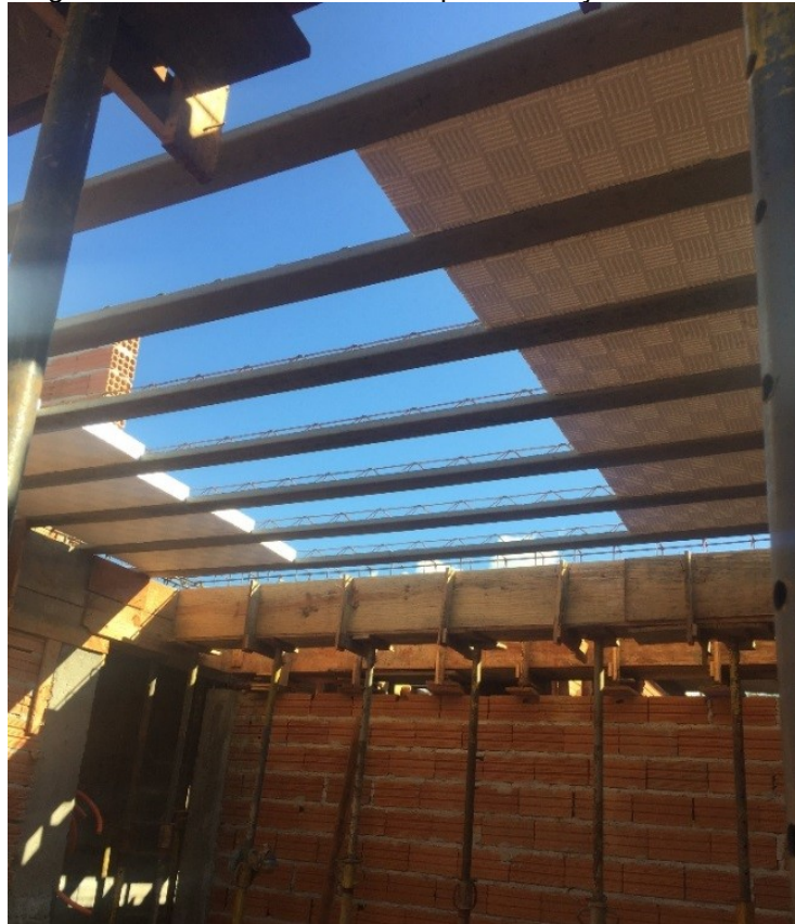
Figura 12 - Posicionamento das placas treliçadas e do EPS
