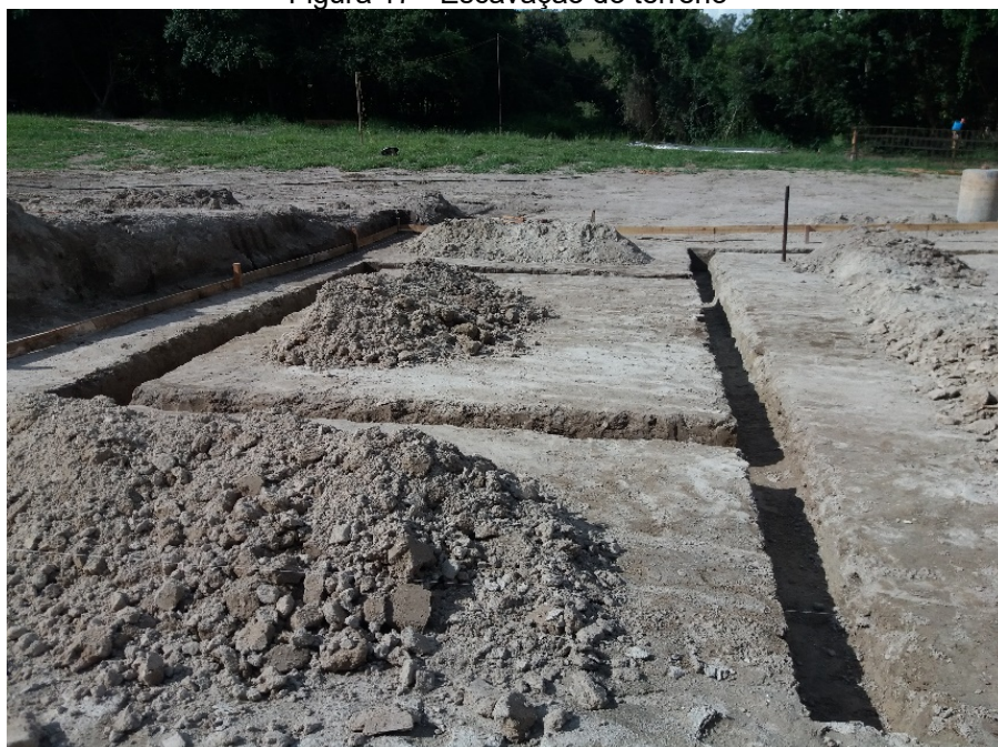
Figura 17 - Escavação do terreno
