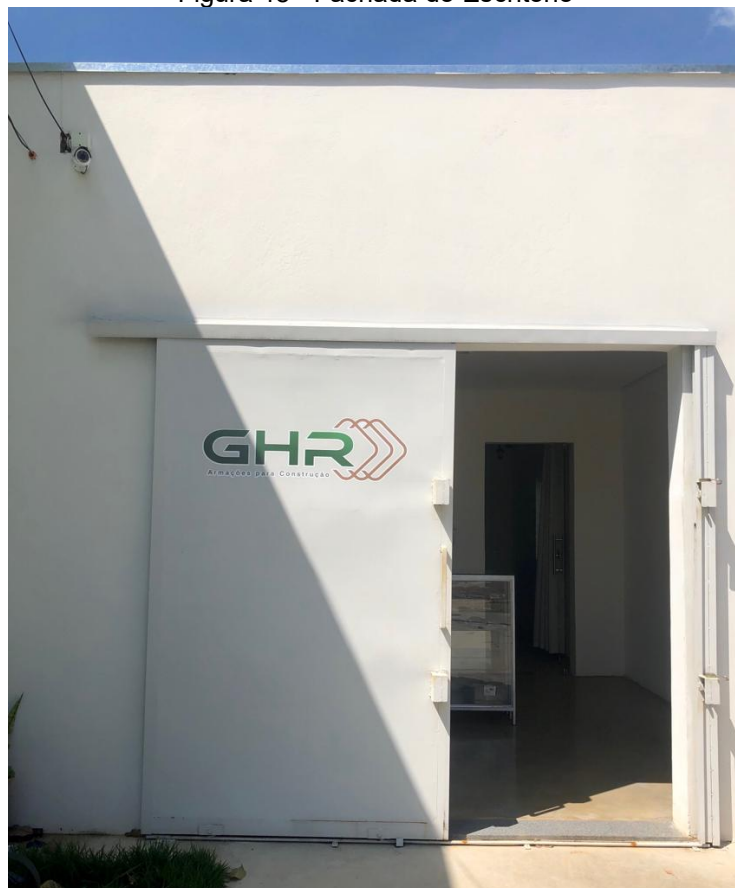
Figura 48 - Fachada do Escritório
