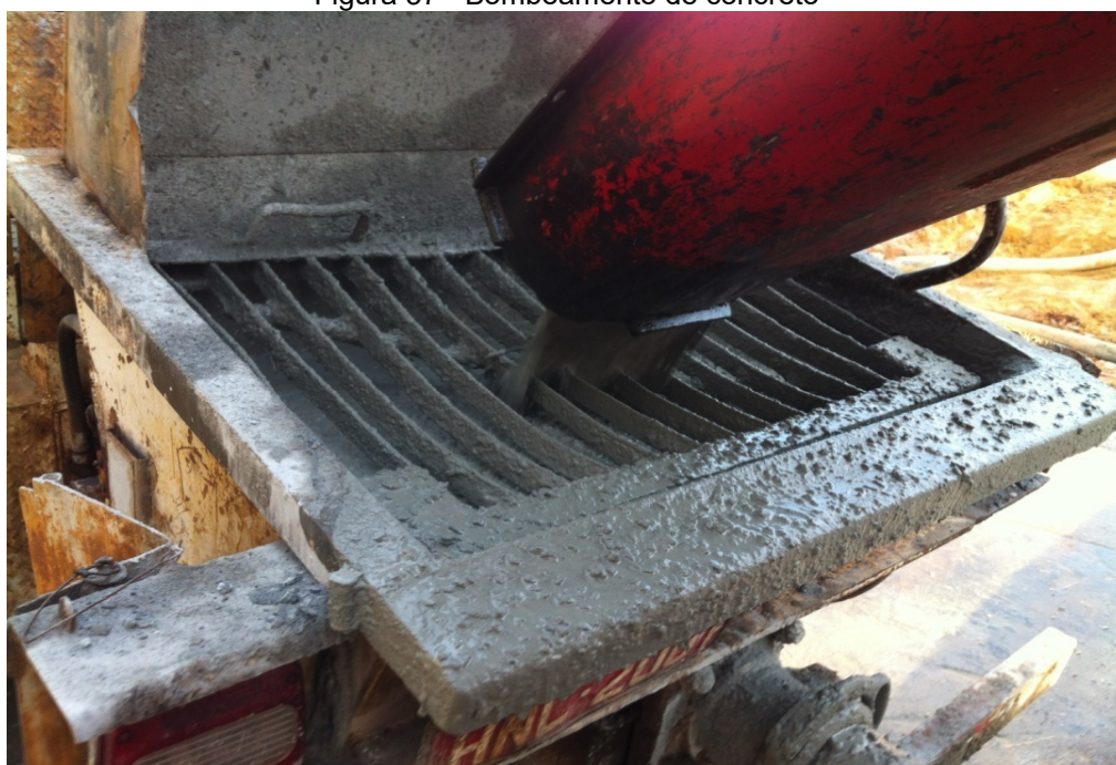
Figura 37 - Bombeamento de concreto
