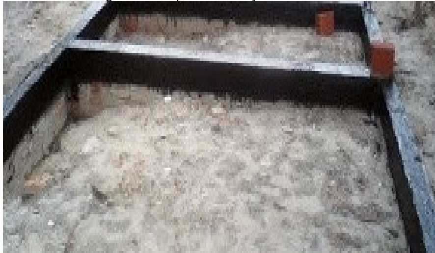
Figura 23 - Impermeabilização do baldrame
