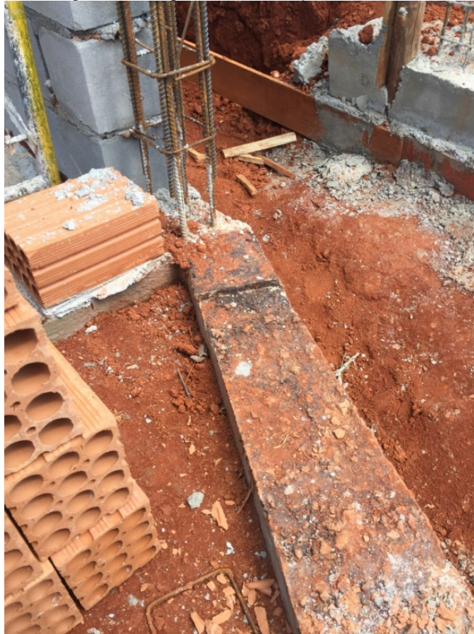
Figura 11 - Viga Baldrame impermeabilizada
