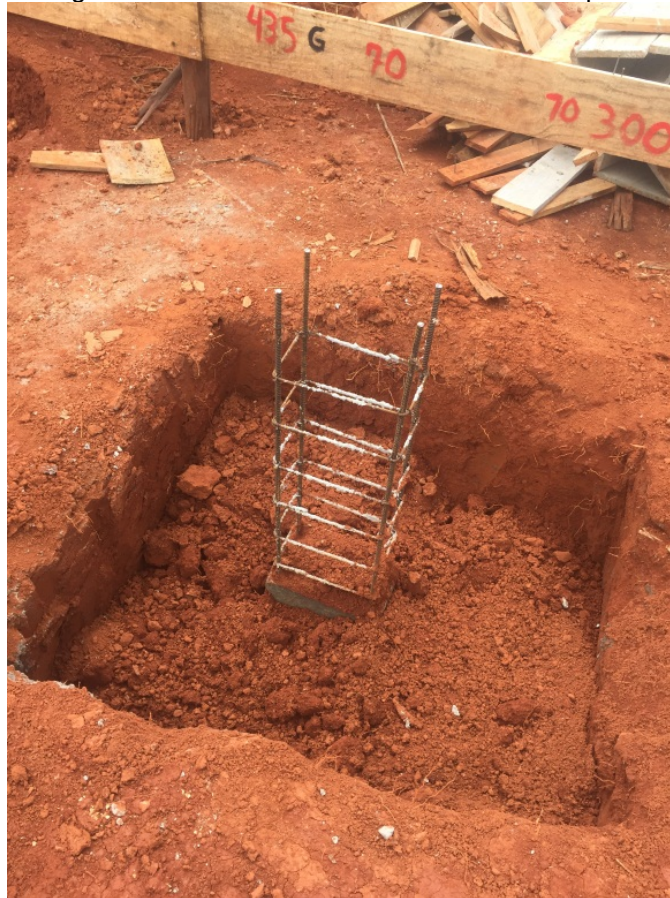
Figura 5 - Processo de reaterro da vala da sapata
