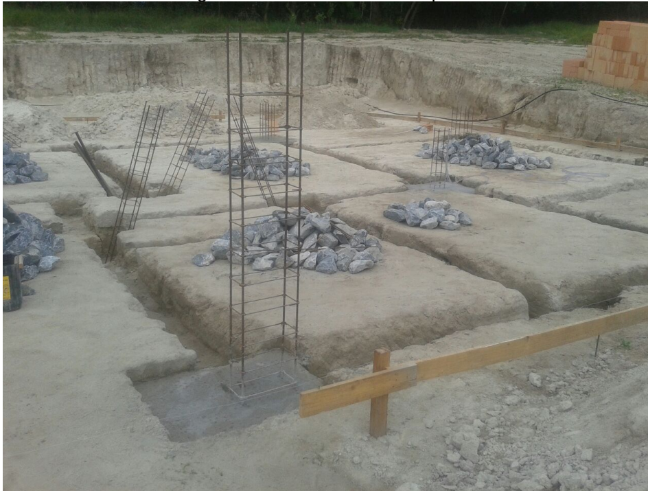
Figura 20 - Enchimento das sapatas
