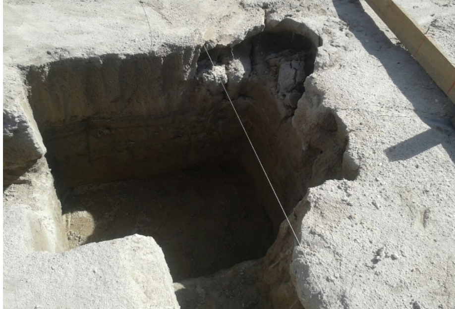
Figura 18 - Escavação para construção de sapata
