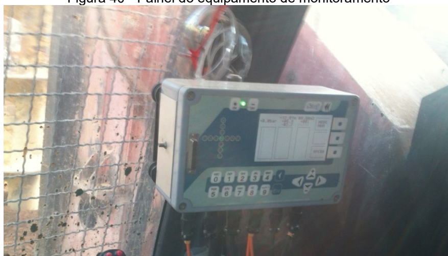
Figura 40 - Painel do equipamento de monitoramento
