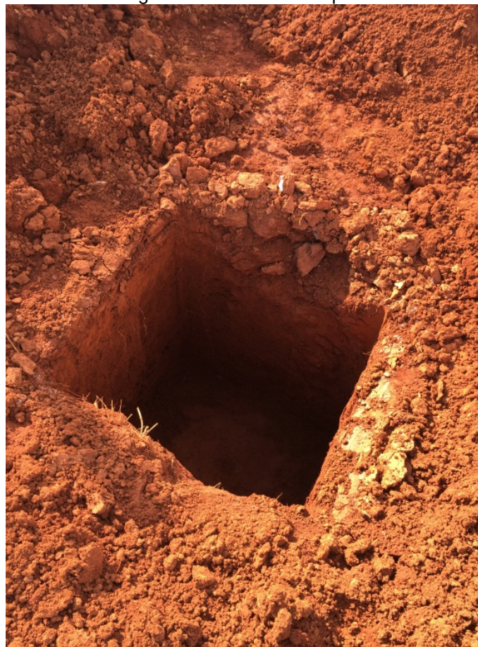
Figura 2 - Abertura da sapata
