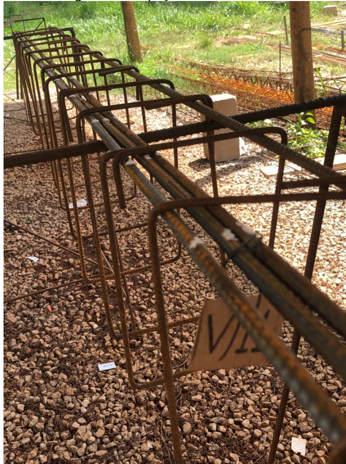
Figura 57 - Espaçamento dos estribos
