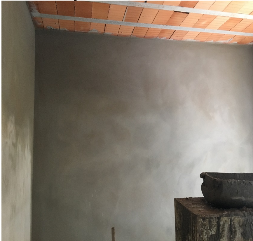
Figura 29 - Revestimento concluído
