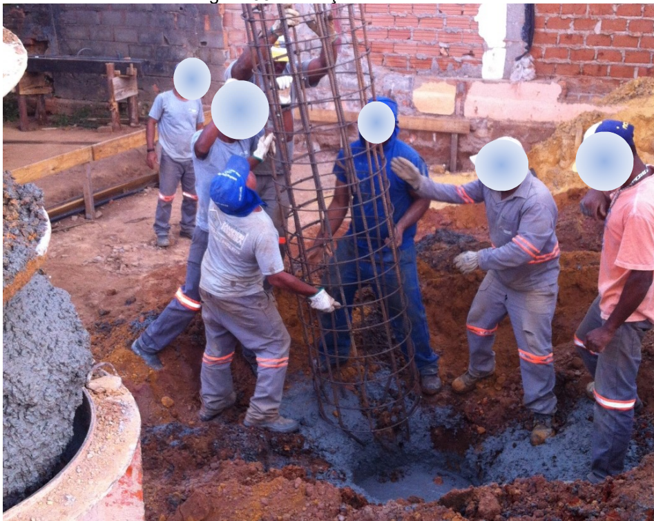
Figura 38 - Inserção da armadura
