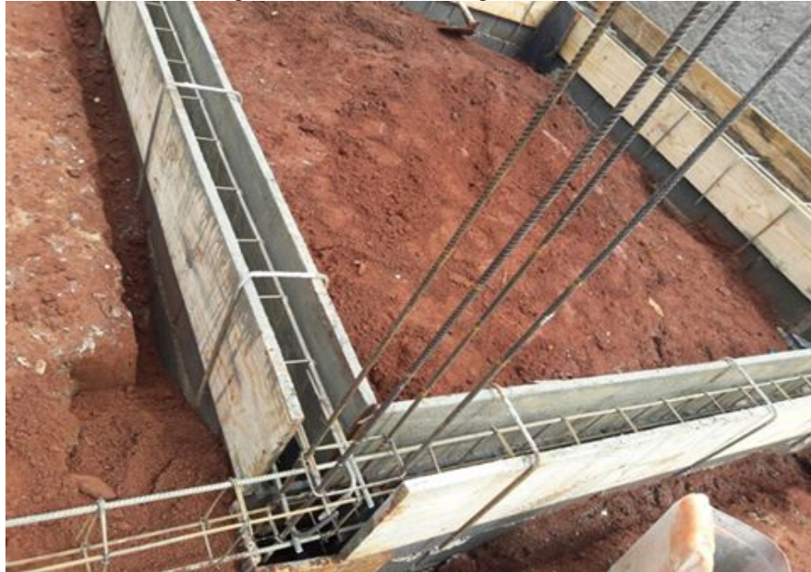
Figura 76 - Fôrmas da viga baldrame
