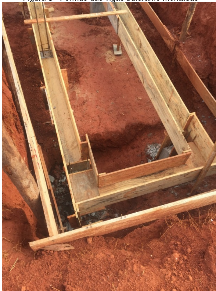
Figura 8 - Fôrmas das vigas baldrame montadas
