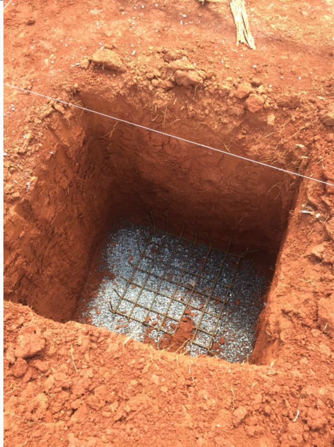
Figura 3 - Sapata com a camada de pedra brita e sua armadura
