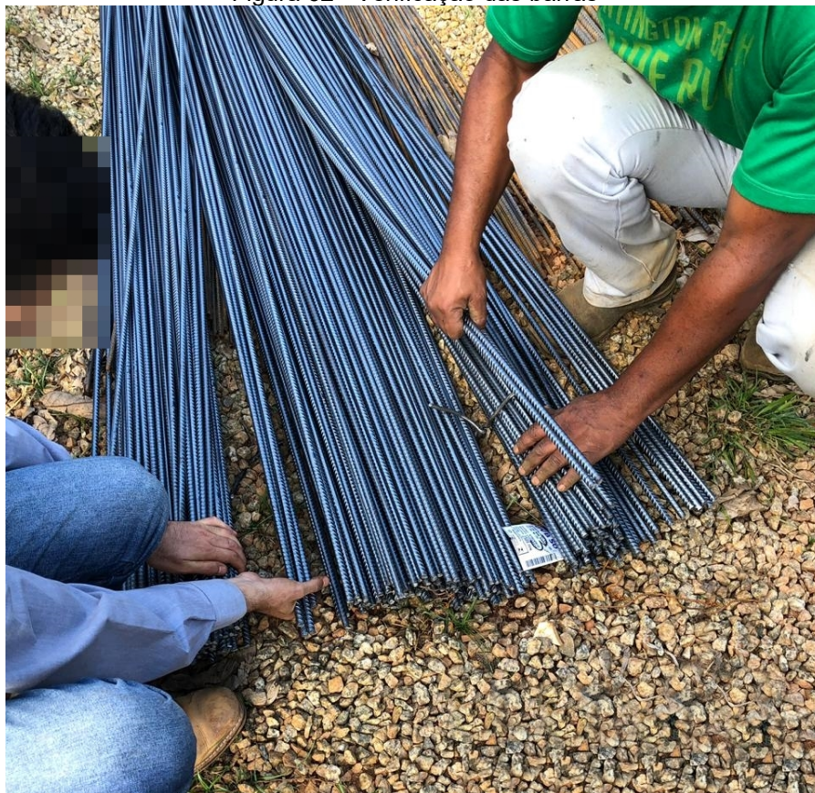
Figura 62 - Verificação das barras
