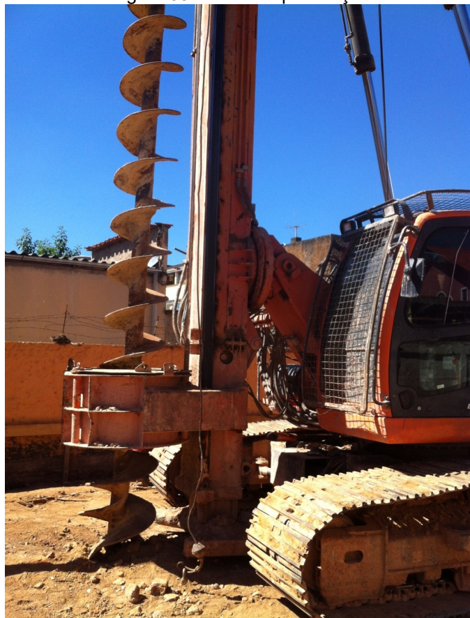
Figura 35 - Início da perfuração
