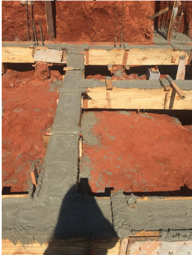
Figura 10 - Vigas concretadas
