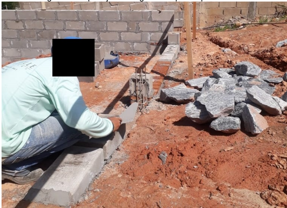
Figura 24 - Aplicação da argamassa para a primeira fiada
