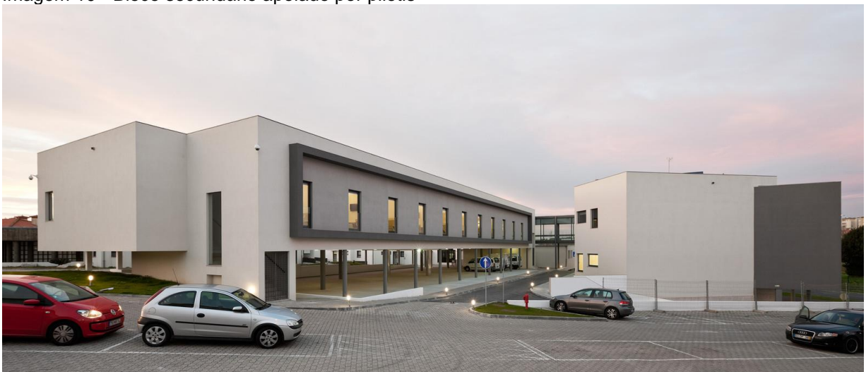
Imagem 10 - Bloco secundário apoiado por pilotis
