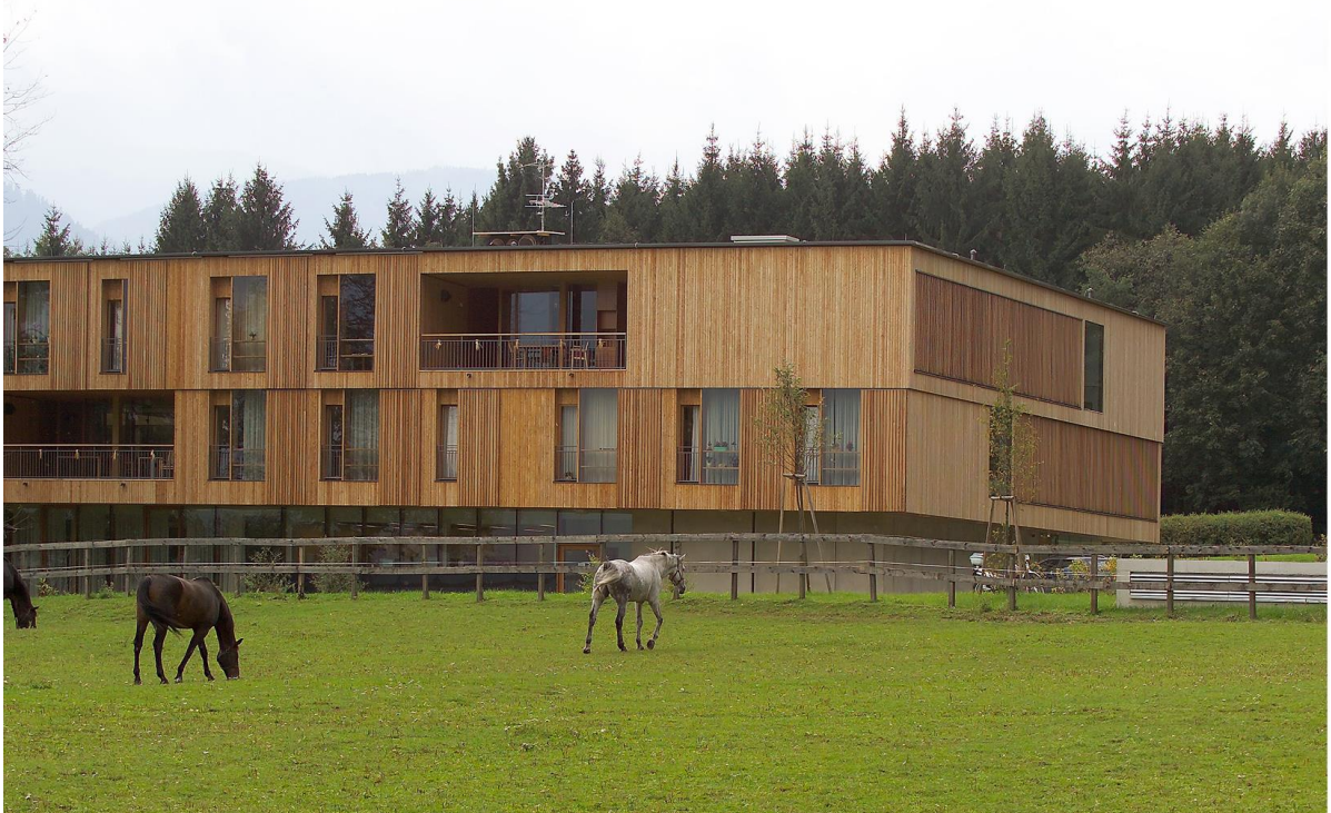
Imagem 14 - Área externa da edificação
