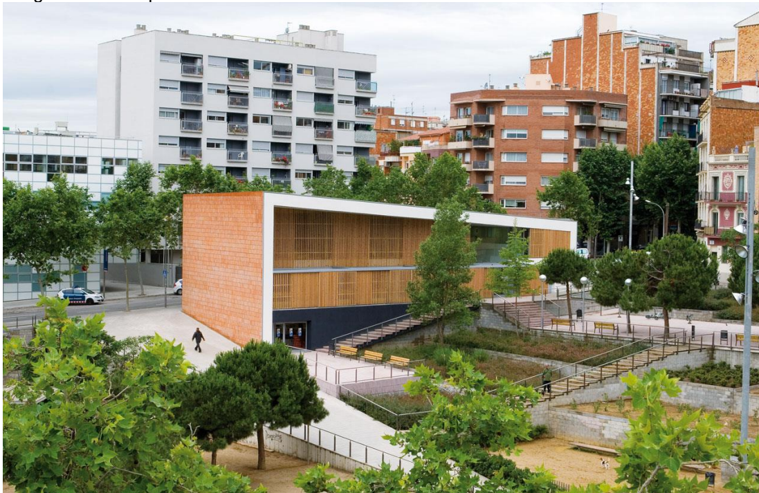
Imagem 1 - Casa para terceira idade - Barcelona
