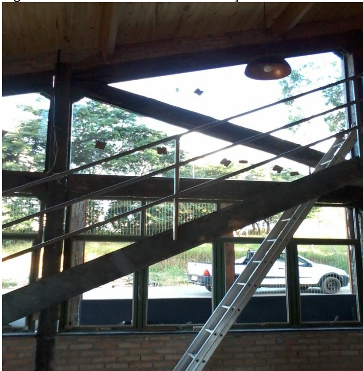
Figura 37 – Vista interna da edificação mostrando a combinação de materiais usados
