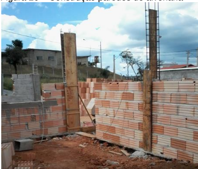
Figura 26 – Construção paredes de alvenaria
