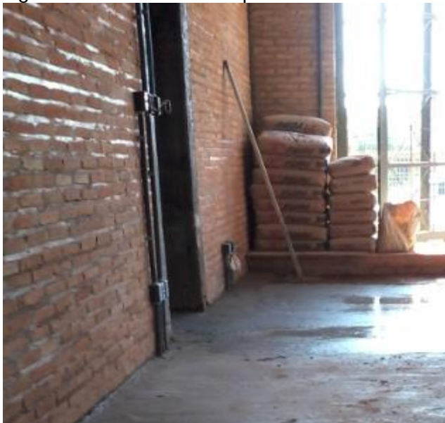
Figura 38 – Eletrodutos expostos
