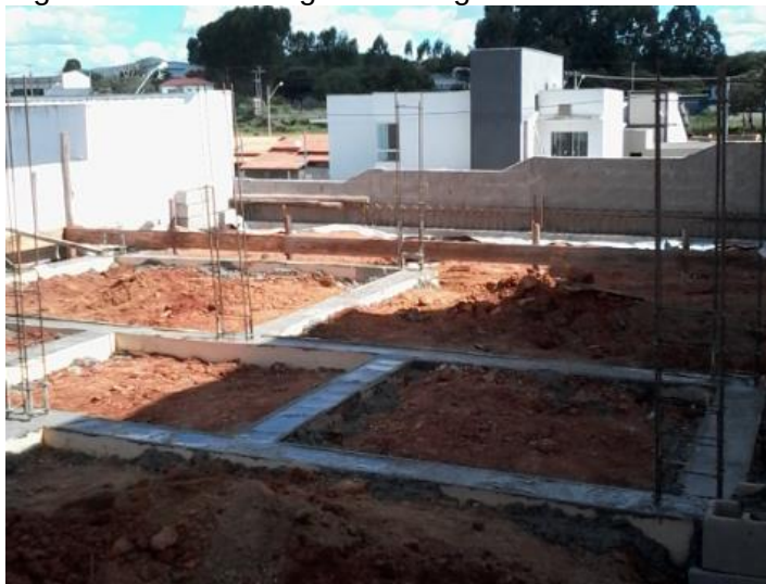
Figura 25 - Concretagem das vigas baldrame
