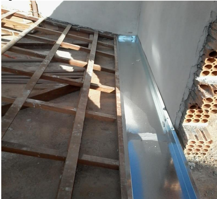
Figura 32 – Estruturas de madeira do telhado
