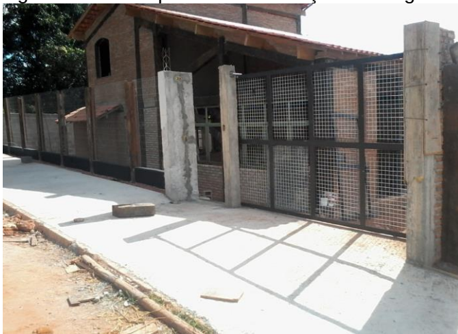
Figura 39 – Vista parcial da edificação com vigas e pilares de madeira
