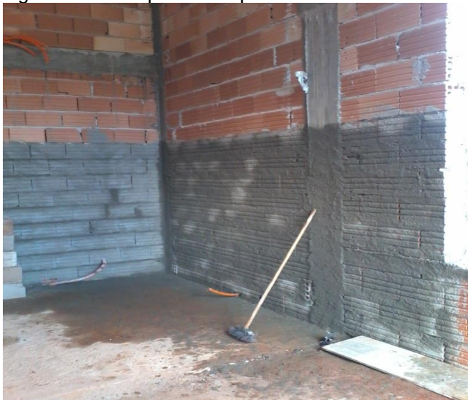
Figura 29 – Chapisco das paredes
