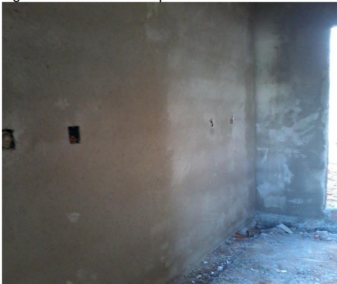
Figura 30 – Reboco das paredes
