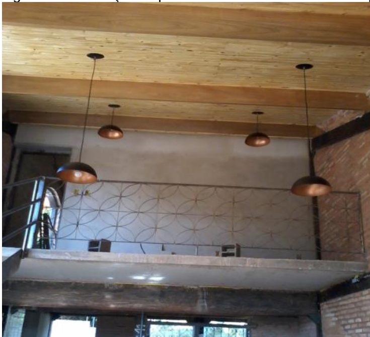
Figura 35 – Serviço de qualidade no acabamento de carpintaria
