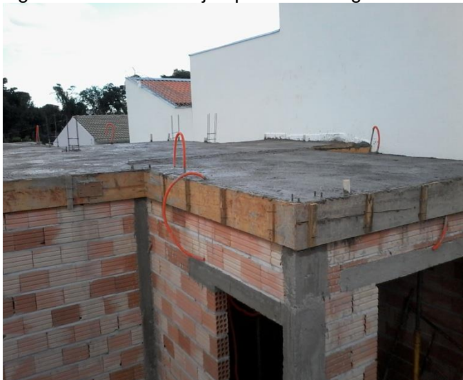
Figura 28 – Cura da laje após concretagem
