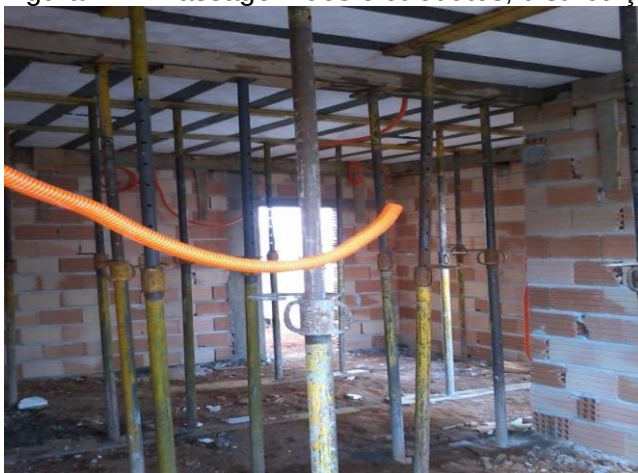
Figura 27 – Passagem dos eletrodutos, distribuição da laje e escoramento
