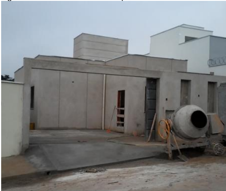
Figura 33 – Fase final da edificação
