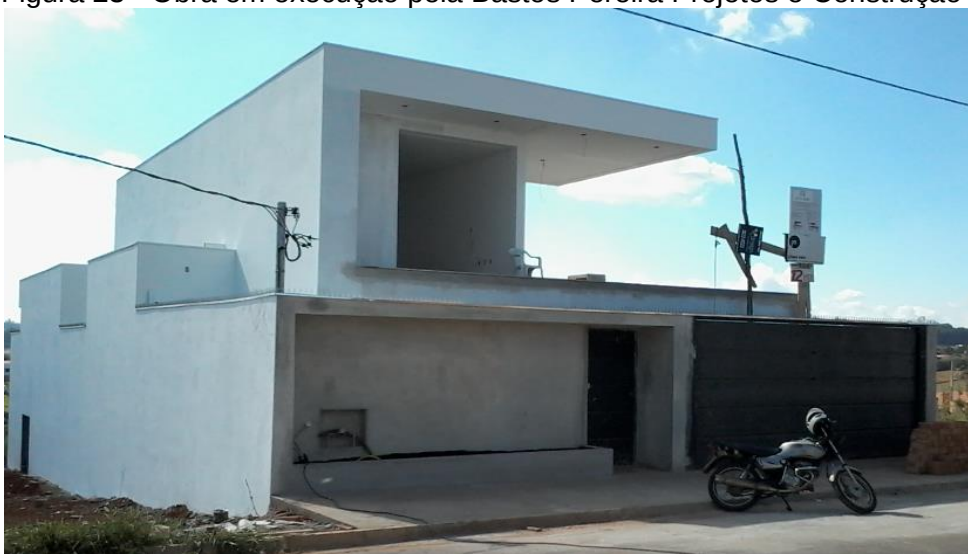
Figura 23 - Obra em execução pela Bastos Pereira Projetos e Construção
