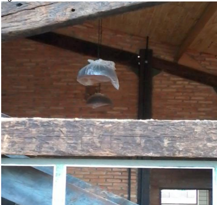
Figura 36 – Madeira reciclada utilizada na estrutura da edificação
