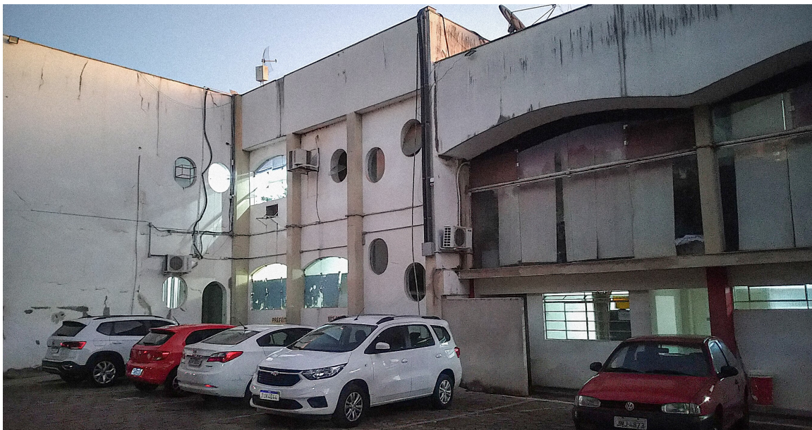
Imagem 27 – Estacionamento e caminho para acesso ao pavimento inferior.
