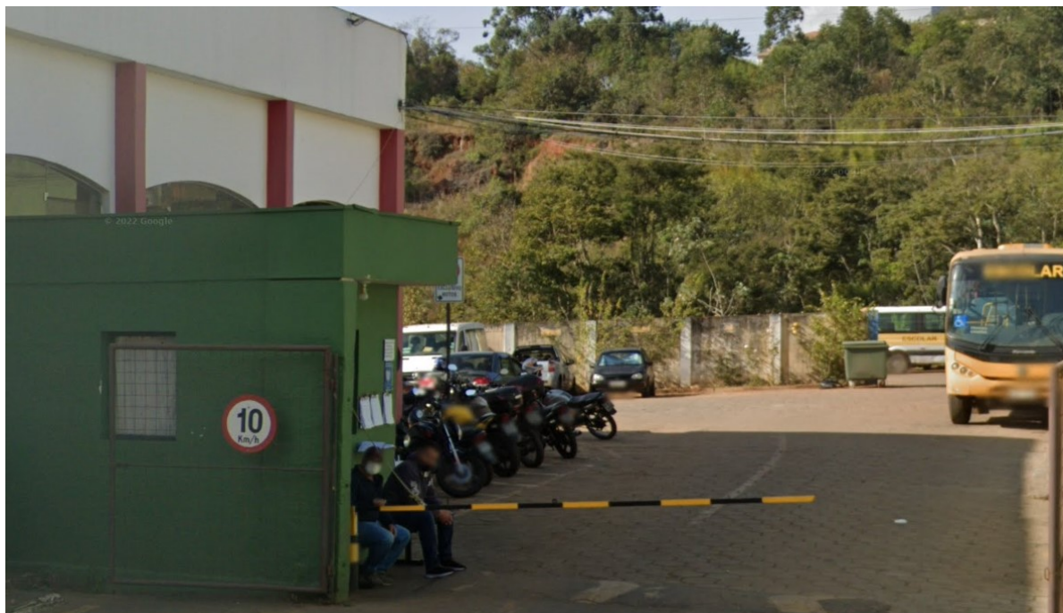
Imagem 32 – Guarita para controle de acesso ao pátio da PML.
