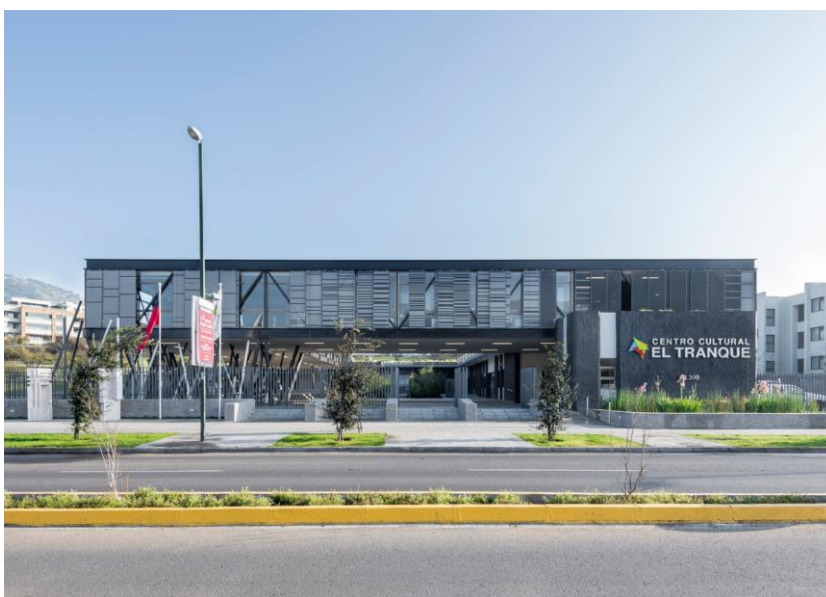
Imagem 07: Fachada do Centro Cultural El Tranque
