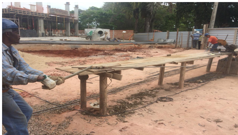
Figura 119 – Bancada de armação e corte das barras
