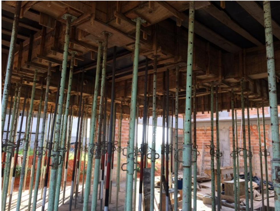
Figura 22 – Escoras sustentando lajes e vigas
