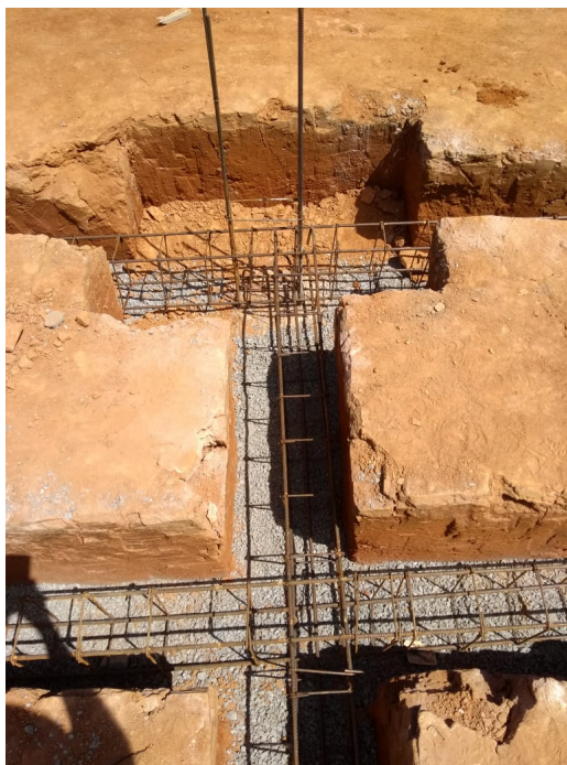
Figura 12 – Armaduras dos pilares e das vigas baldrames
