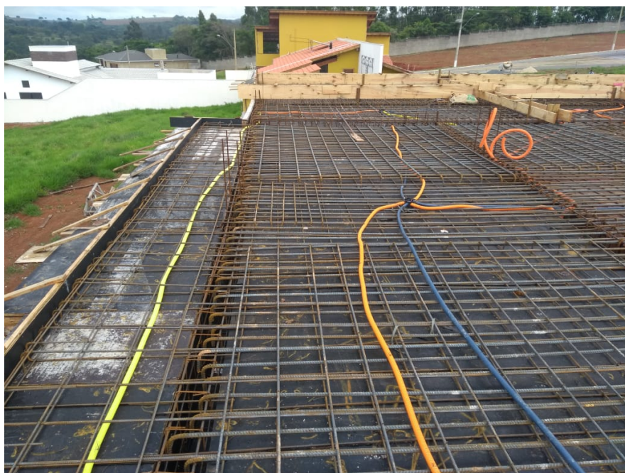
Figura 14 – Armaduras positivas e negativas
