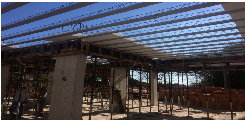
Figura 97 – Montagem da laje
