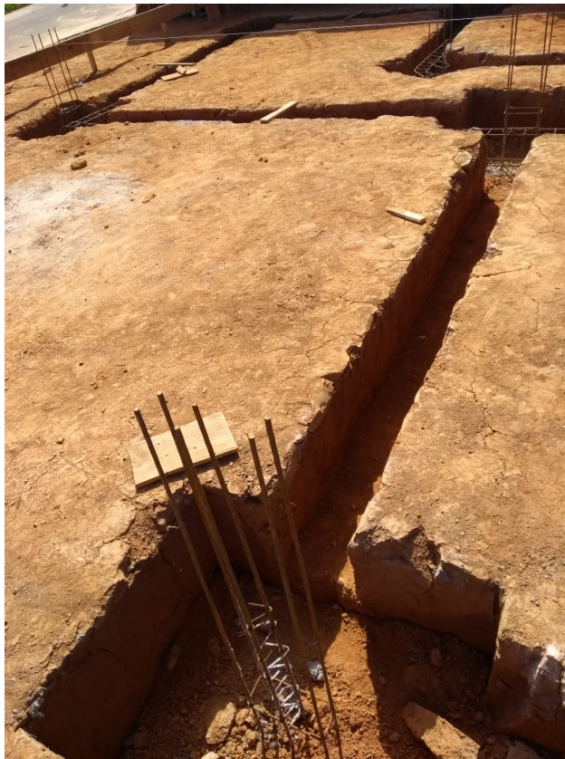
Figura 10 – Vala para a viga baldrame
