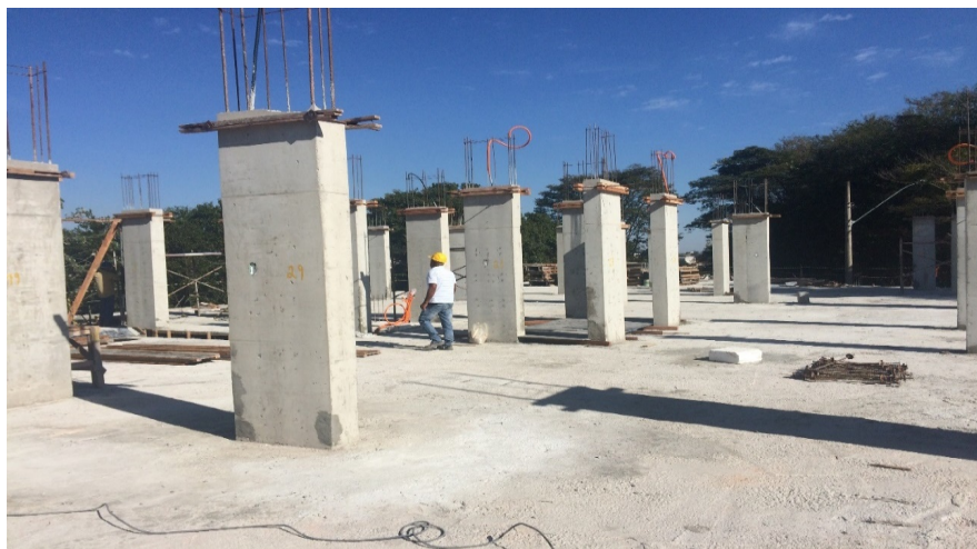
Figura 94 – Pilares após concretagem
