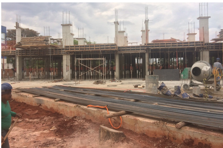
Figura 118 – Execução do 1º Pavimento
