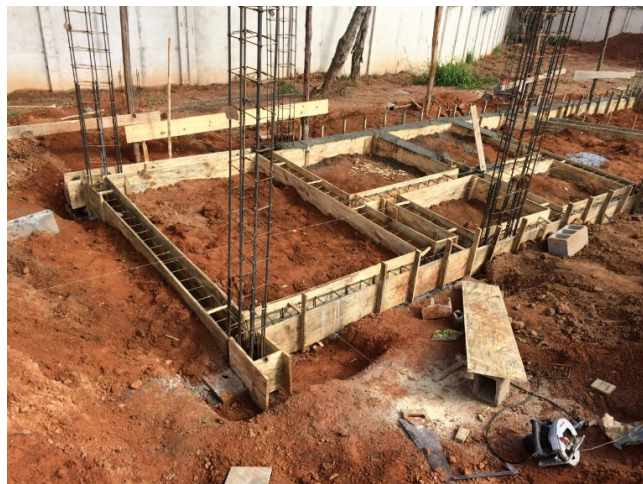
Figura 30 – Concretagem das vigas baldrames
