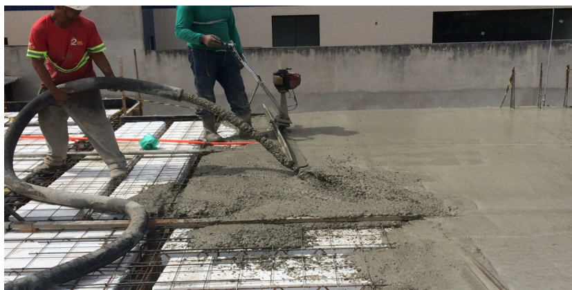
Figura 106 – Concretagem e nivelamento
