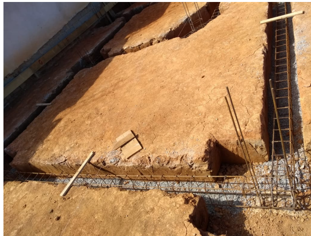
Figura 11 – Colocação da armadura na viga baldrame
