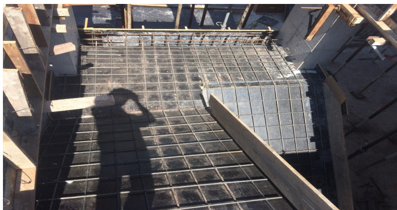
Figura 102 – Montagem da escada
