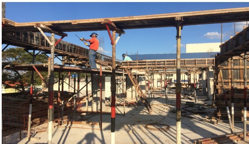
Figura 114 – Montagem das vigas e fundos
