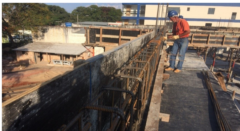
Figura 115 – Espaçamento e medição dos estribos
