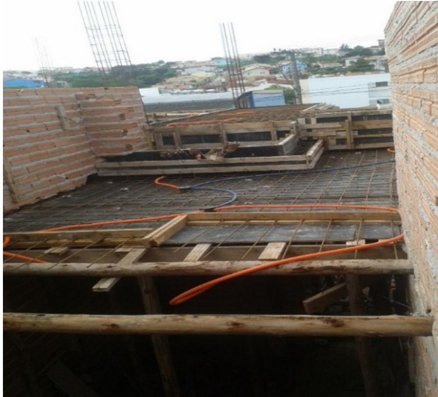
Figura 21 – Fôrmas de madeira e sistema elétrico antes da concretagem
