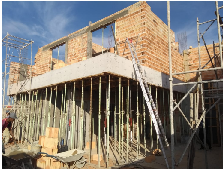
Figura 16 – Escoras da garagem e alvenaria do pavimento superior
