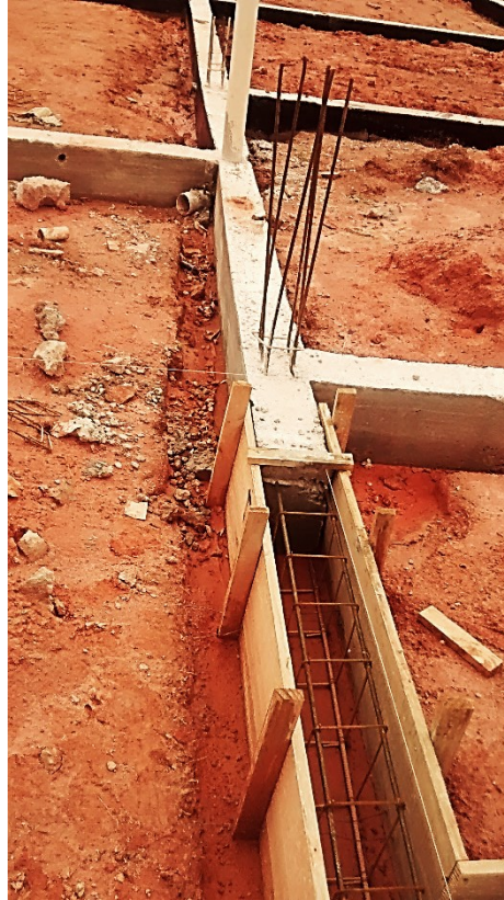
Figura 13 – Desforma das vigas baldrames
