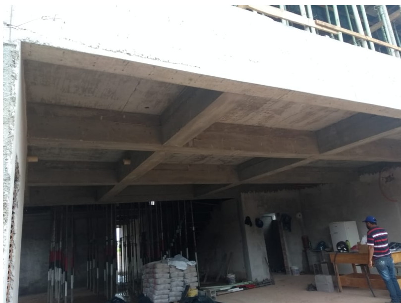
Figura 17 – Laje após a retirada das escoras e das fôrmas
