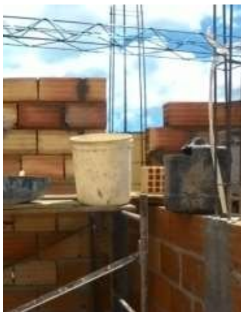
Figura 25 – Amarração de alvenaria
