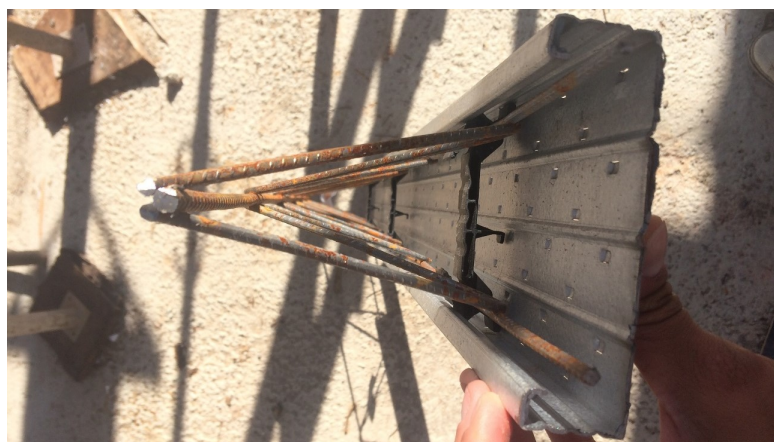
Figura 100 – Visão frontal da vigota
