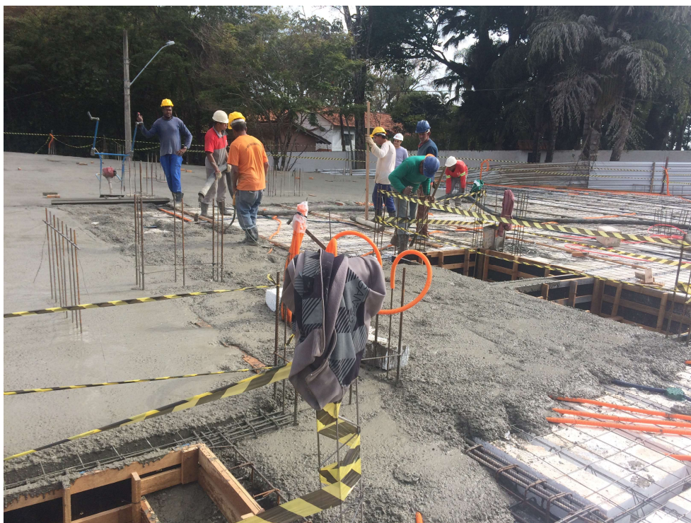
Figura 90 – Concretagem da primeira laje
