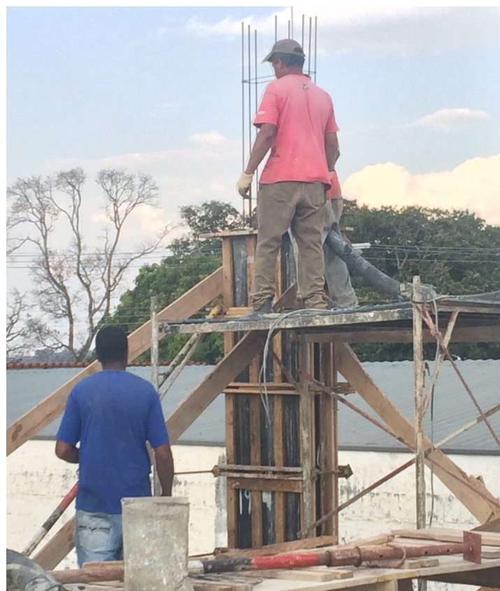
Figura 112 – Concretagem do pilar
