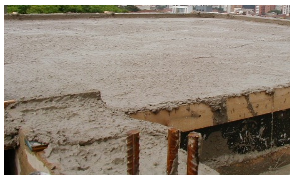
Figura 24 – Fôrmas de laje maciça no momento em que recebeu concreto
