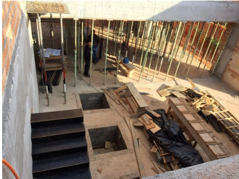
Figura 23 – Escoras e fôrma de escada
