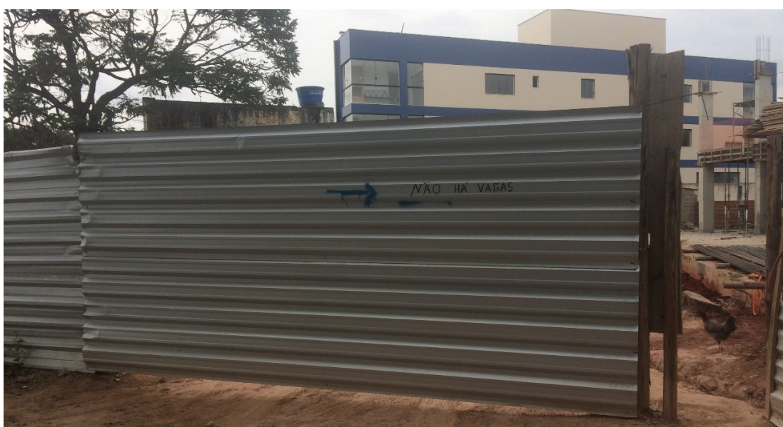
Figura 125 – Portão de acesso para materiais
