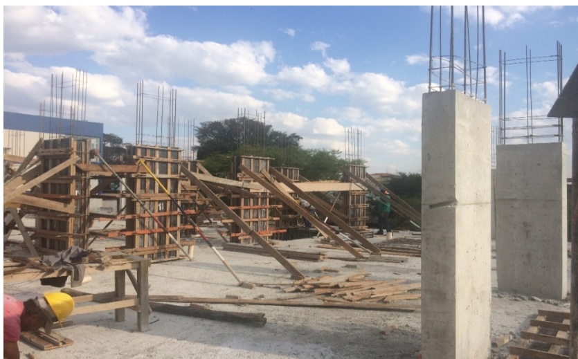
Figura 113 – Pilares desformados
