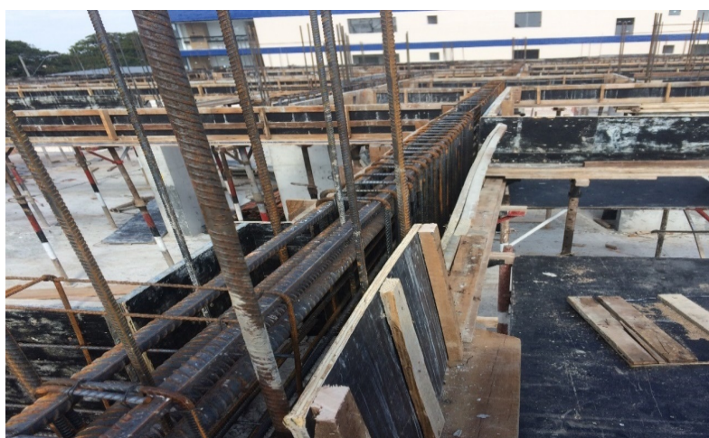
Figura 116 – Viga pronta para amarração dos estribos
