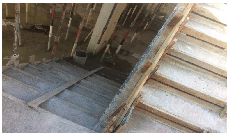
Figura 109 – Escadas após concretagem
