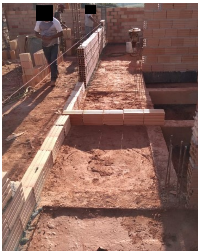
Figura 37 – Amarração da alvenaria
