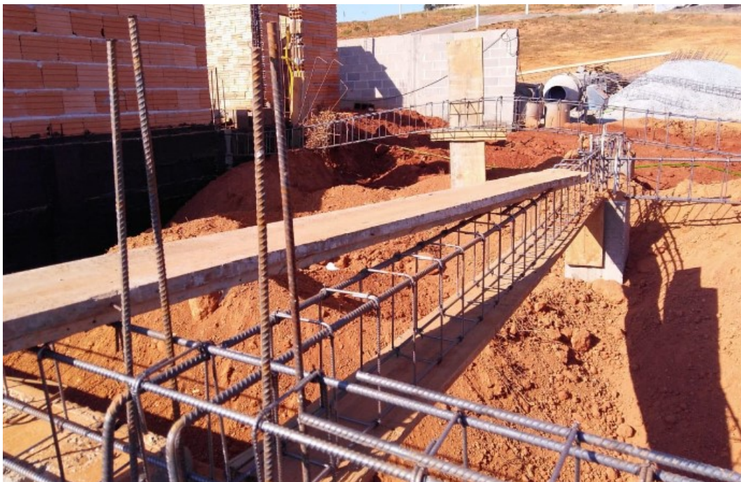
Figura 34 – Armações da viga baldrame
