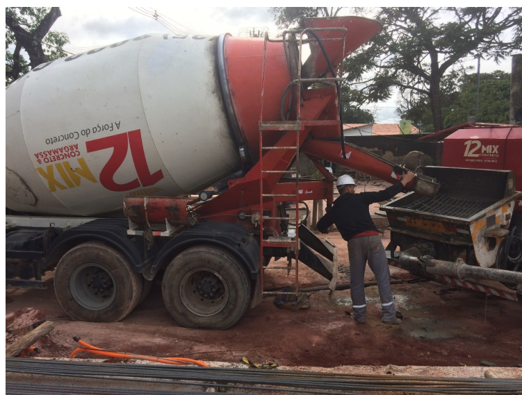
Figura 104 – Concretagem da Segunda Laje
