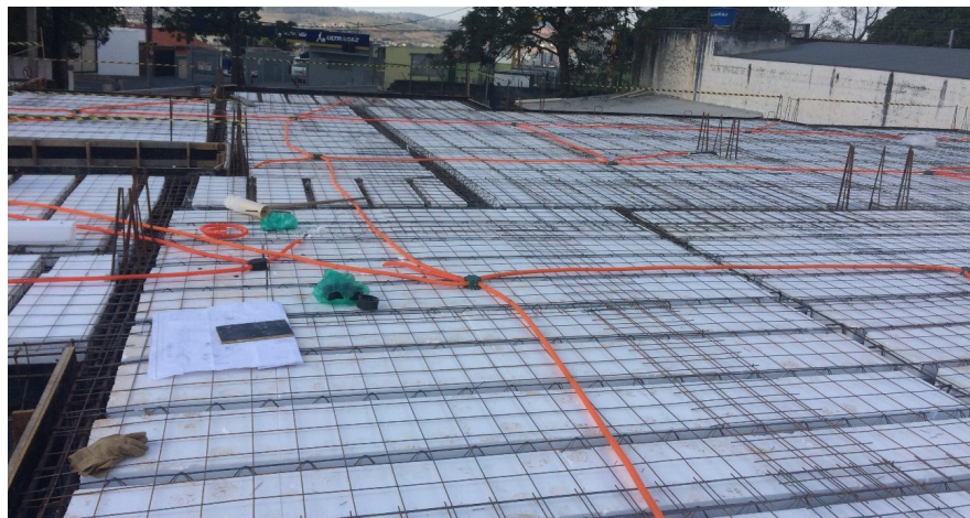
Figura 101 – Laje do segundo pavimento
