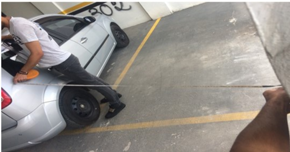
Figura 78 – Medidas realizadas no vão de uma vaga de garagem
