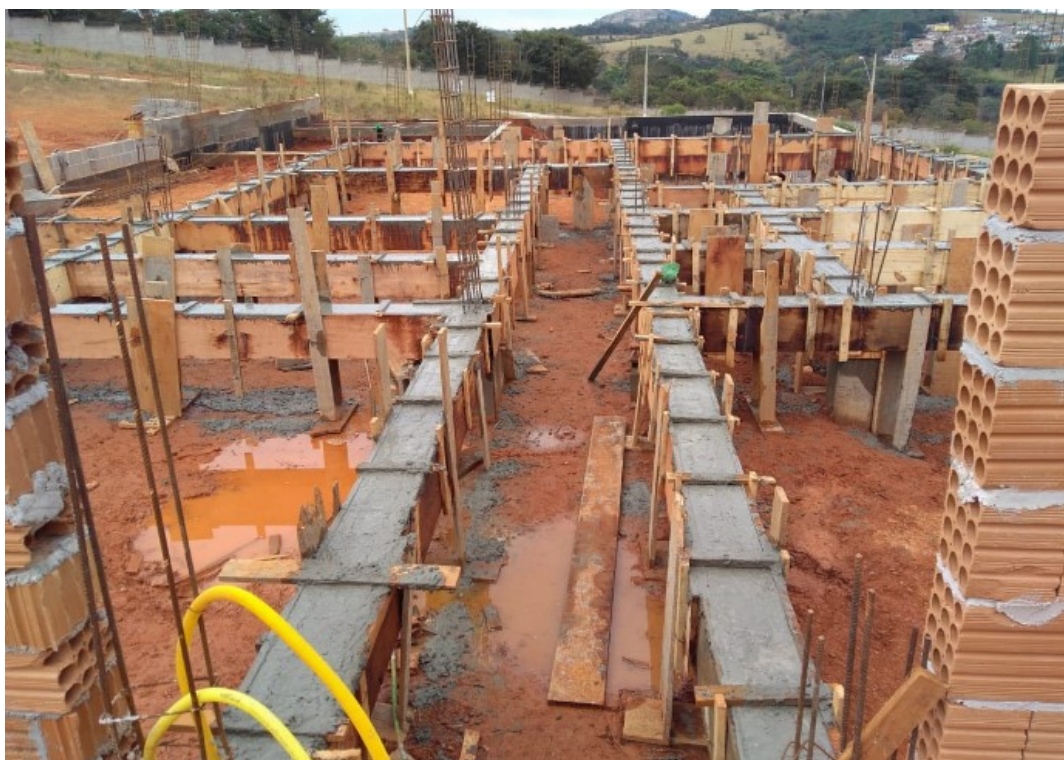
Figura 35 – Vigas baldrame concretadas
