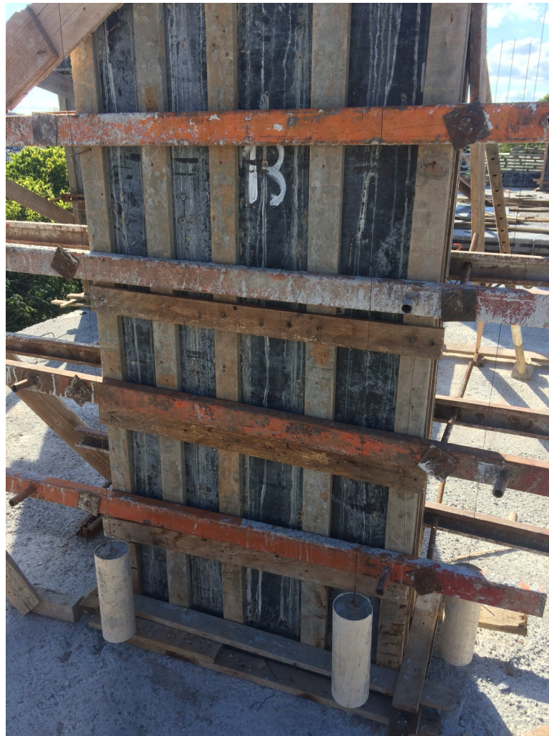
Figura 92 – Montagem dos gabaritos e realização do prumo
