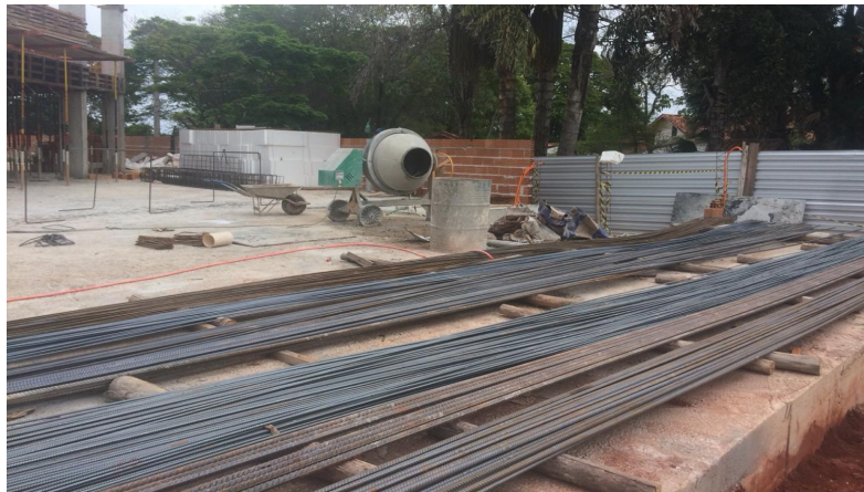
Figura 121 – Estoque das barras de aço
