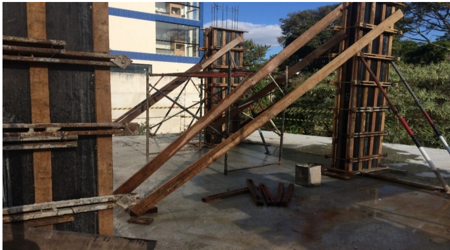
Figura 93 – Travamento do pilar
