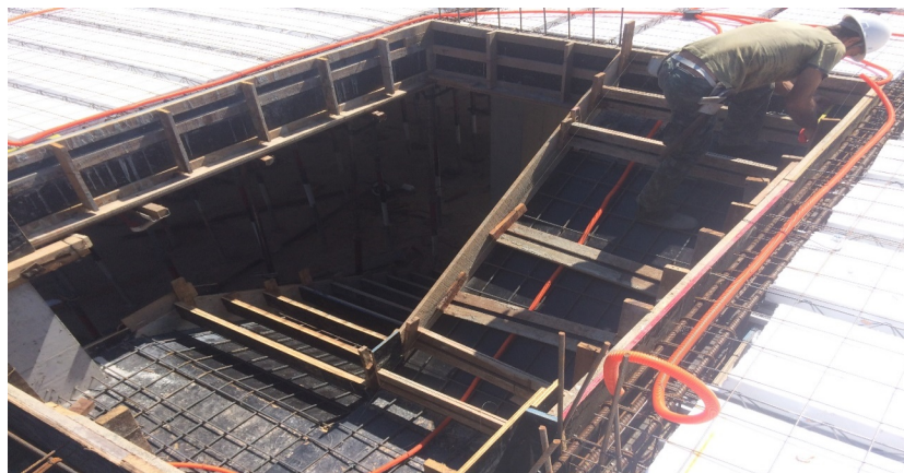
Figura 103 – Montagem dos degraus
