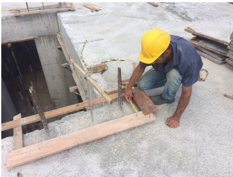
Figura 110 – Locação dos Pilares
