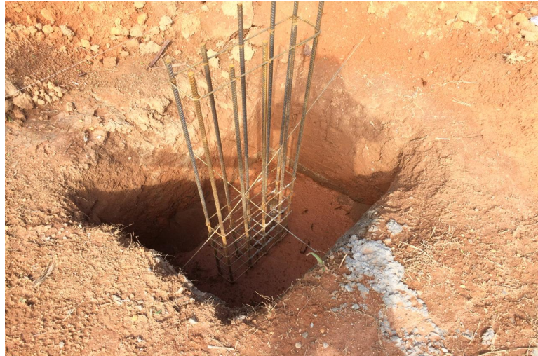
Figura 29 – Posicionamento das armações de fundação
