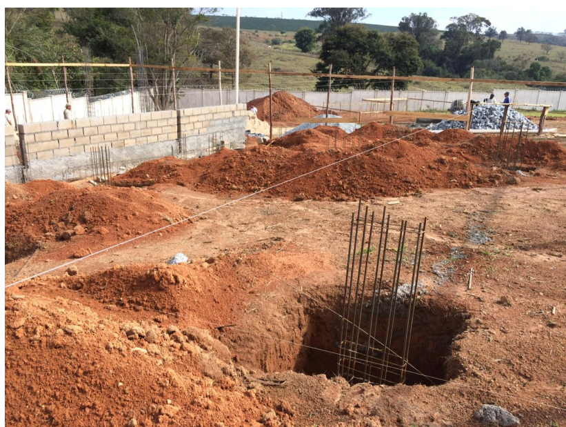
Figura 28 – Demarcação das armações de fundação
