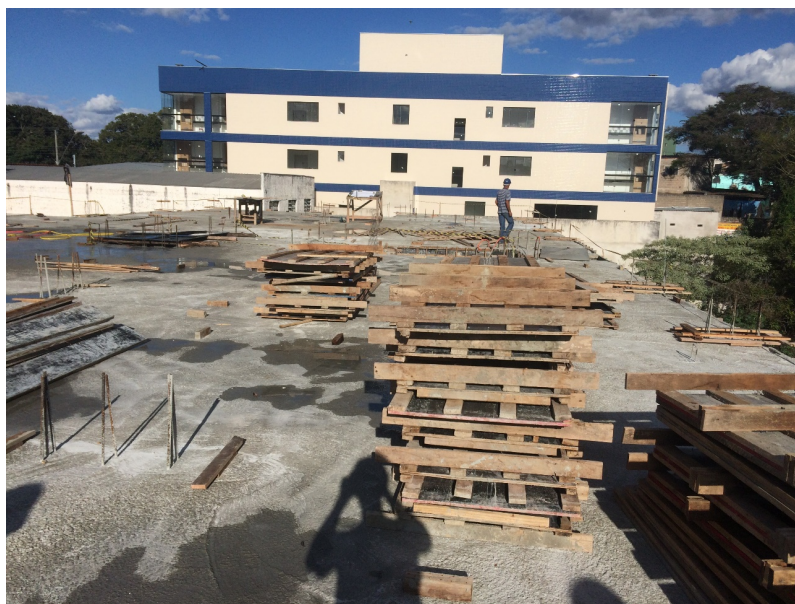
Figura 108 – Laje após concretagem
