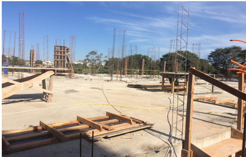
Figura 91 – Montagem dos Pilares
