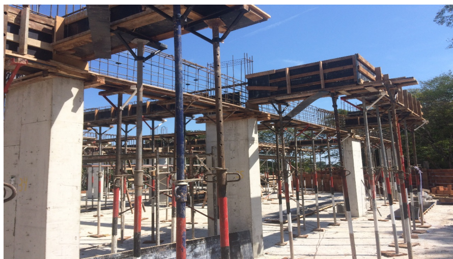
Figura 96 – Montagem das vigas
