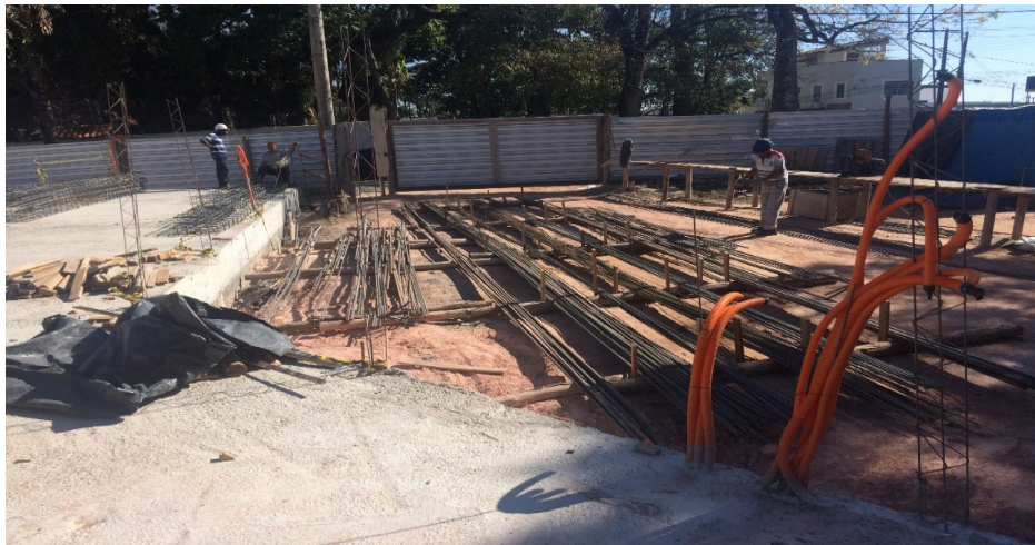
Figura 95 – Ferragem para a montagem das vigas
