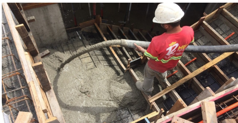
Figura 107 – Concretagem das escadas
