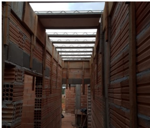
Figura 38 – Fôrmas de madeira
