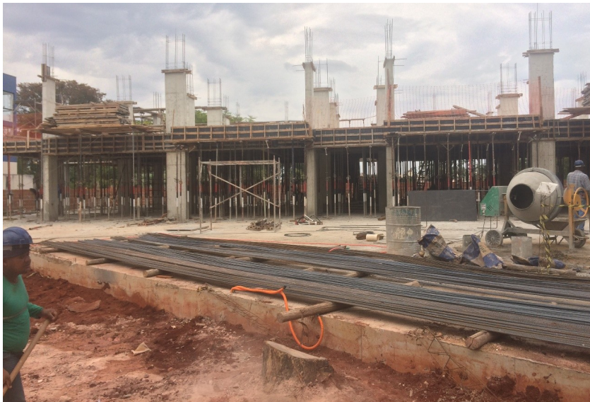
Figura 88 – Canteiro de Obras
