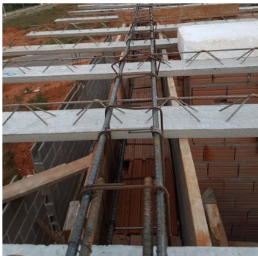
Figura 39 – Vigotas apoiadas sobre as vigas
