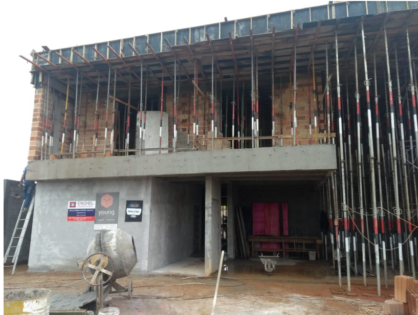
Figura 18 – Execução da laje do pavimento superior
