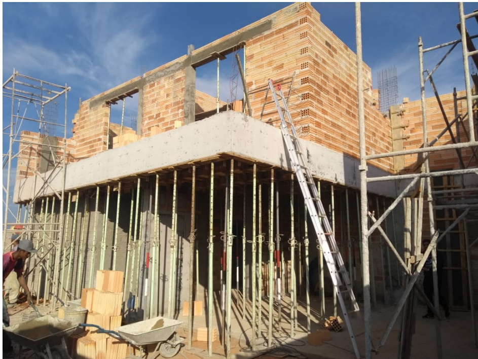
Figura 20 – Obra residencial condomínio MontSerrat em Lavras – MG
