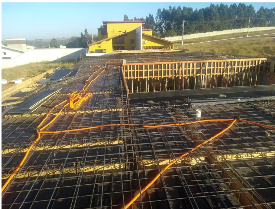
Figura 15 – Laje maciça antes da concretagem
