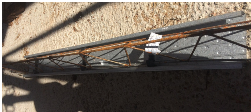
Figura 99 – Visão superior da vigota
