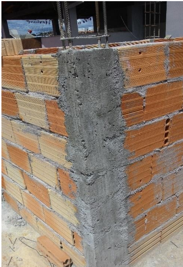
Figura 26 – Amarração de alvenaria no pilar
