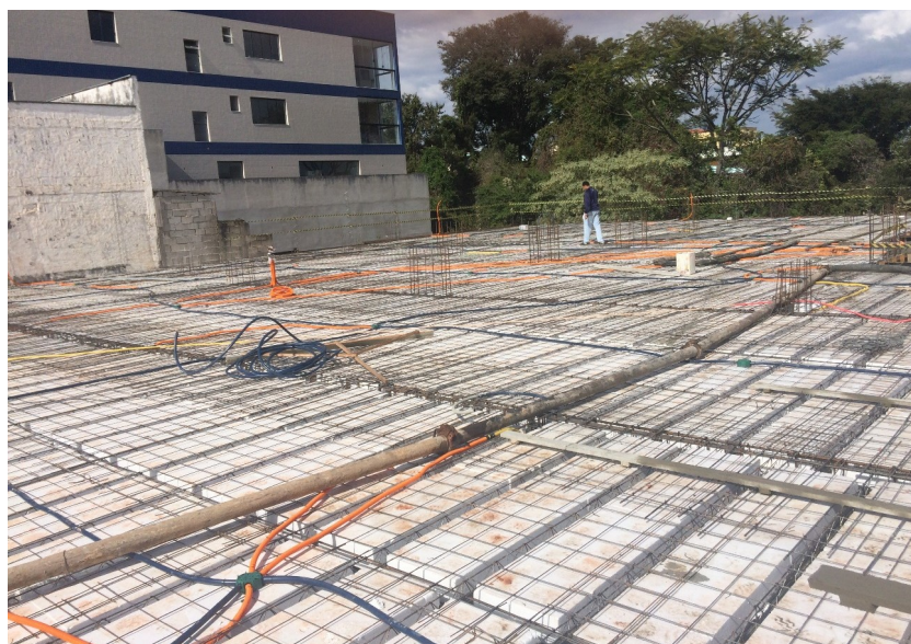
Figura 89 – Laje do primeiro pavimento
