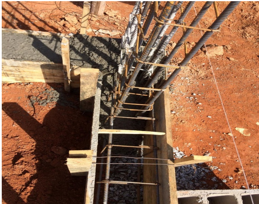
Figura 31 – Detalhe da concretagem
