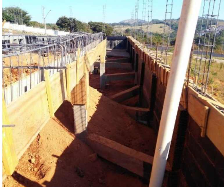
Figura 33 – Montagem das fôrmas para viga baldrame
