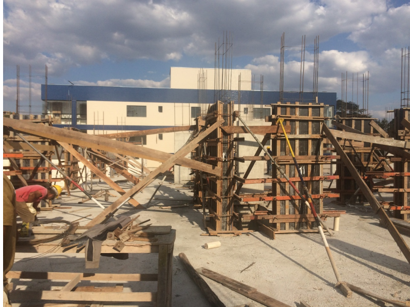
Figura 111 – Gabaritos montados e travados
