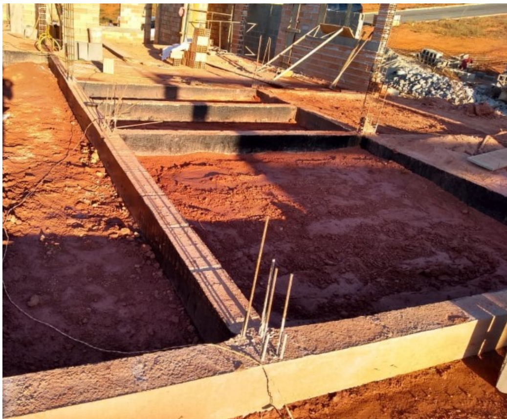
Figura 36 – Vigas desformadas
