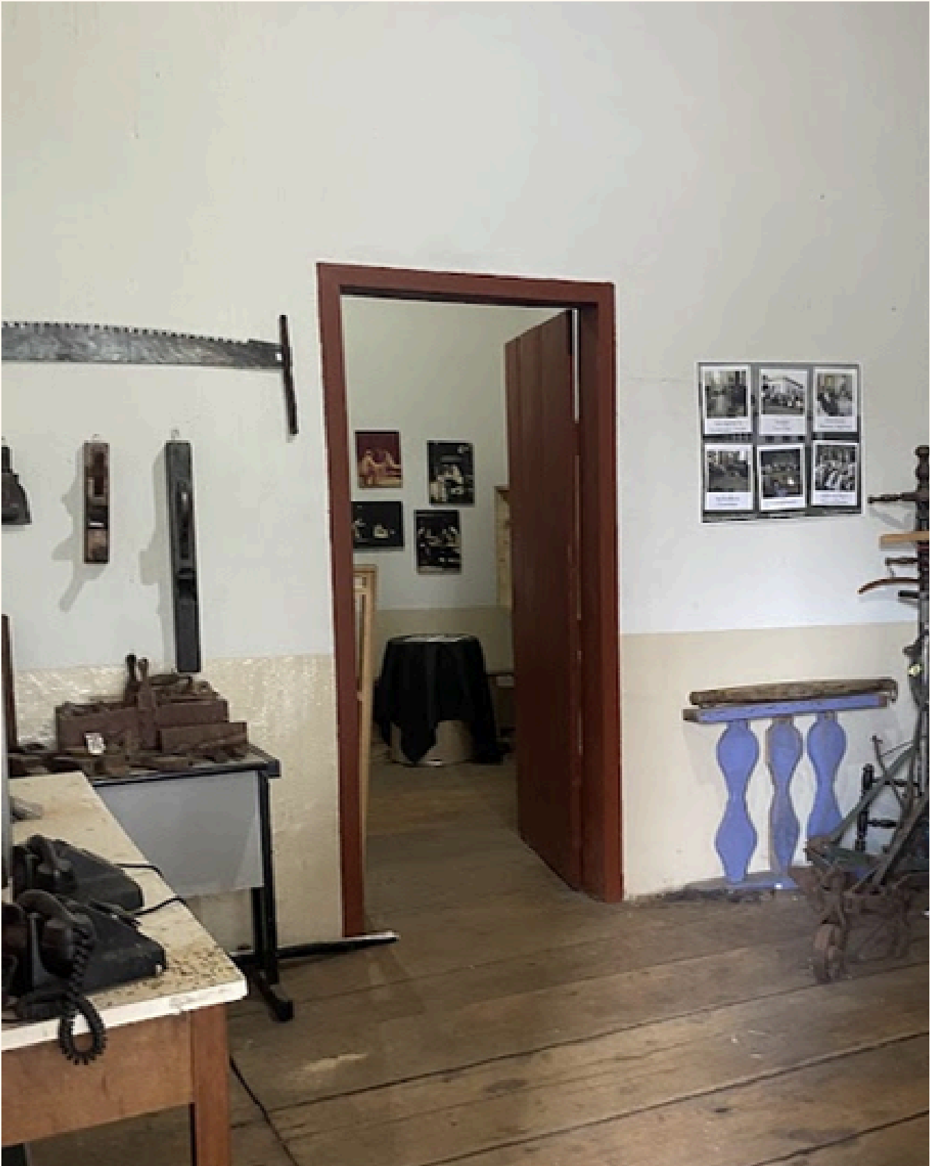
PAREDE QUE SERÁ DEMOLIDA PARA AS SALAS DE EXPOSIÇÃO. FONTE: PRODUZIDO PELA AUTORA, 2025
