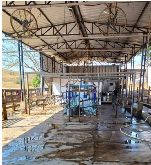
Figura 7: sala de espera e entrada da ordenha
