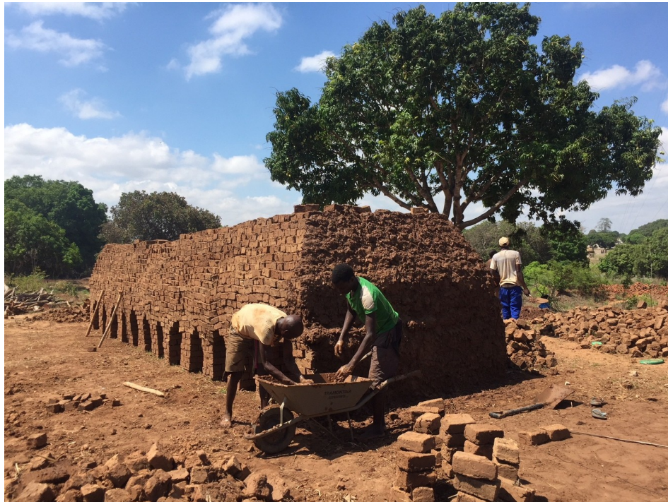
Imagem 13- Processo de construção
