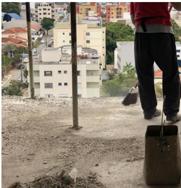
Figura 112 – Limpeza da laje
