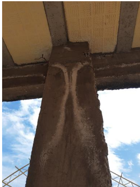
Figura 37 – Pilar com processo de lixiviação
