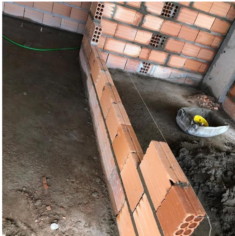
Figura 122 – Elevação dos cantos principais com auxílio da linha guia.
