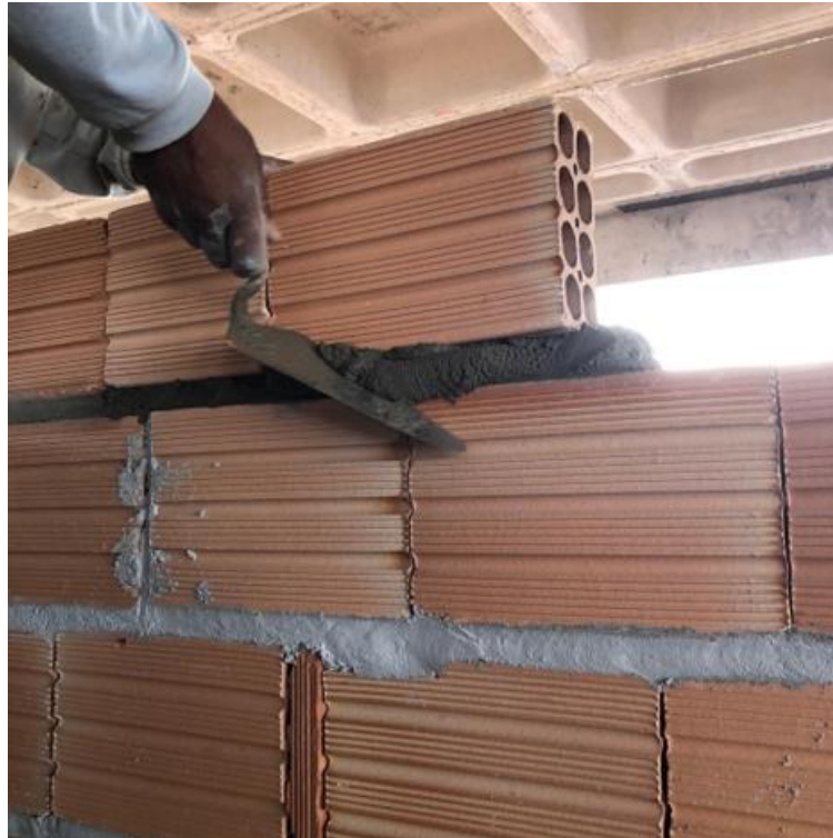
Figura 123 – Retirada do excesso de argamassa
