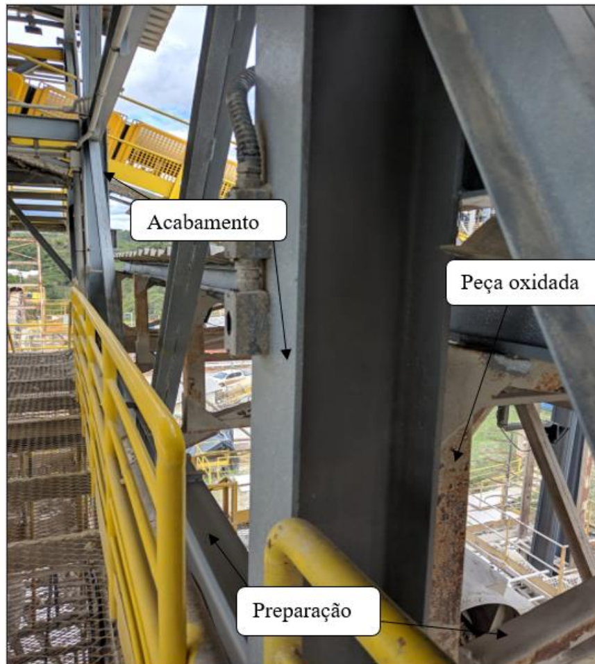
Figura 13 – Preparação de parte da estrutura
