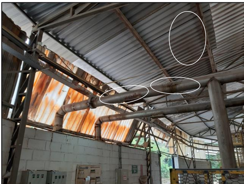
Figura 8 – Estrutura do galpão da Separação Magnética
