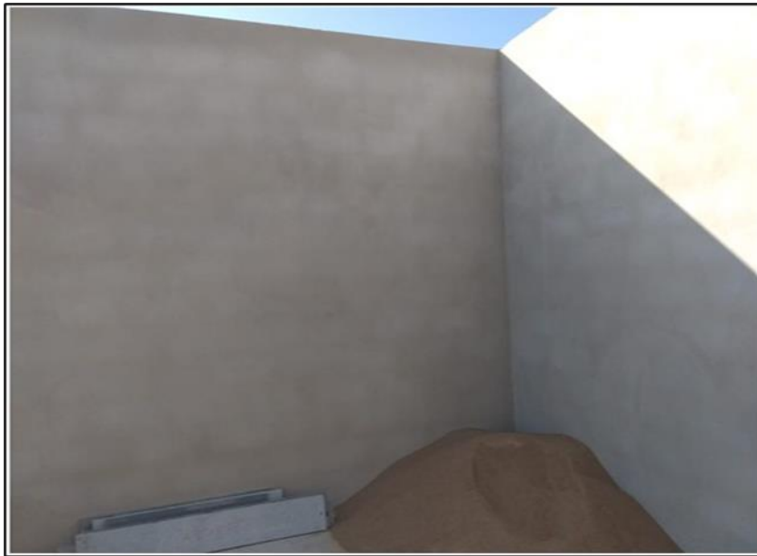
Figura 18 – Parede preparada para receber o porcelanato
