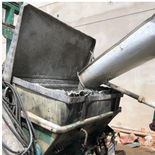
Figura 100 – Caminhão betoneira descarregando concreto na bomba
