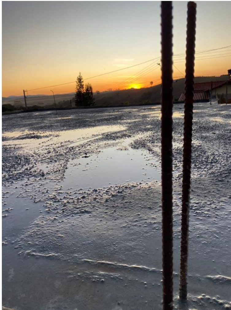
Figura 90 – Cura do concreto da laje
