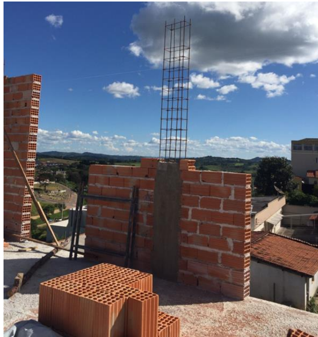
Figura 85 – Concretagem do pilar junto a execução da alvenaria
