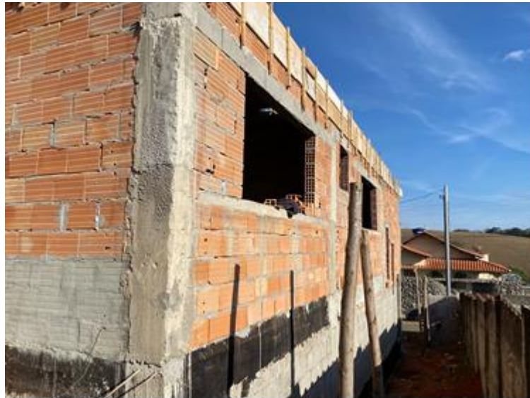
Figura 80 – Vergas e Contravergas na alvenaria
