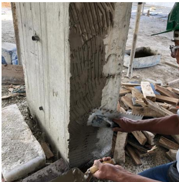
Figura 116 – Passando argamassa na face do pilar
