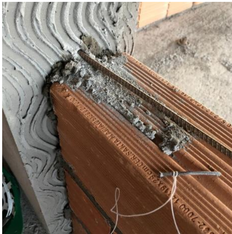
Figura 126 – Vergalhão introduzido na peça estrutural
