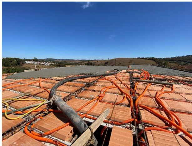
Figura 89 – Concretagem da laje
