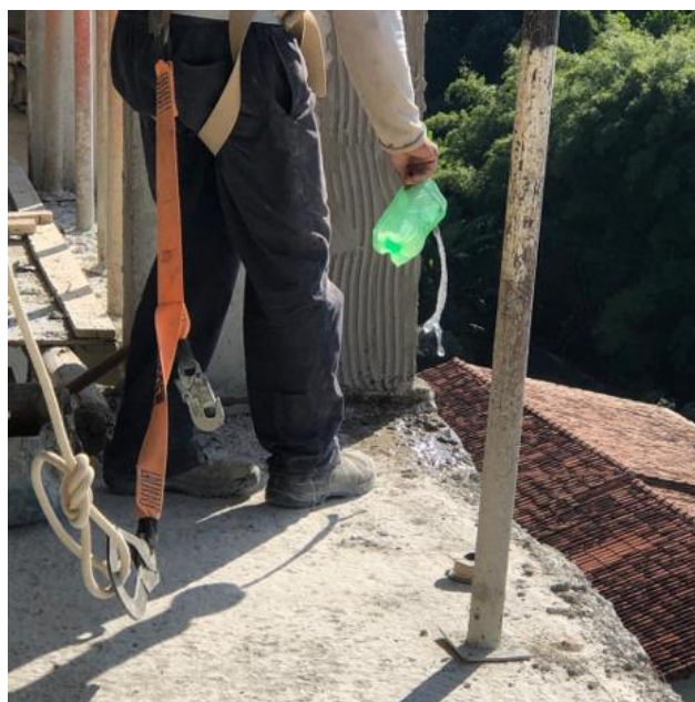
Figura 117 – Laje molhada para receber a alvenaria
