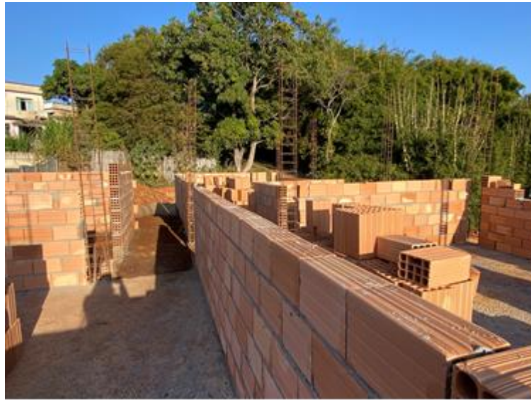
Figura 79 – Execução da alvenaria
