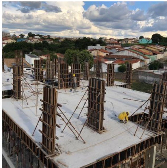
Figura 97 – Pilares do Pavimento tipo 02, bloco B
