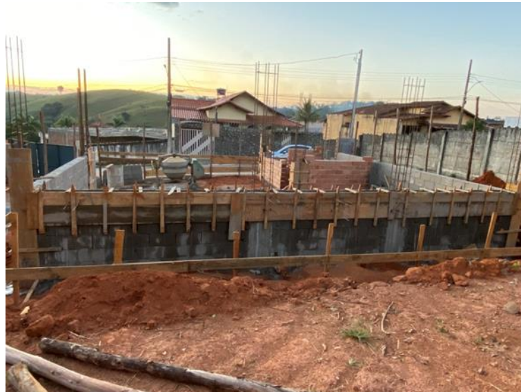
Figura 86 – Montagem das vigas do 1º pavimento
