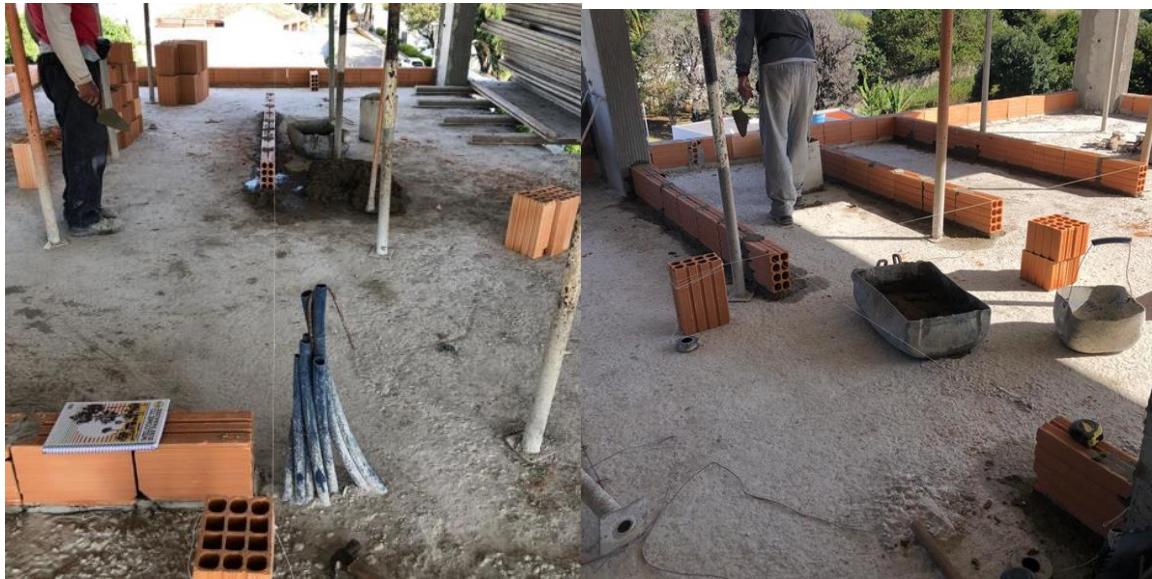
Figura 119 – Linha guia para auxiliar no alinhamento e marcação
