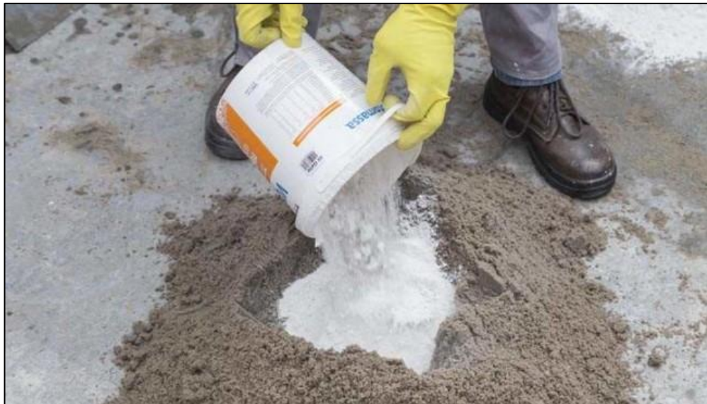
Figura 17 – Homogeneização da argamassa
