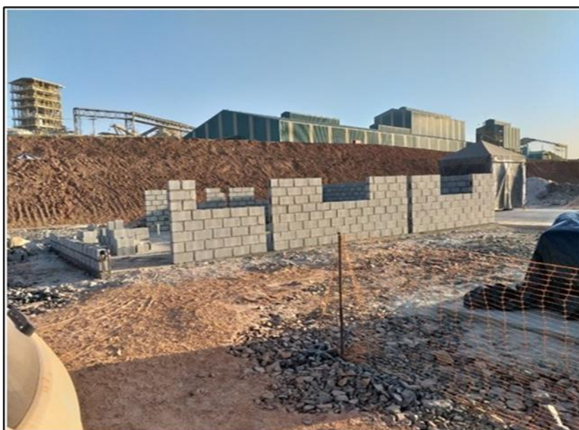
Figura 16 – Alinhamento dos blocos
