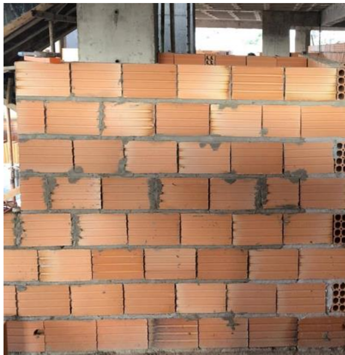
Figura 125 – Amarração dos tijolos
