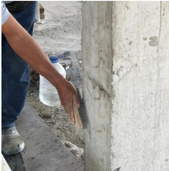
Figura 115 – Escovação da face do pilar que receberá alvenaria
