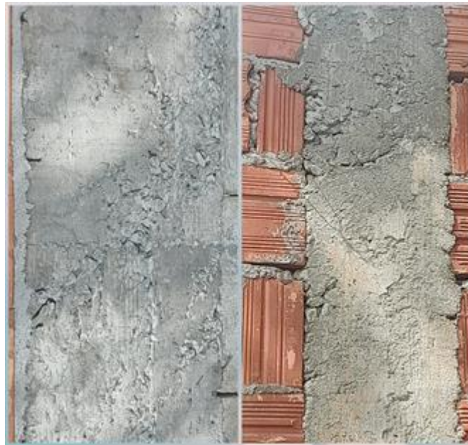
Figura 60 – Pilar da obra do cemitério
