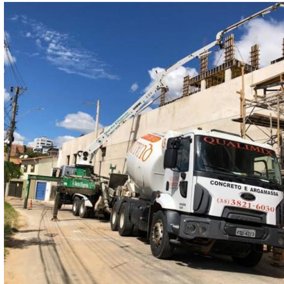
Figura 99 – Caminhão bomba-lança e betoneira
