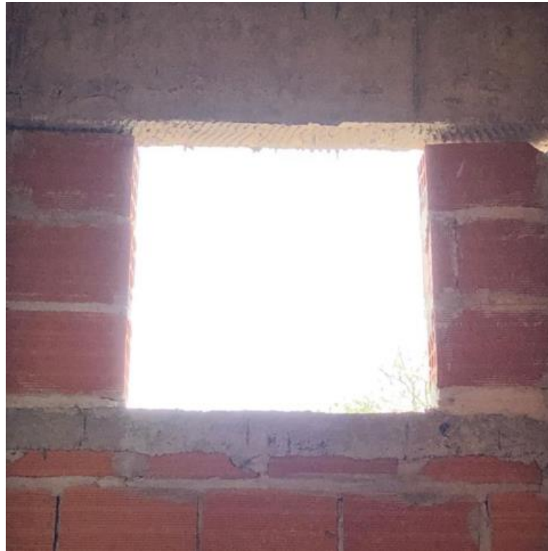
Figura 128 – Viga com função de verga na janela
