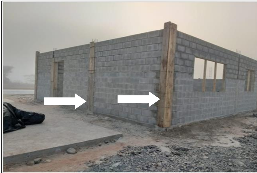
Figura 19 – Montagem de forma dos pilares
