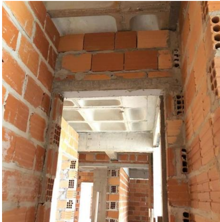
Figura 132 – Verga de uma porta finalizada
