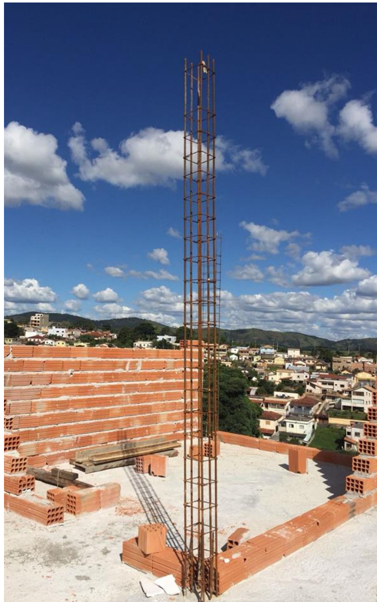
Figura 83 – Posicionamento das armaduras do pilar
