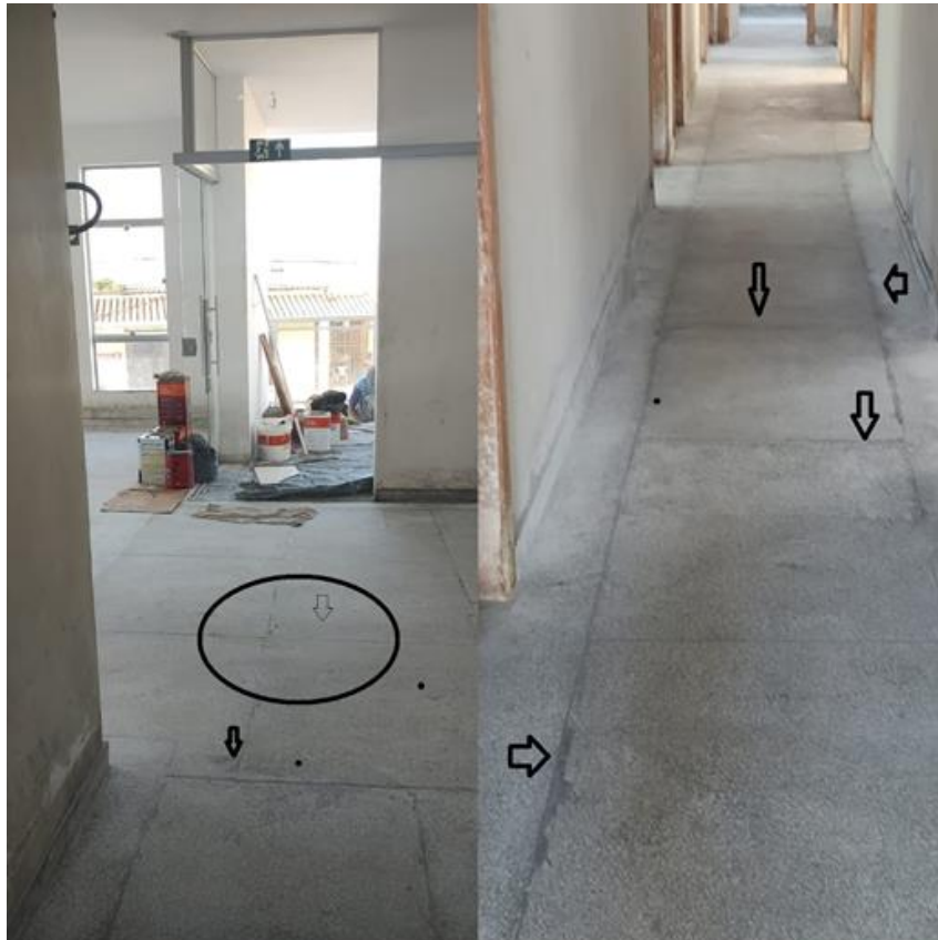
Figura 56 – Piso do posto de saúde bairro Serra
