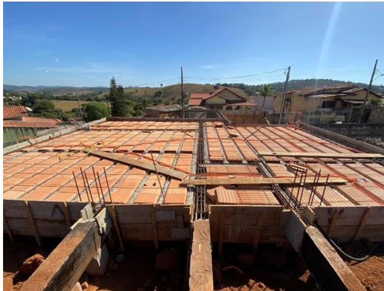
Figura 87 – Laje pré-moldada
