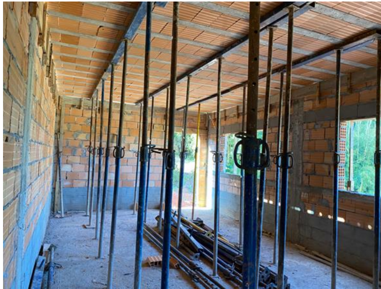
Figura 91 – Escoramento da laje
