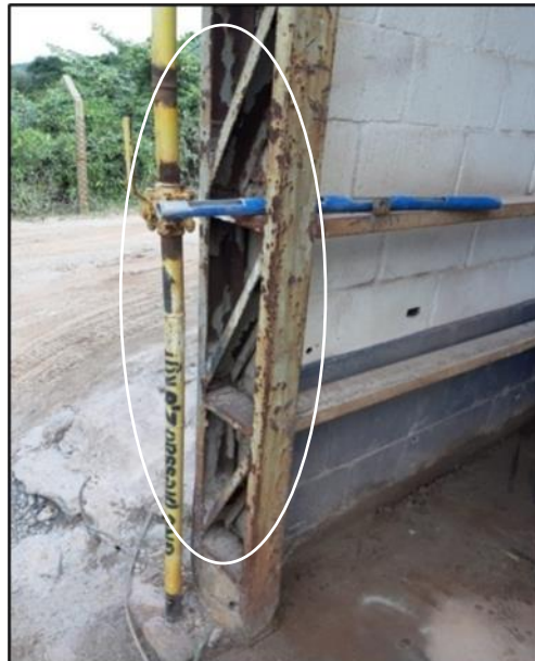
Figura 7 – Pilar metálico de sustentação do galpão
