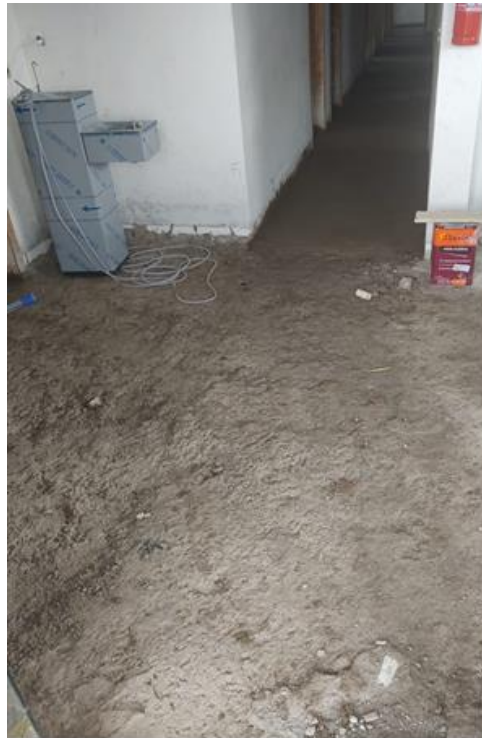
Figura 57 – Demolição do piso granilite
