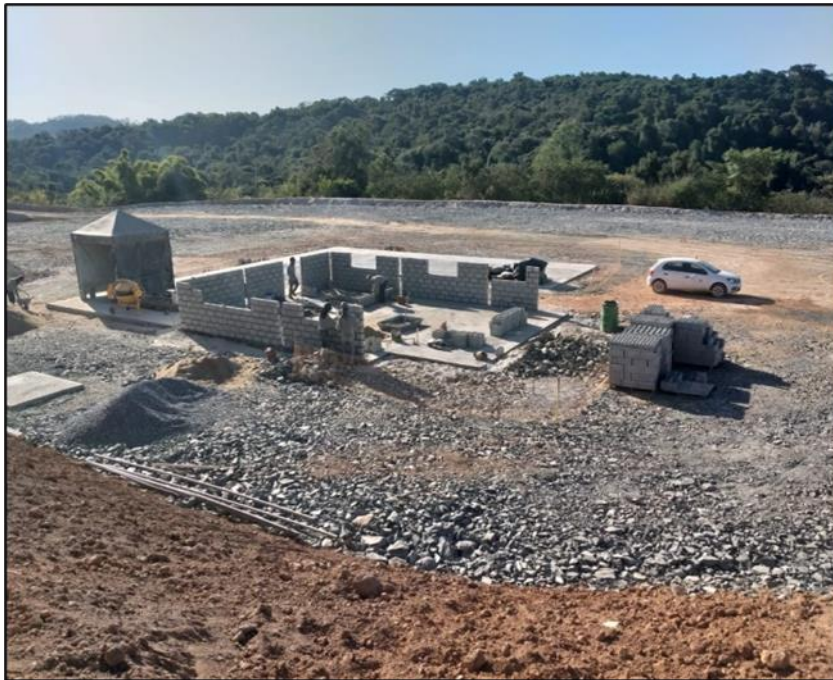
Figura 15 – Início do levantamento das paredes
