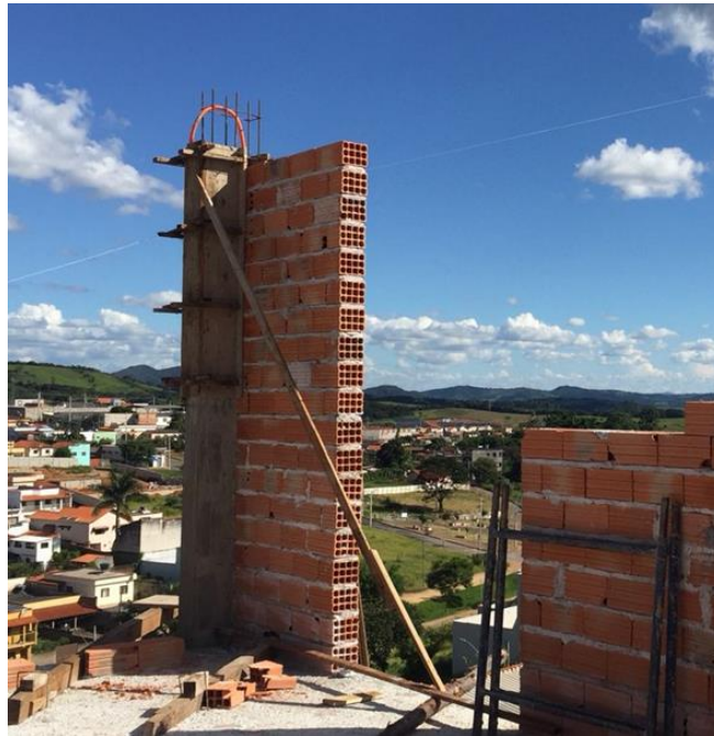
Figura 84 – Posicionamento das fôrmas na estrutura
