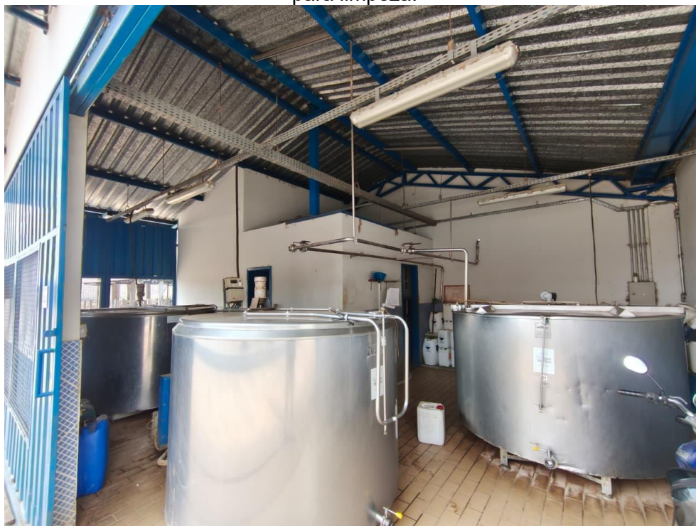
Figura 3: Sala de armazenamento de leite, com os tanques resfriadores e equipamentos para limpeza.
