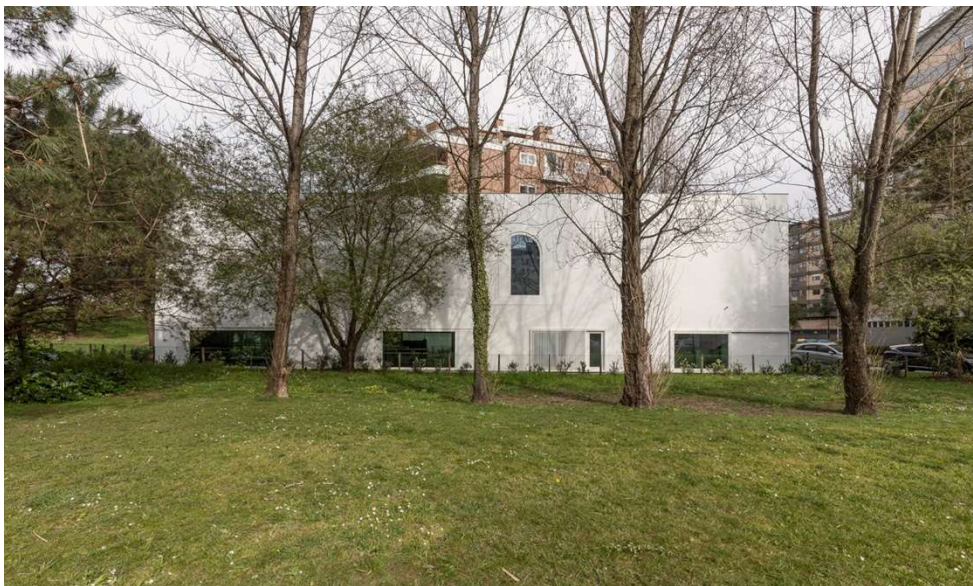
Imagem 7 - Fachada dos Fundos
