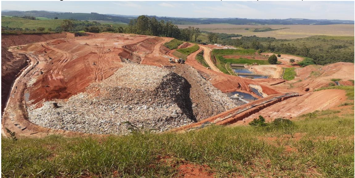
Figura 70 - Aterro Sanitário Controlado (CTR Nepomuceno)
