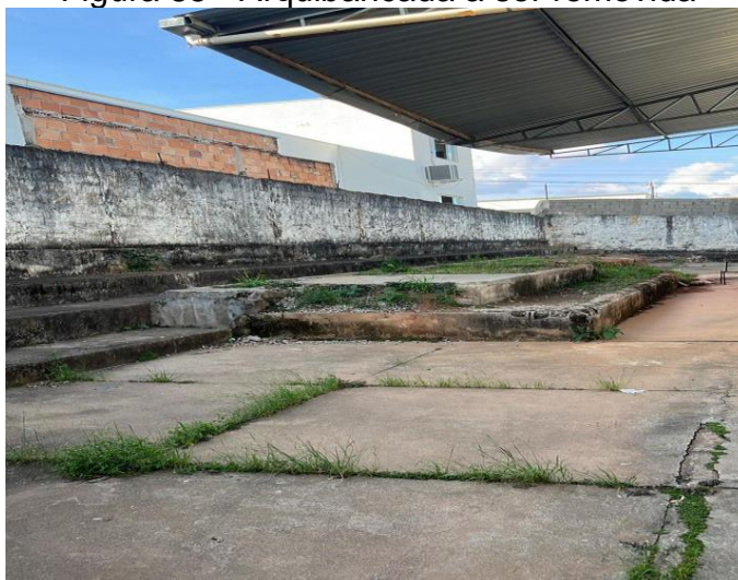
Figura 85 - Arquibancada a ser removida
