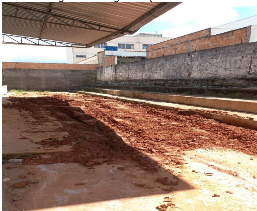
Figura 87 - Regularização do terreno
