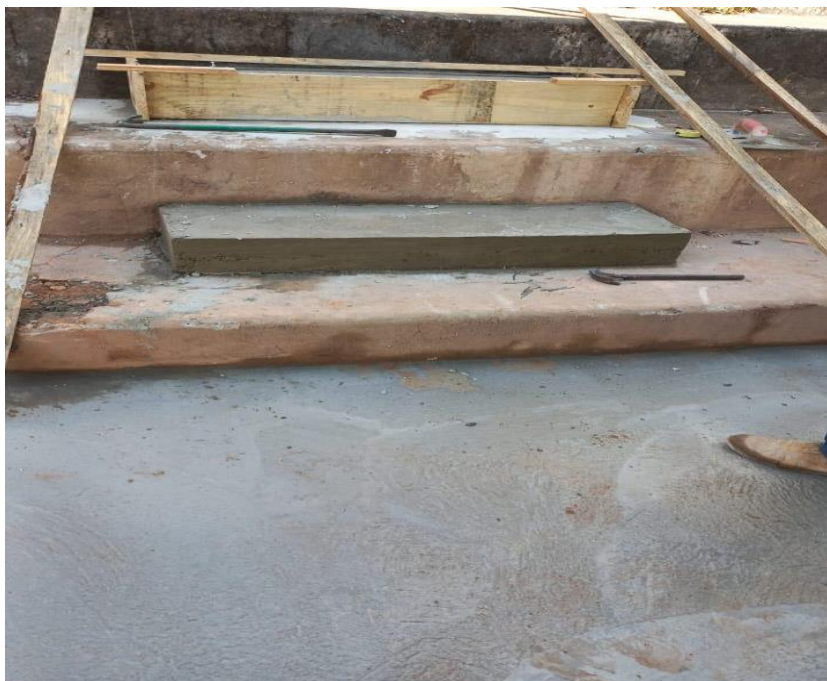
Figura 90 - Criação de degraus para adequação da norma
