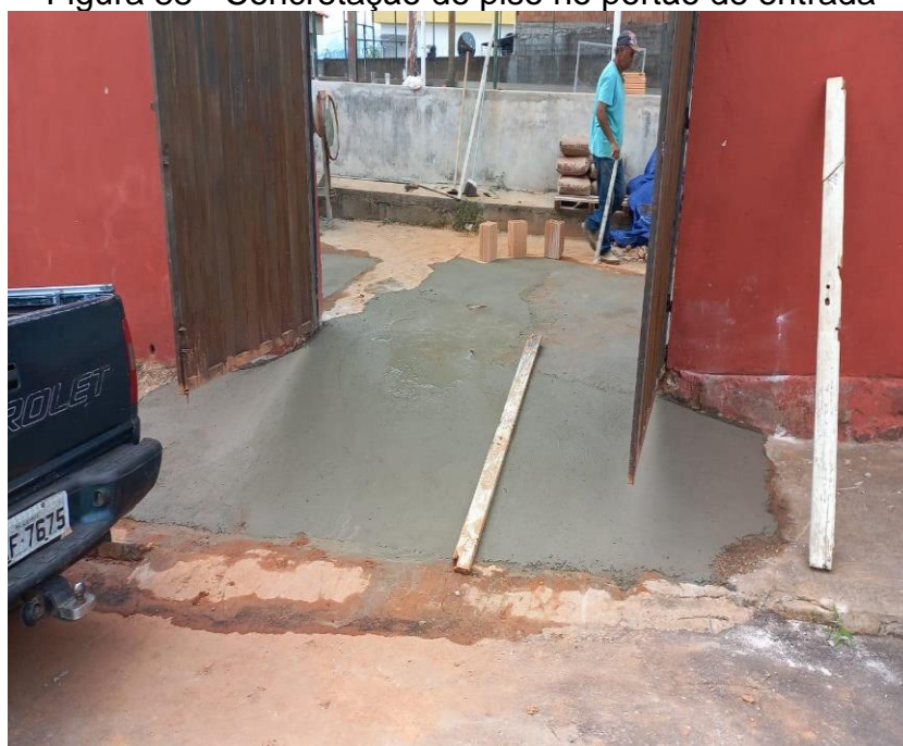
Figura 88 - Concretação do piso no portão de entrada
