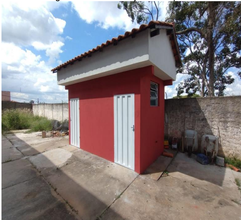
Figura 103 - Renovação do depósito
