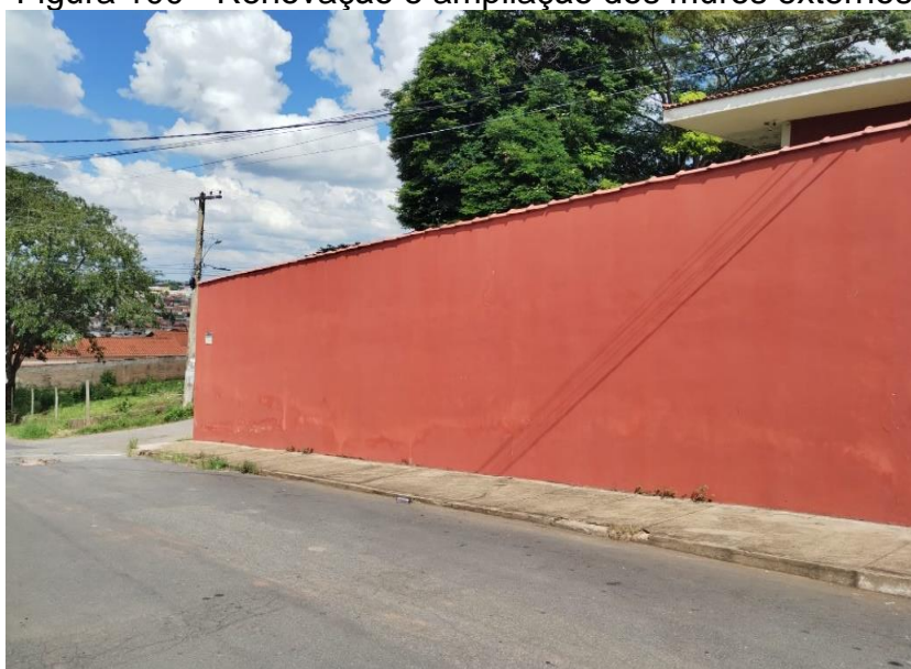
Figura 100 - Renovação e ampliação dos muros externos
