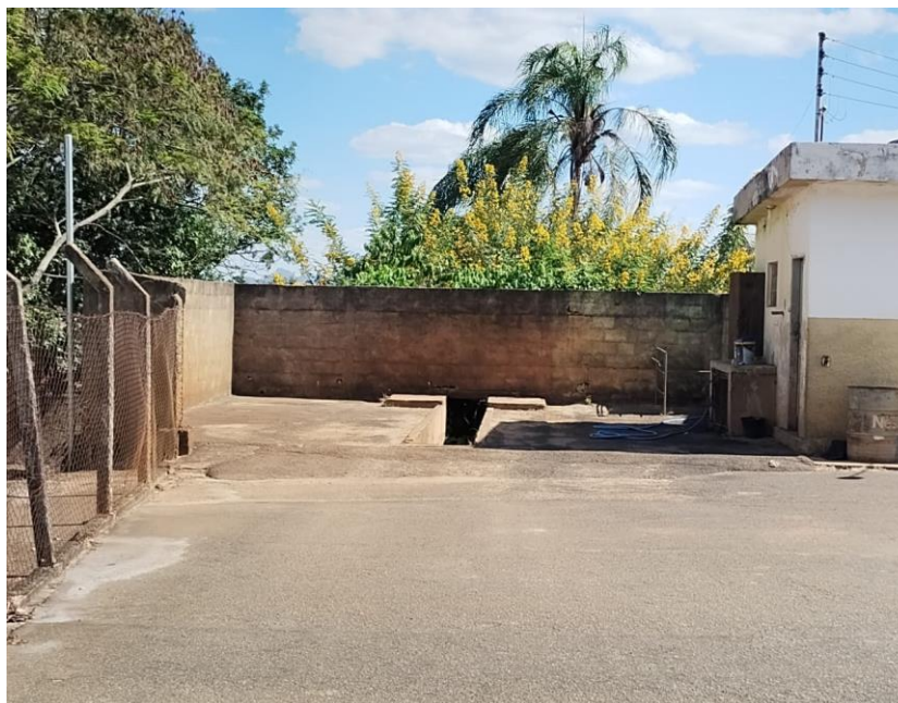
Figura 113 - Espaço atual insuficiente para a demanda de veículos
