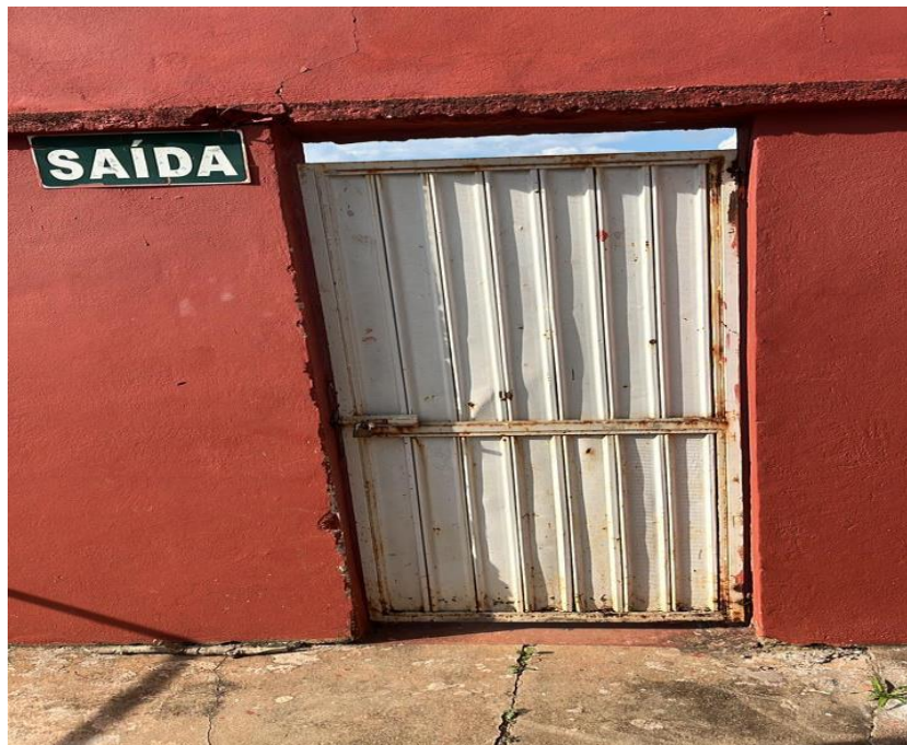
Figura 95 - Portão degradado pela ação do tempo e a exposição a fatores climáticos
