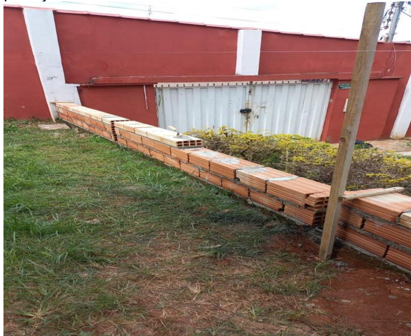
Figura 107 - Montagem de uma base de alvenaria para instalação de grade de proteção
