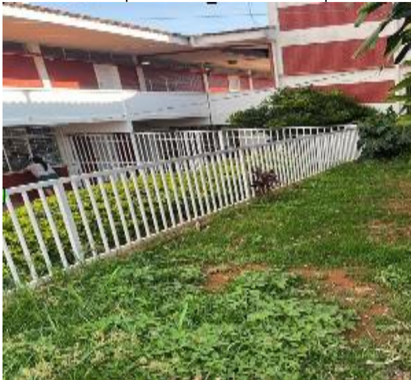
Figura 105 - Guarda-corpos com medida inferior ao previsto na Instrução
