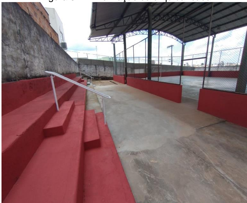
Figura 91 - Finalização da arquibancada
