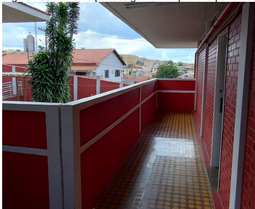
Figura 108 - Finalização dos guarda-corpos dos pavilhões
