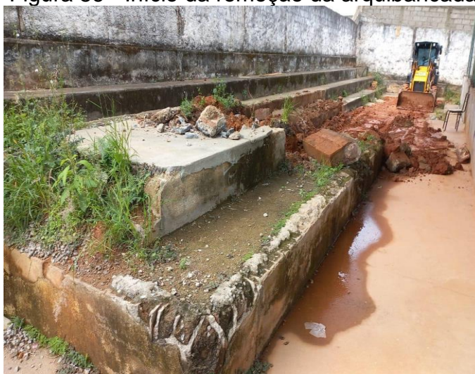
Figura 86 - Início da remoção da arquibancada
