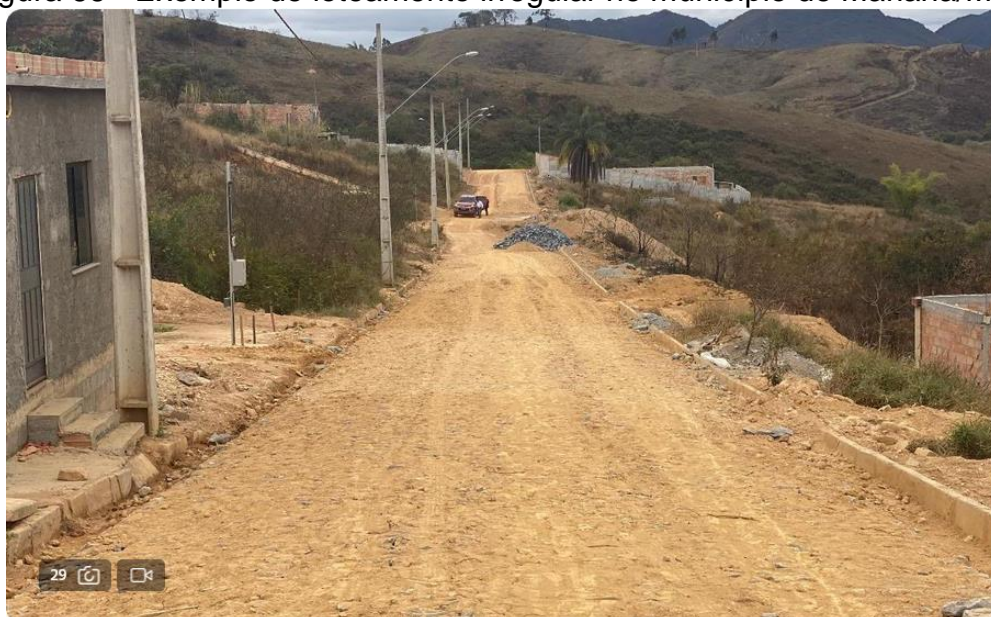
Figura 66 - Exemplo de loteamento irregular no município de Mariana/MG
