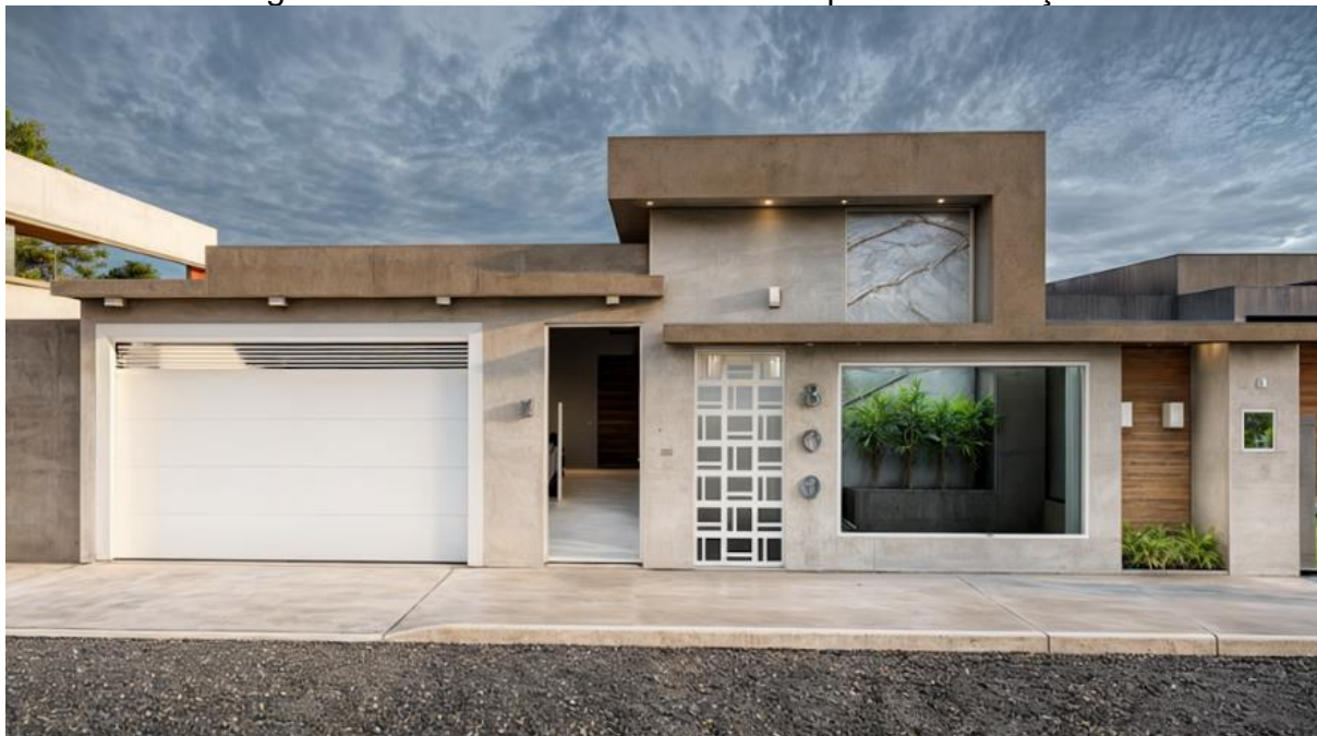
Figura 56 - Fachada da residência 2 após renderização
