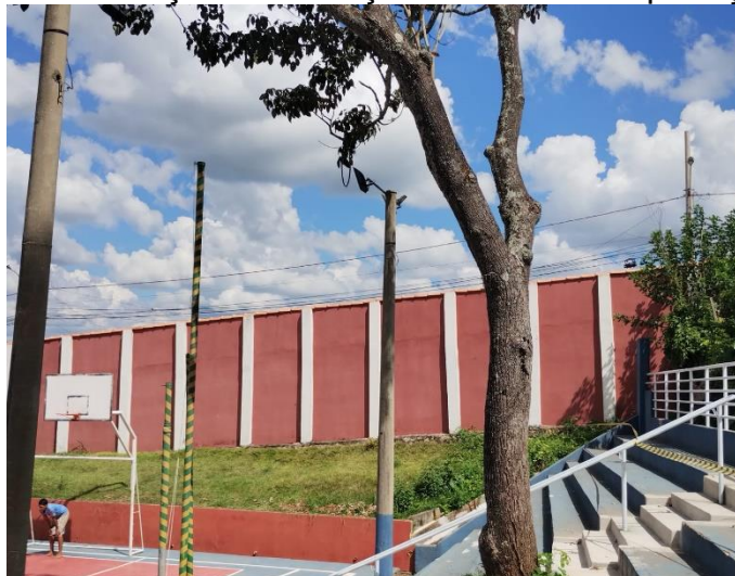
Figura 109 - Finalização da elevação dos muros de proteção externa
