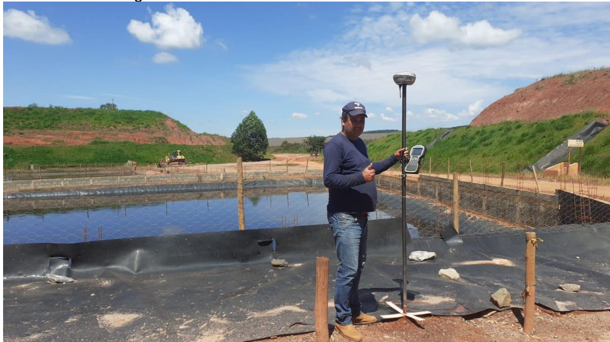
Figura 59 - Ponto de controle utilizando Rover RTK
