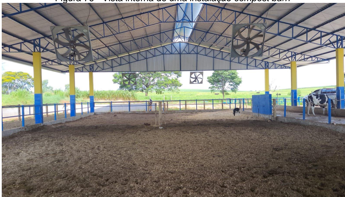
Figura 76 - Vista interna de uma instalação compost barn
