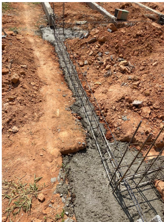
Figura 14 - Fundação de estrutura.
