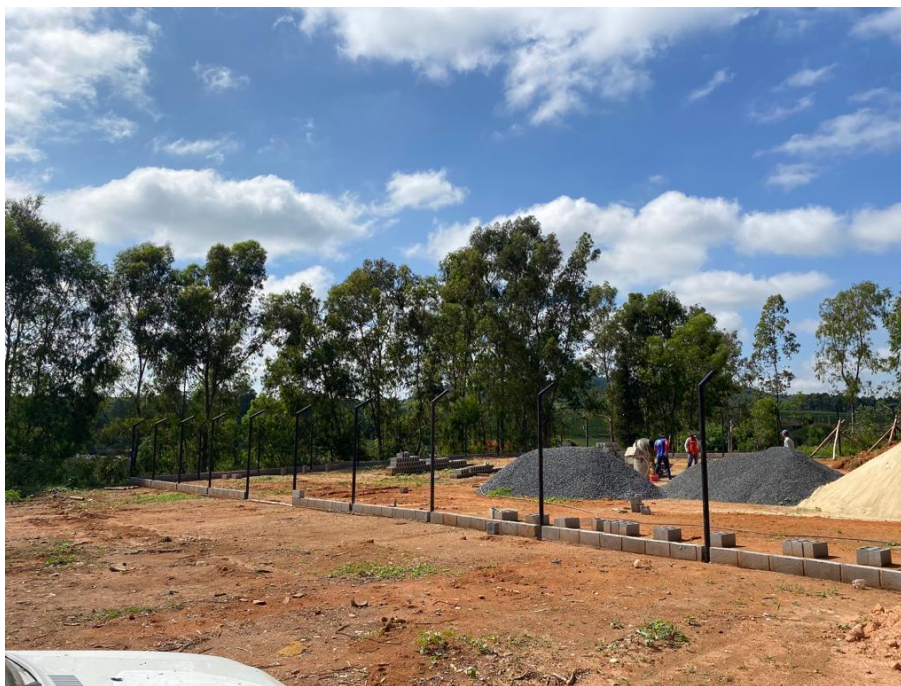
Figura 13 - Início da Fundação do Canil Municipal.
