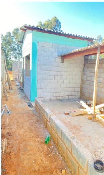
Figura 15 - Finalização da alvenaria.
