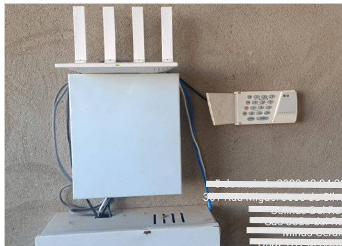
Figura 32 – Central de segurança da obra
