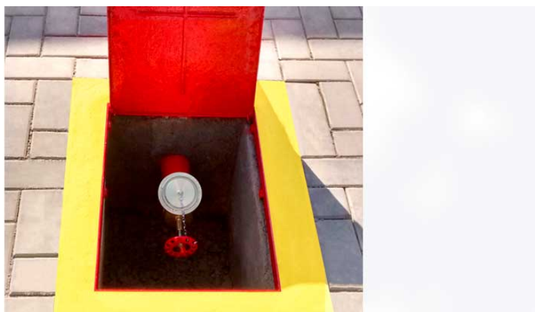
Figura 58 – Hidrante de recalque
