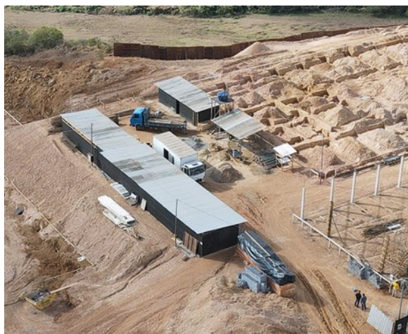
Figura 5 – Imagem aérea do canteiro montado
