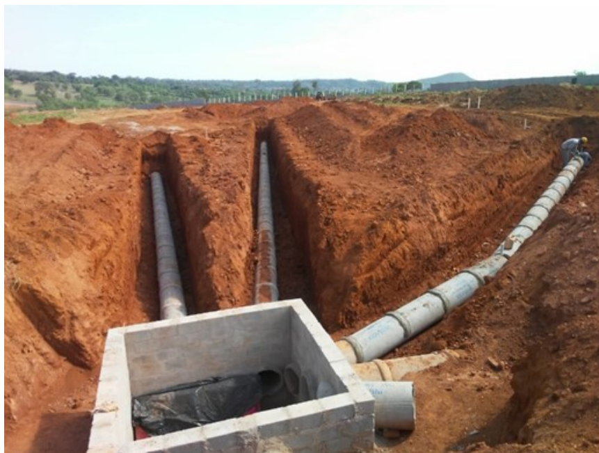
Figura 87 – Alvenaria poço de visita
