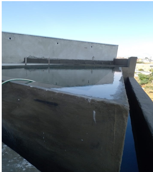
Figura 46 – Teste de estanqueidade da piscina
