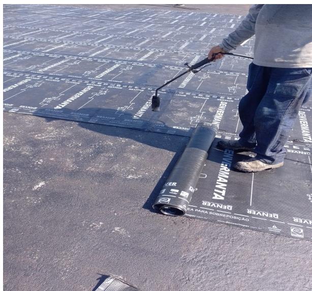
Figura 39 – Aplicação de manta com maçarico
