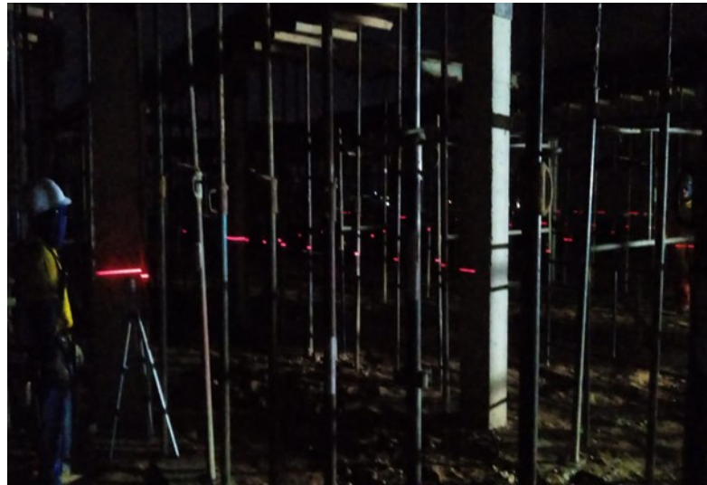
Figura 30 – Uso de nível a laser para nivelamento de laje
