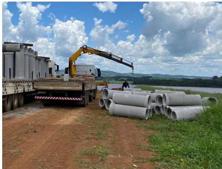
Figura 107 – Descarregamento dos tubos em pontos estratégicos
