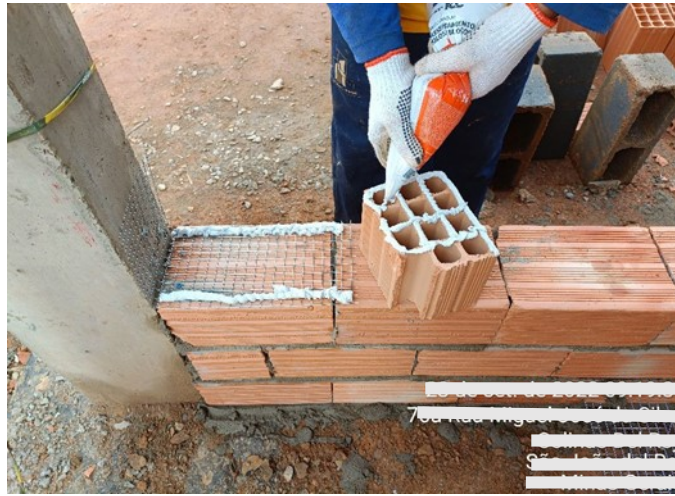
Figura 22 – Execução da massa polimérica
