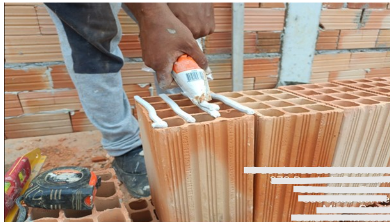
Figura 23 – Execução da massa polimérica
