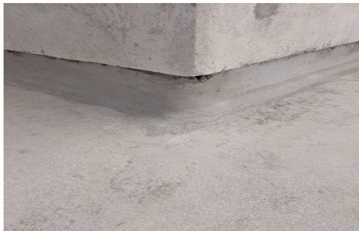
Figura 37 – Rebaixo na alvenaria da platibanda
