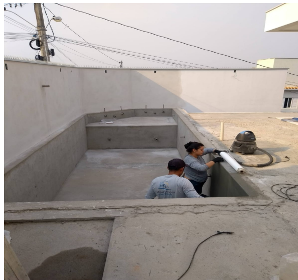
Figura 44 – Aplicação da primeira demão de argamassa polimérica junto com a tela de poliéster
