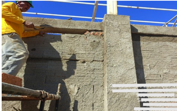
Figura 24 – Execução do encunhamento a 45°
