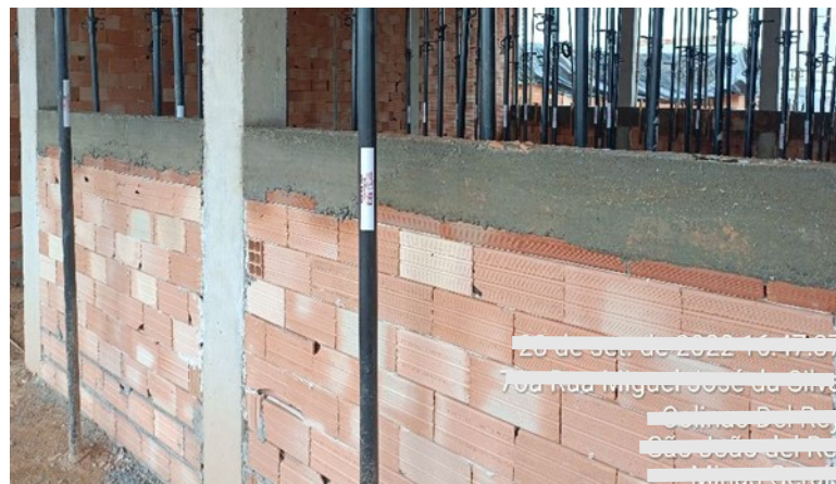
Figura 19 – Execução da Alvenaria de Vedação com tijolo cerâmico
