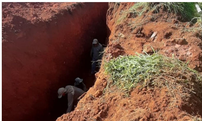
Figura 105 – Vala de rede esgoto
