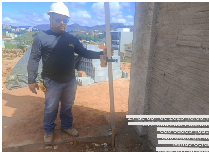
Figura 28 – Nivelamento de piso
