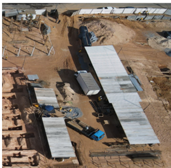
Figura 6 – Imagem aérea do canteiro montado
