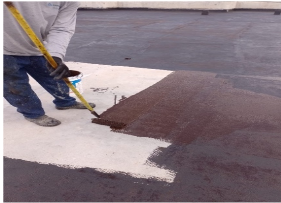
Figura 38 – Imprimação do substrato com primer a base de asfalto
