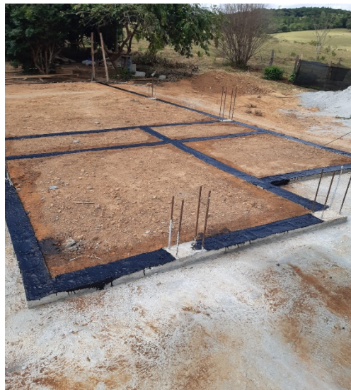
Figura 43 – Baldrame impermeabilizado com pintura asfáltica
