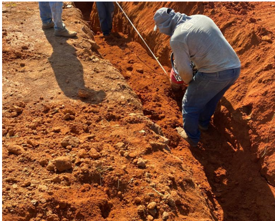
Figura 96 – Compactação da vala após fechamento
