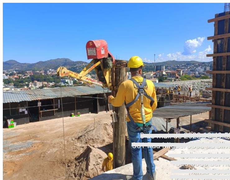
Figura 16 – Operando guincho central de argamassa
