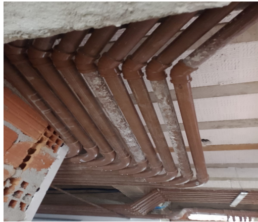
Figura 48 – Redes de distribuição hidráulica
