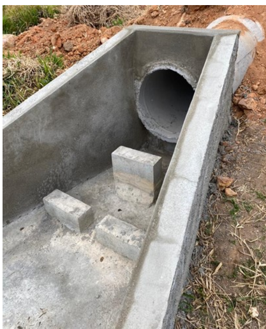
Figura 92 – Reboco dos dissipadores
