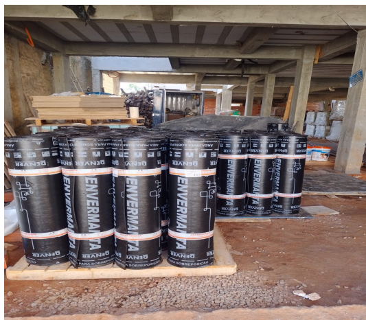
Figura 36 – Rolos da manta utilizada na obra
