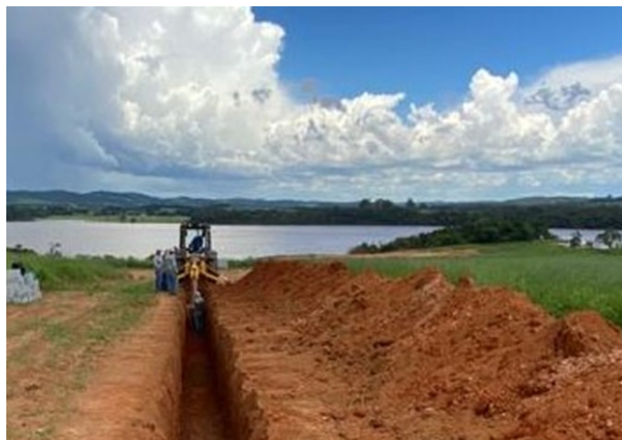
Figura 104 – Abertura de valas
