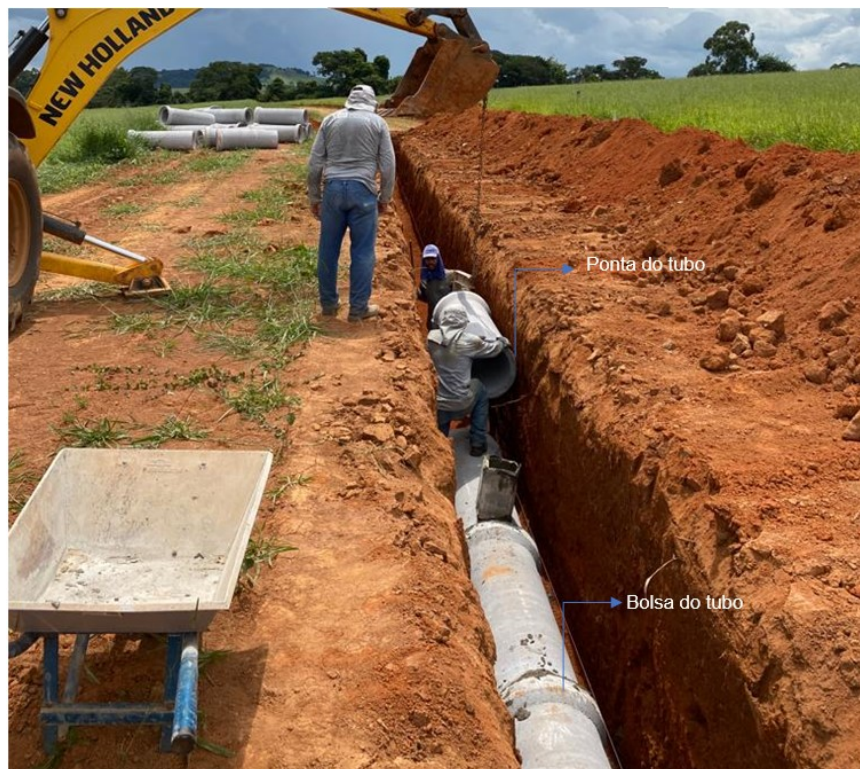
Figura 94 – Assentamento dos tubos de concreto
