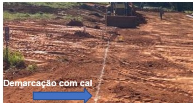
Figura 102 – Demarcação das valas
