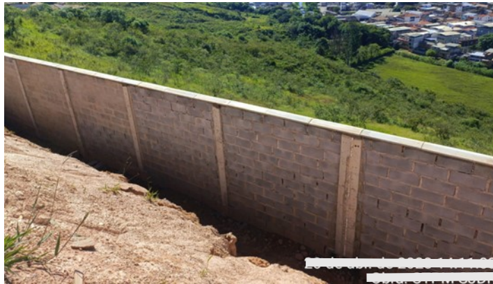
Figura 18 – Muro com bloco de concreto
