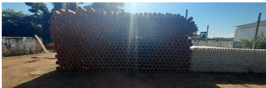
Figura 106 – Armazenamento dos tubos
