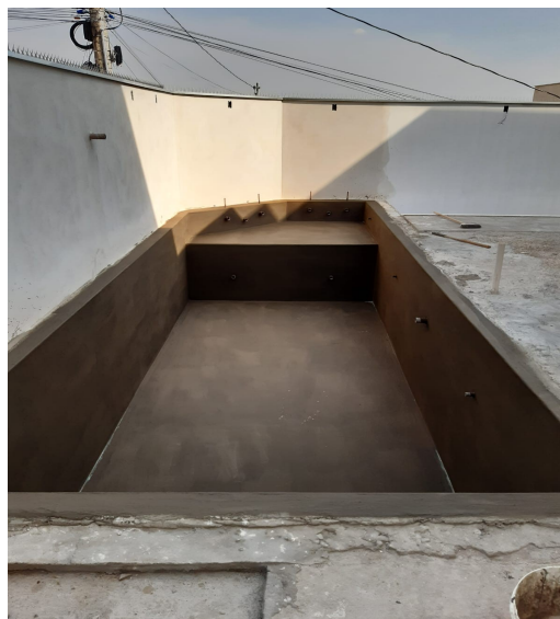
Figura 45 – Impermeabilização da piscina finalizada
