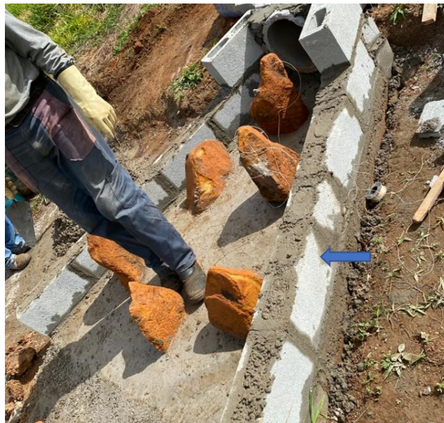
Figura 90 – Demarcação dos gabaritos dos dissipadores com a primeira fiada de bloco
