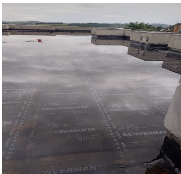
Figura 40 – Teste de estanqueidade
