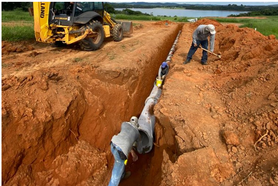
Figura 95 – Rejuntamento dos tubos de concreto
