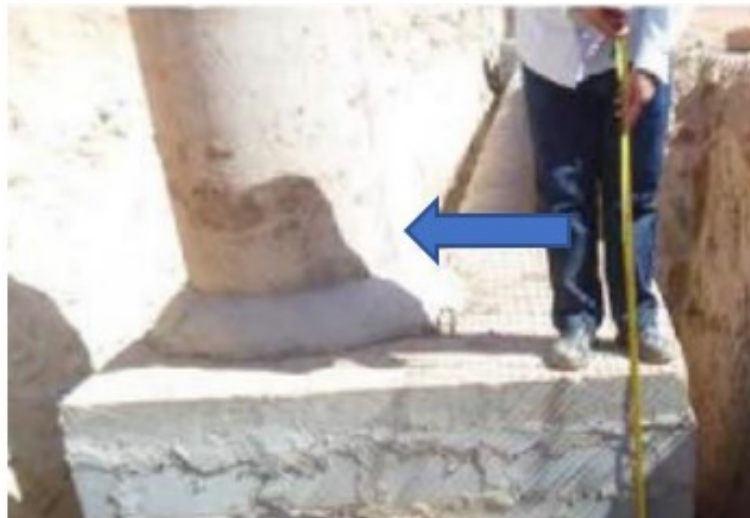
Figura 88 – Chaminé do poço de visita
