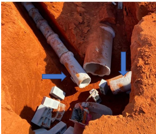
Figura 86 – Ligações ramais de boca de lobo aos poços de visita
