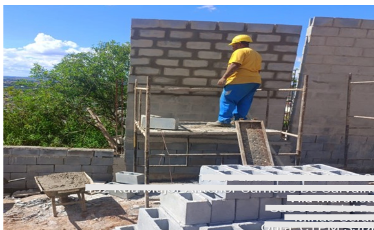
Figura 20 – Execução da Alvenaria de Vedação com bloco de concreto
