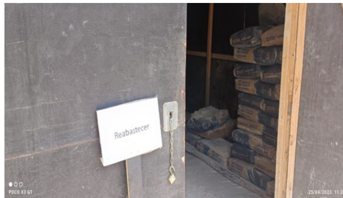
Figura 13 – Placas informativas (Cimento)
