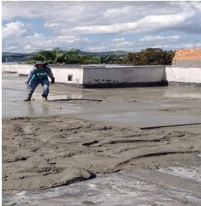
Figura 42 – Aplicação de argamassa sobre a manta asfáltica
