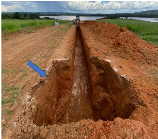
Figura 85 – Fosso para construção dos poços de visita
