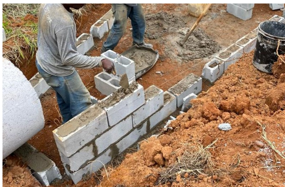
Figura 91 – Levantamento da alvenaria dos dissipadores em bloco cheio
