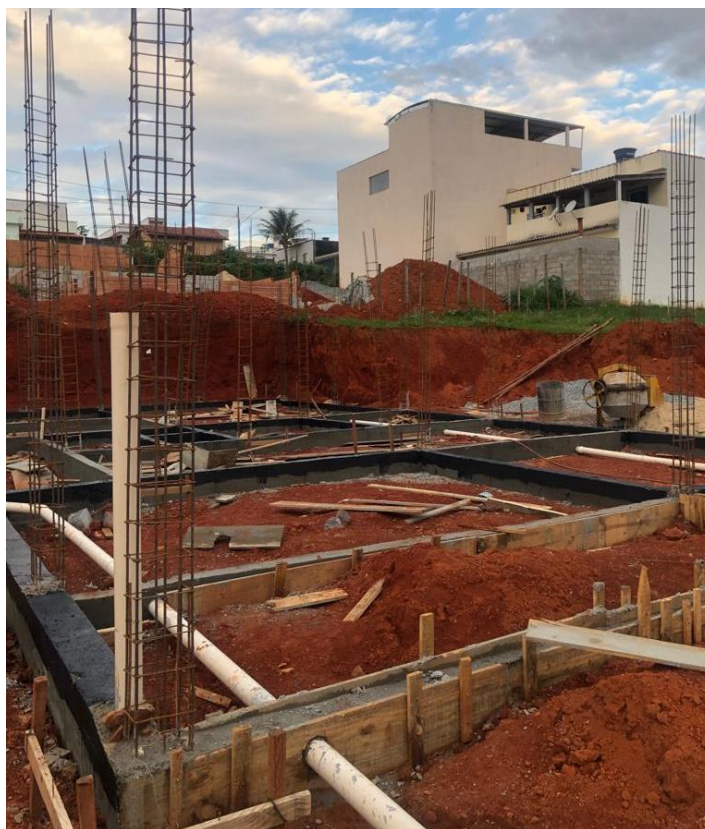
Figura 56: Vigas baldrames concretadas e impermeabilizadas
