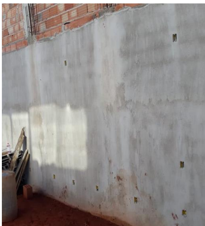
Figura 93: Reboco da alvenaria
