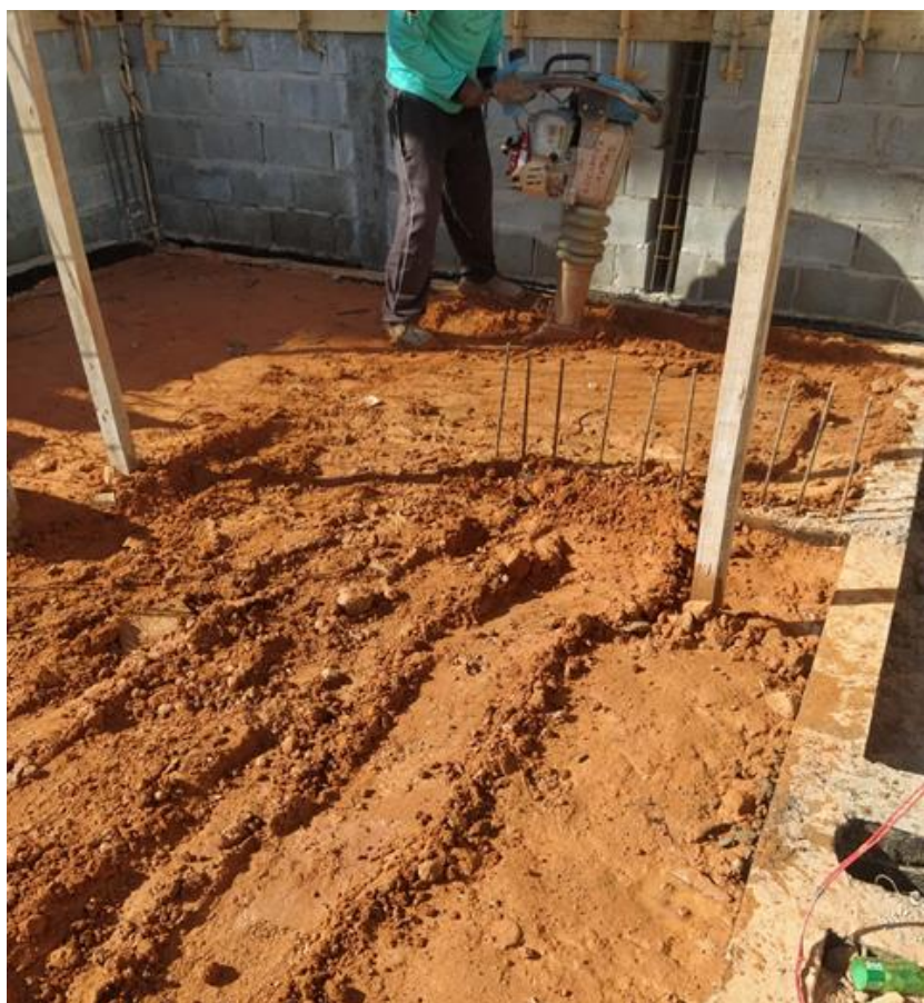
Figura 33: Compactação do solo antes da execução do contrapiso
