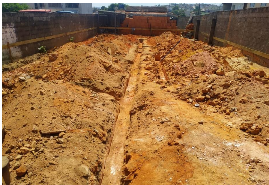
Figura 66: Locação da obra
