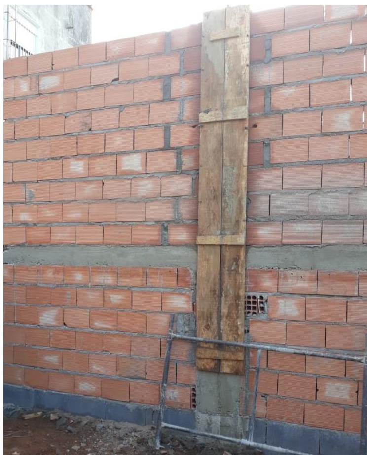
Figura 87: Forma de um pilar
