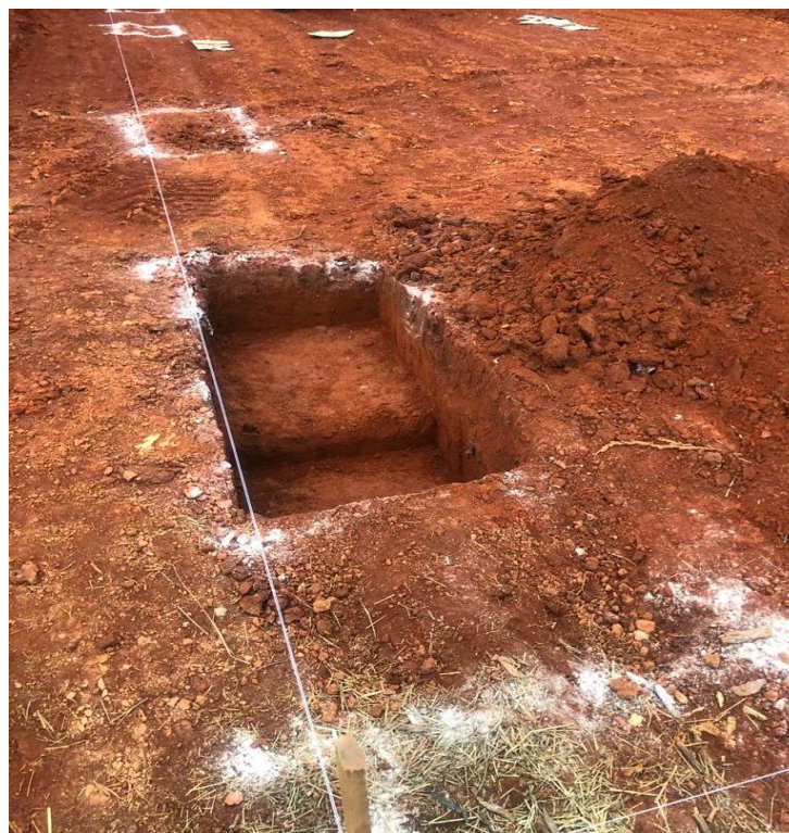
Figura 55: Escavação do terreno
