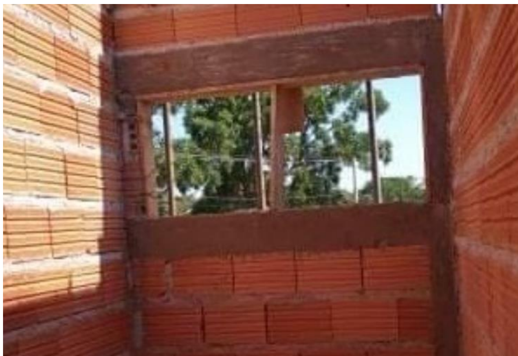
Figura 37: Esquema representando verga (superior) e contraverga (inferior)
