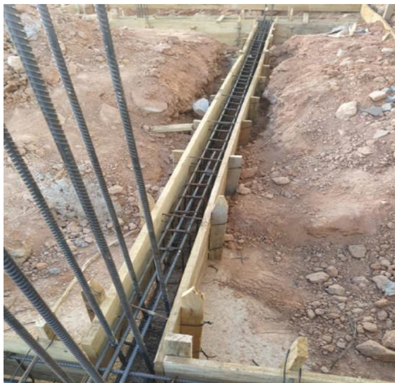
Figura 30: Forma de madeira utilizada para o fechamento da viga baldrame
