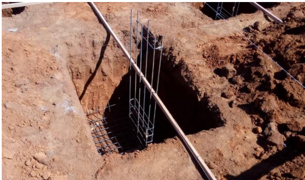
Figura 27: Armação da Sapata
