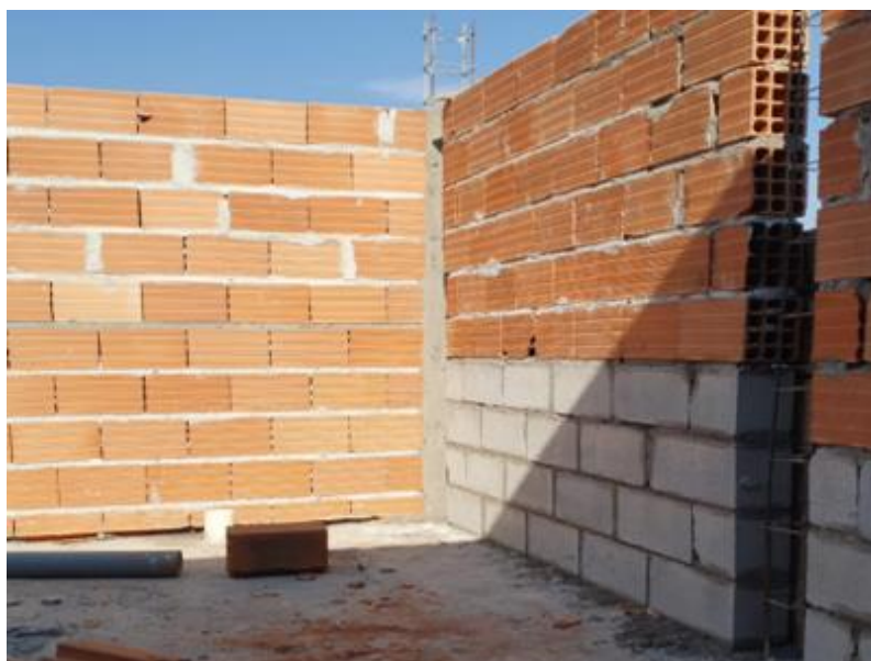
Figura 69: Alvenaria de vedação
