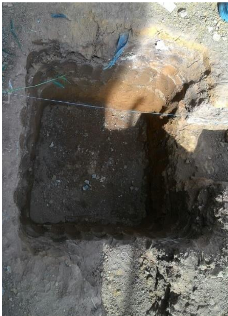
Figura 81: Vala para execução da sapata
