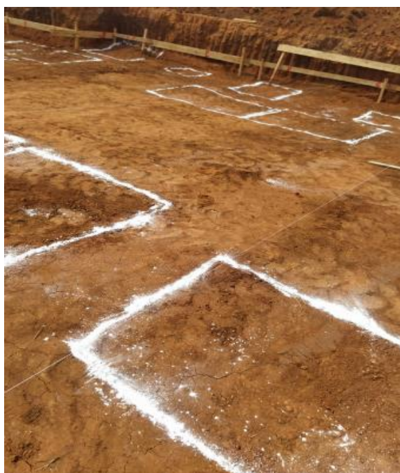
Figura 26: Marcação das sapatas no início da obra
