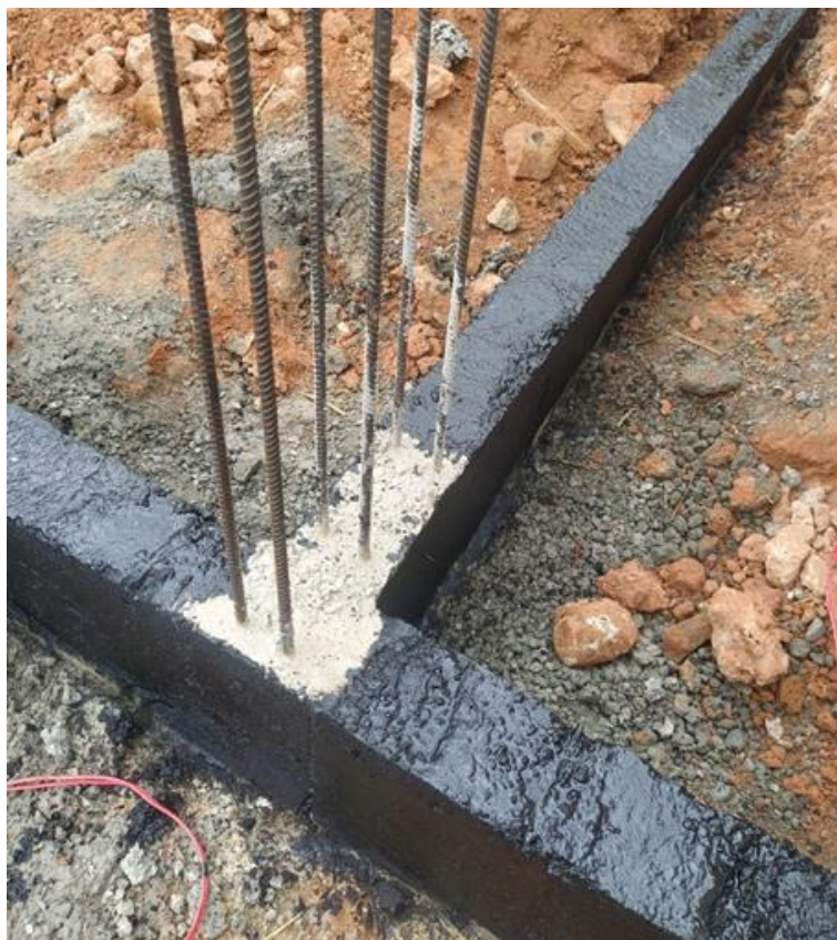
Figura 32: Impermeabilização da viga baldrame
