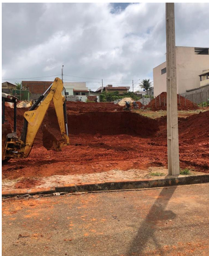
Figura 54: Preparação do terreno
