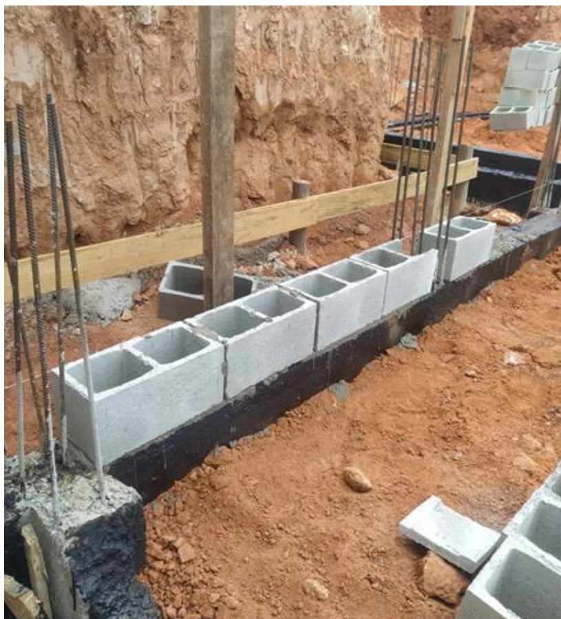
Figura 35: Marcação da primeira fiada utilizando bloco de cimento
