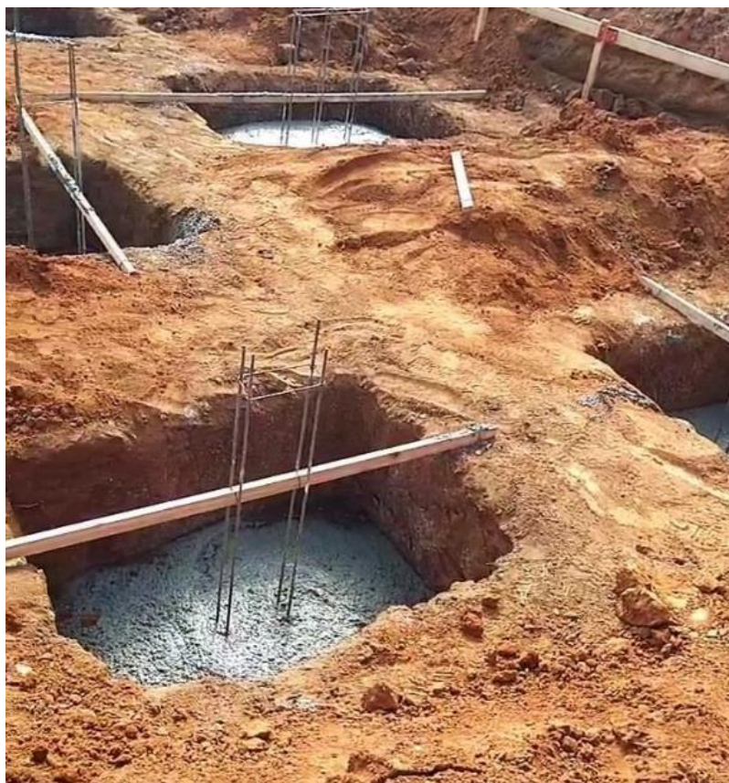
Figura 28: Concretagem da Sapata
