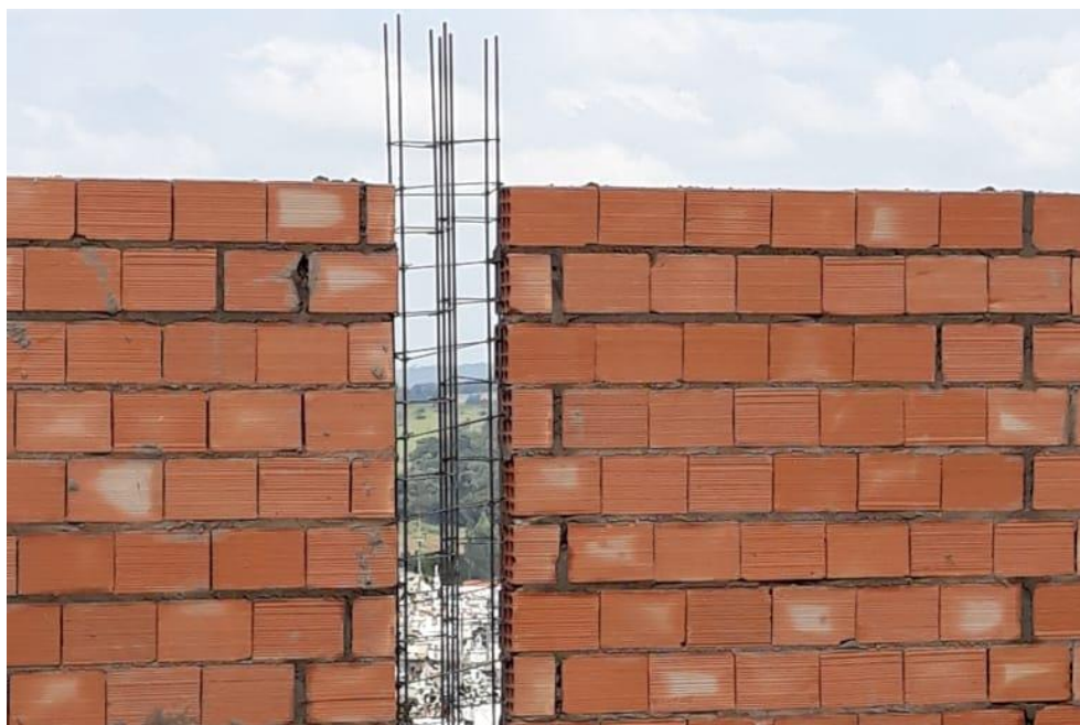
Figura 91: Alvenaria de vedação
