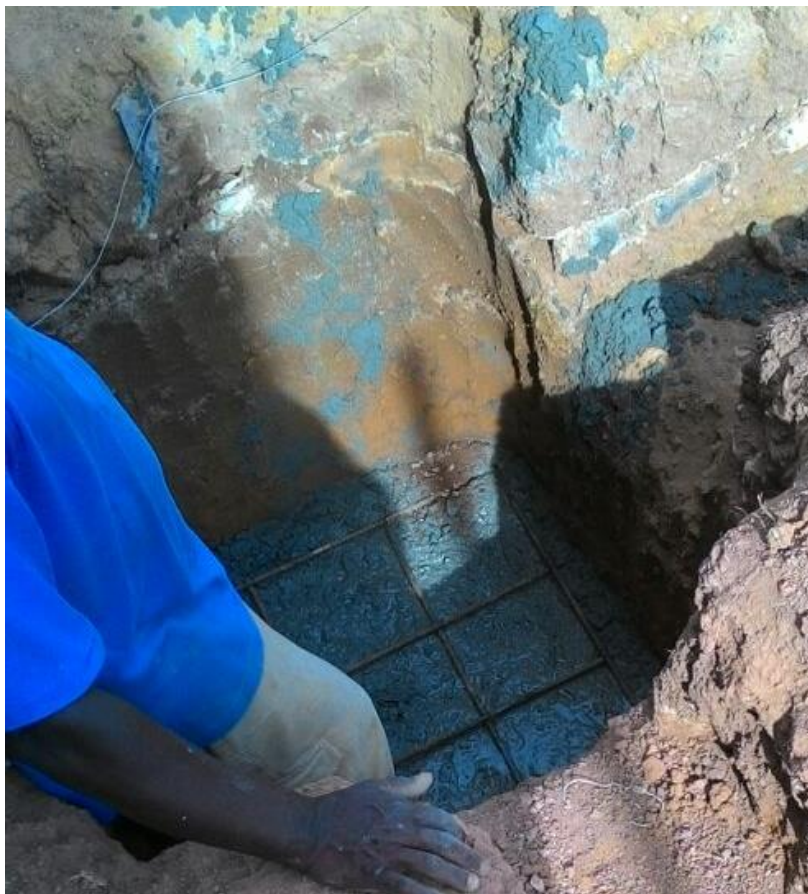
Figura 82: Concreto magro e armadura de fundo
