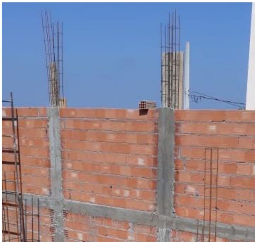
Figura 88: Desenforma dos pilares
