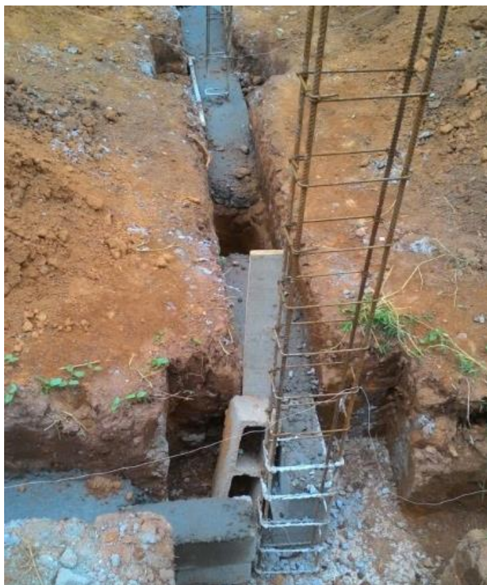
Figura 85: Vala para viga baldrame
