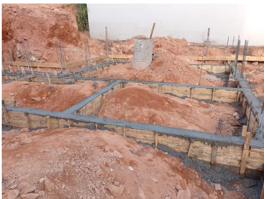
Figura 31: Viga baldrame concretada
