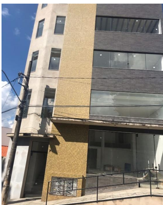
Figura 13: Fachada voltada para a rua A
