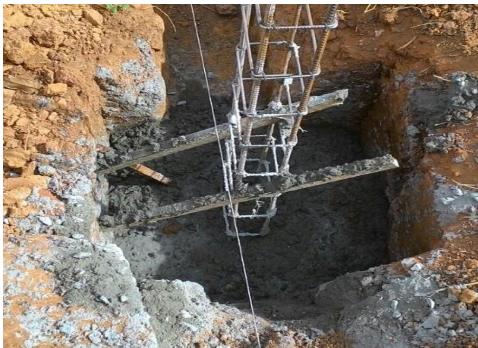
Figura 84: Concretagem da sapata
