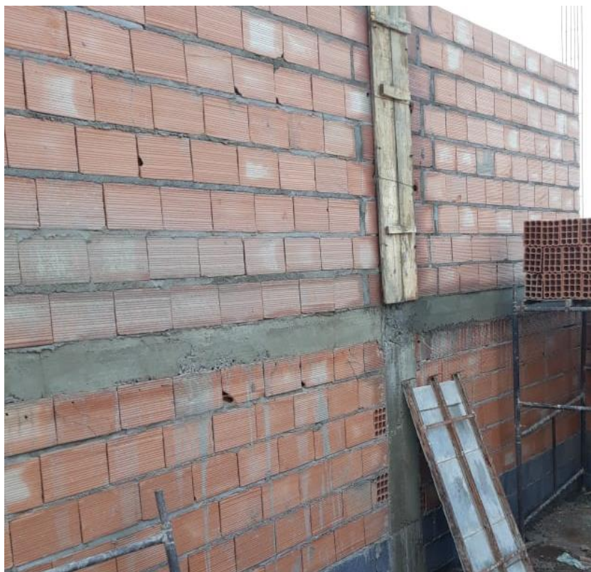
Figura 89: Alvenaria de vedação
