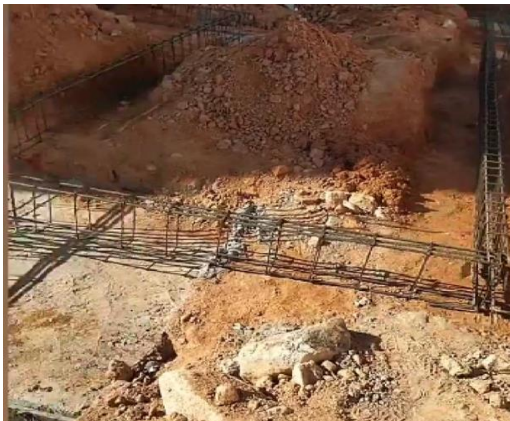
Figura 29: Armação viga baldrame
