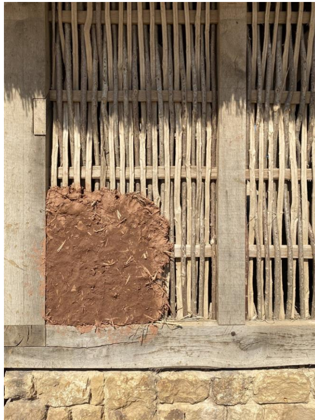
Imagem 09 – Método construtivo em pau a pique exposto pelo museu
