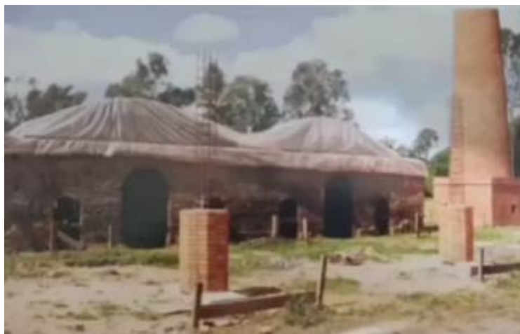
Imagem 23 – Início da construção dos pilares da nova edificação em tijolos no mesmo estilo das chaminés e em segundo plano os fornos protegidos por plásticos
