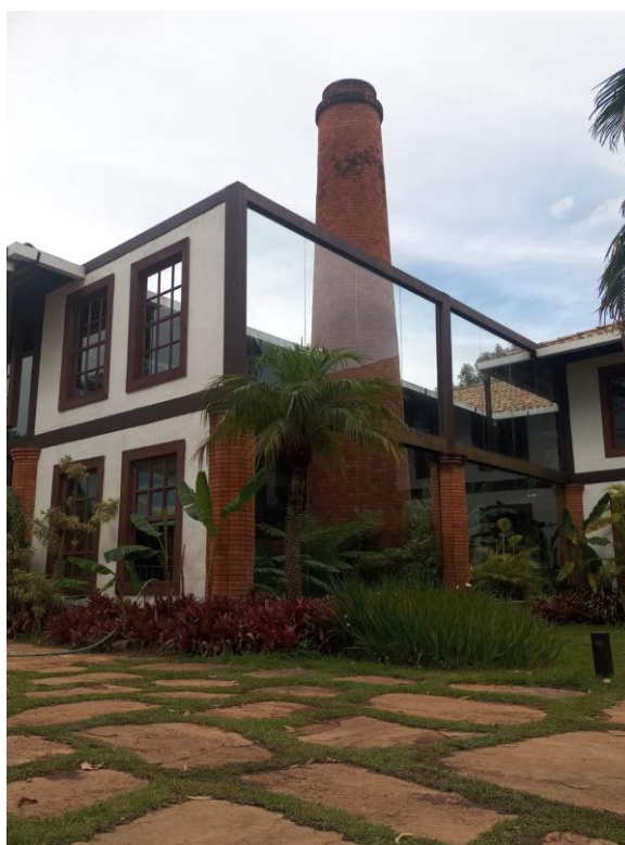
Imagem 27 – Relação do entorno das chaminés mesclando paredes de alvenaria com paredes em pele de vidro sustentadas por barras de ferro
