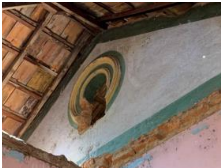
Imagem 34 – Óculo acima da empana na alvenaria que divide os cômodos
