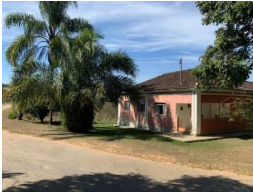
Imagem 35 – Edificação típica do povoado
