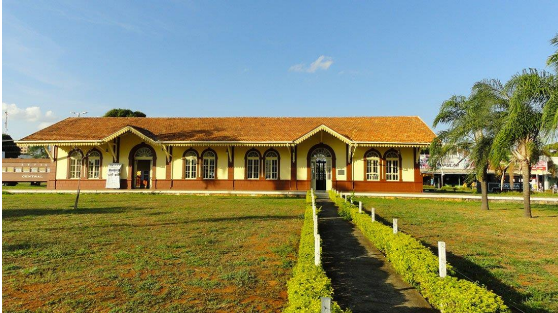
Imagem 31 – Fachada lateral da estação
