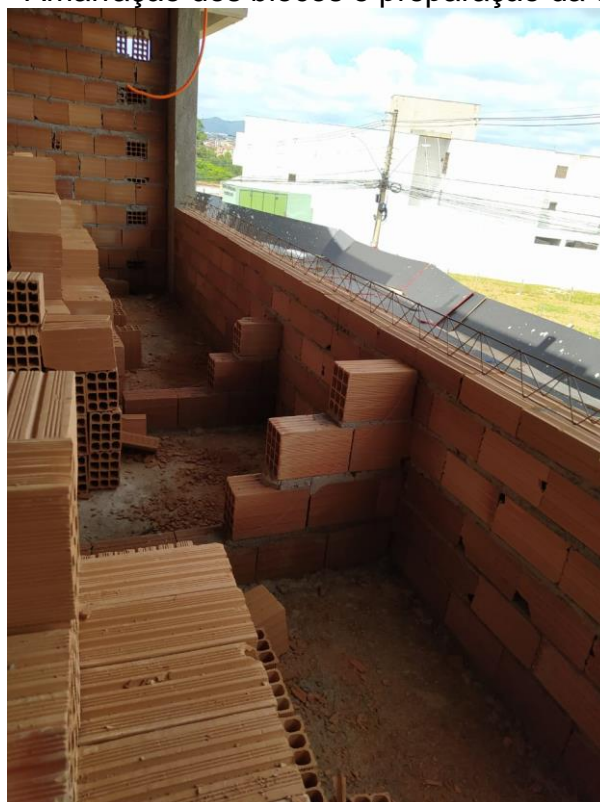
Figura 16 – Amarração dos blocos e preparação da contraverga
