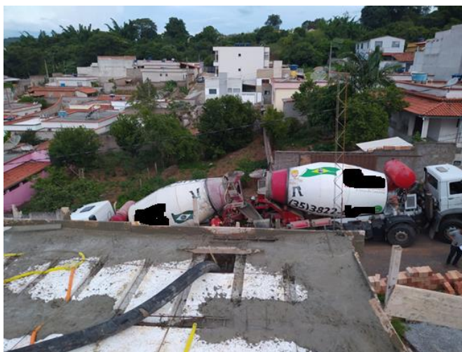
Figura 55 – Enchimento da laje de isopor
