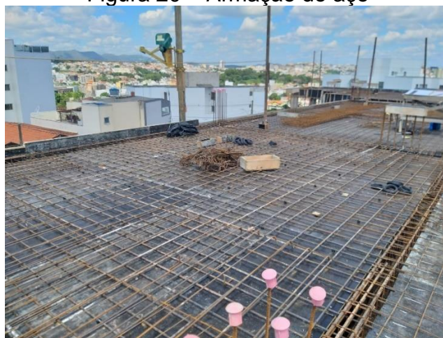
Figura 20 – Armação do aço
