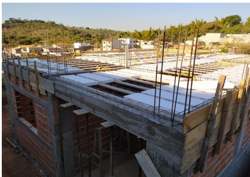
Figura 54 – Montagem da laje com isopor
