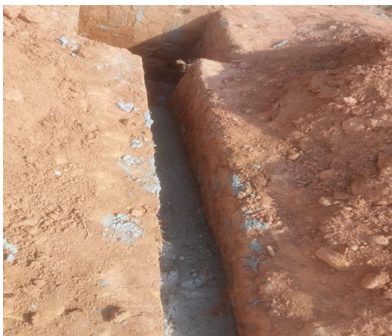
Figura 46 – Escavação dos furos da sapata
