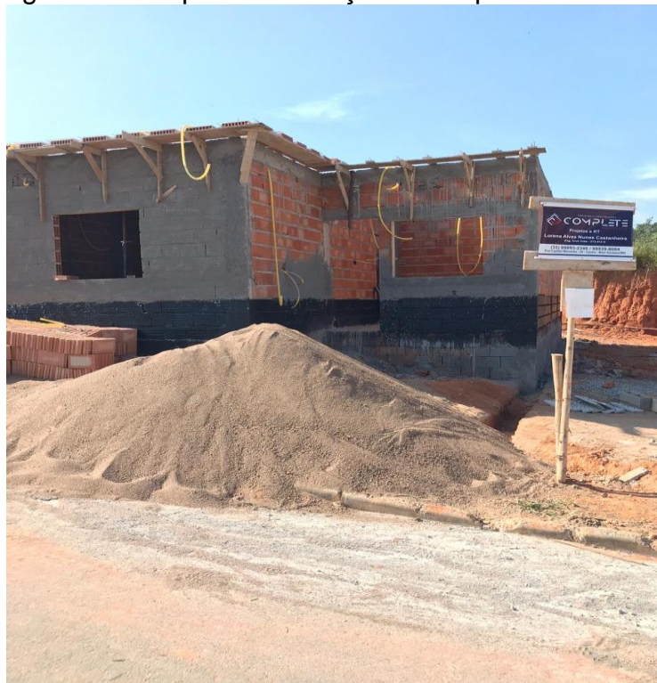
Figura 49 – Impermeabilização das 3 primeiras fiadas
