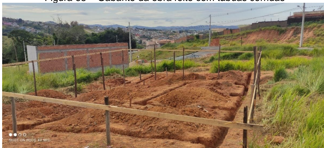
Figura 68 – Gabarito da obra feito com tábuas corridas
