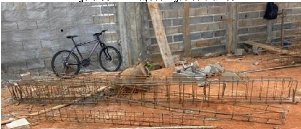
Figura 30 – Armações vigas baldrames
