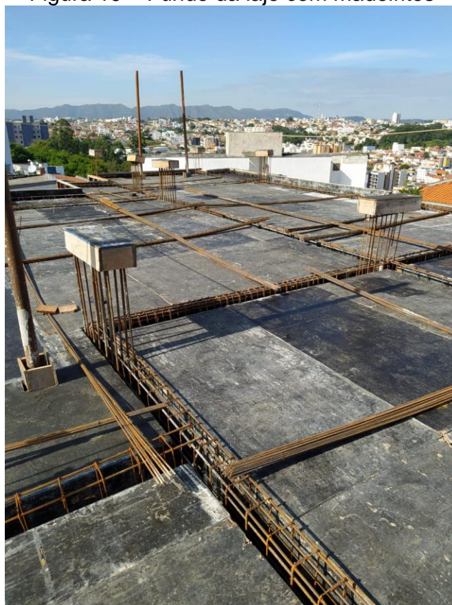
Figura 19 – Fundo da laje com madeirites
