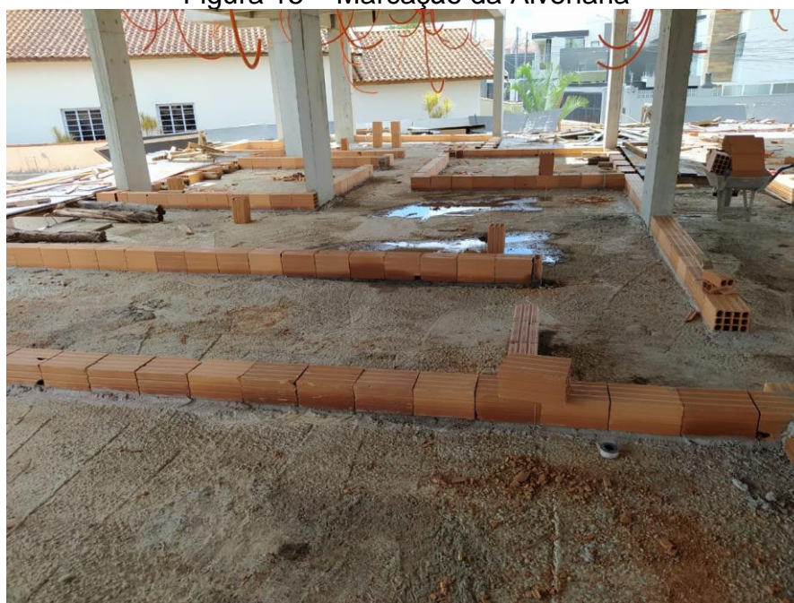
Figura 15 – Marcação da Alvenaria
