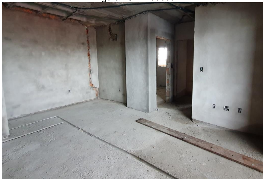
Figura 75 – Reboco
