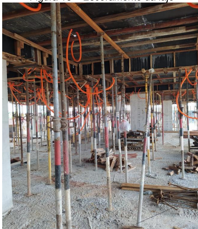
Figura 18 – Escoramento da laje
