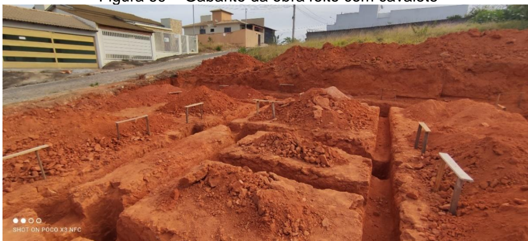
Figura 69 – Gabarito da obra feito com cavalete
