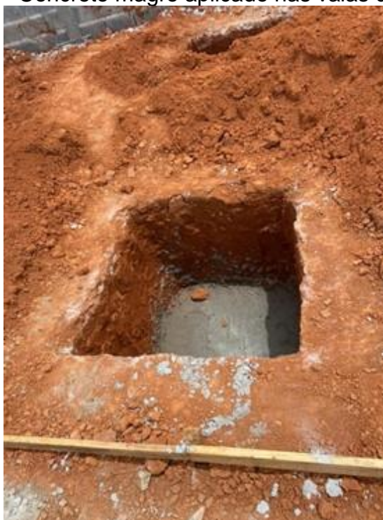
Figura 27 – Concreto magro aplicado nas valas das sapatas
