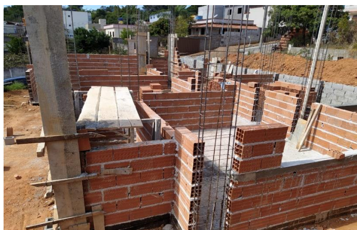
Figura 51 – Posicionamento de ferragens para os pilares
