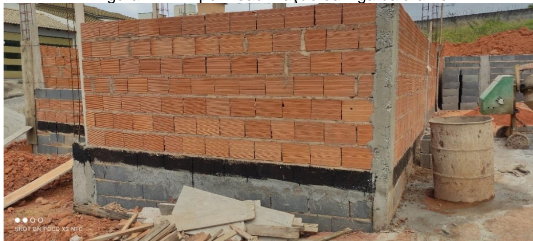
Figura 72 – Impermeabilização da viga baldrame
