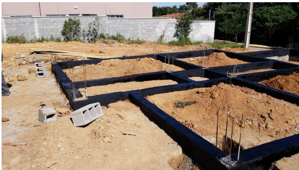
Figura 48 – Vigas Baldrame já impermeabilizadas
