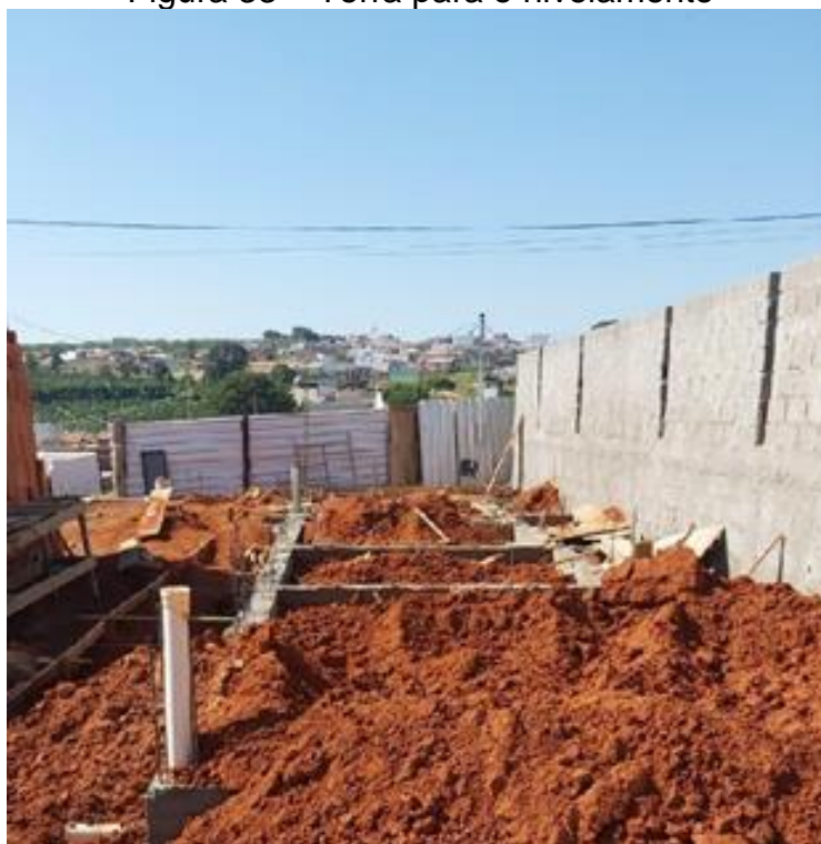
Figura 33 – Terra para o nivelamento
