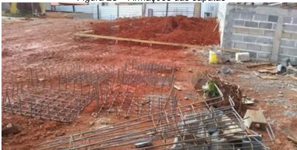
Figura 28 – Armações das sapatas
