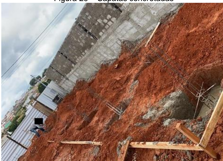
Figura 29 – Sapatas concretadas
