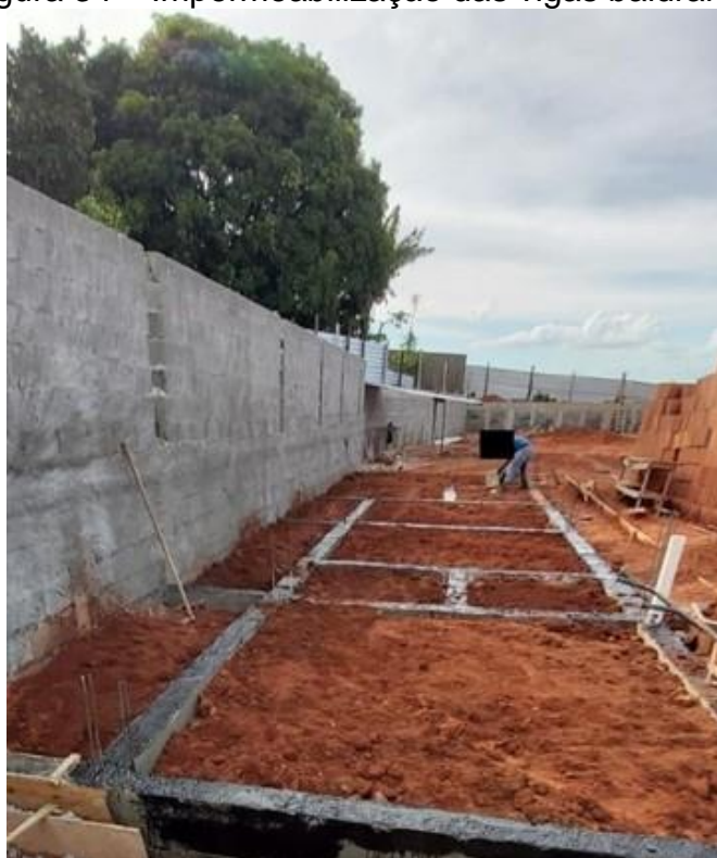
Figura 34 – Impermeabilização das vigas baldrame
