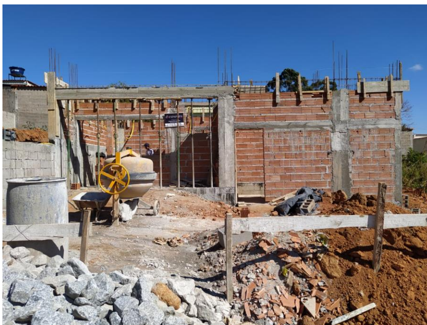
Figura 52 – Pilares já prontos
