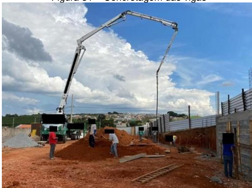
Figura 31 – Concretagem das vigas
