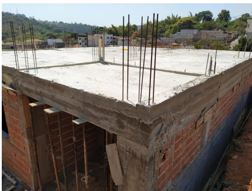
Figura 57 – Conclusão da concretagem da laje
