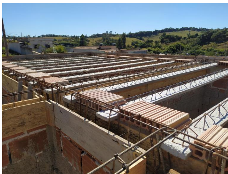
Figura 60 – Momento inicial de montagem da laje
