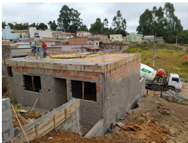
Figura 61 – Momento da alocação do concreto na laje
