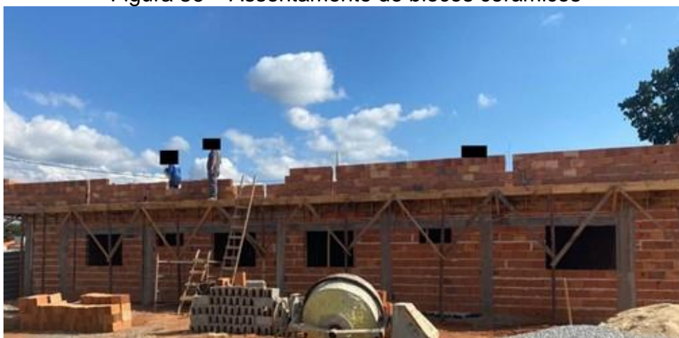
Figura 36 – Assentamento de blocos cerâmicos
