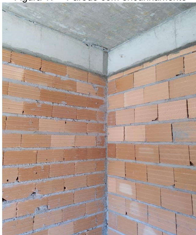
Figura 17 – Parede com encunhamento
