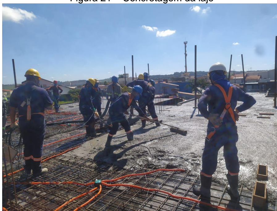
Figura 21 – Concretagem da laje
