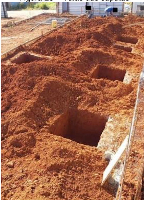
Figura 26 – Valas das sapatas
