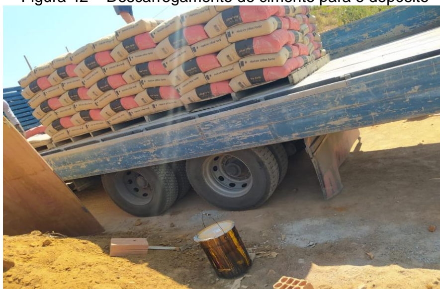
Figura 42 – Descarregamento do cimento para o depósito
