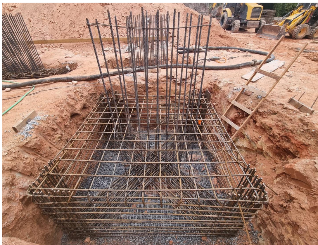
Figura 40: Armação do bloco de fundação.
