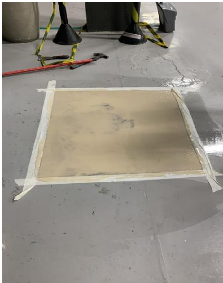
Figura 8: Mistura de catalisador, primer e pó de quartzo.
