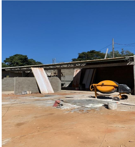
Figura 17: Emboço da parede das baias de materiais da fábrica de blocos.
