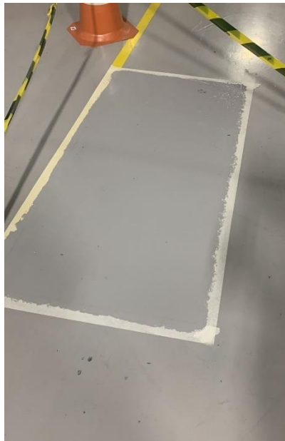
Figura 11: Epóxi aplicado ao chão em seu processo de cura
