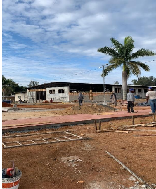
Figura 22: Marcenaria em execução.
