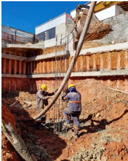
Figura 36: Armação sendo inserida.
