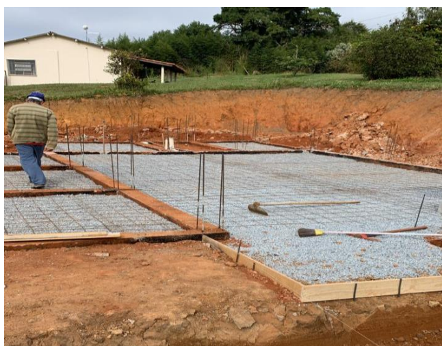
Figura 27: Malha traçada com brita na superfície.
