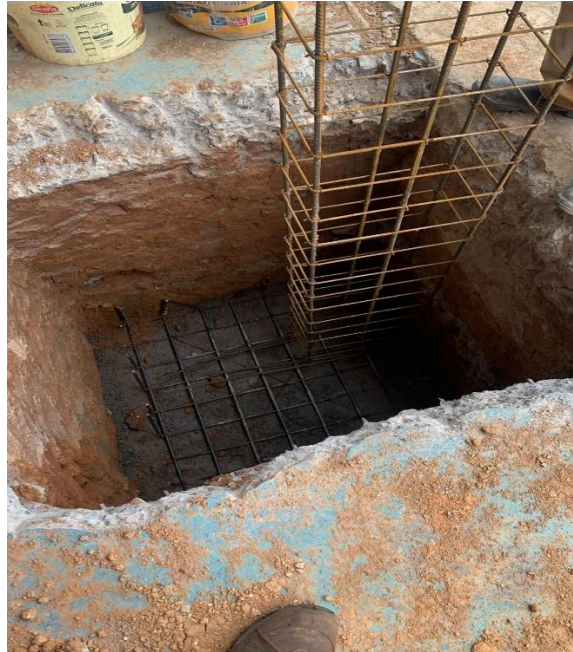
Figura 30: Gradil posicionado na fundação escavada.
