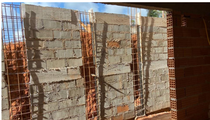
Figura 67: Vigas intermediárias e de travamento.
