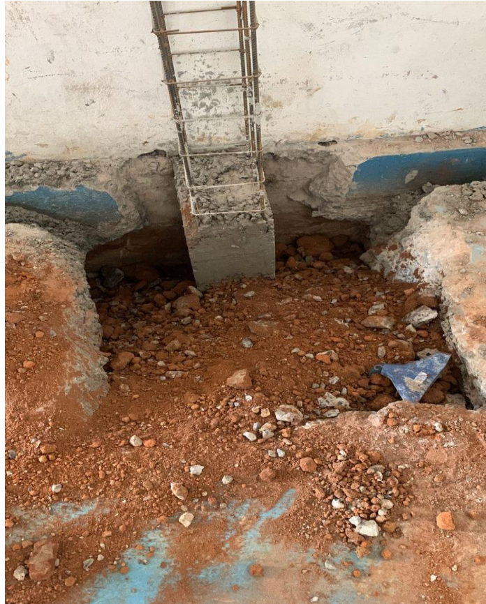
Figura 31: Sapata coberta com terra pós concretagem.
