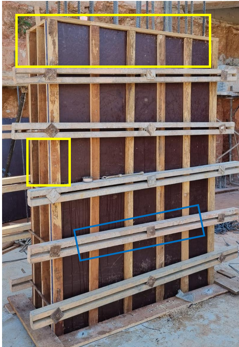
Figura 48: Montantes e gravatas.
