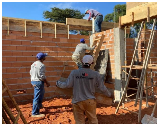
Figura 72: Colocação das formas no lugar adequado
