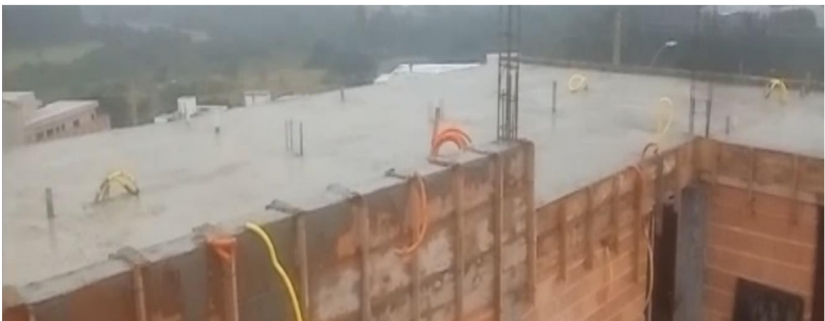
Figura 75: Laje após a concretagem
