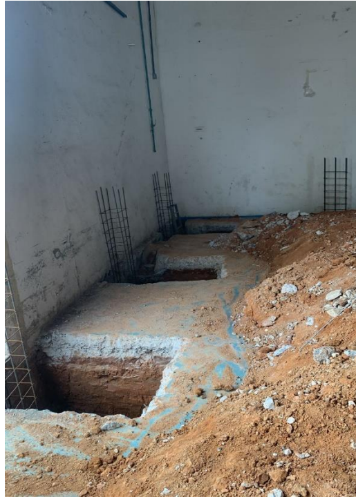
Figura 29: Sapatas escavadas e posicionadas com pilar de arranque.
