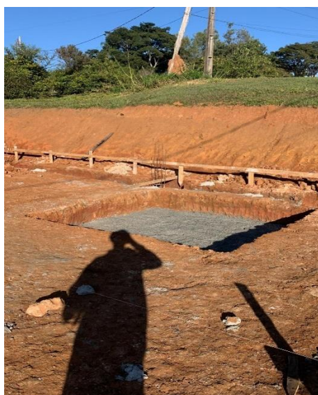
Figura 25: Locação e posicionamento das vigas baldrames.
