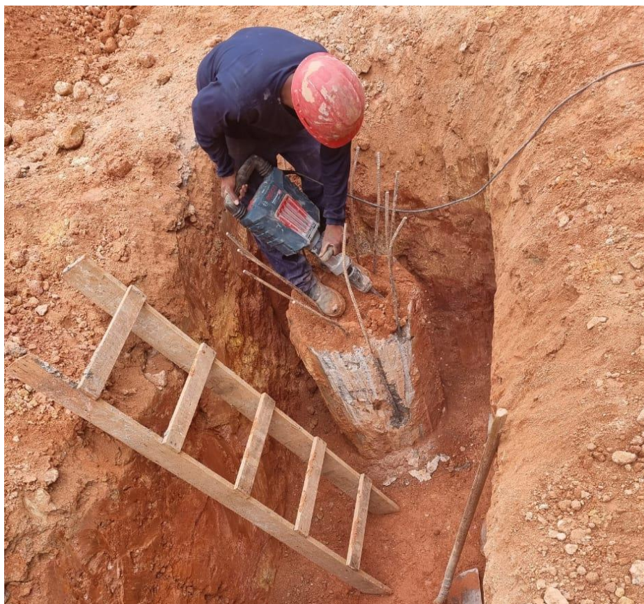
Figura 39: Arrasamento das estacas.
