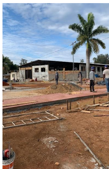
Figura 1: Execução de obra da Marcenaria FADMINAS
