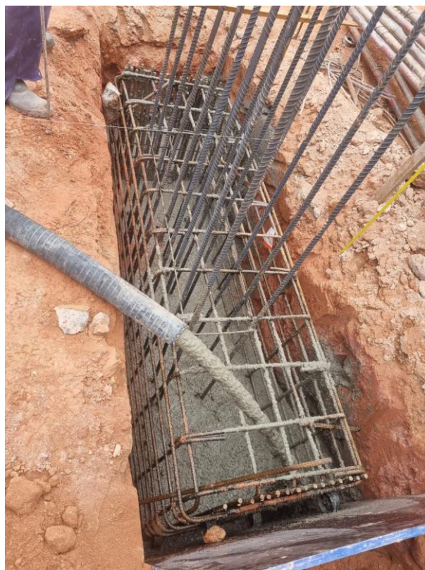
Figura 42: Concretagem do bloco.
