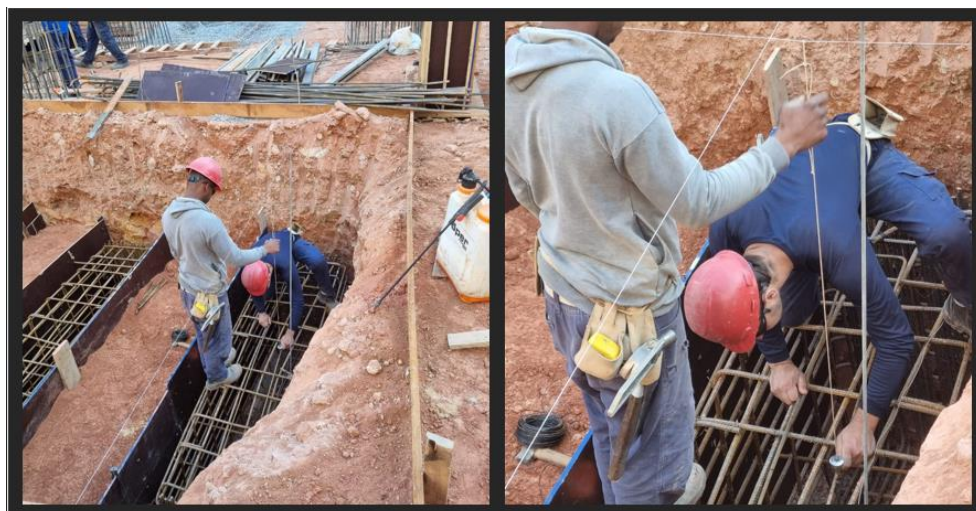
Figura 41: Locação dos arranques.
