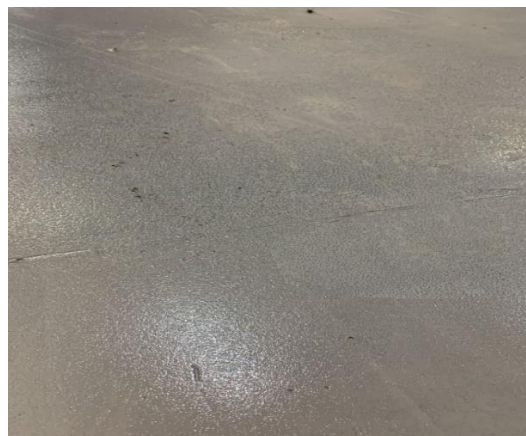
Figura 13: Bolhas de ar devido a umidade e chuva.
