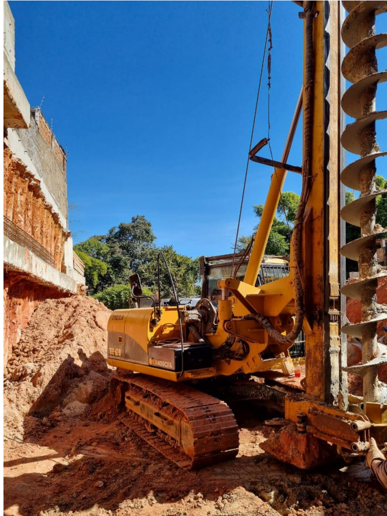
Figura 34: Representação do equipamento utilizado na perfuração do solo.
