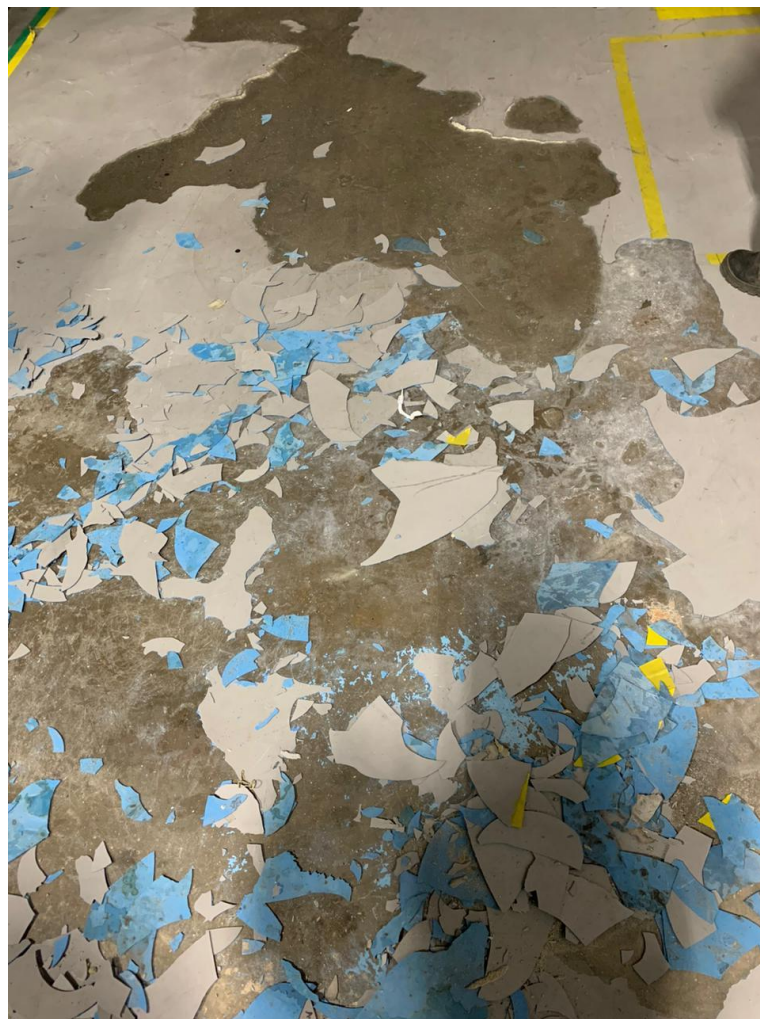
Figura 4: Corte e retirada epóxi.
