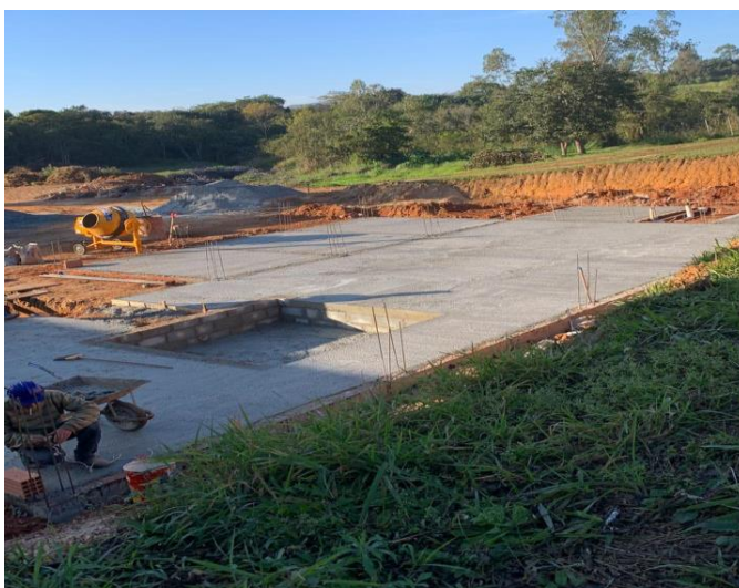
Figura 28: Radier concretado.
