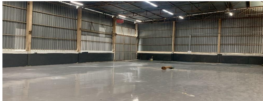
Figura 12: Epóxi aplicado em toda extensão do galpão da LEAR.
