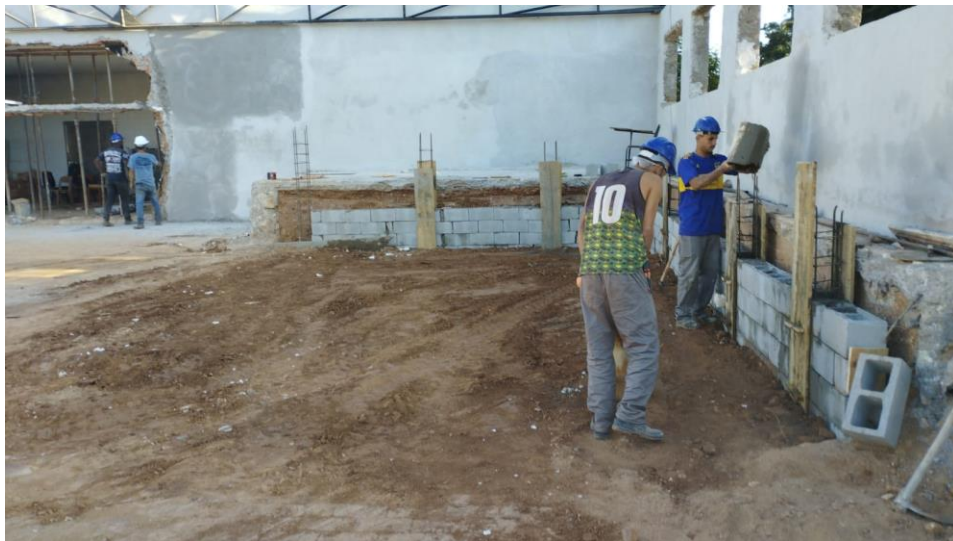
Figura 19: Muro de arrimo para posterior muro de eps.
