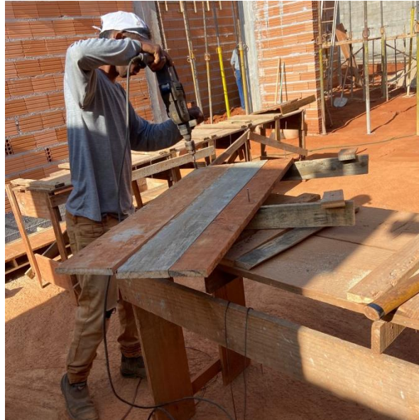
Figura 70: Montagem das fôrmas
