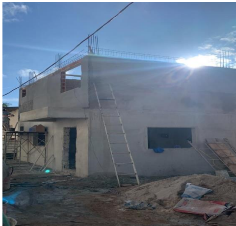
Figura 18: Casa/caixa d'água rebocada
