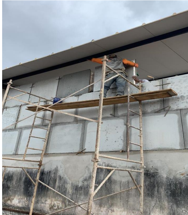
Figura 21: Fixação de alvenaria EPS.
