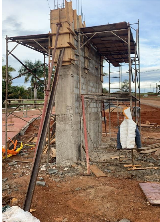
Figura 15: Começo do emboço parte inferior do letreiro.
