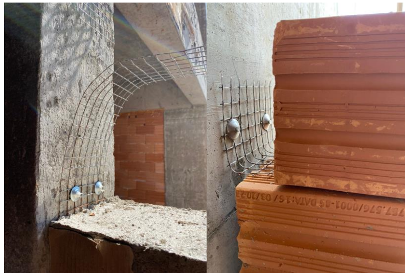
Figura 27 – Fixação da tela entre alvenaria e pilar
