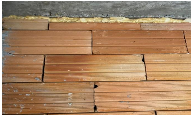
Figura 29 – Encunhamento realizado com a espuma expansiva
