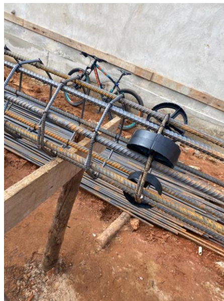
Figura 8 – Uso dos espaçadores
