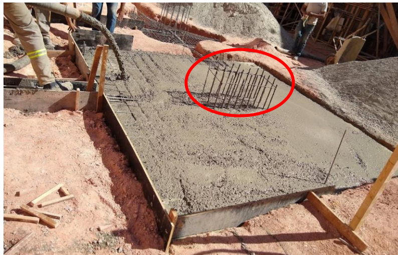
Figura 62 – Armadura de espera de pilar
