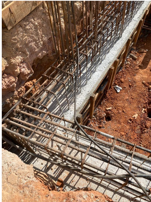
Figura 16 – Vigas concretadas
