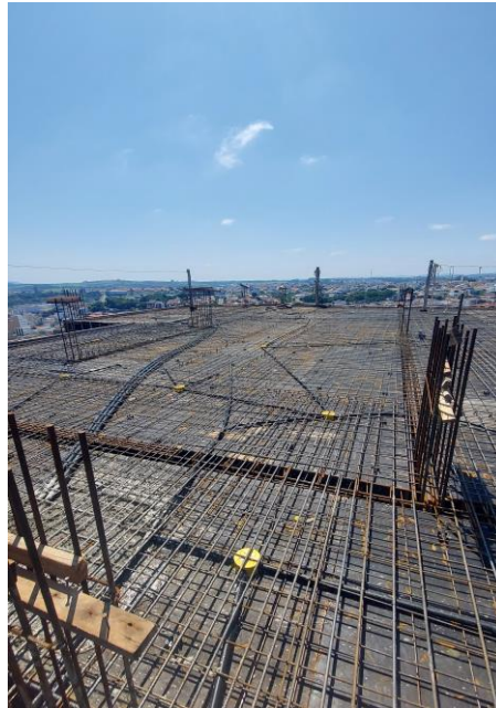
Figura 40 – Armaduras colocadas conforme projeto
