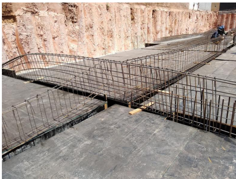
Figura 71 – Posicionamento de armaduras de vigas
