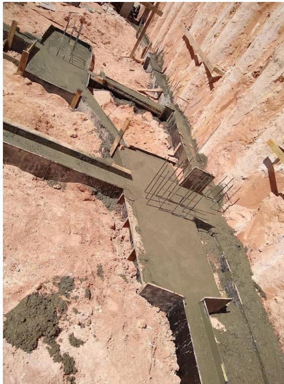
Figura 61 – Blocos de coroamento e vigas baldrame concretados
