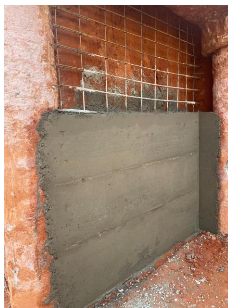
Figura 19 – Cortina concretada
