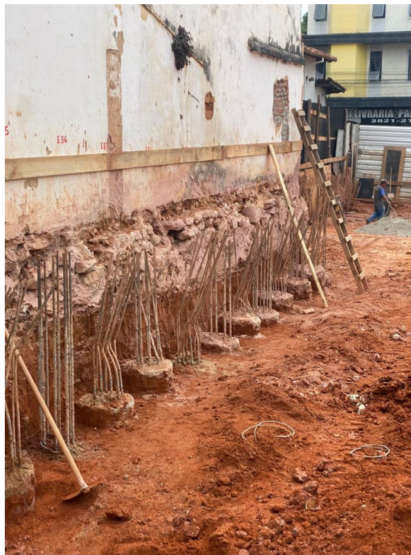
Figura 11 – Estacas já concretadas
