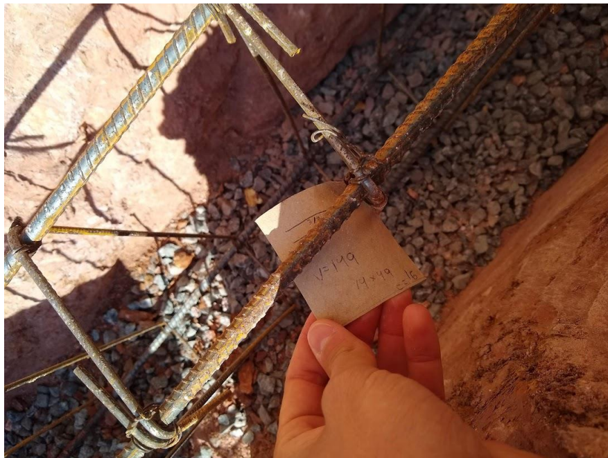
Figura 60 – Viga baldrame em fase de execução
