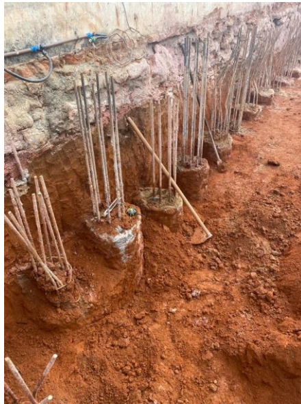
Figura 12 – Limpeza entre as estacas
