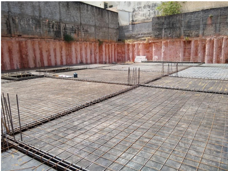
Figura 72 – Armação positiva de laje
