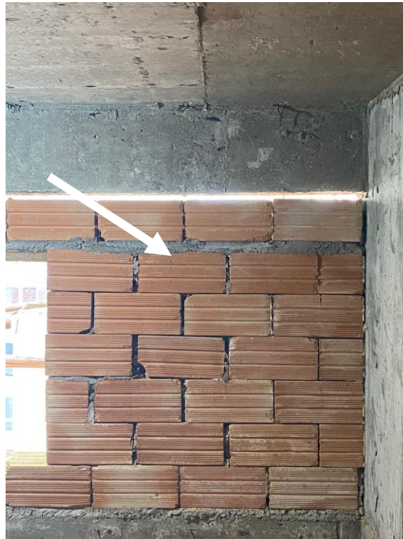
Figura 28 – Vão entre alvenaria e viga que receberá encunhamento
