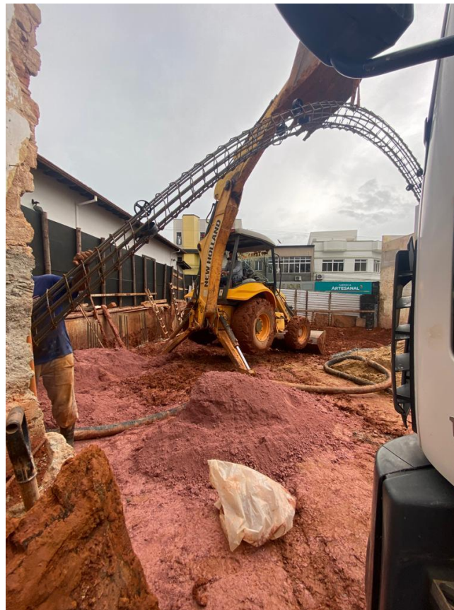
Figura 10 – Içamento da armadura da estaca
