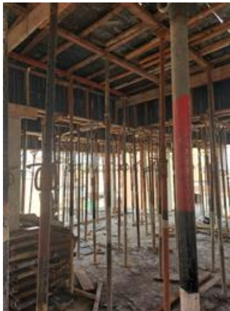
Figura 38 – Escoras posicionadas conforme projeto
