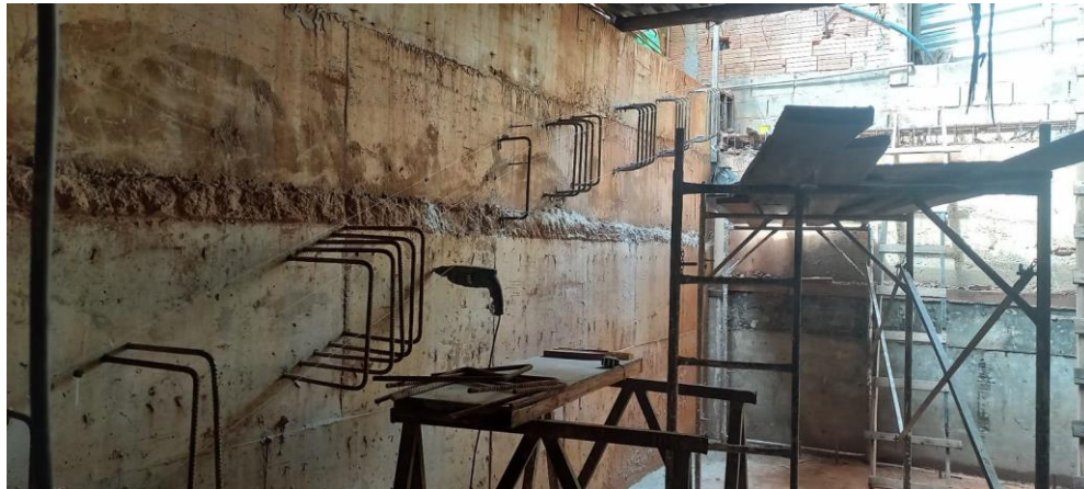
Figura 90 – Execução de viga de borda inclinada
