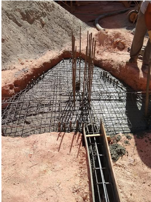
Figura 59 – Bloco de coroamento em concretagem
