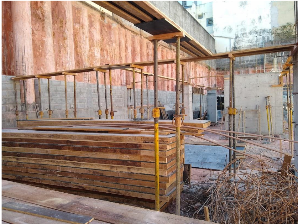
Figura 67 – Formas de fundo de vigas e escoramentos
