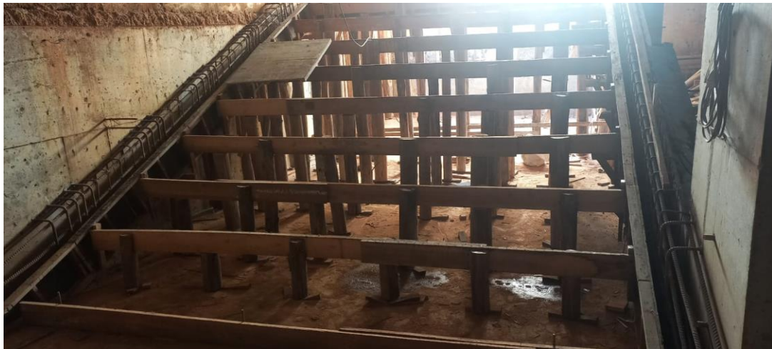
Figura 97 – Execução da forma
