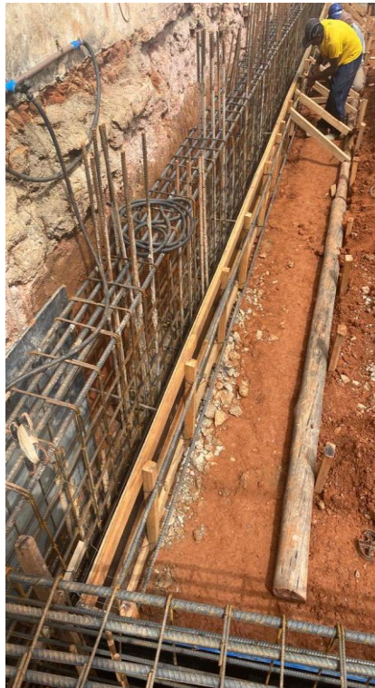
Figura 15 – Montagem das formas
