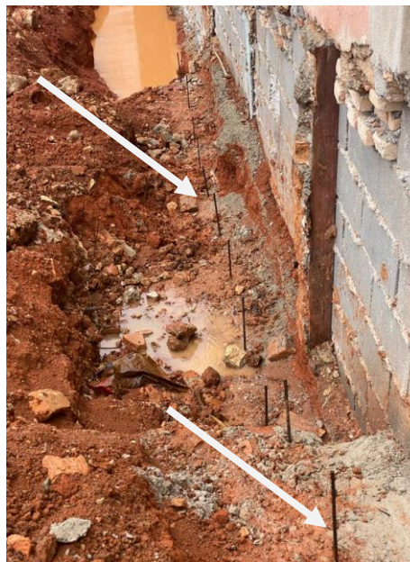
Figura 6 – Locação das estacas da cortina de contenção
