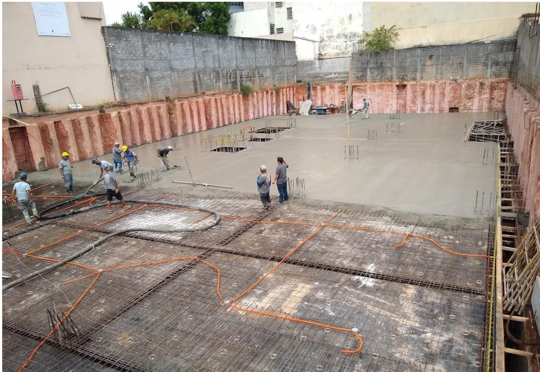
Figura 76 – Concretagem de vigas e laje
