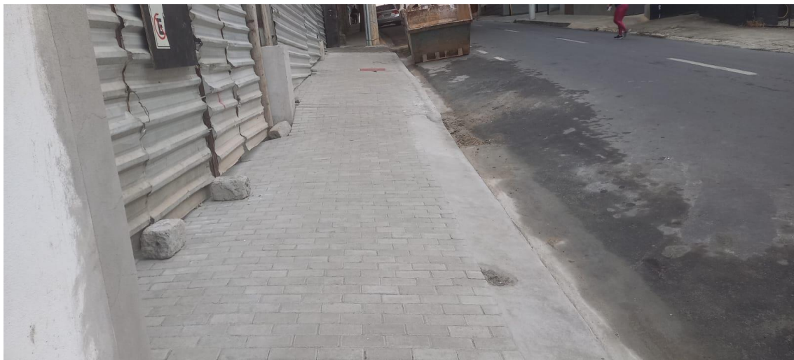
Figura 105 – Piso intertravado finalizado
