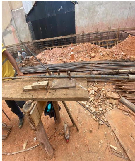
Figura 7 – Armação das estacas
