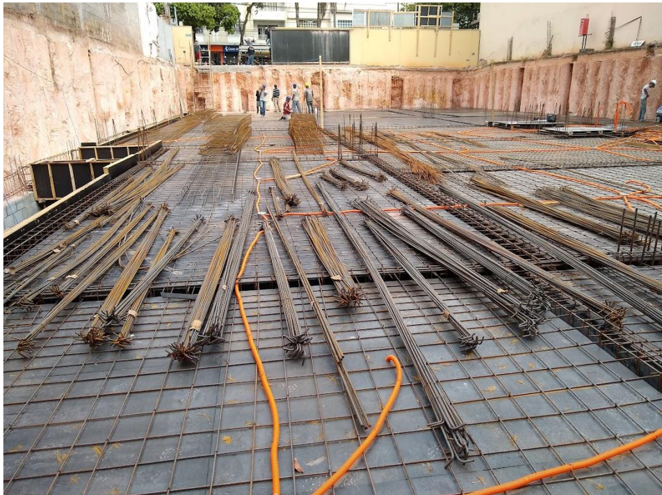
Figura 74 – Barras de aço para armação negativa de laje
