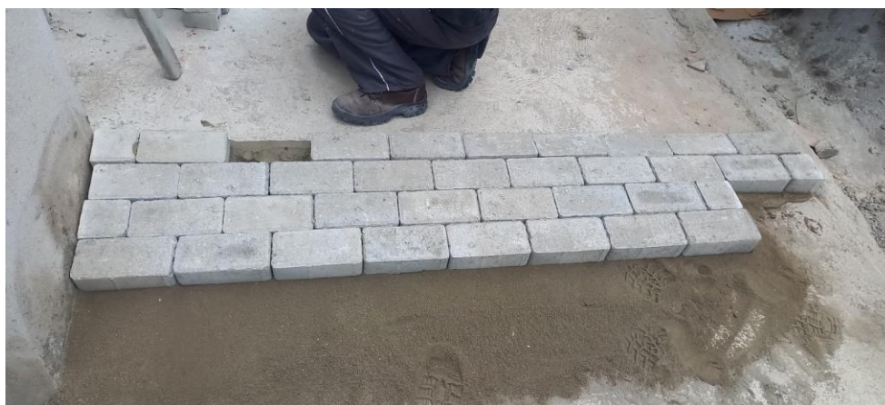
Figura 104 – Execução do piso
