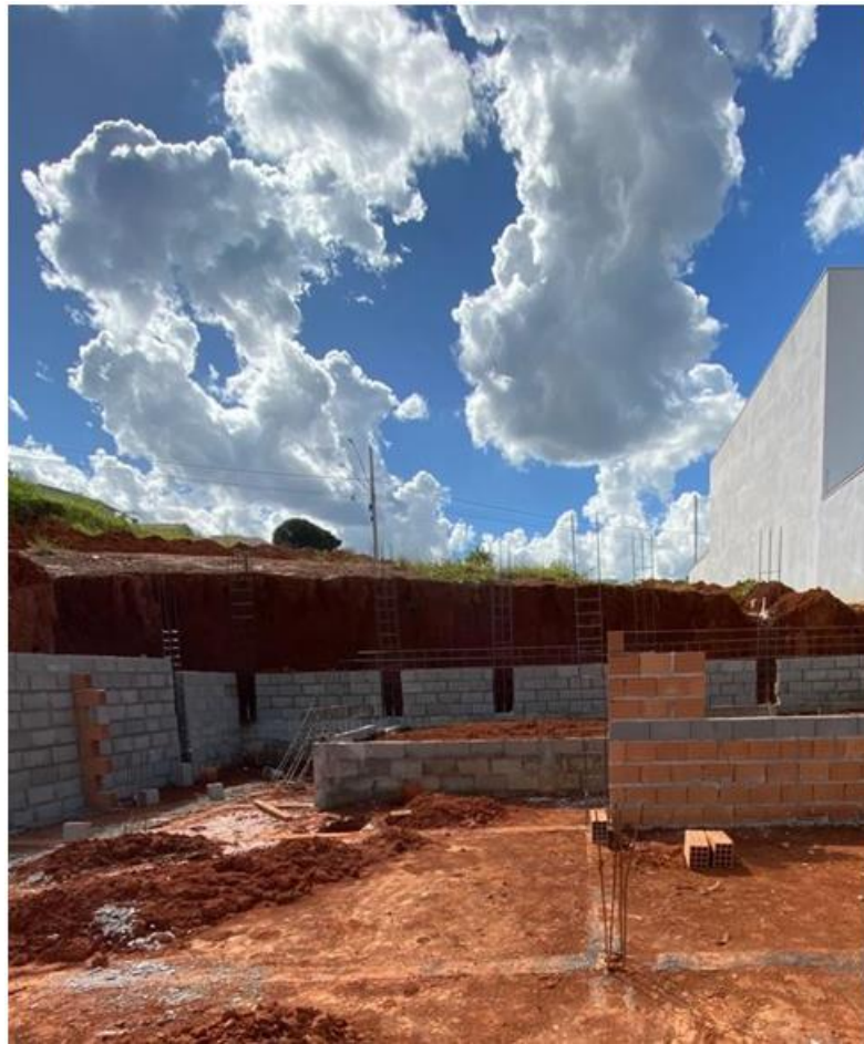
Figura 54 – Diferença de nível entre os terrenos
