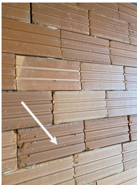
Figura 24 – Alvenaria finalizada com argamassa polimérica
