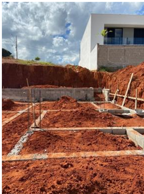
Figura 52 – Etapa de fundação
