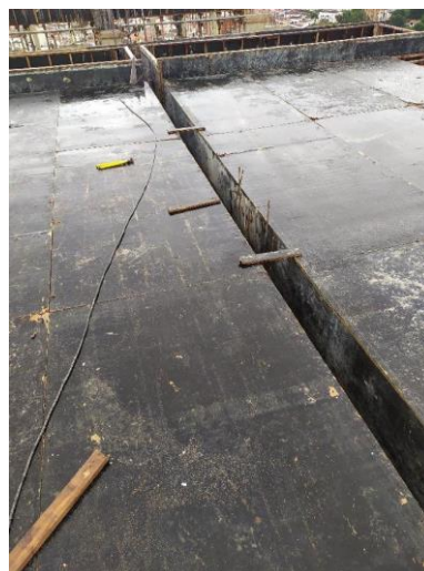
Figura 37 – Montagem das fôrmas das lajes e vigas
