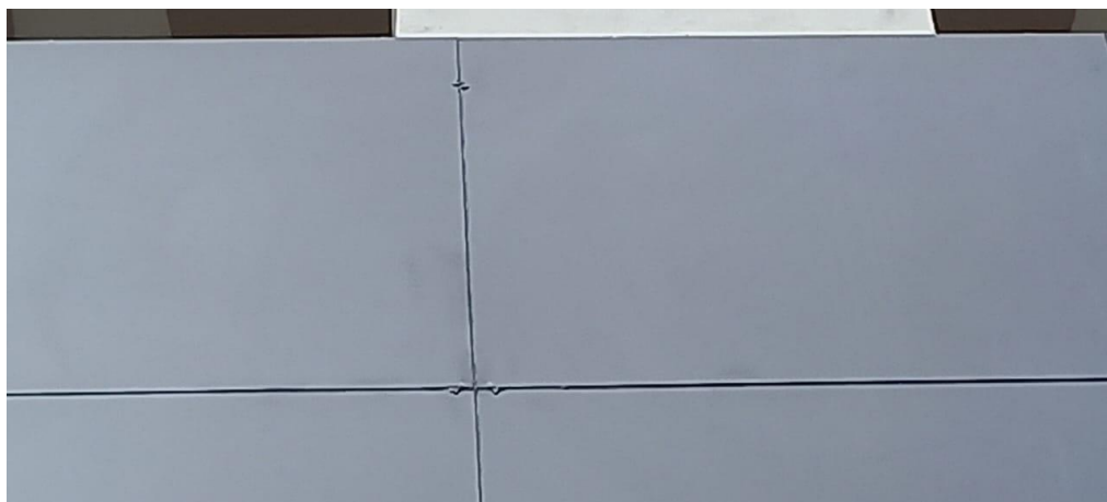
Figura 87 – Revestimento com insert tipo H
