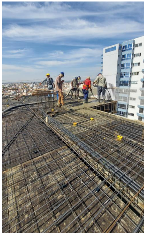
Figura 42 – Lançamento do concreto
