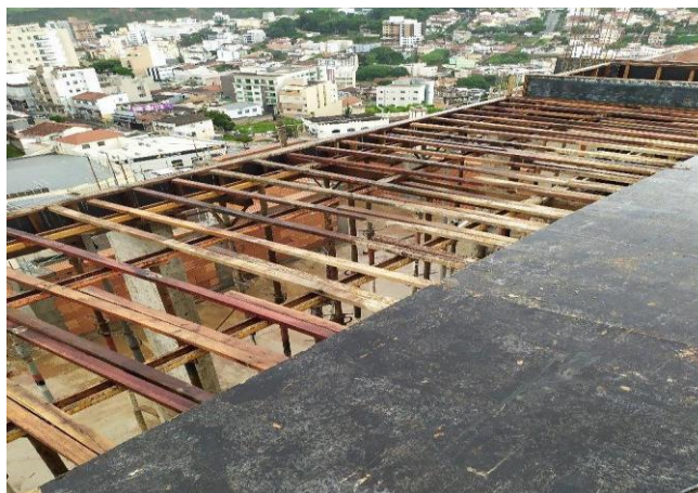
Figura 35 – Materiais usados na montagem das formas
