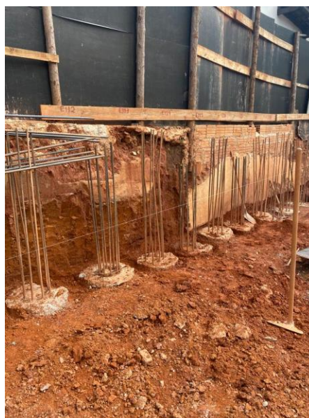
Figura 13 – Alinhamento para vigas
