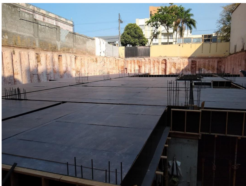
Figura 70 – Fechamento de formas da laje
