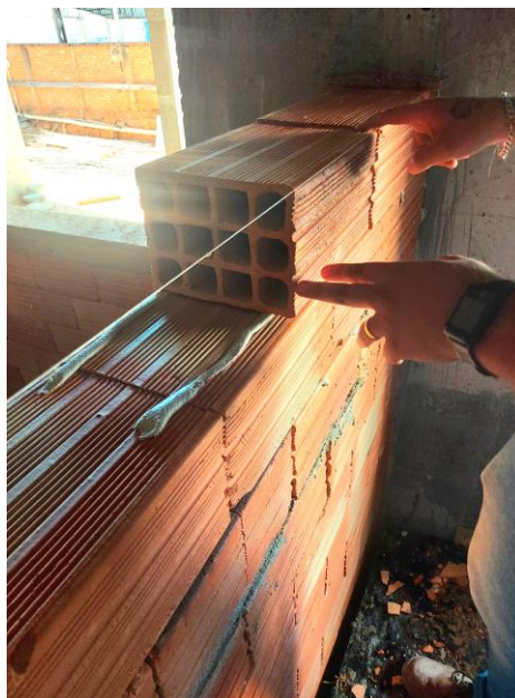
Figura 23 – Execução da argamassa polimérica
