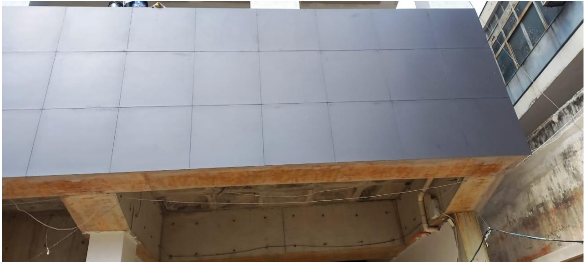
Figura 88 – Demonstração do revestimento finalizado
