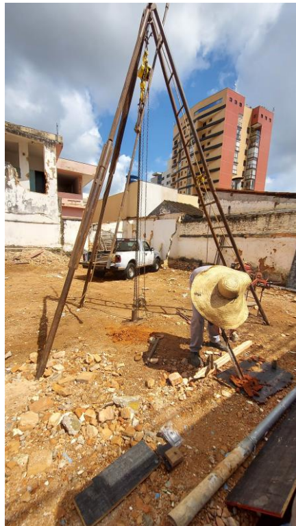
Figura 4 – Execução da sondagem
