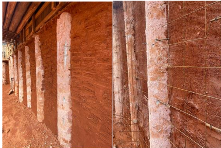
Figura 18 – Limpeza entre estacas e instalação das malhas de ferro
