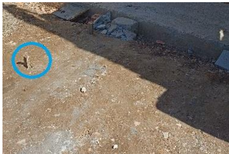
Figura 102 – Piquete usado para nivelar o solo
