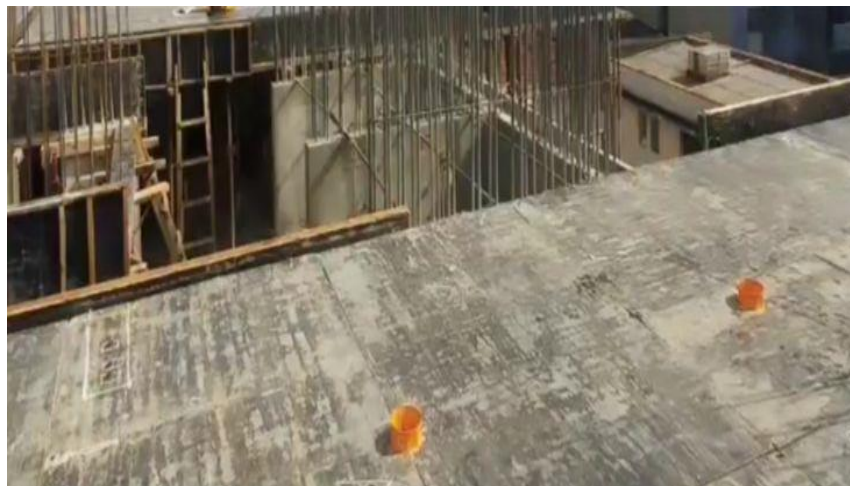
Figura 39 – Passagens elétricas na laje maciça
