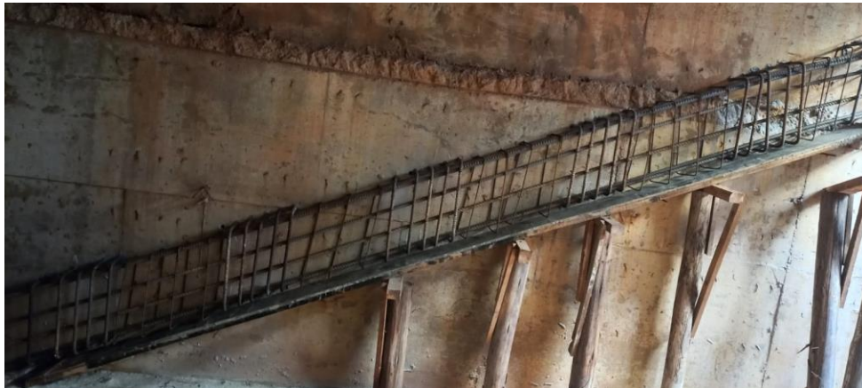
Figura 92 – Armadura de borda inclinada finalizada
