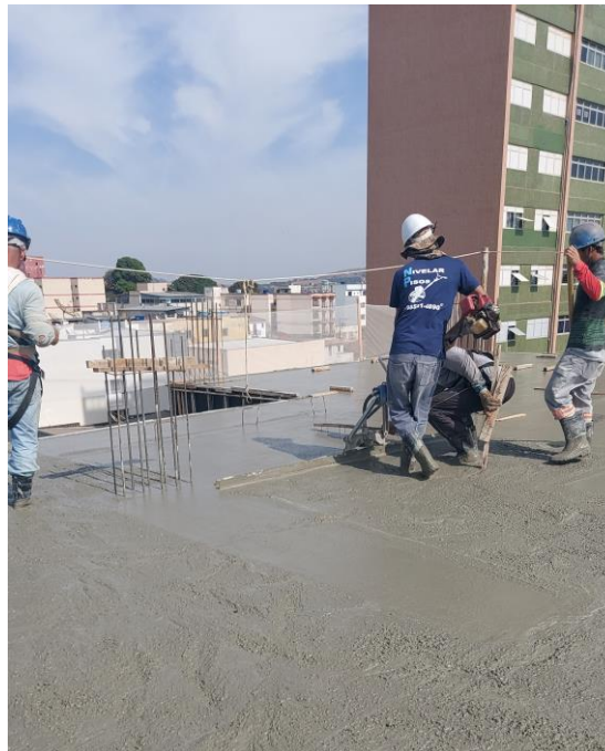
Figura 43 – Nivelamento elétrico da laje
