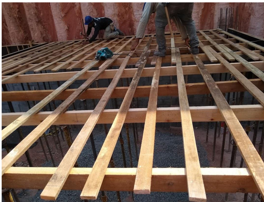
Figura 69 – Estrutura de suporte de formas e escoramentos
