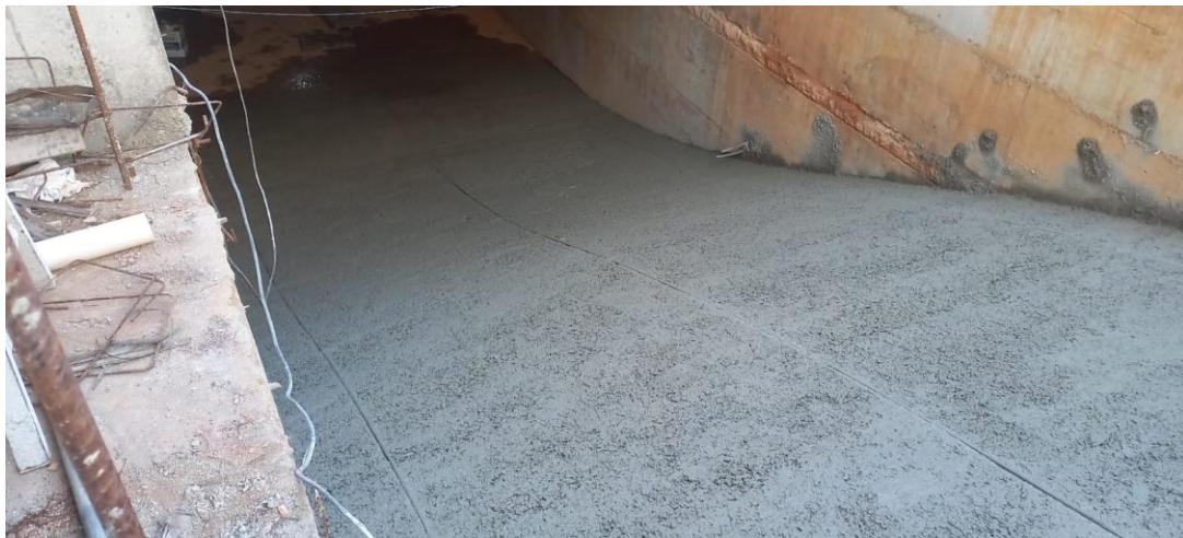
Figura 99 – Rampa concretada
