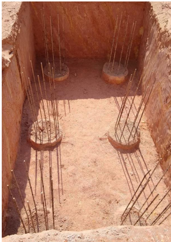
Figura 57 – Bloco de coroamento em fase de execução
