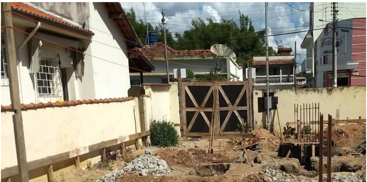
Figura 9 – Locação da obra
