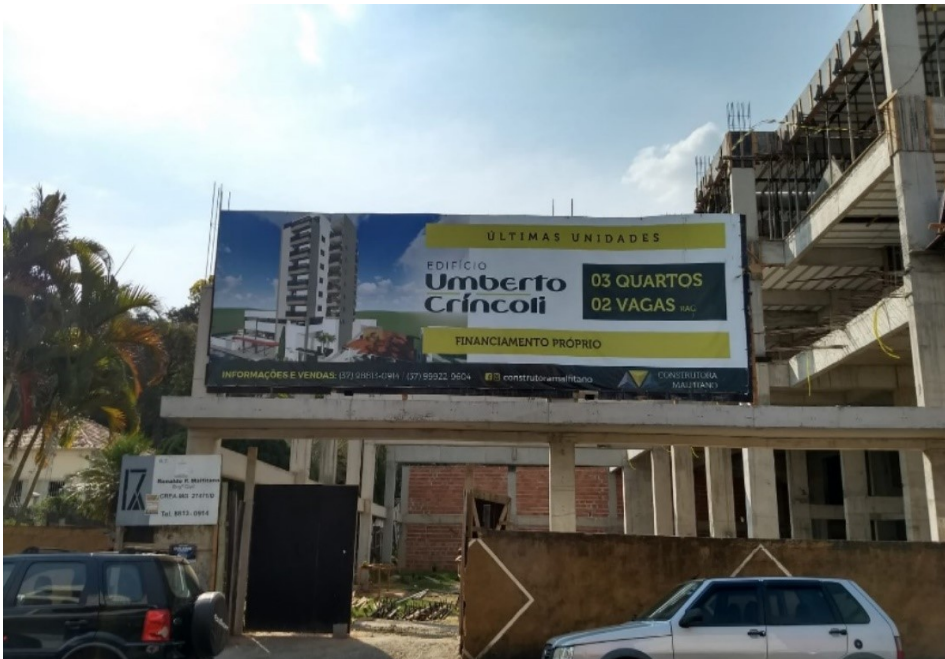
Figura 1 – Obra em andamento do Edifício Umberto Crincoli
