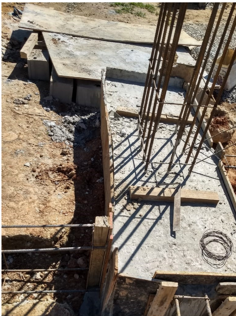
Figura 14 – Vigas baldrame (armação)
