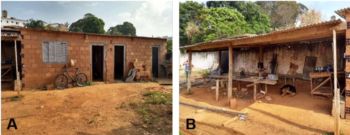
Figura 3 – Organização do canteiro de obras A) Almojarifado; (B) Área coberta
