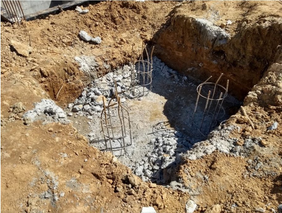
Figura 12 – Vala bloco de coroamento
