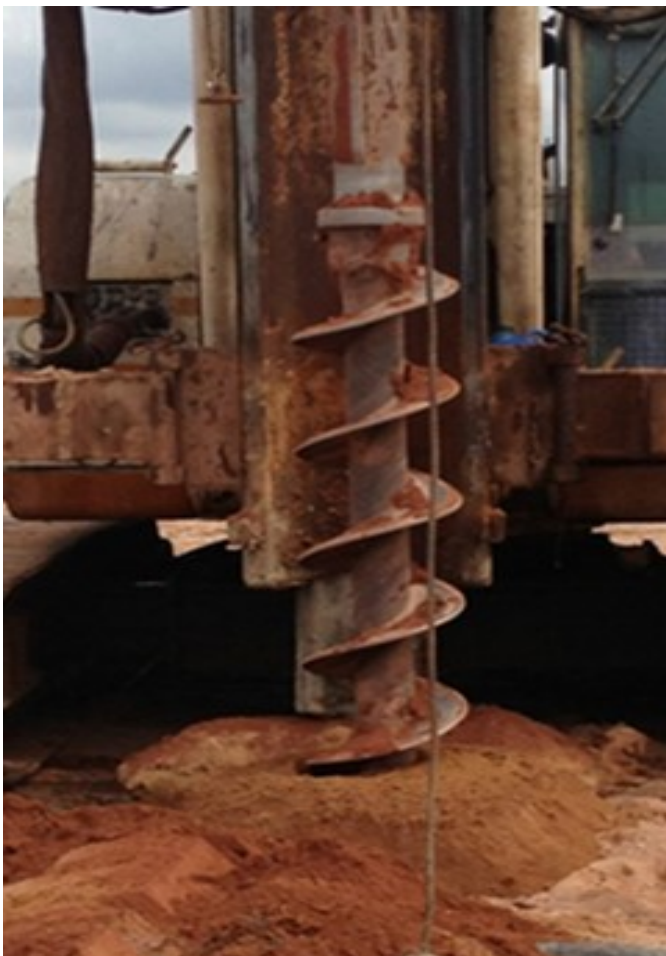
Figura 10 – Perfuratriz de trado contínuo
