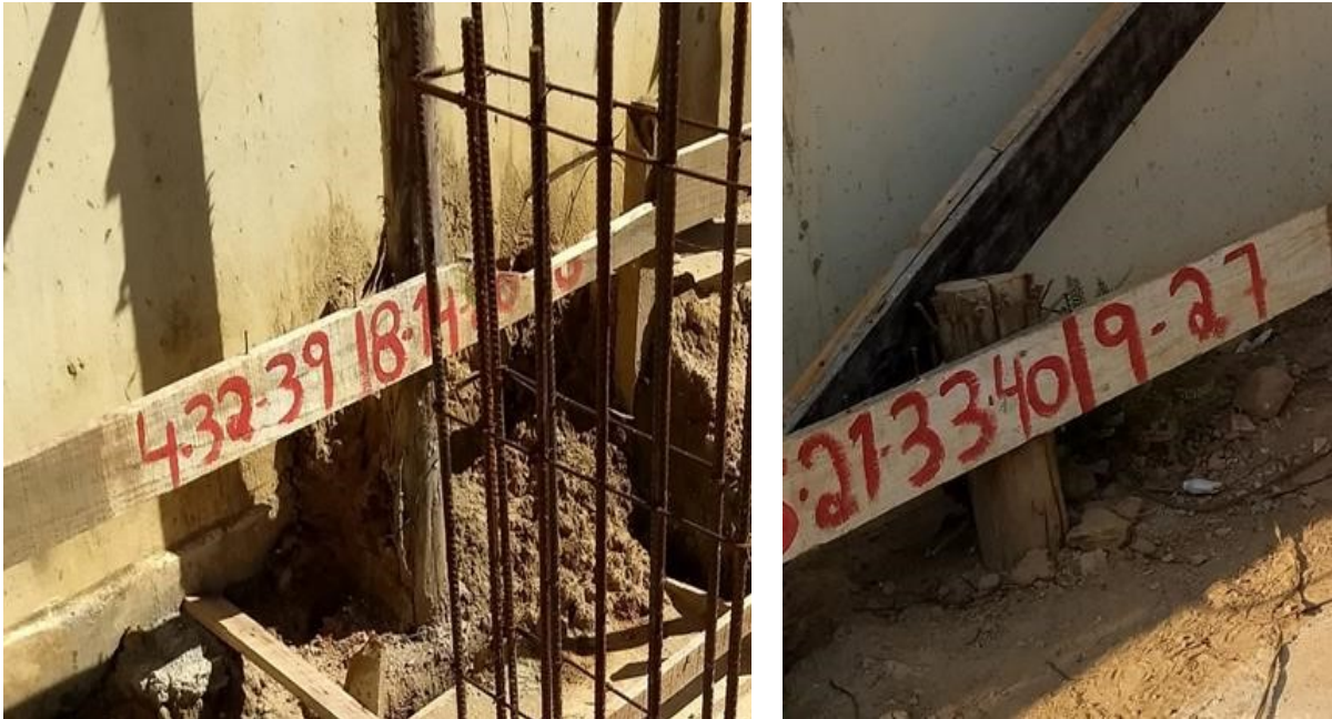
Figura 6 – Locação por gabaritos
