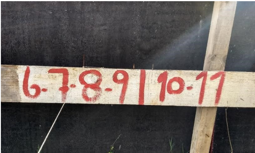
Figura 8 – Marcação da locação
