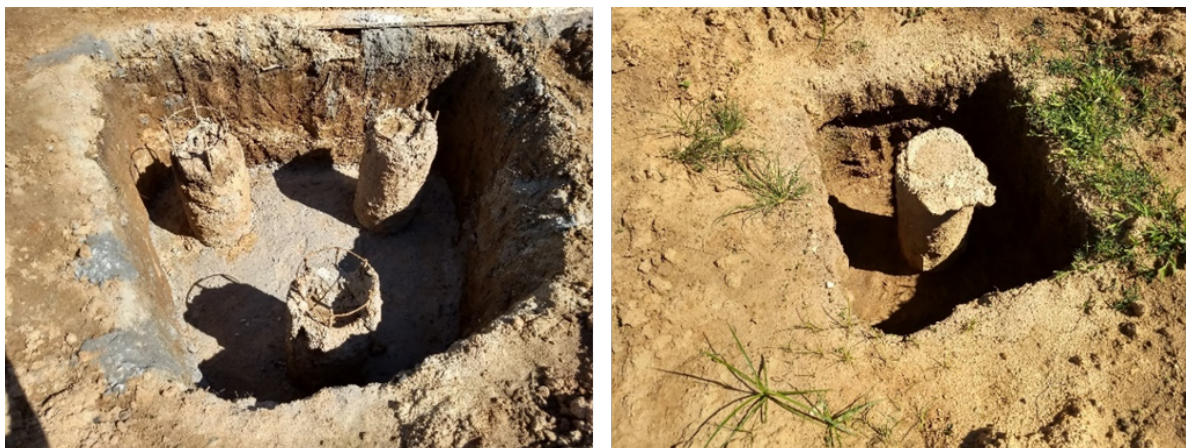
Figura 11 – Estaca hélice contínua
