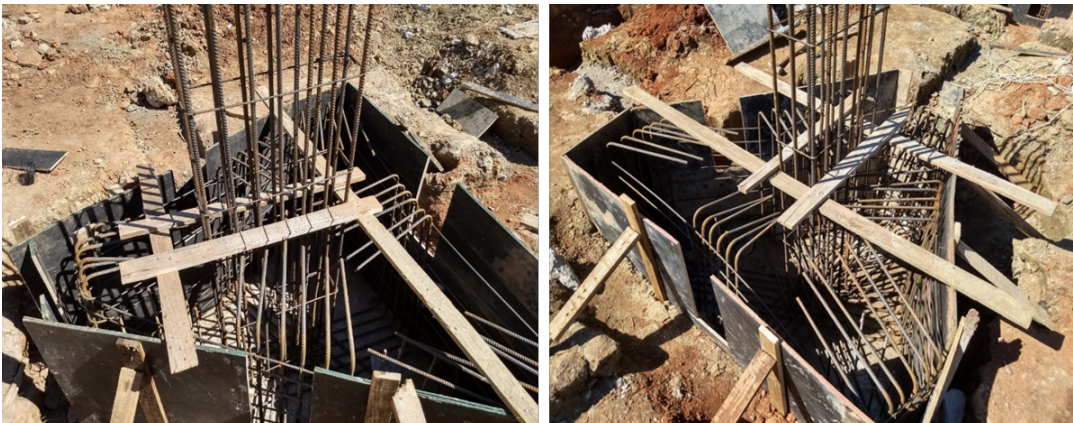
Figura 13 – Preparação para concretagem
