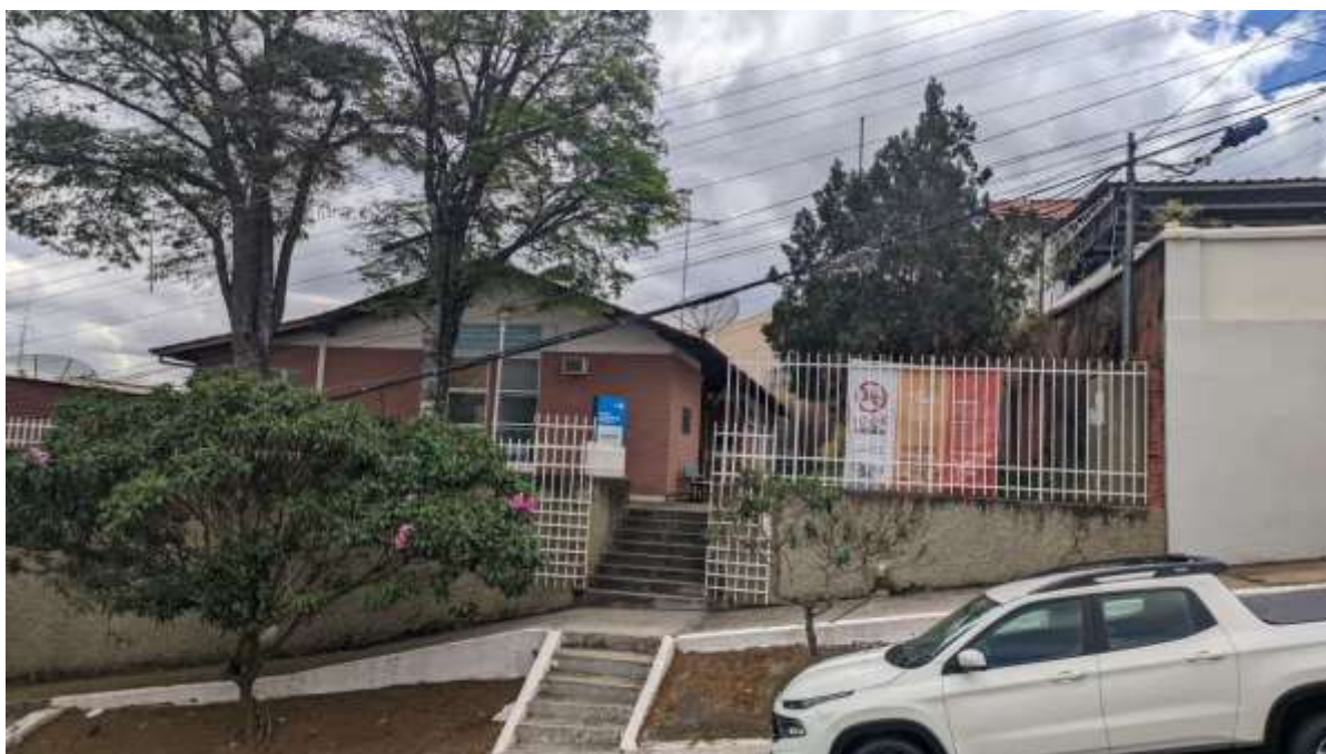
Imagem 22 - Entrada do PSF Rural, escada íngreme sem rampa de acessibilidades.
