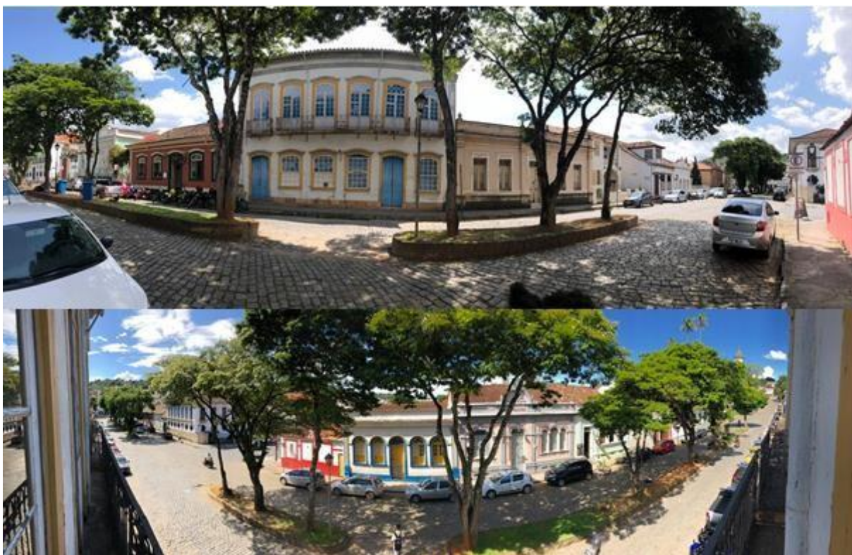
Imagem 21 - Edificações da Rua Padre José Maria Xavier
