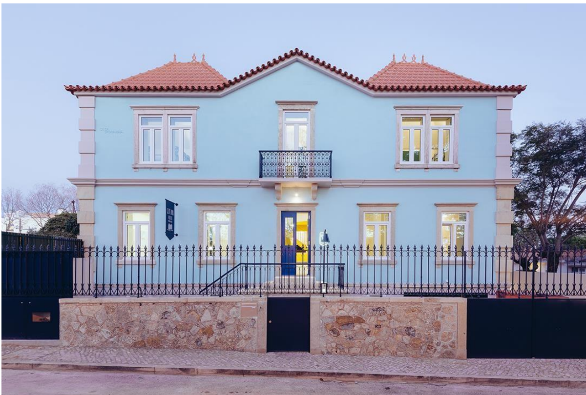
Imagem 7 - Fachada frontal do Hostel na Parede
