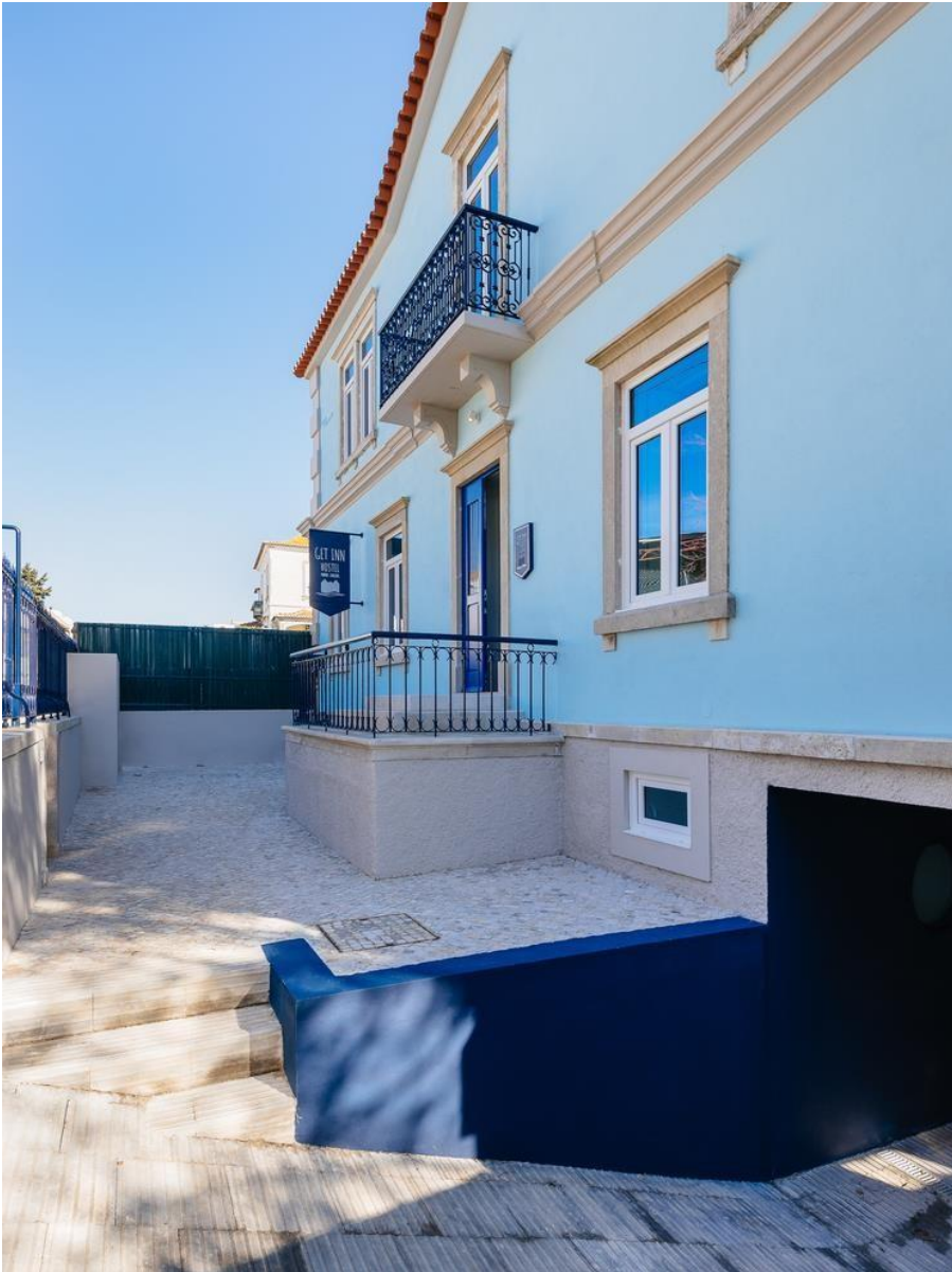
Imagem 8 - Vista da fachada
