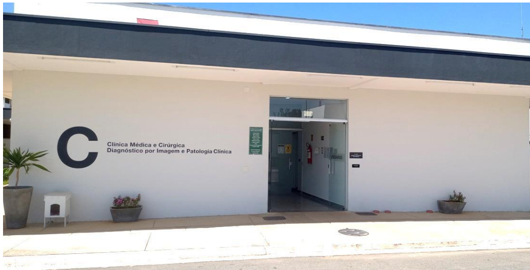
Imagem 1 – Visão externa do bloco C.
