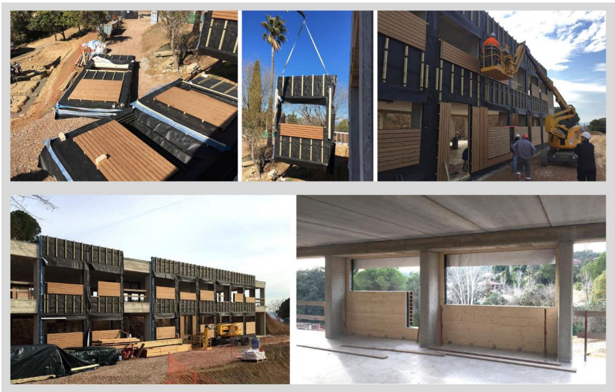
Imagem 10 – Processo de construção das paredes pré-moldadas
