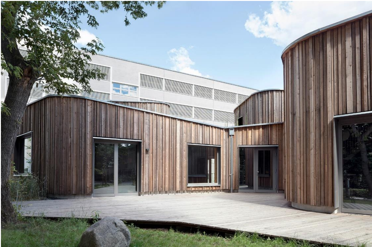
Imagem 5 – Fachada em madeira lariço
