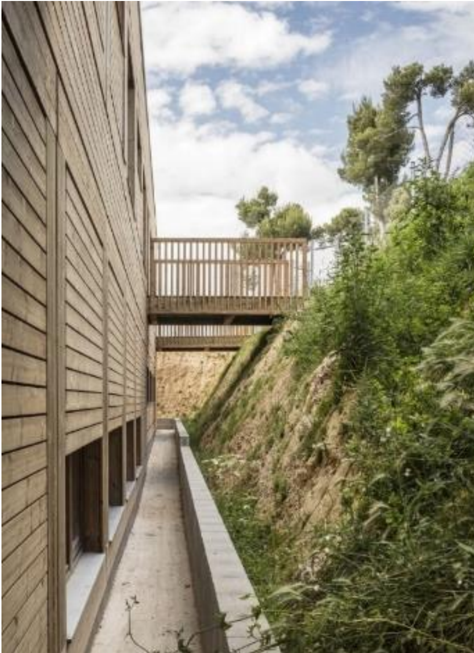
Imagem 9- Ponte de acesso respeitando a topografia do terreno
