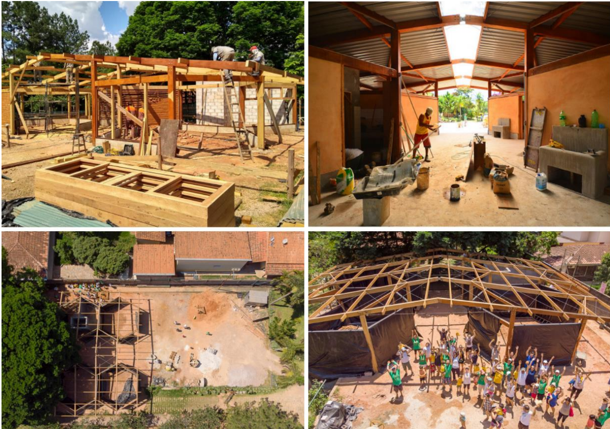
Imagem 14– Fases da construção da escola Waldor Ecoara
