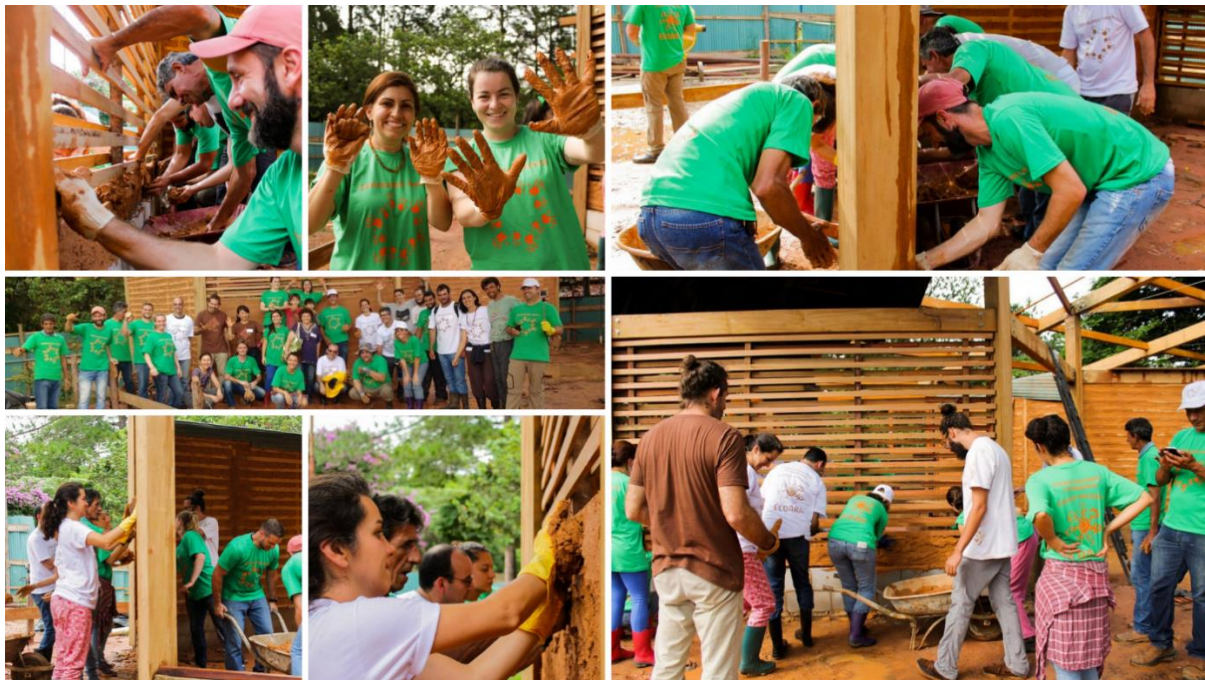
Imagem 15– Comunidade Ecoara e pedreiros executando as paredes aplicando a tradicional técnica de taipa de mão
