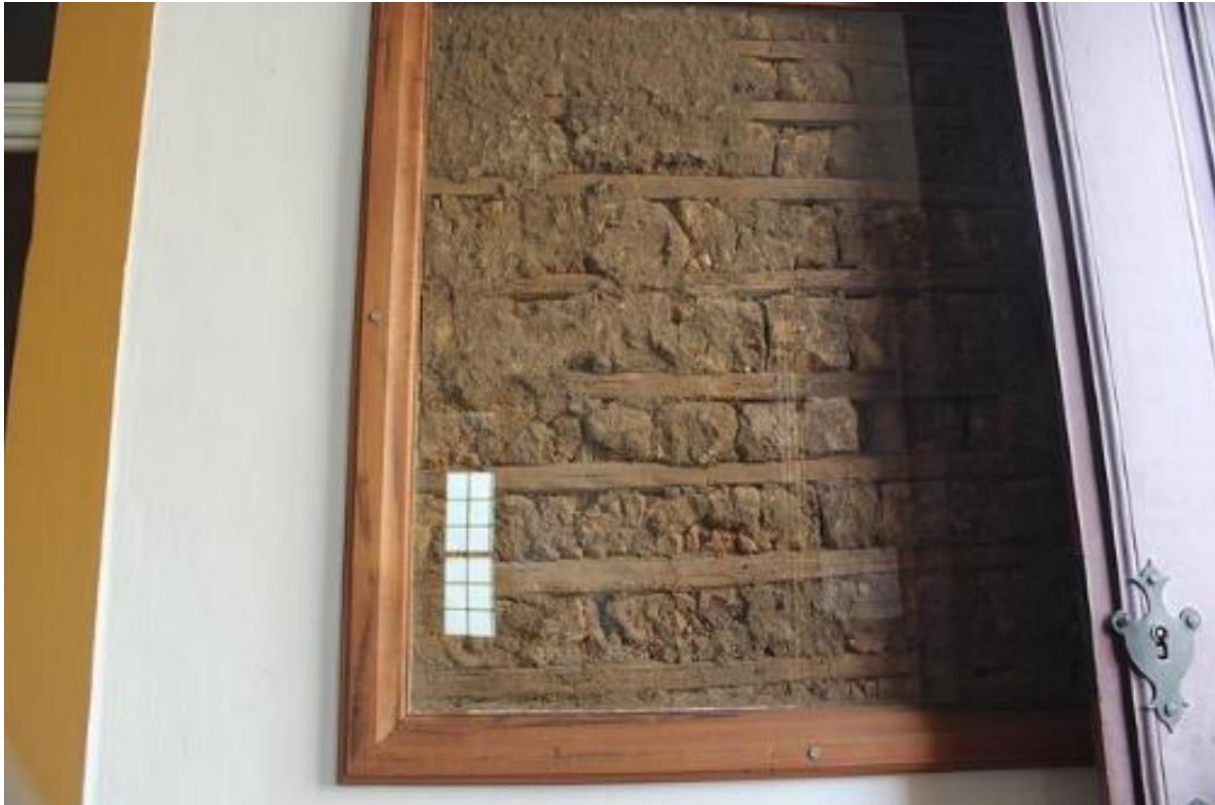
Imagem 24: Detalhe da parede original do casarão em pau-a-pique
