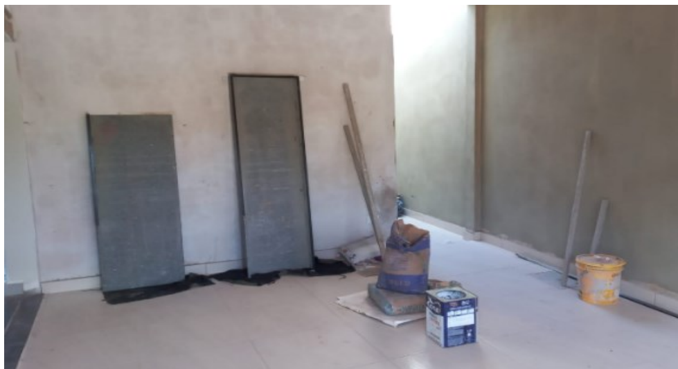
Figura 23 - Porcelanato garagem instalado.
