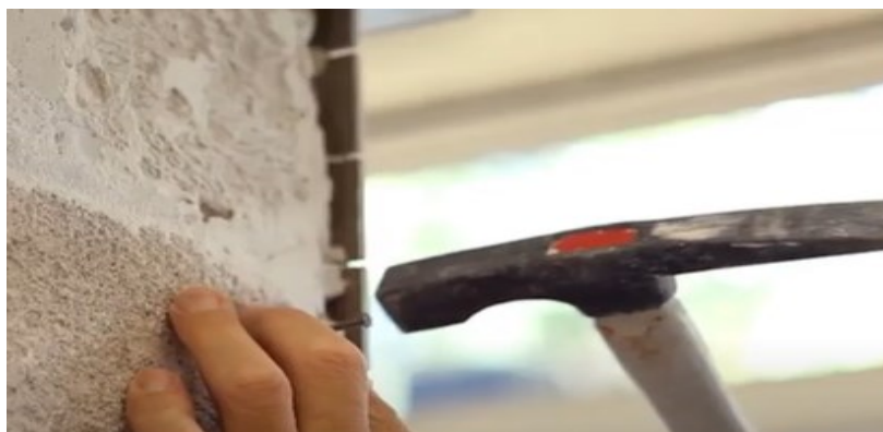
Figura 5 - Instalação dos pregos para nivelamento.
