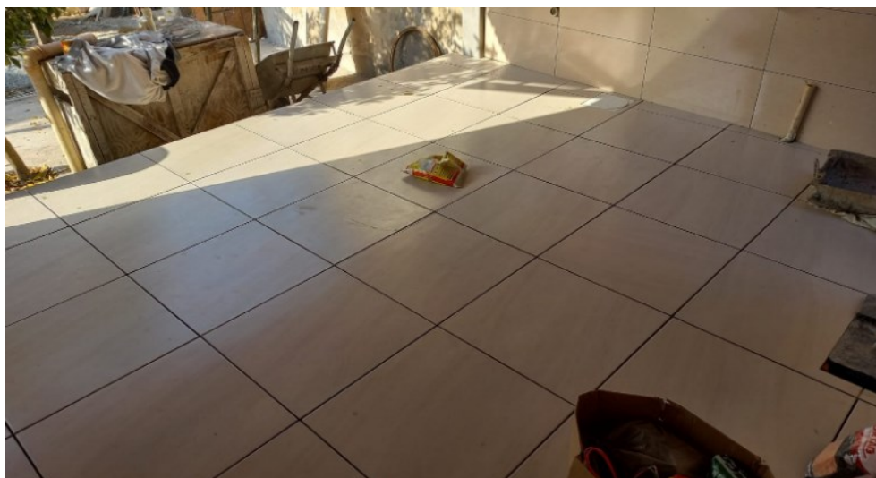
Figura 24 - Porcelanato lavanderia instalado.
