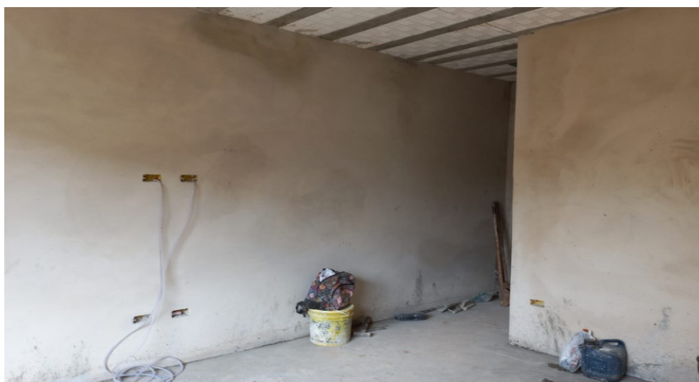
Figura 11 - Reboco finalizado.
