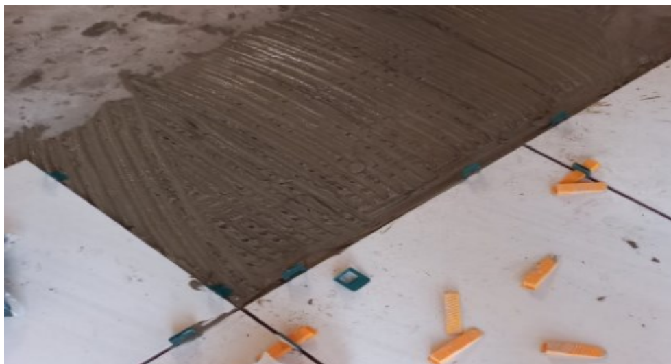
Figura 26 - Argamassa no contra piso.
