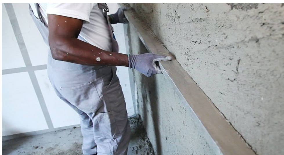
Figura 9 - Parede sarrafeada.
