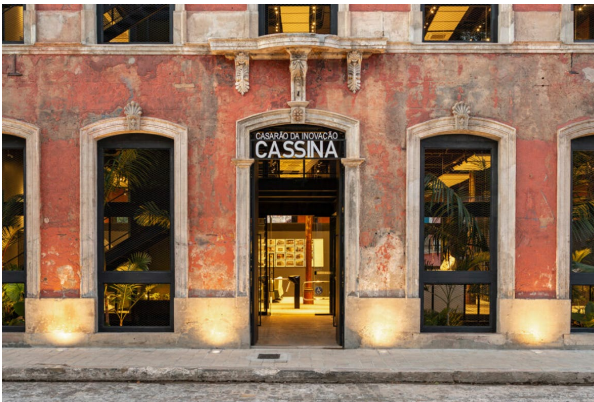
Imagem 9 – Fachada revestida de argamassa pigmentada de pó de arenito vermelho
