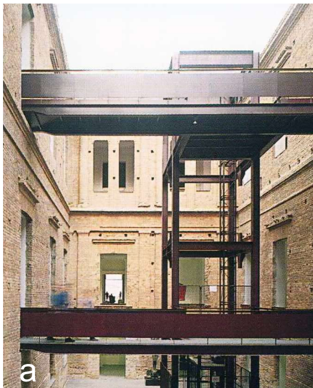
Imagem 4 – Aberturas e permeabilidade do local
