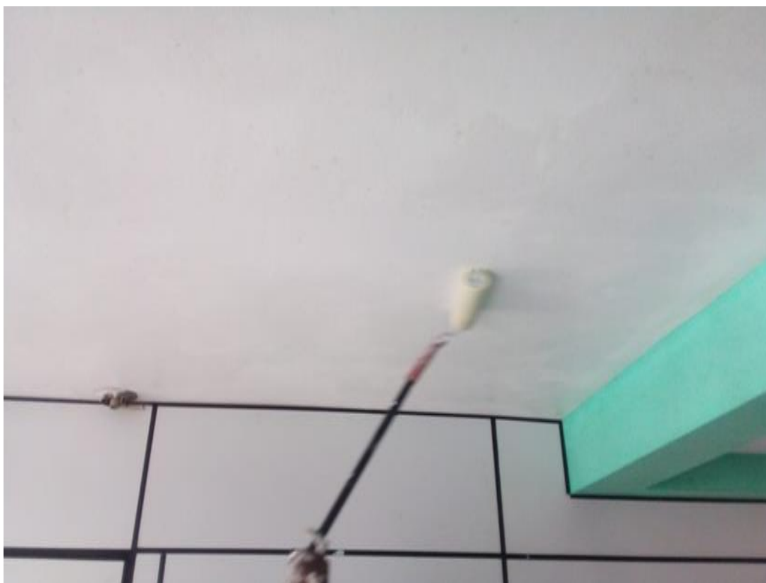
Imagem 11. Pinturas das Paredes do Consultório.
