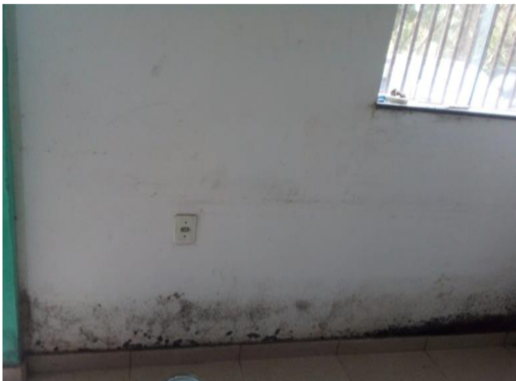
Imagem 10. Atual Aspectos das Paredes do Consultório.
