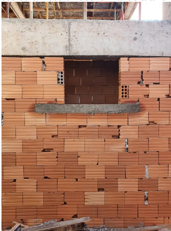
Figura 99 – Blocos cerâmicos unidos formando a alvenaria de vedação
