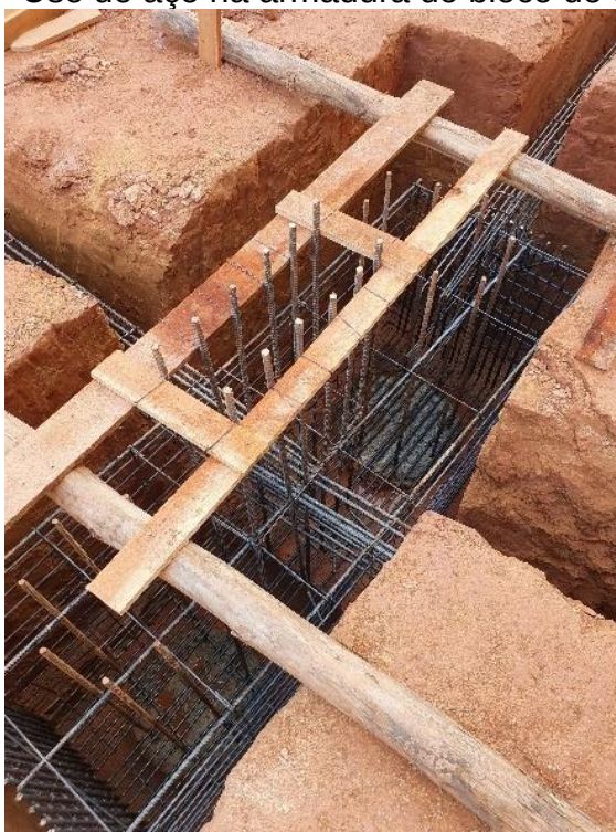
Figura 46 – Uso do aço na armadura do bloco de coroamento
