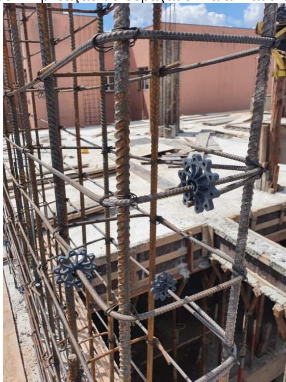
Figura 88 – Aplicação do espaçador na armadura do pilar
