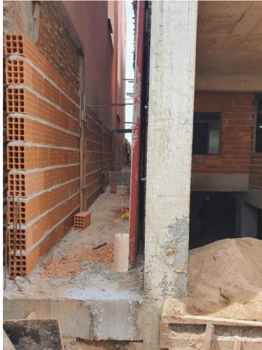
Figura 84 – Uso do prumo para transferência do eixo do pavimento inferior para o pavimento superior
