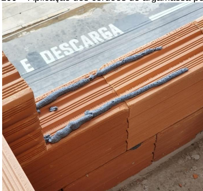
Figura 109 – Aplicação dos cordões de argamassa polimérica
