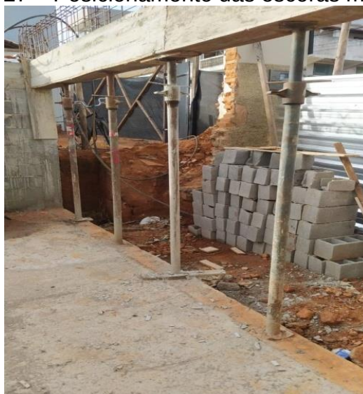
Figura 27 – Posicionamento das escoras metálicas
