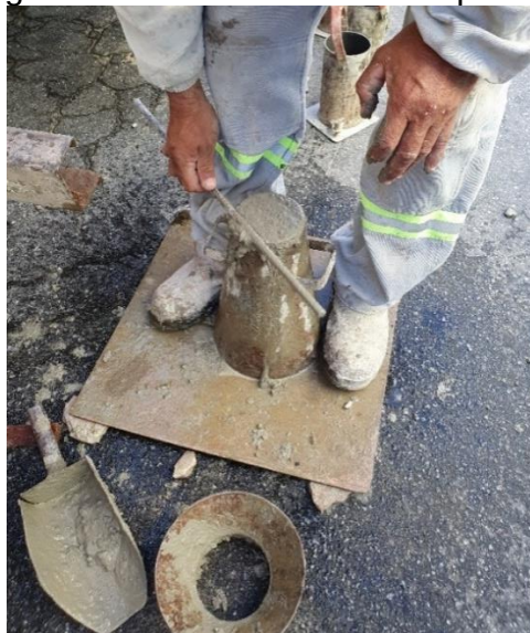
Figura 73 – Nivelamento da superfície
