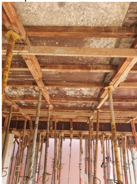
Figura 44 – Escora tipo metálica como sustentação das formas
