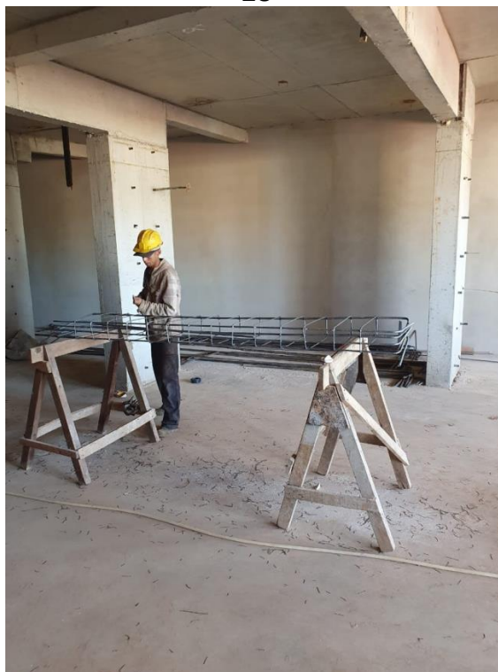
Figura 60 – Montagem da armadura de viga no espaço determinado conforme a NR 18
