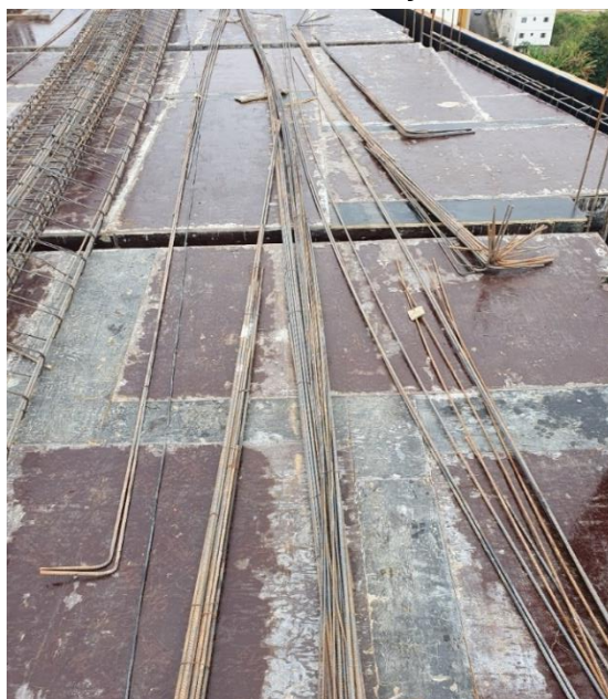
Figura 63 – Peças cortadas e dobradas das armaduras de vigas para montagem no local de instalação
