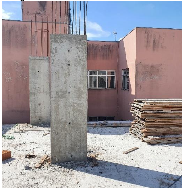
Figura 82 – Pilar do sistema estrutural
