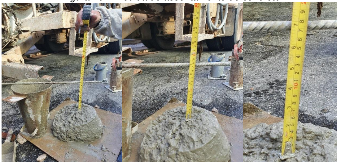
Figura 76 – Medida do assentamento do concreto
