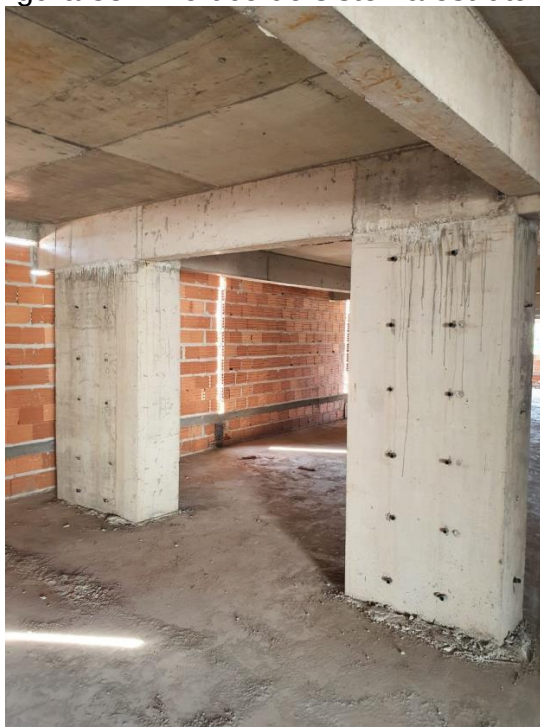
Figura 83 – Pórtico do sistema estrutural
