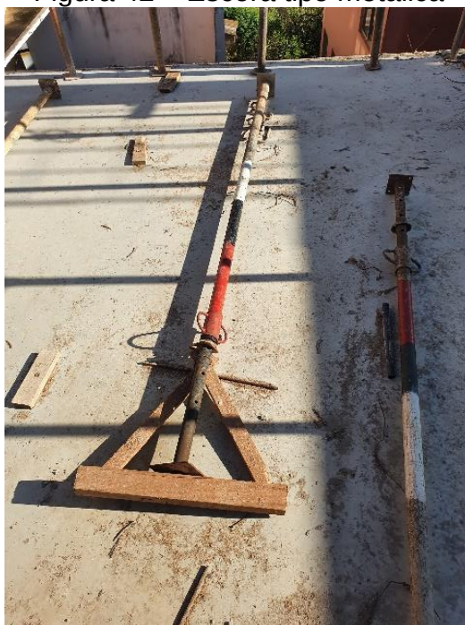
Figura 42 – Escora tipo metálica
