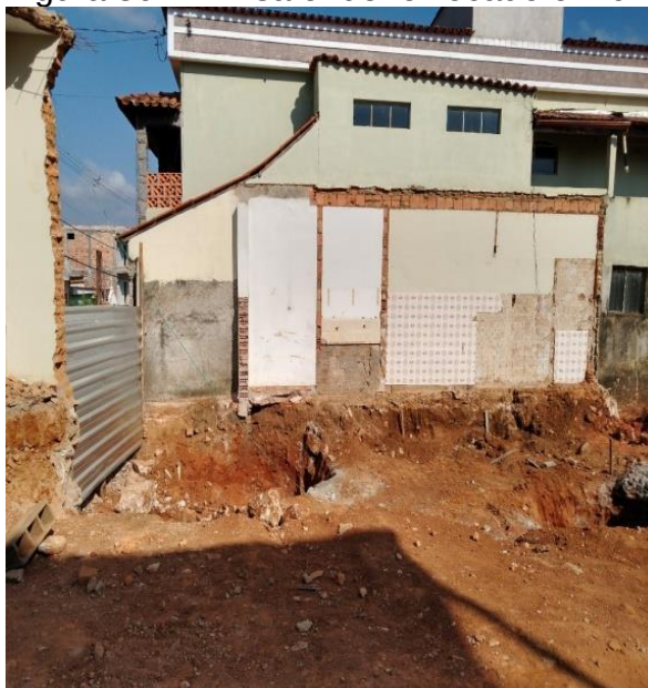
Figura 36 – Divisa onde foi locado o muro
