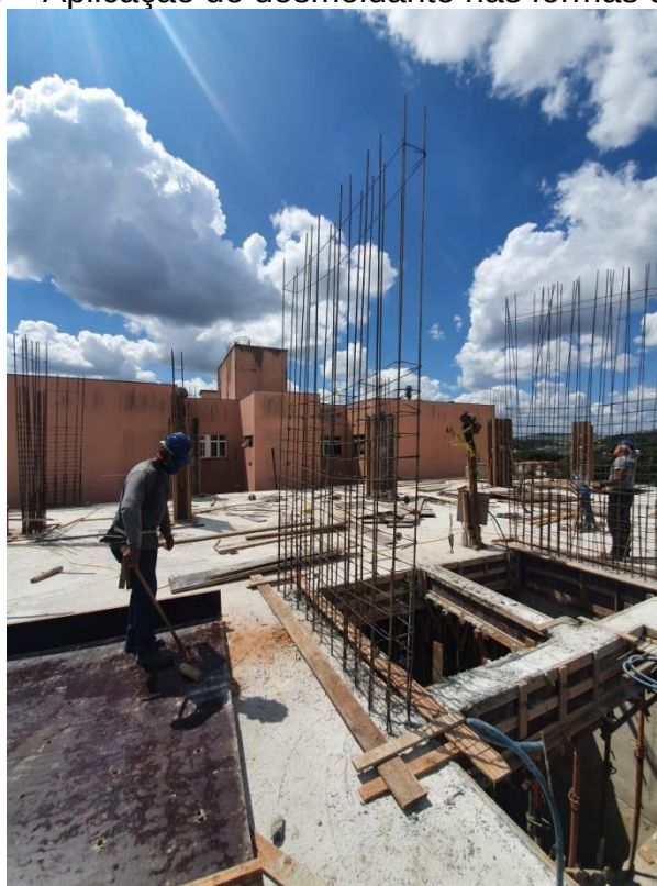
Figura 93 – Aplicação de desmoldante nas fôrmas dos pilares
