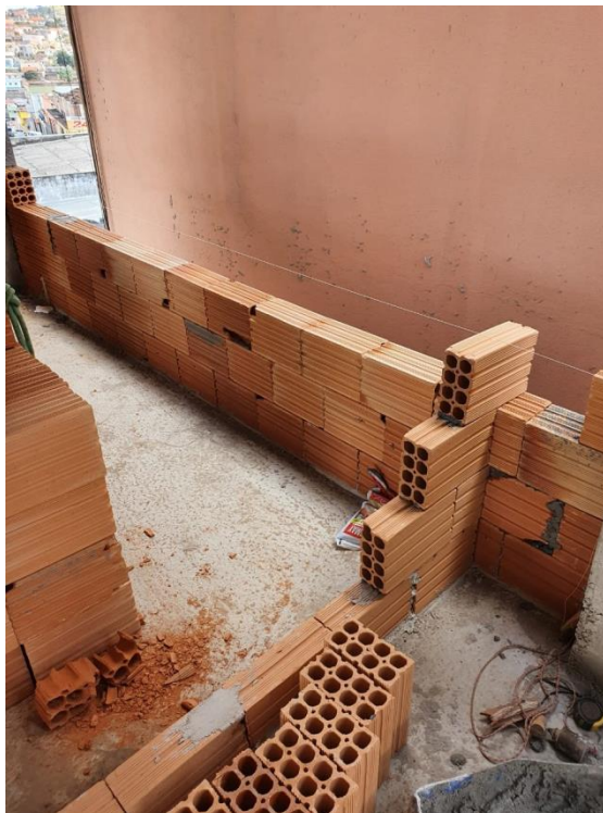
Figura 105 – Alinhamento horizontal dos blocos cerâmicos
