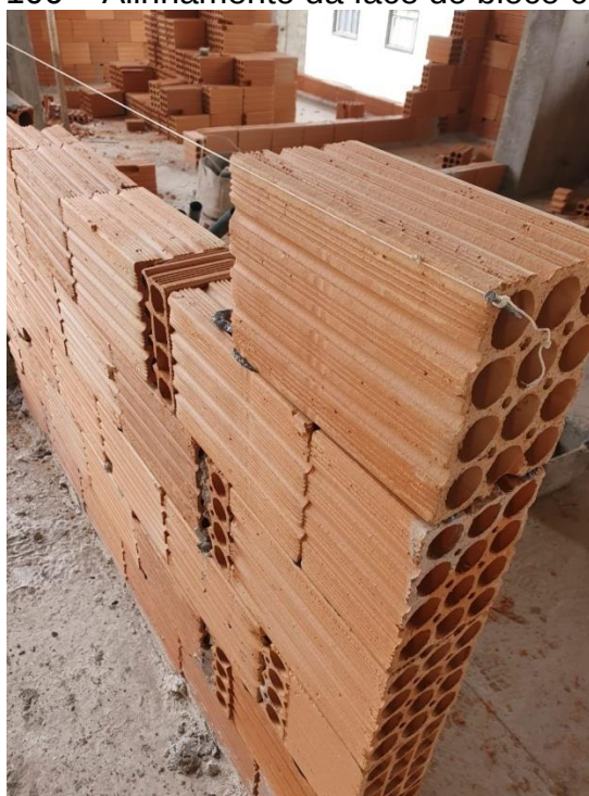
Figura 106 – Alinhamento da face do bloco cerâmico
