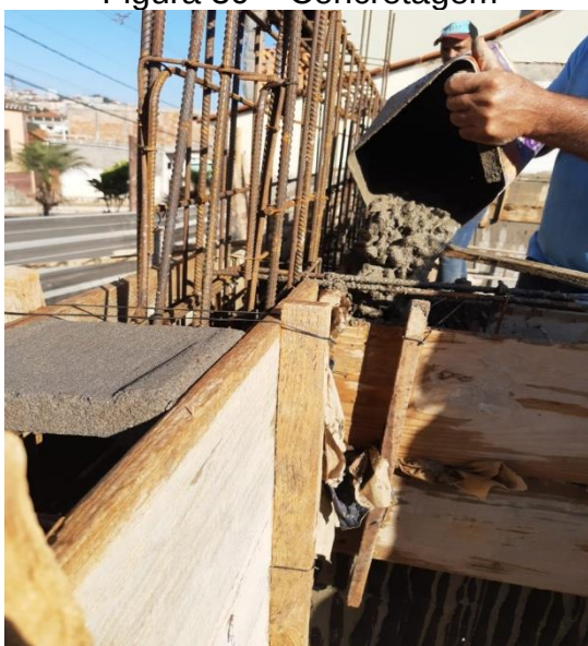
Figura 30 – Concretagem
