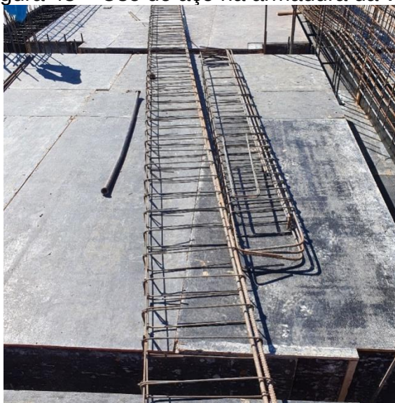
Figura 48 – Uso do aço na armadura da viga
