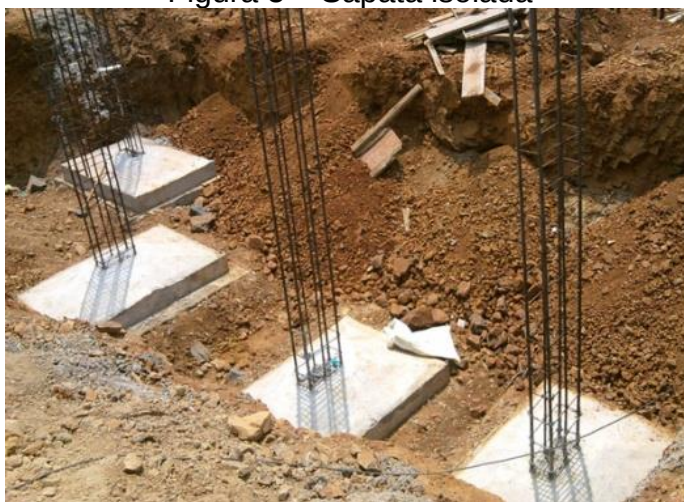
Figura 5 – Sapata isolada
