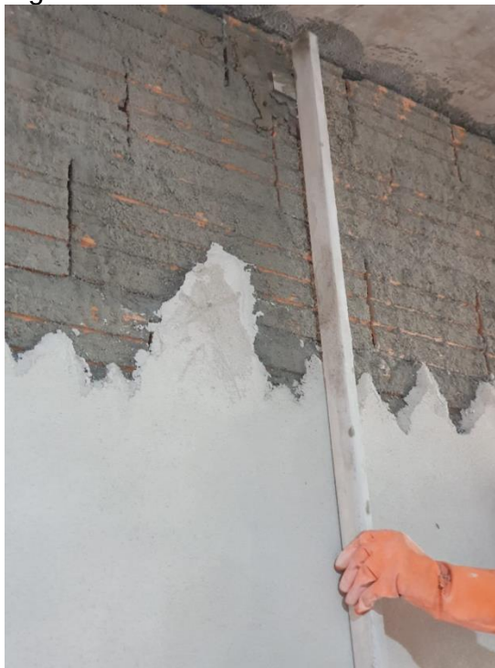
Figura 112 – Sarrafeamento do reboco
