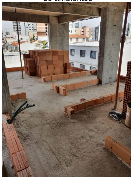
Figura 98 – Instalação de blocos cerâmicos na alvenaria de vedação para separação de ambientes
