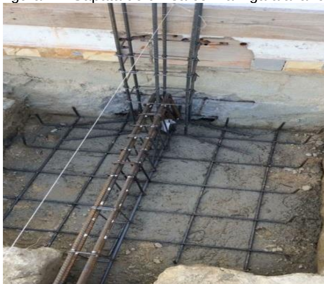
Figura 4 – Sapata de divisa com a viga alavanca
