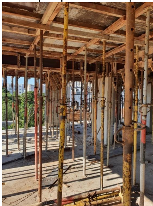
Figura 43 – Aplicação da escora tipo metálica
