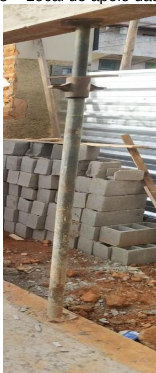
Figura 28 – Local de apoio das escoras
