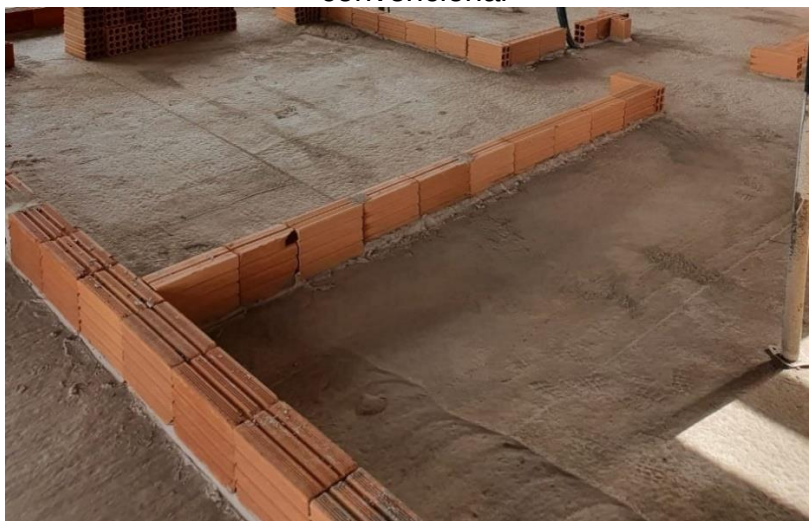
Figura 108 – Primeira fiada de bloco cerâmico assentado com argamassa convencional
