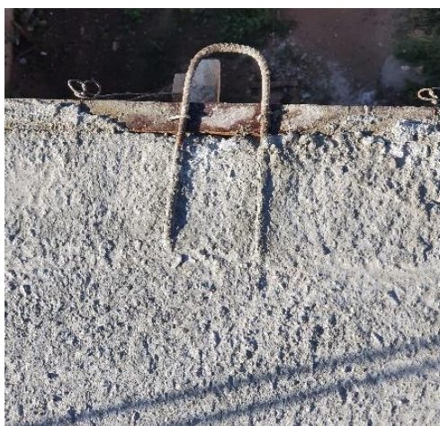
Figura 54 – Gancho para suporte de bandeja de proteção
