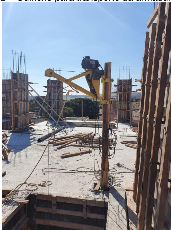
Figura 61 – Guincho para transporte da armadura da viga
