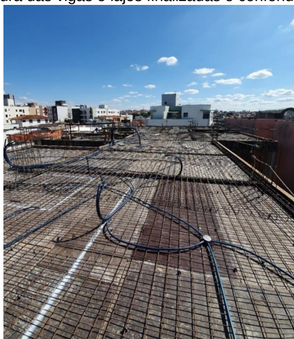
Figura 64 – Armadura das vigas e lajes finalizadas e conferidas conforme projeto
