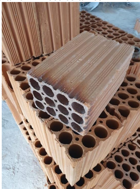
Figura 101 – Bloco cerâmico 14x19x29 cm
