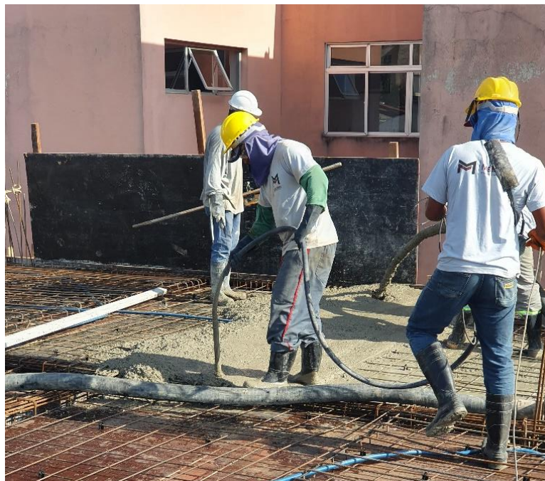
Figura 78 – Lançamento e adensamento do concreto
