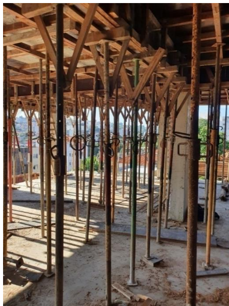
Figura 45 – Dimensionamento das escoras
