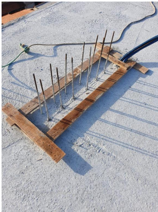
Figura 86 – Gastalho confeccionado de madeira
