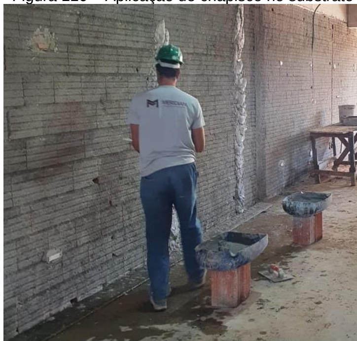
Figura 110 – Aplicação de chapisco no substrato
