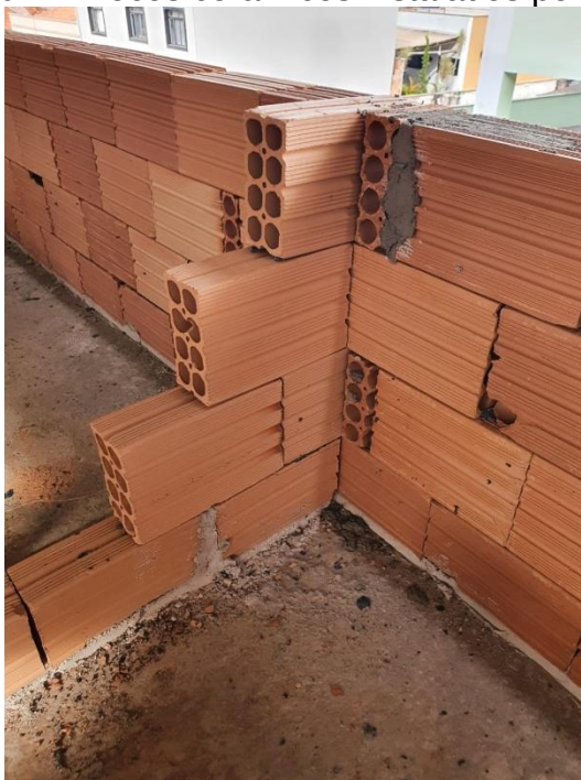
Figura 104 – Blocos cerâmicos instalados pelos cantos
