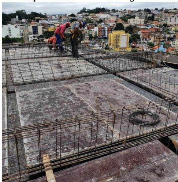
Figura 62 – Finalização da armadura de viga no local de instalação
