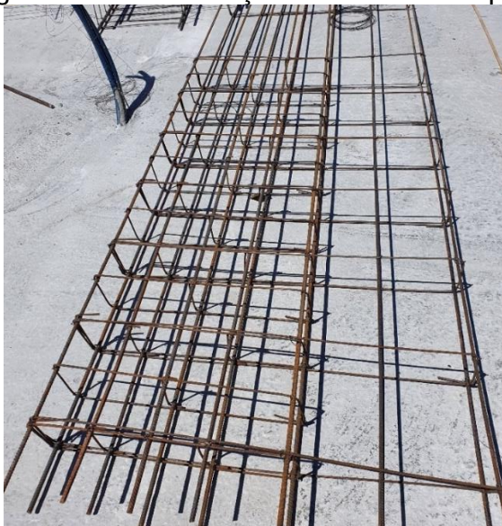
Figura 47 – Uso do aço na armadura do pilar
