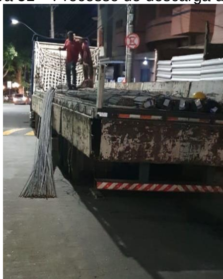
Figura 51 – Processo de descarga de aço
