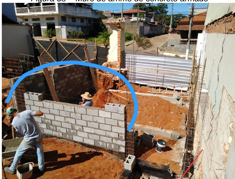
Figura 38 – Muro de arrimo de concreto armado
