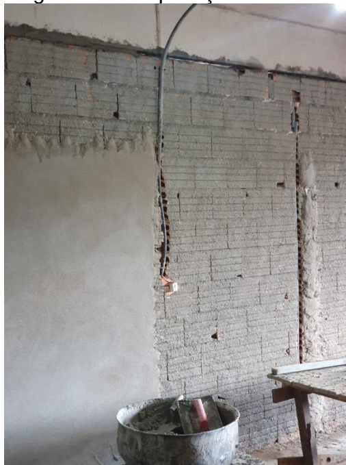
Figura 111 – Aplicação do reboco
