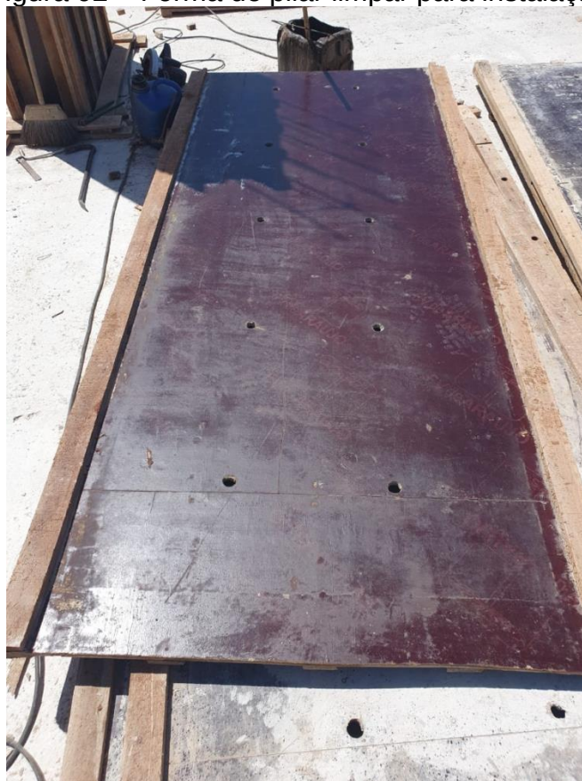
Figura 92 – Fôrma de pilar limpa para instalação
