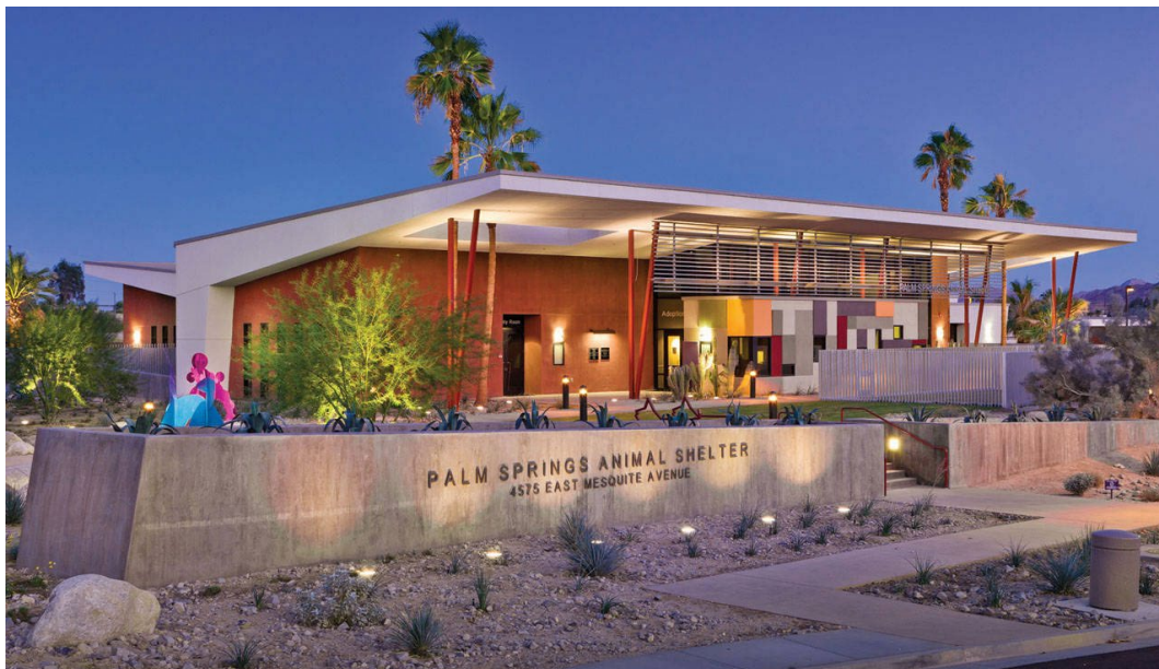
Imagem 10 – Fachada do Palm Springs Animal Care Facility
