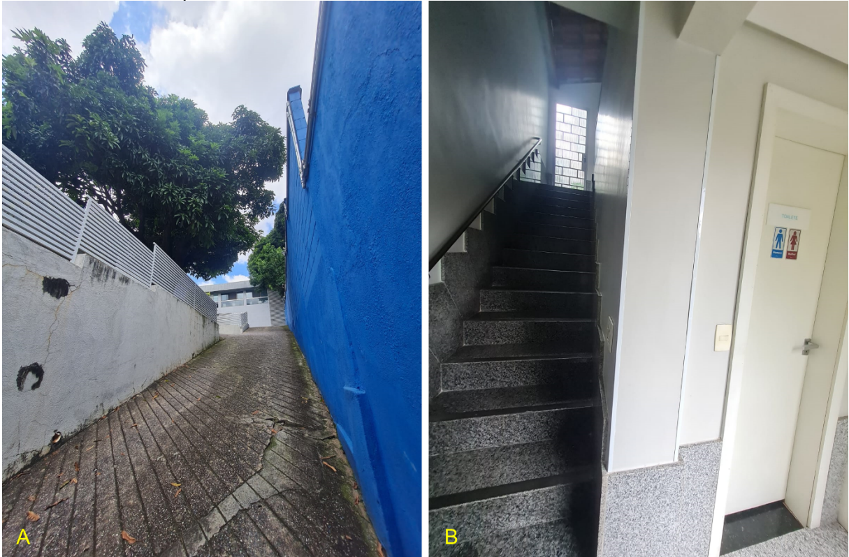
Figura 1: Área externa da clínica. (A) Rampa de acesso ao estacionamento. (B) Escada que conduz ao andar superior.
