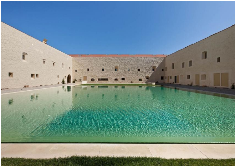
Imagem 14– Convento após Reabilitação
