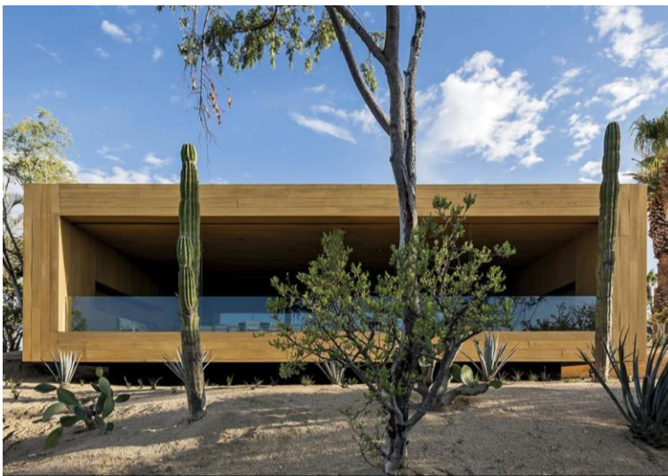
Imagem 29 – Estrutura em Balanço
