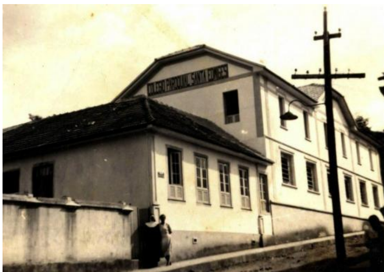
Imagem 11 – Fachada Escola Paroquial Santa Edwiges
