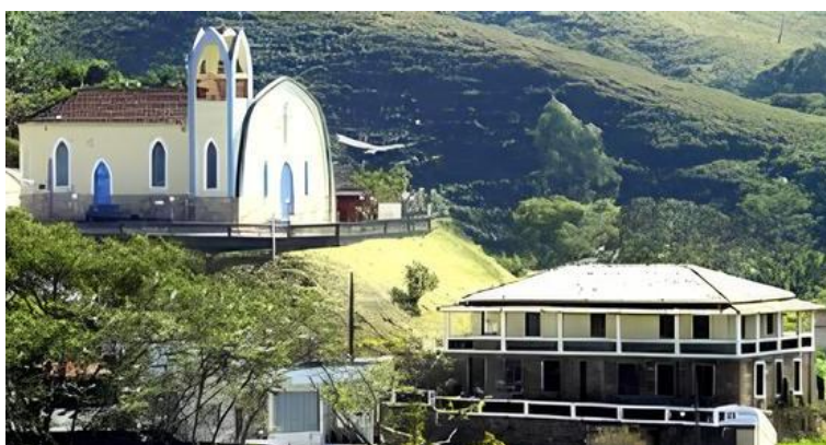
Imagem 5 – Edifício da Antiga Cadeia e Igreja do Rosário
