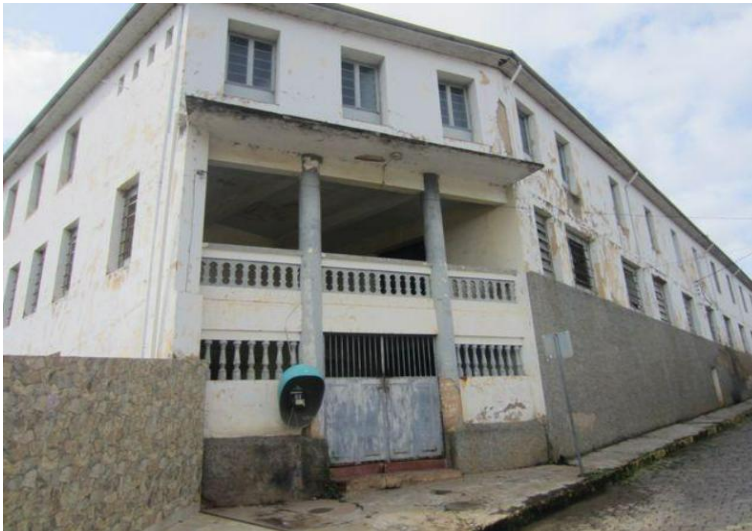
Imagem 12 – Fachada Colégio Santa Edwiges
