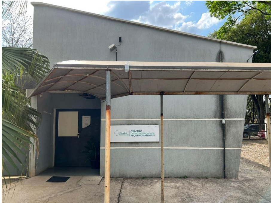
Figura 3 - Vista parcial da fachada da internação da clínica médica do hospital veterinário.
