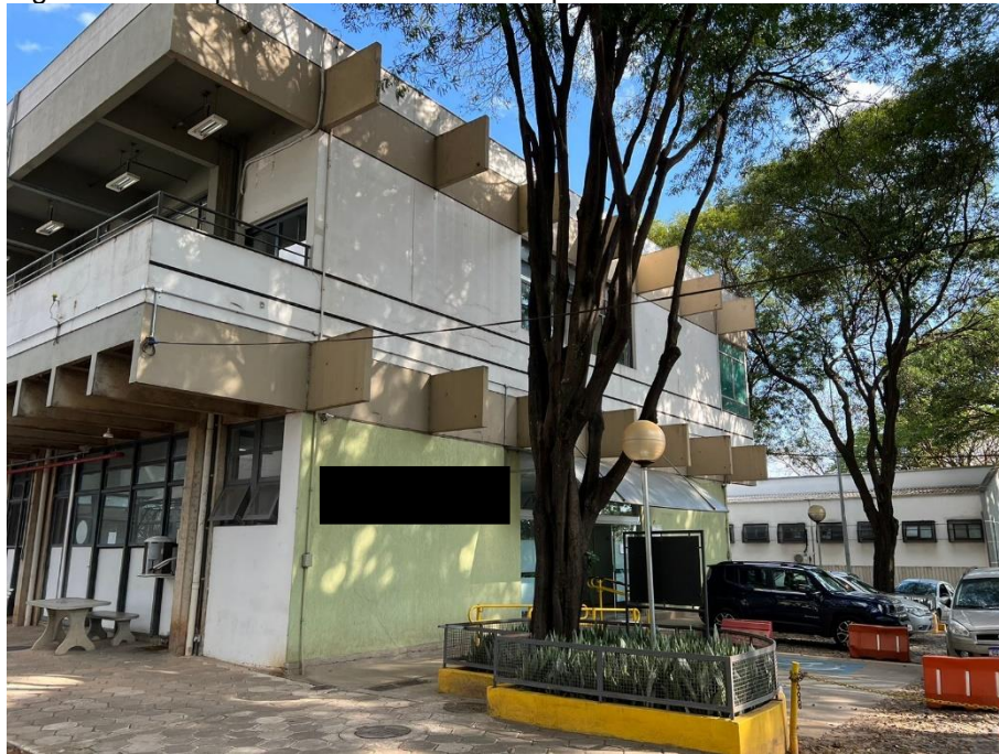
Figura 1 - Vista parcial da fachada do hospital veterinário.
