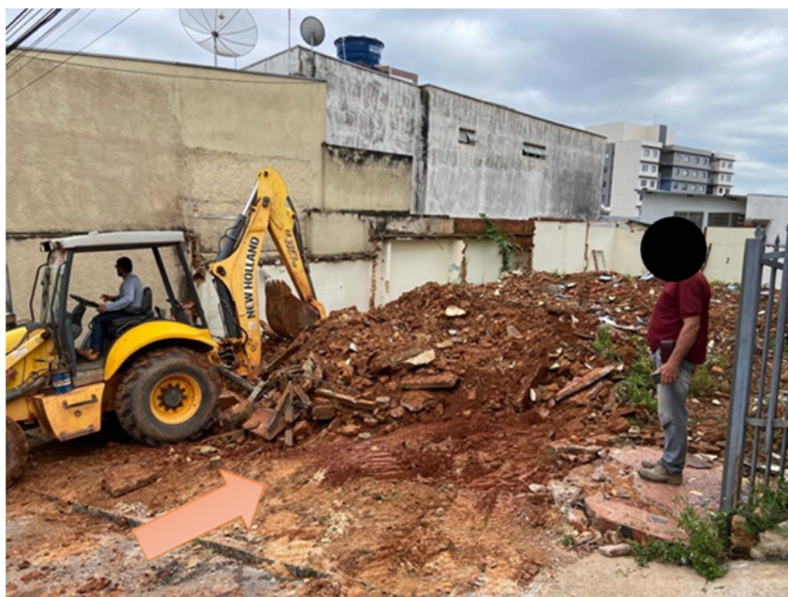
Figura 33 – Após a Demolição
