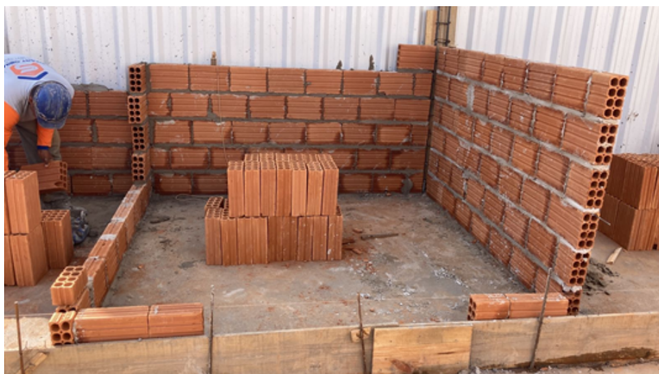
Figura 14 – Execução de alvenaria
