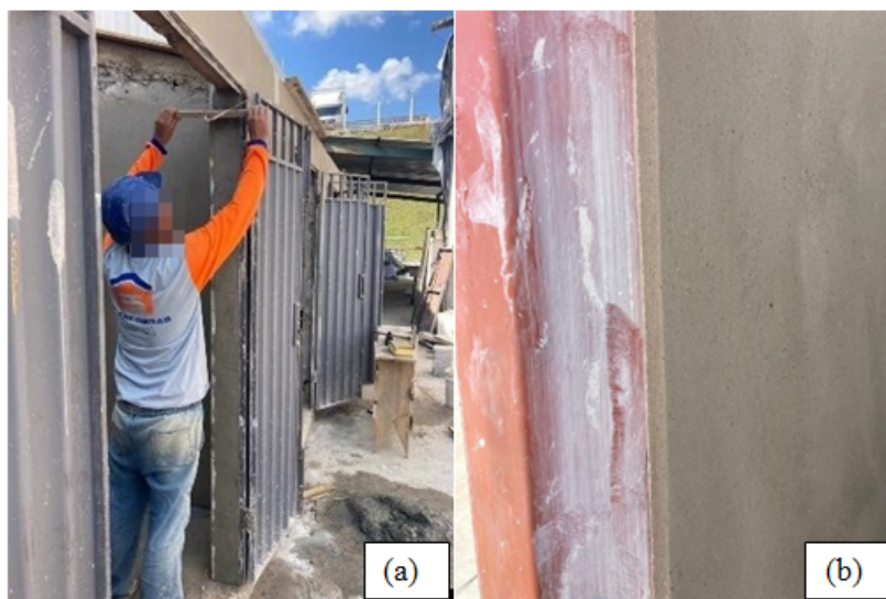
Figura 21 – Sarrafeamento, desempeamento e filtro (a) e parede finalizada (b)
