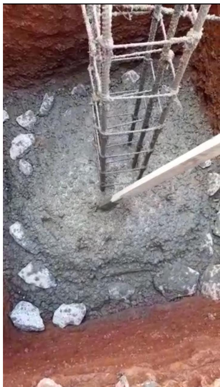
Figura 42 – Concretagem da Sapata
