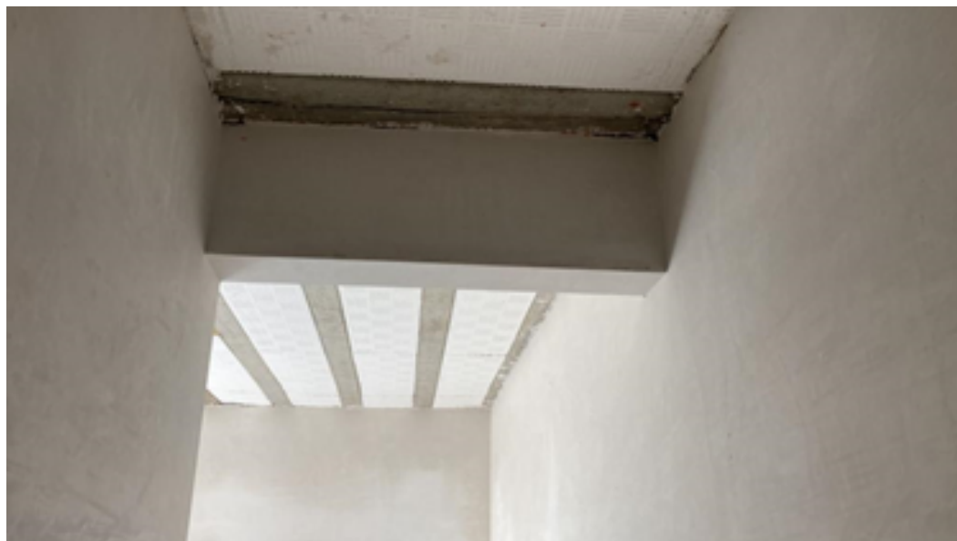
Figura 28 – Requadro executado em gesso liso
