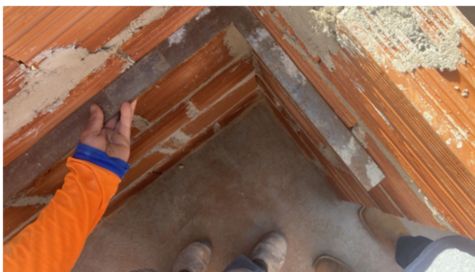
Figura 17 – Aferição de esquadro na 6ª fiada num ponto B
