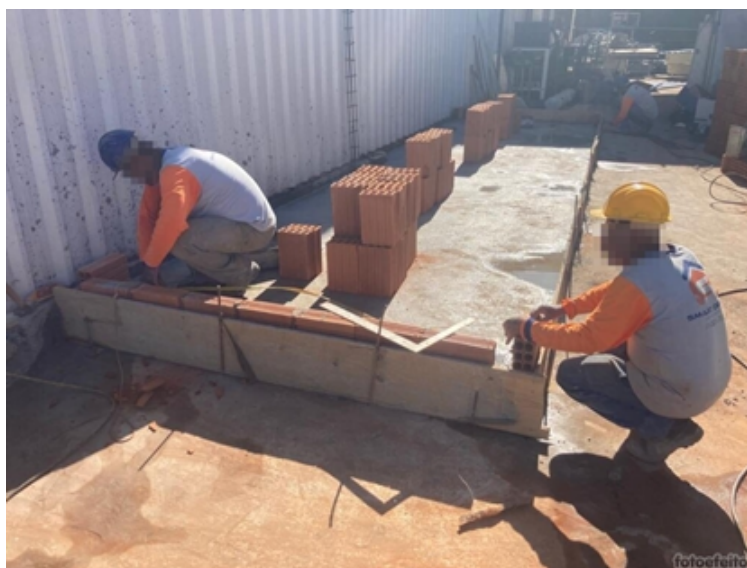
Figura 4 – Início da marcação das paredes
