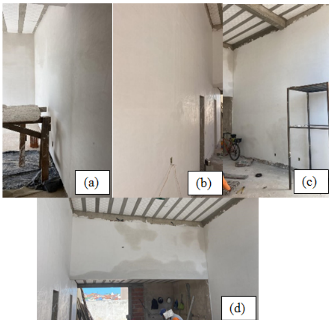
Figura 27 – Paredes com acabamento do gesso liso recém-executado (a), (b), (c) e (d)
