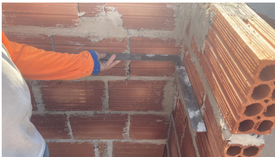
Figura 16 – Aferição de esquadro na 6ª fiada num ponto A
