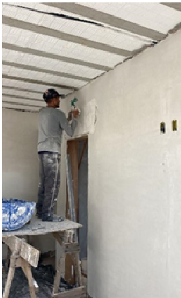
Figura 30 – Manutenção de gesso liso desnivelado, após conferência
