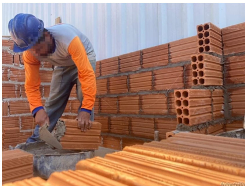
Figura 8 – Parede em T com amarração na obra
