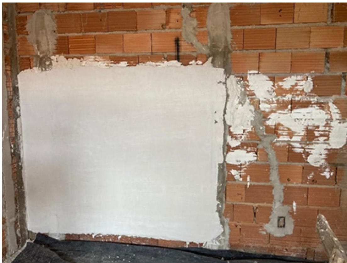
Figura 26 – Gesso aplicado em 3 demãos sem acabamento final
