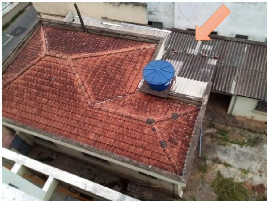
Figura 32 – Antes da Demolição
