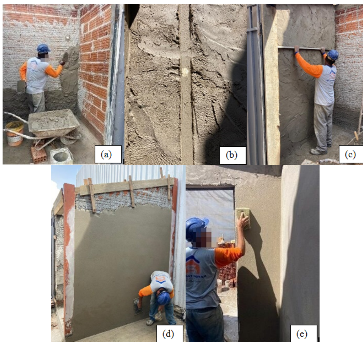
Figura 20 – Preenchimento do reboco (a) e (b), desempenamento (c) e (d), camurçamento (e)
