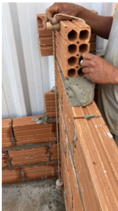
Figura 15 – Aferição do prumo
