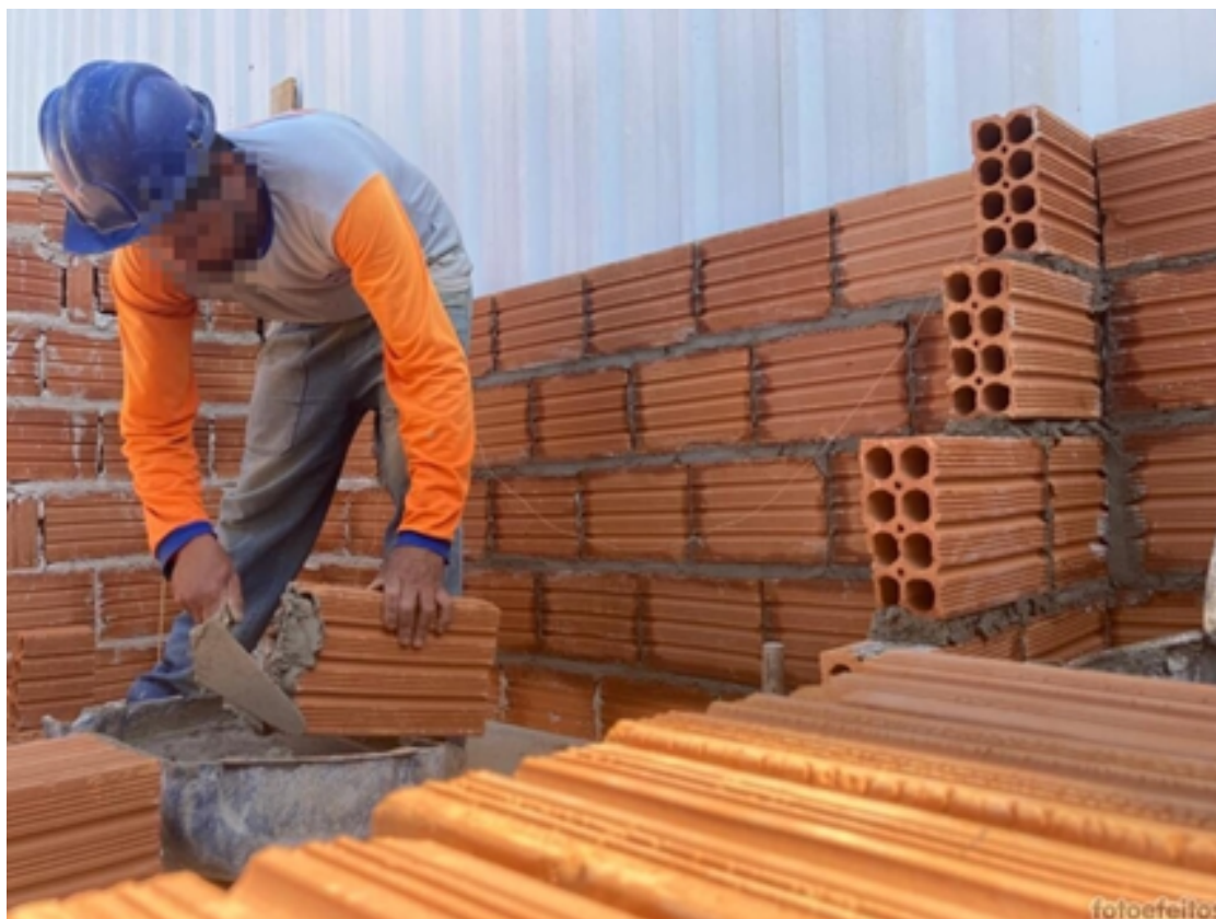
Figura 13 – Execução de parede em T com amarração na obra
