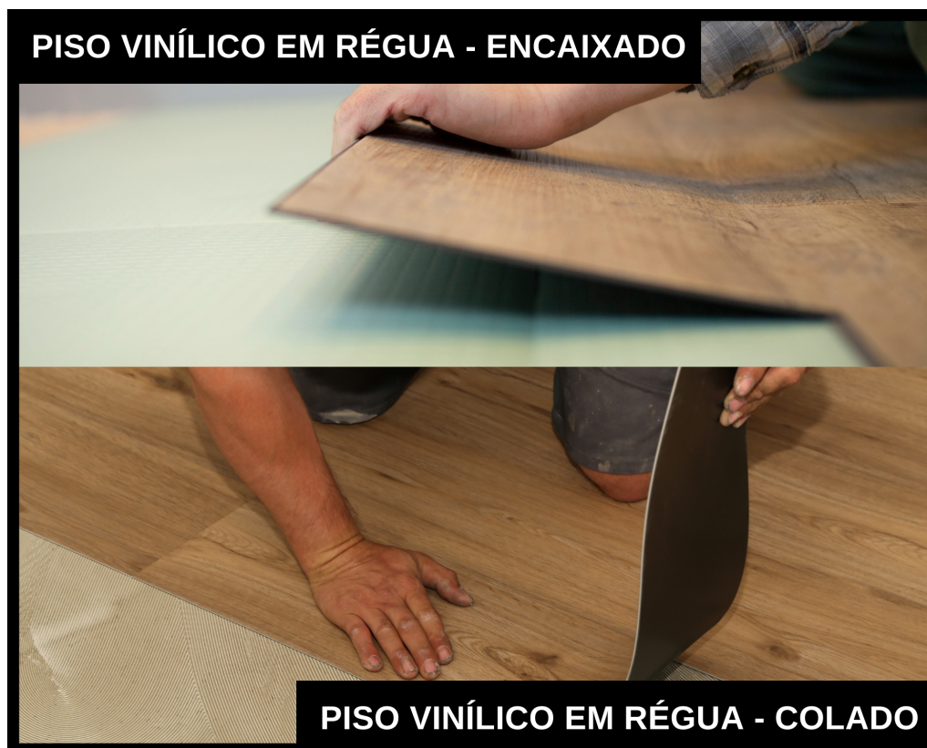
Figura 70 – Instalação de Pisos Vinílicos Colados
