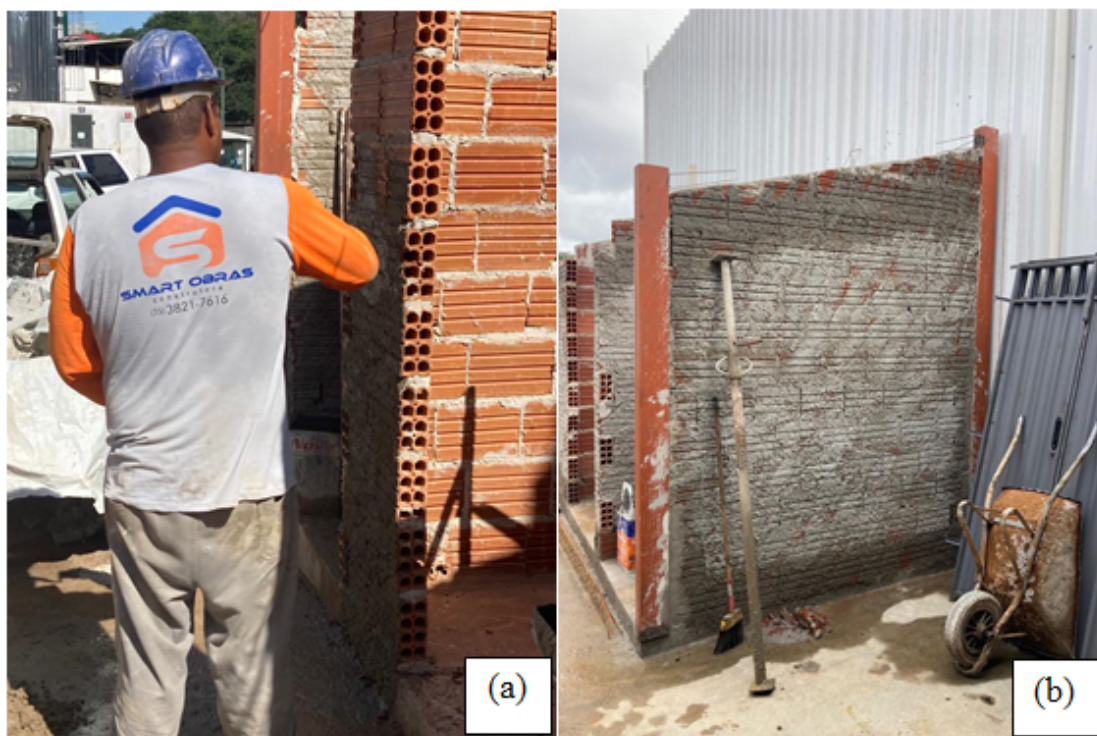
Figura 18 – Execução de chapisco (a) e chapisco já executado (b)
