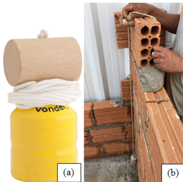
Figura 9 – Prumo de face (a) e Prumo de face em uso (b)
