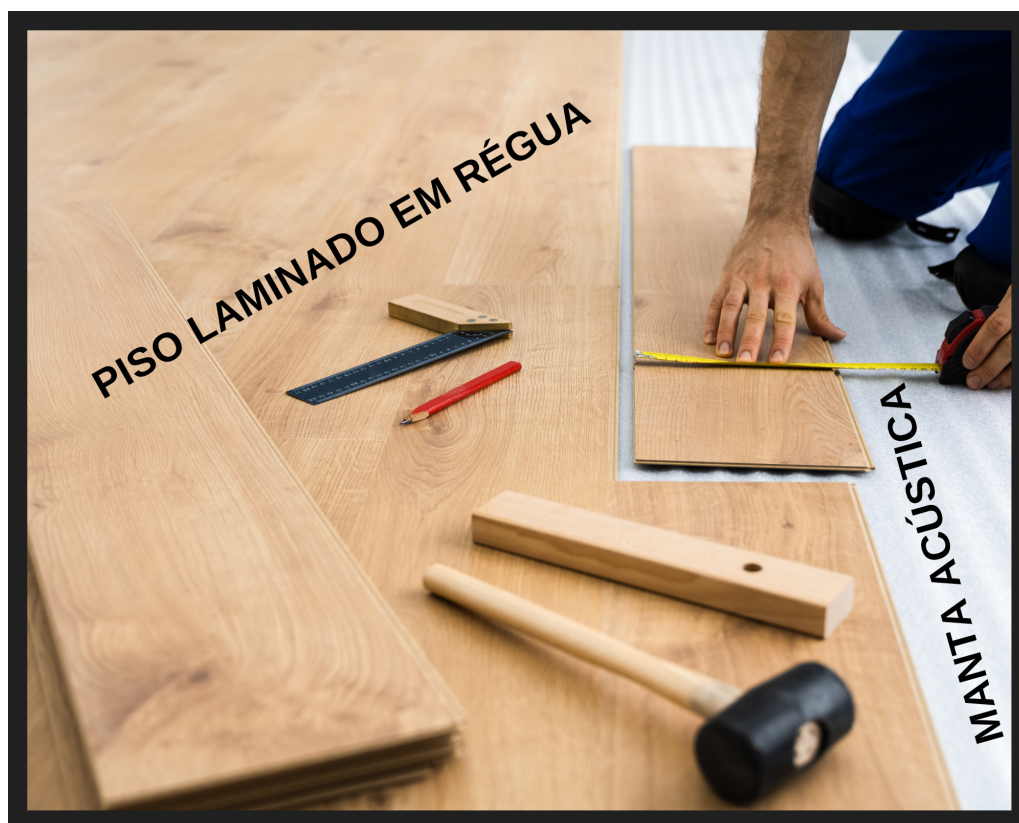
Figura 71 – Instalação de Pisos Laminados
