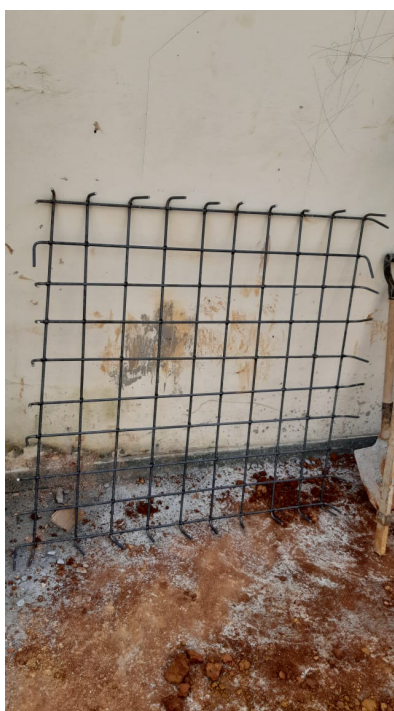
Figura 41 – Armação da Sapata
