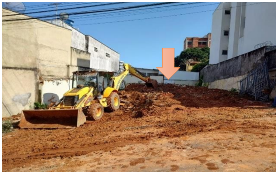
Figura 35 – Nivelamento do Terreno
