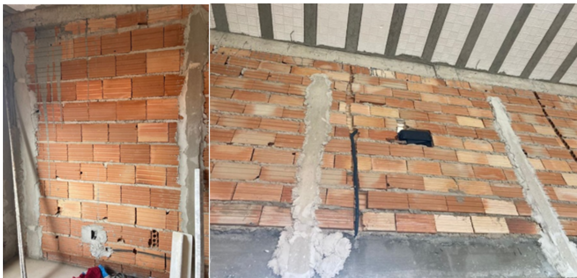
Figura 24 – Mestras executadas para aplicação de gesso liso
