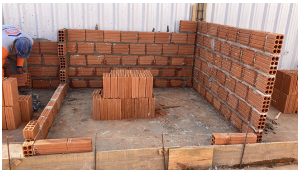
Figura 5 – Alvenaria em meia parede
