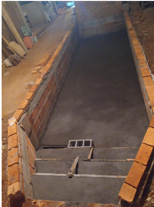
Figura 2 - Construção da nova sala de ordenha.
