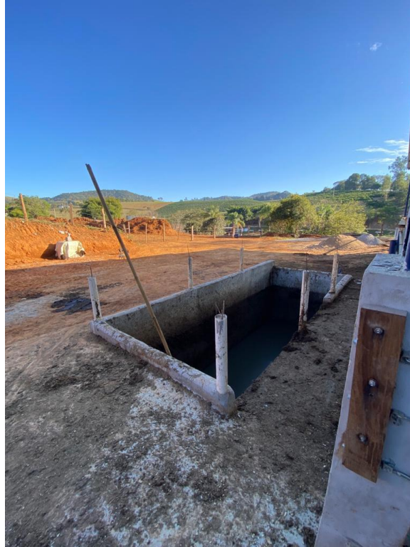
Figura 6 - Construção da fossa para coleta de dejetos.
