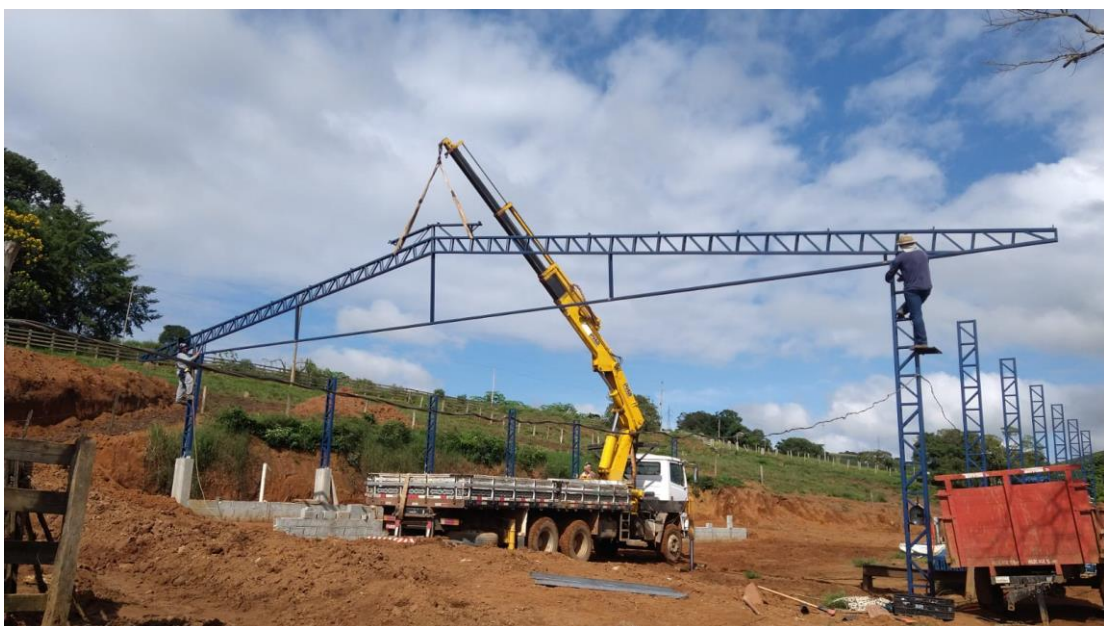
Figura 4 - Construção do Compost Barn .
