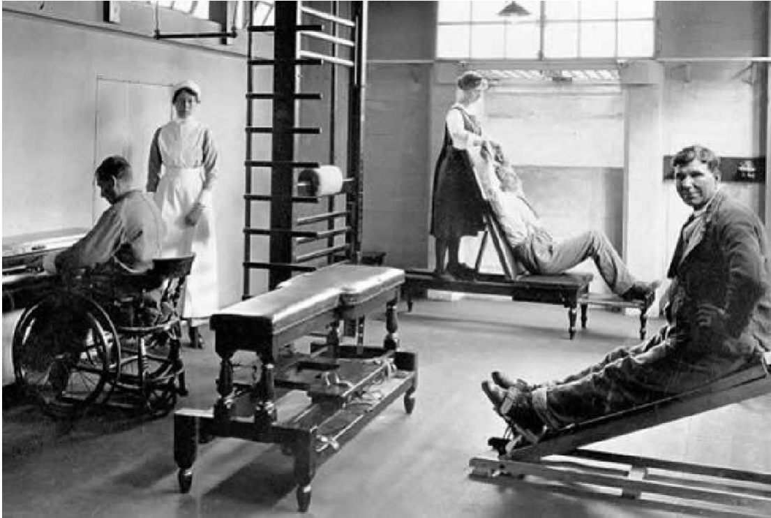
Imagem 3: Antigas clínicas de fisioterapia – uso de iluminação e ventilação natural.
