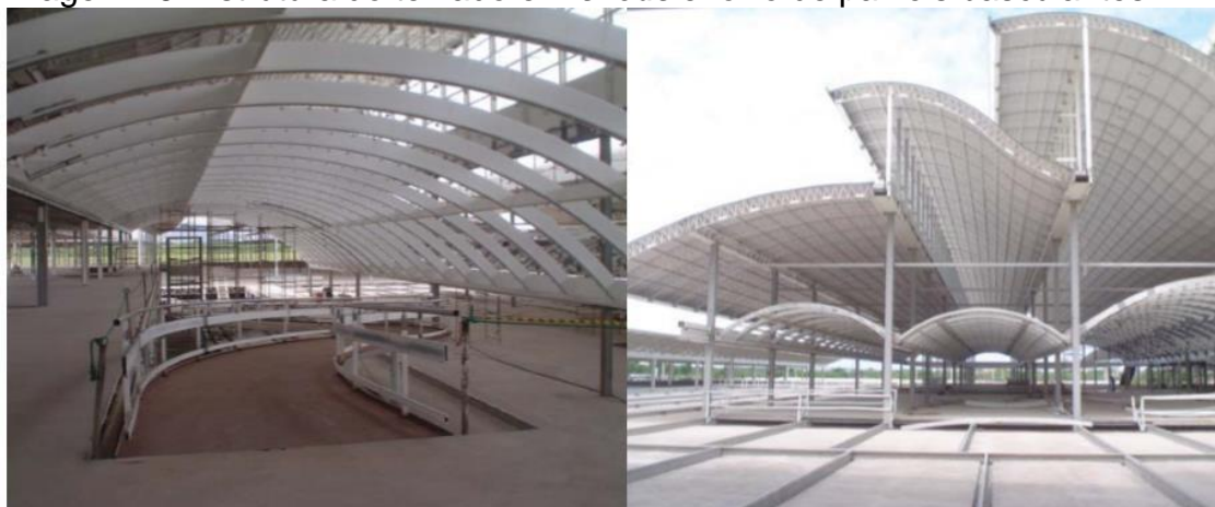
Imagem 26: Estrutura do telhado em sheds e forro de painéis basculantes.
