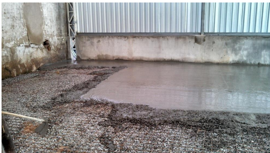
Figura 59 - Concretagem do piso industrial
