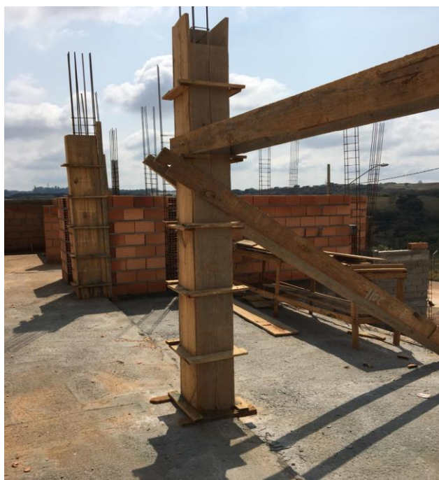
Figura 10 - Formas de escoramento
