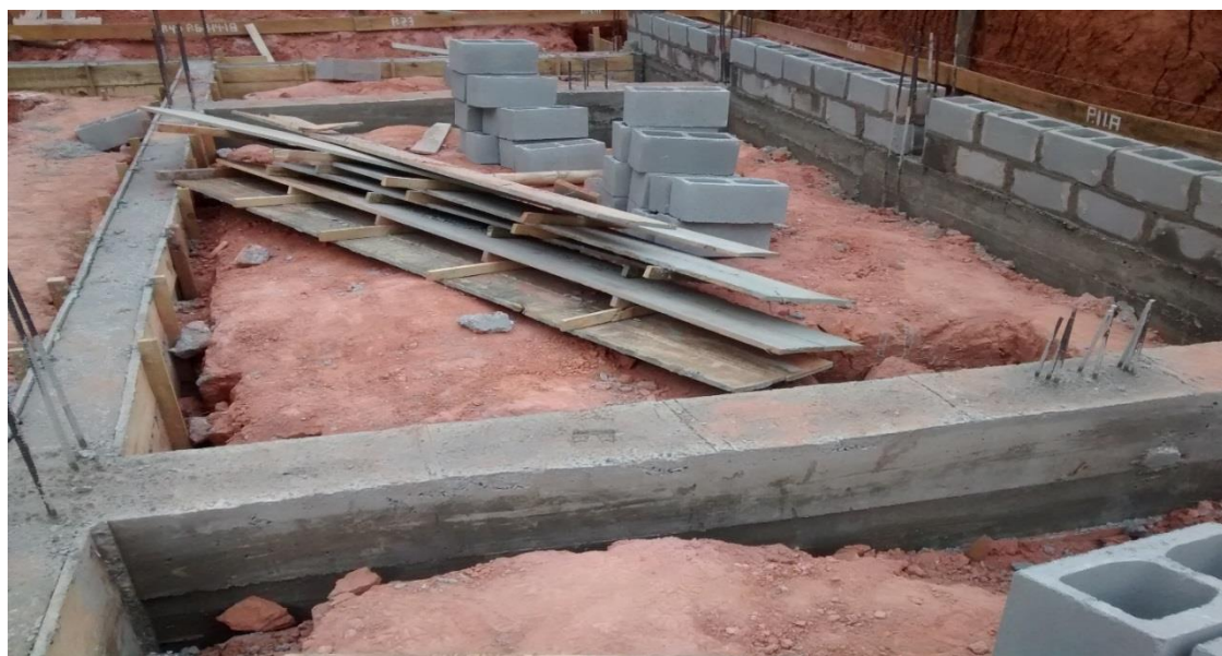
Figura 54 - Concretando a viga
