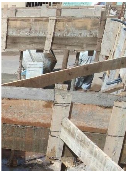
Figura 82 - Formas e escoras das vigas
