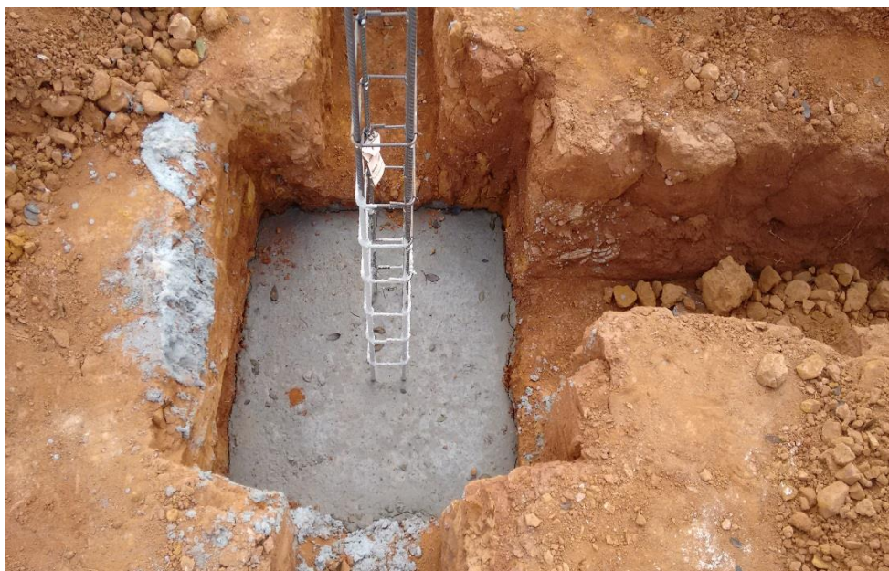
Figura 7 - Concretagem da sapata
