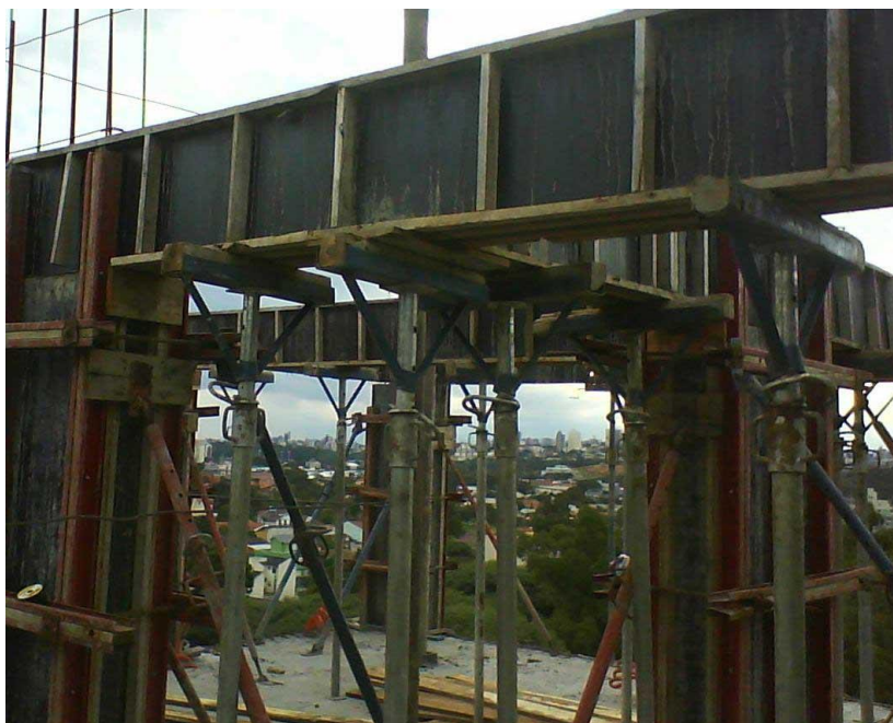
Figura 12 - Preparado para receber o lançamento do concreto
