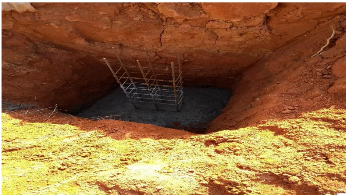
Figura 46 - Procedimentos de construção da sapata retangular
