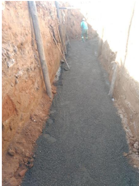
Figura 62 - Berço para assentamento de tubo de concreto
