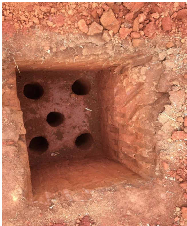
Figura 3 - Perfuração das Broca
