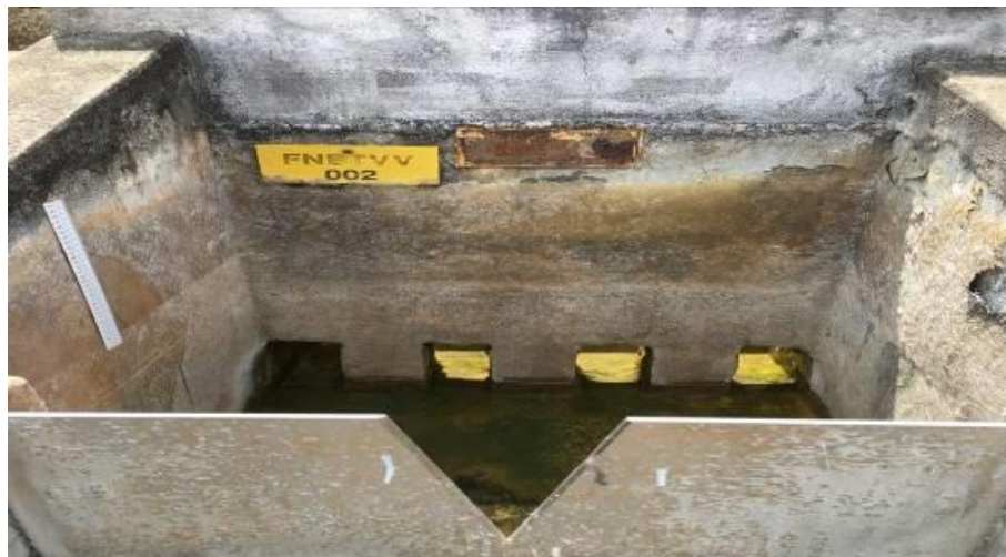
Figura 29 - Identificação do Vertedor
