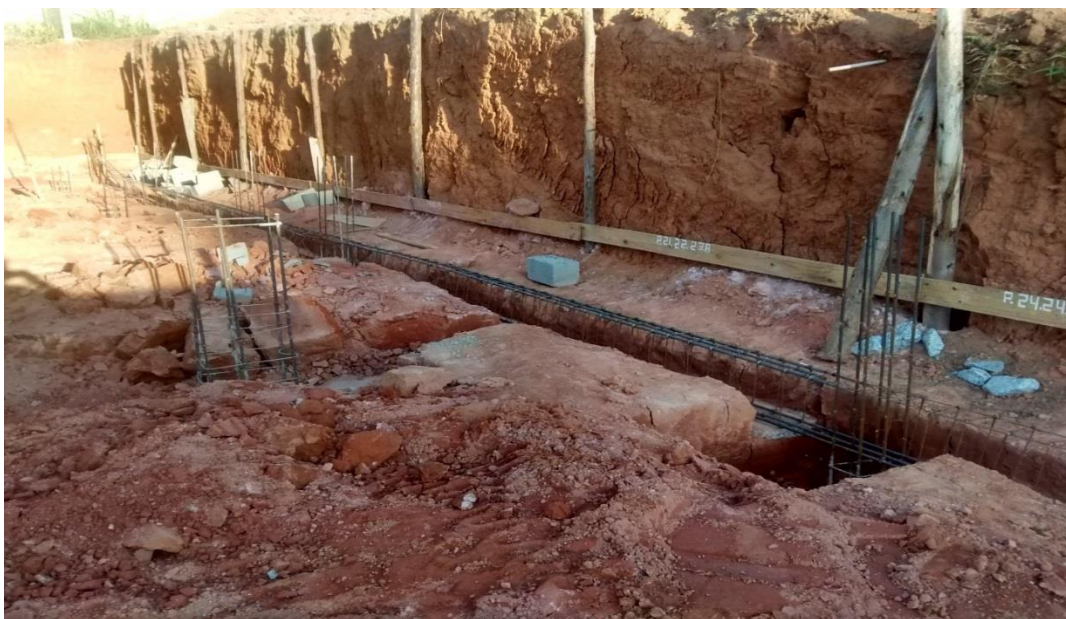
Figura 52 - Ferragens da viga baldrame
