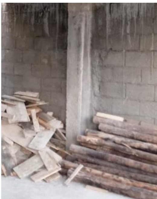
Figura 81 - Pilar de concreto armado
