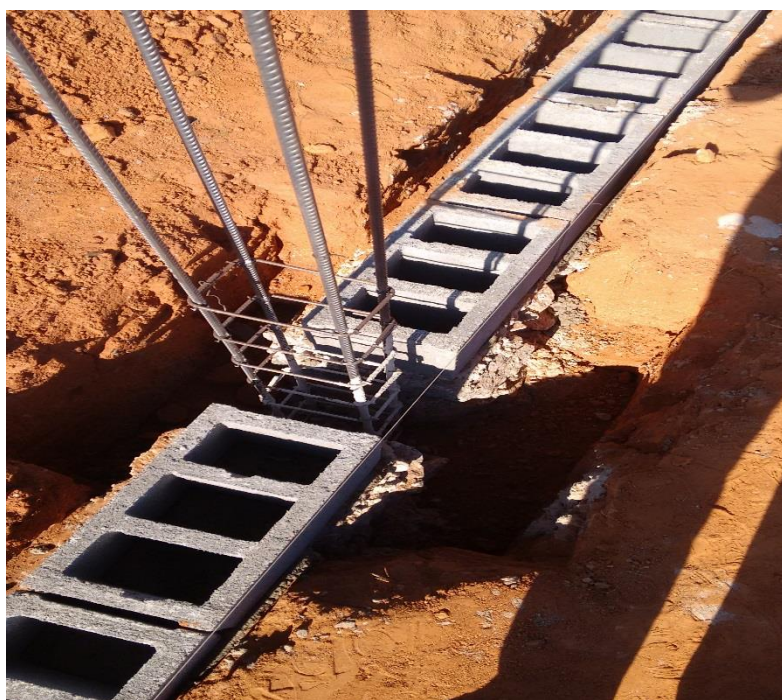
Figura 5 - Assentamento dos blocos de concreto
