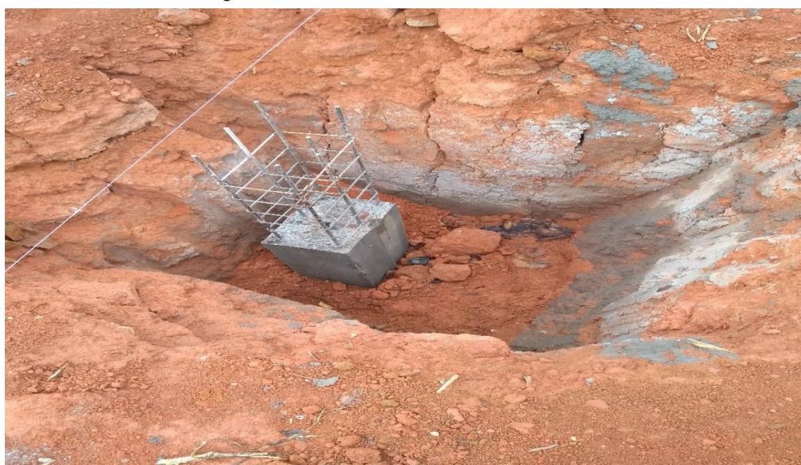
Figura 50 - Pilar concretado e desenformado
