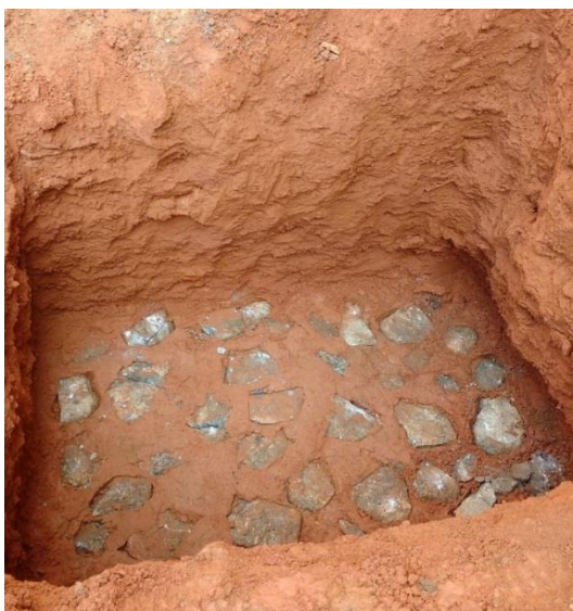
Figura 73 - Apiloamento da vala da sapata
