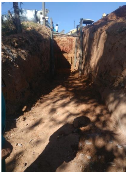
Figura 60 - Escavação de vala
