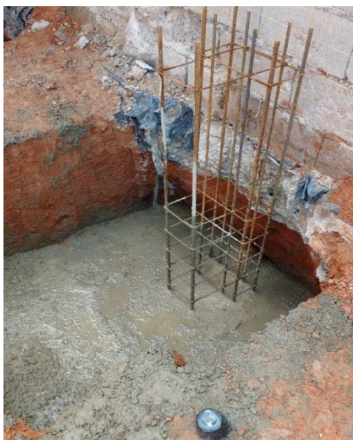
Figura 76 - Acabamento da concretagem
