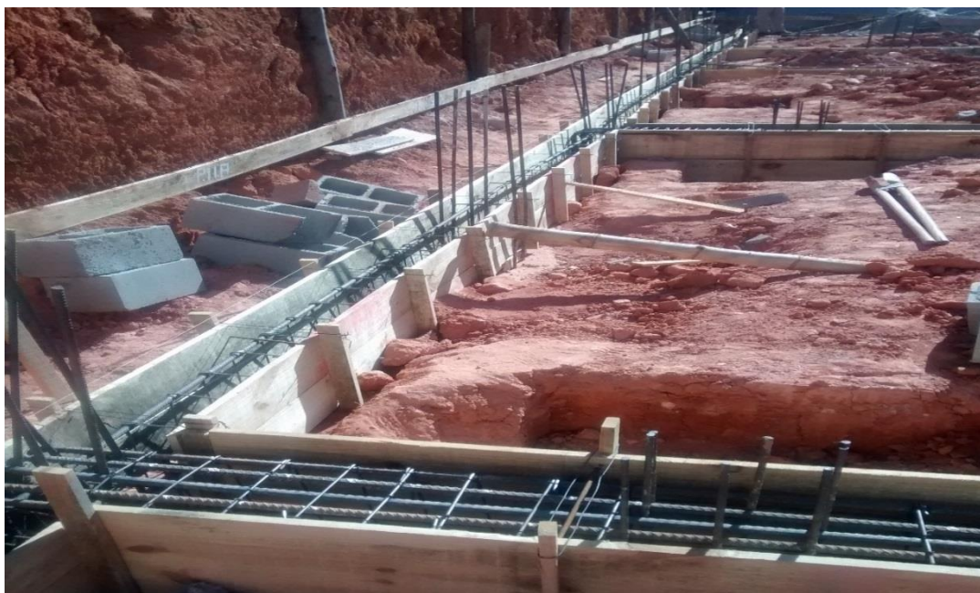
Figura 53 - Formas de madeira das vigas baldrame
