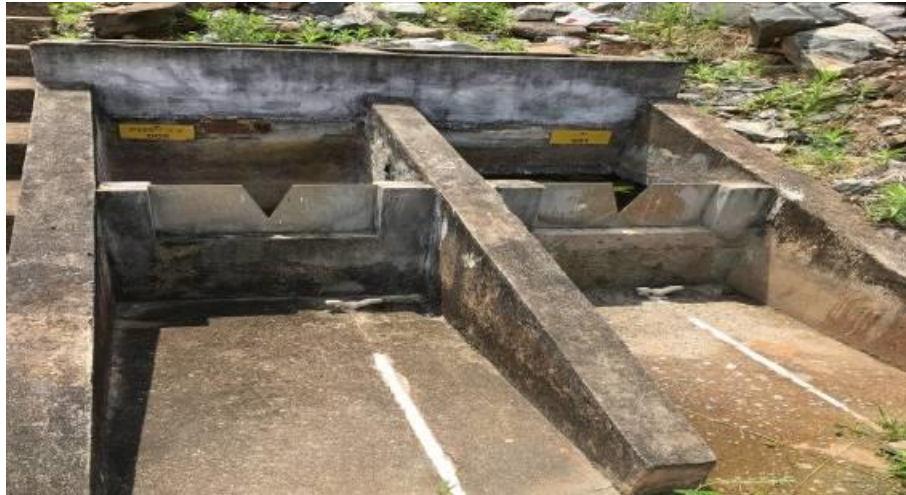
Figura 28 - Vertedores Triangulares
