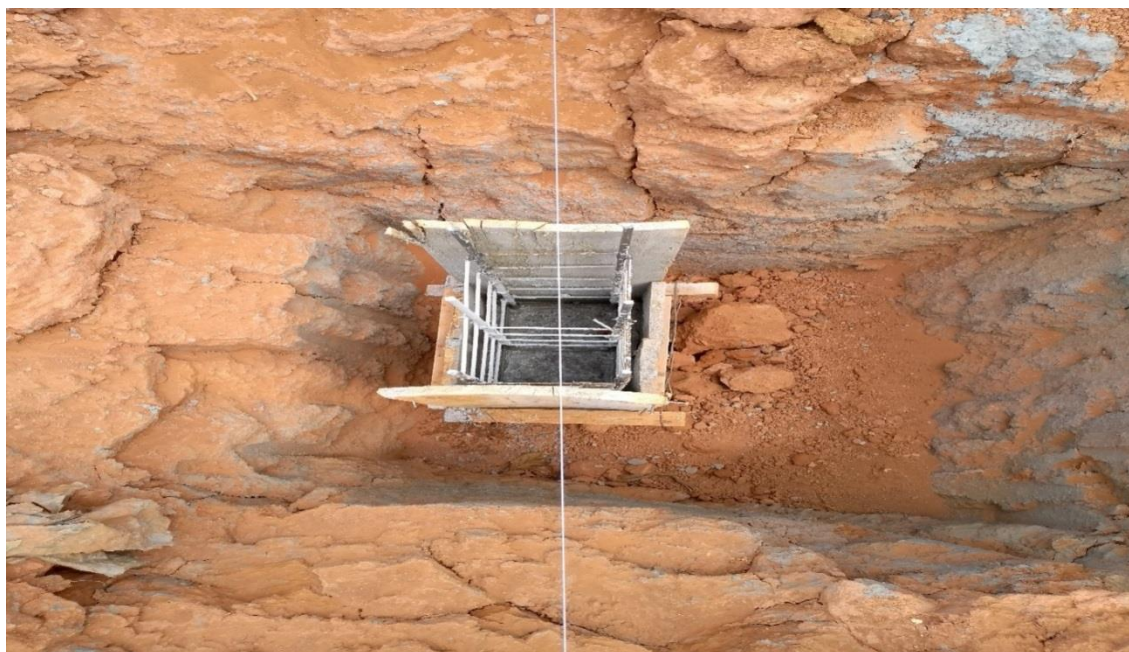
Figura 49 - Concretagem do pilar
