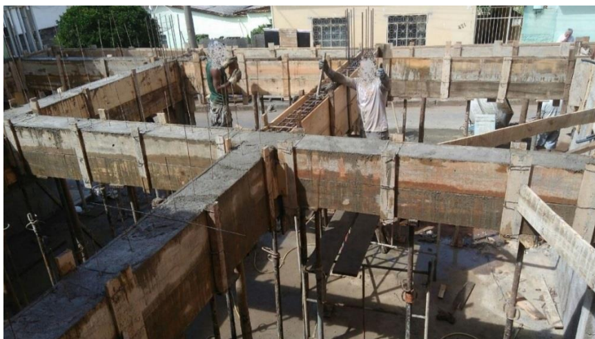
Figura 83 - Armadura das vigas
