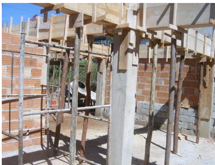
Figura 11 - Pilar desformado
