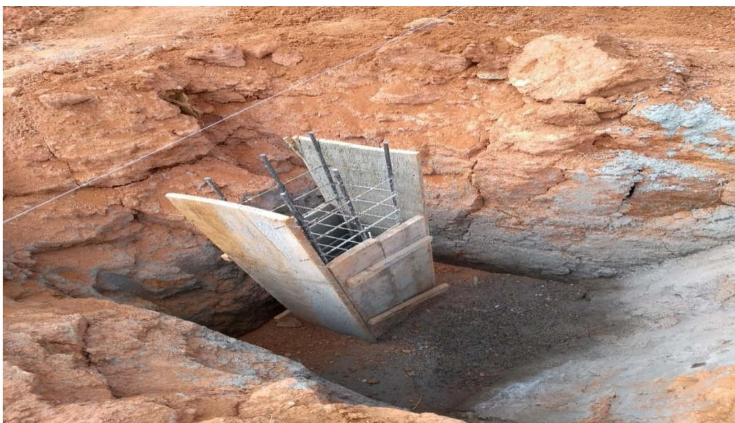
Figura 48 - Fôrma de madeira do pilar
