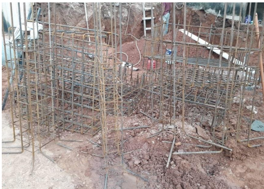
Figura 74 - Armadura usada na sapata e pilares
