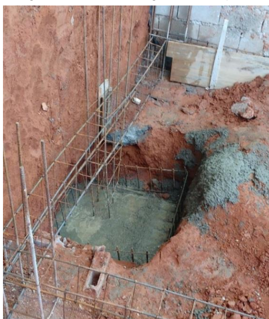
Figura 75 - Concretagem das sapatas
