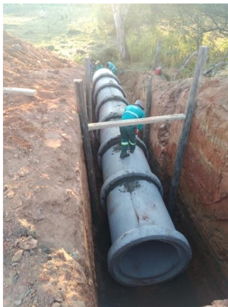
Figura 63 - Assentamento de manilhas e rejuntamento
