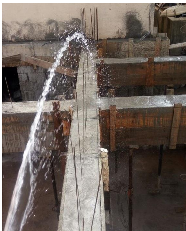
Figura 84 - Concretagem das vigas
