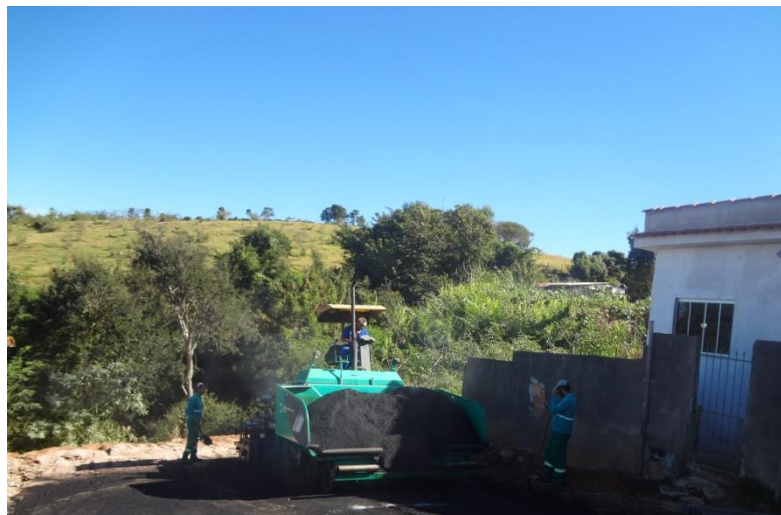
Figura 68 - Aplicação de massa asfáltica
