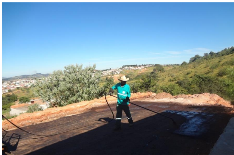
Figura 67 - Pintura de Ligação.
