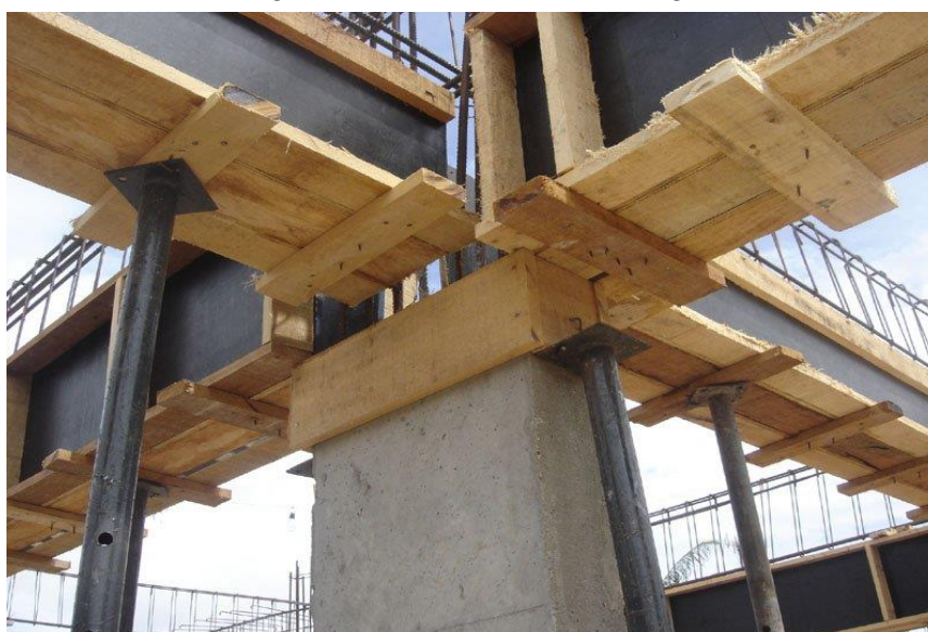
Figura 13 - Escoramento da viga
