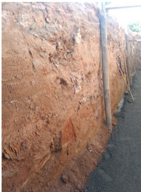
Figura 61 - Escoramento de valas
