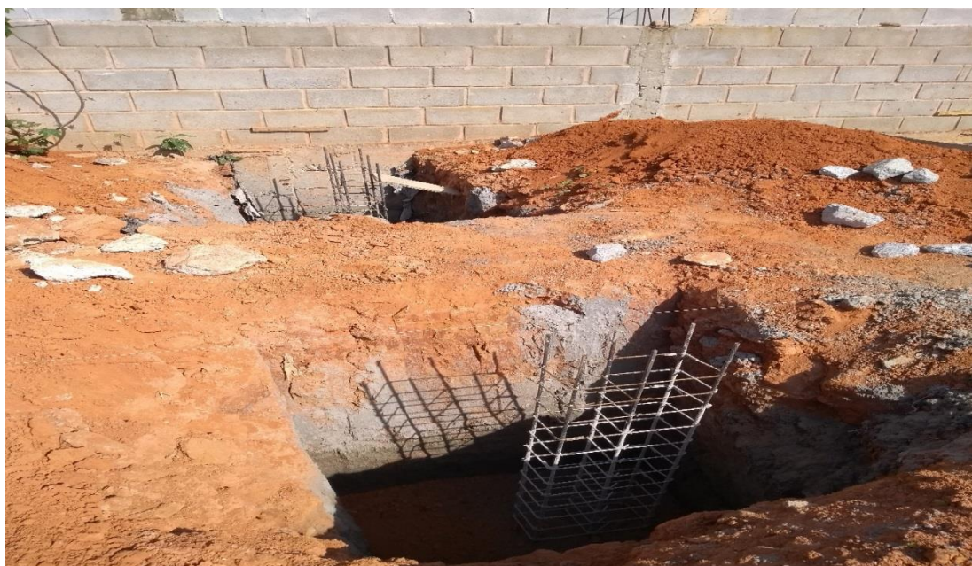
Figura 47 - Armadura de aço dos pilares
