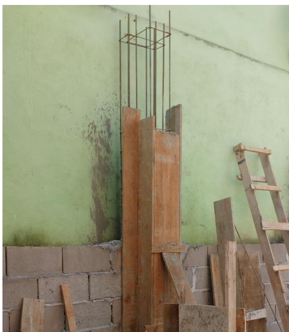
Figura 79 - Forma de um pilar de concreto armado
