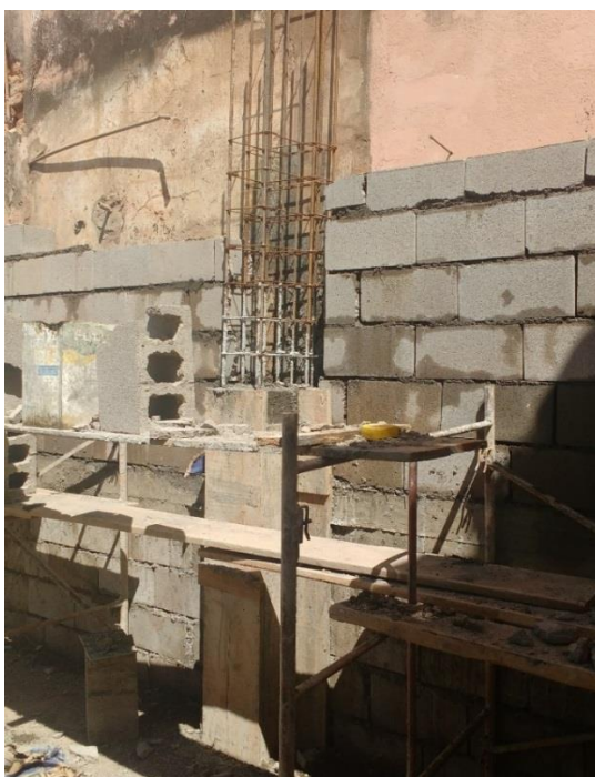
Figura 80 - Preparação e concretagem de um pilar de concreto armado
