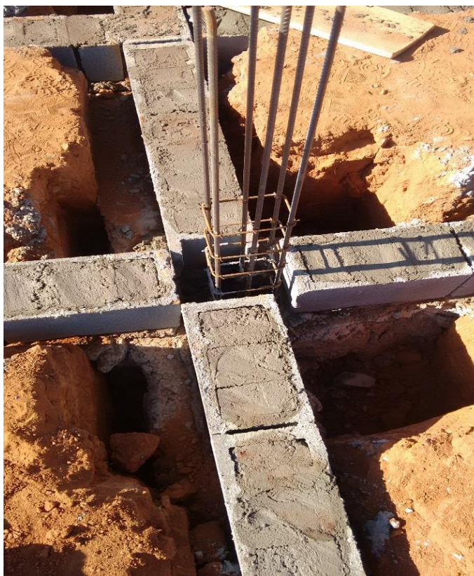
Figura 8 - Assentamento do bloco de concreto cheio
