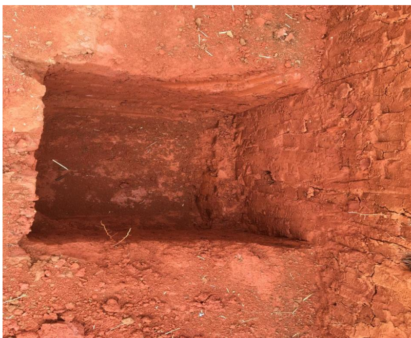
Figura 2 - Abertura de Fundação Rasa
