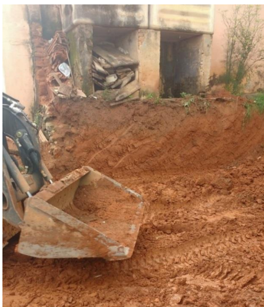
Figura 71 - Desaterro do terreno
