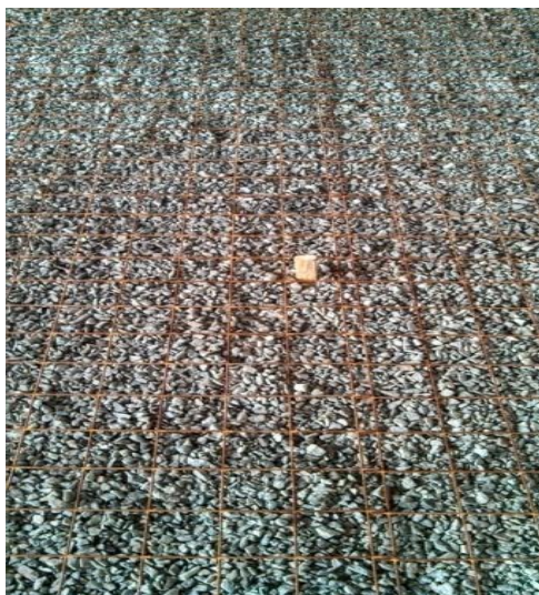
Figura 58 - Berço de brita e armadura
