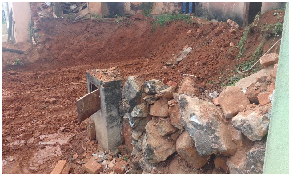
Figura 70 - Desaterro e limpeza do terreno
