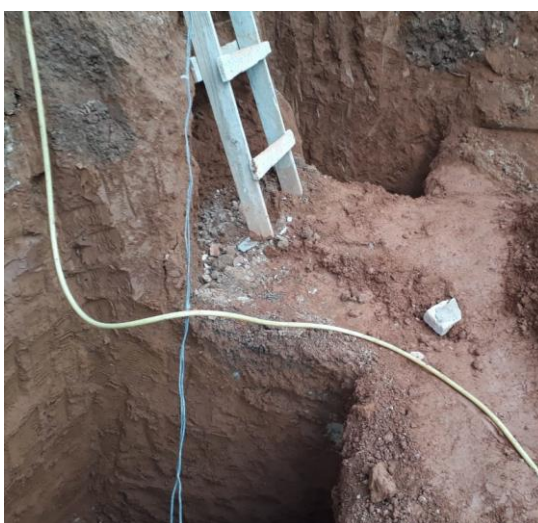
Figura 72 - Perfuração das sapatas
