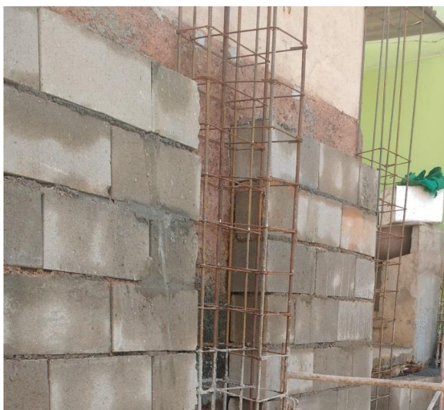
Figura 78 - Armadura do pilar
