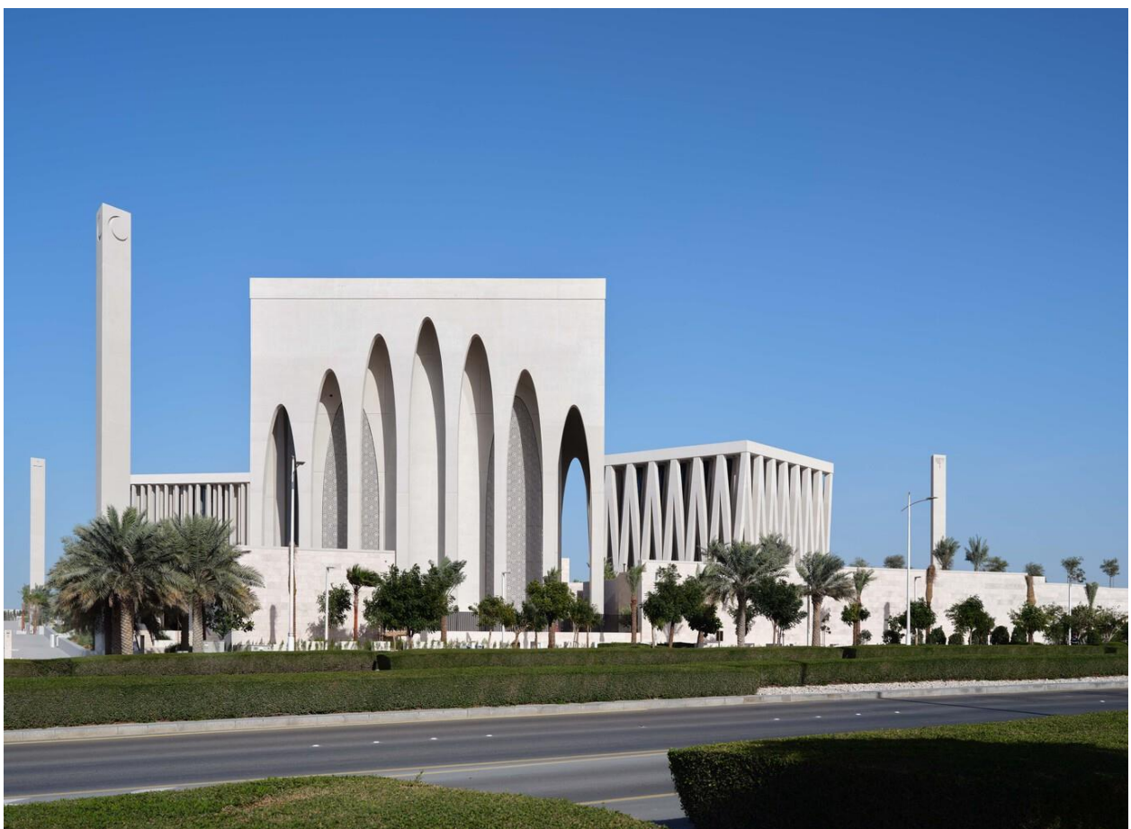
Figura 31 – Fachada da Igreja
