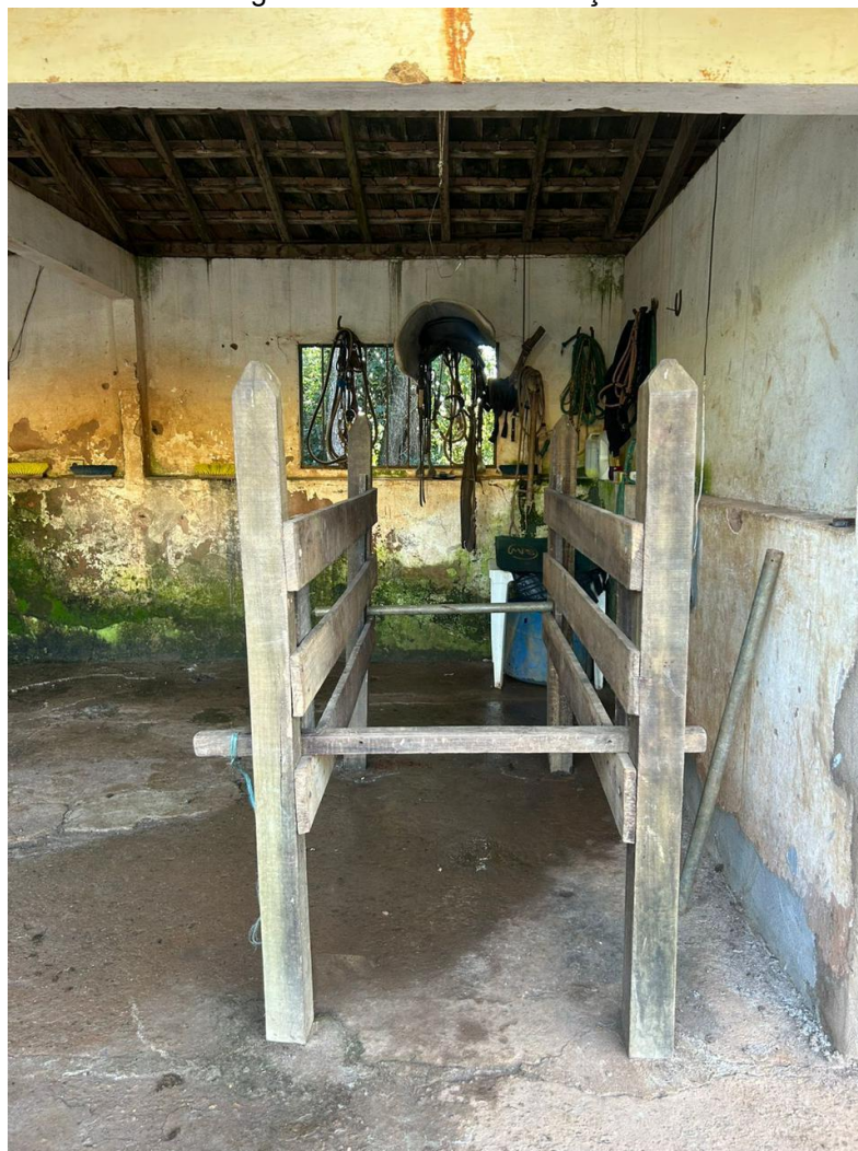
Figura 4 - Tronco de contenção.
