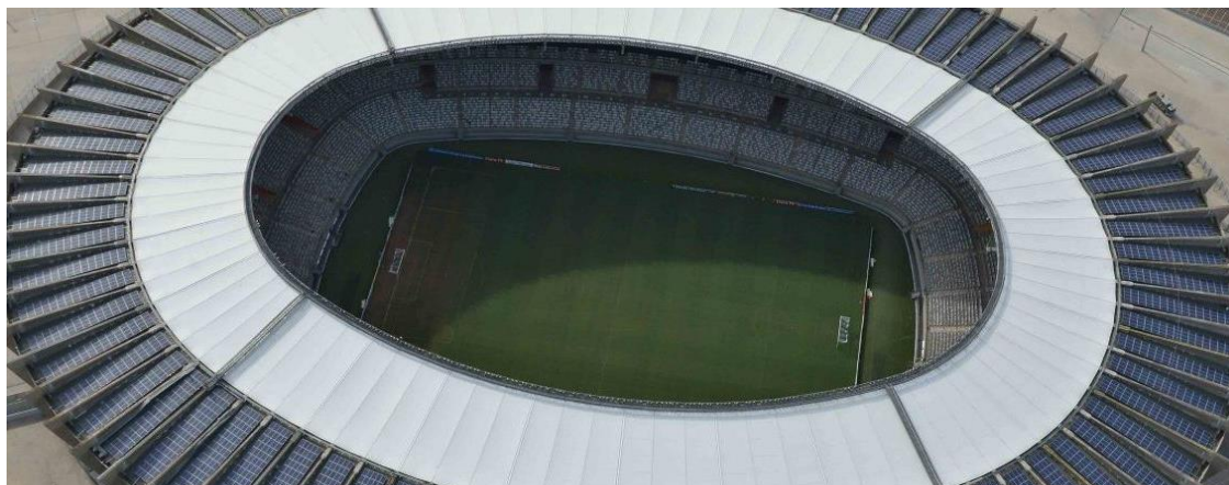
Imagem 10 – Painéis fotovoltaicos na cobertura da arena
